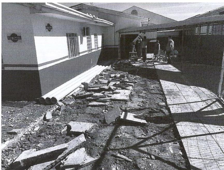
Foto 02: Demolição do piso existente.
