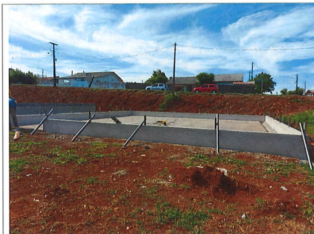
Execução de pilares e vigas do playground
