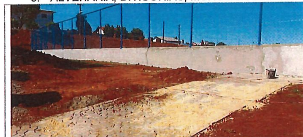
Alvenaria de vedação da mureta do campo
