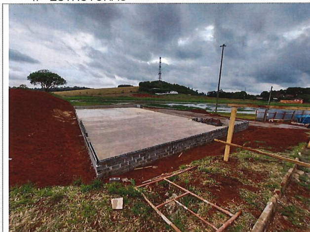
Execução de viga baldrame no entorno da quadra
