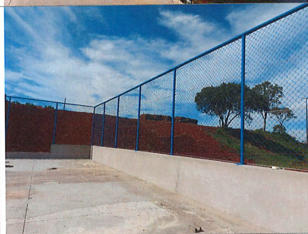
Execução de pilares e vigas da quadra
