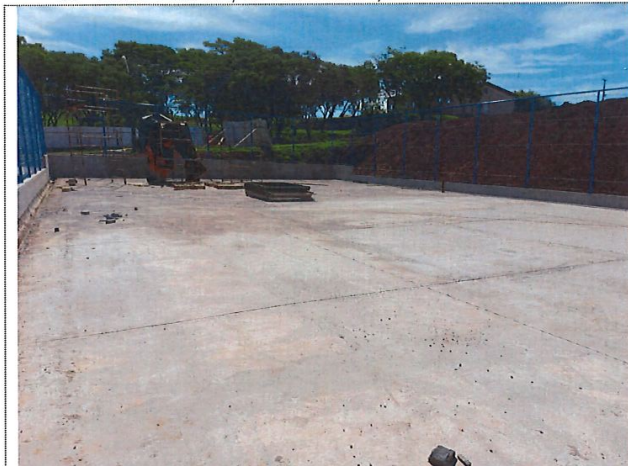
Alvenaria de vedação da quadra
