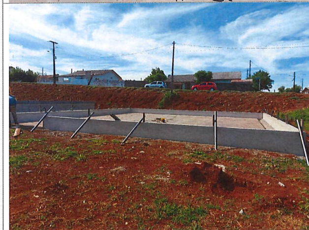
Alvenaria de vedação do playground
