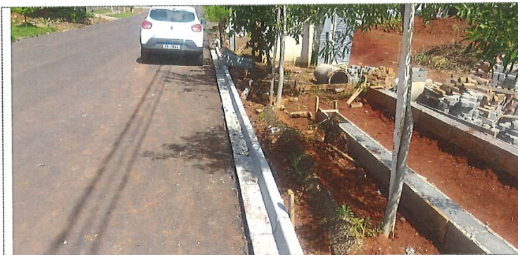
Retirada de meio fio danificado
