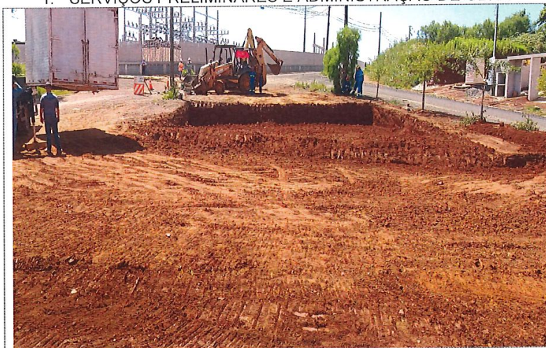
Limpeza do terreno
