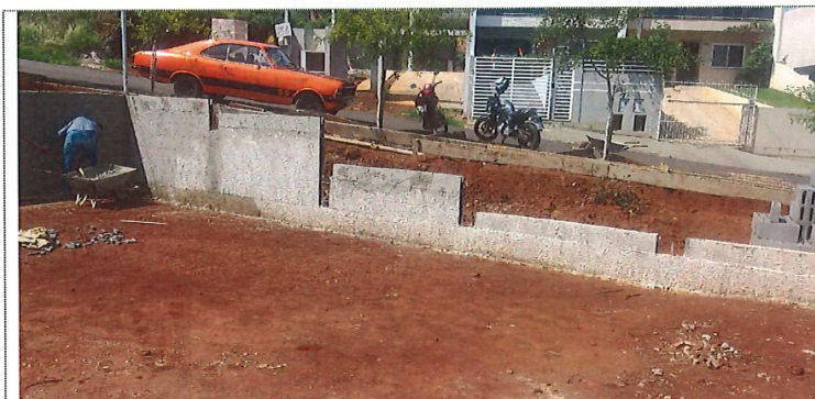
Chapisco aplicado na mureta do playground
