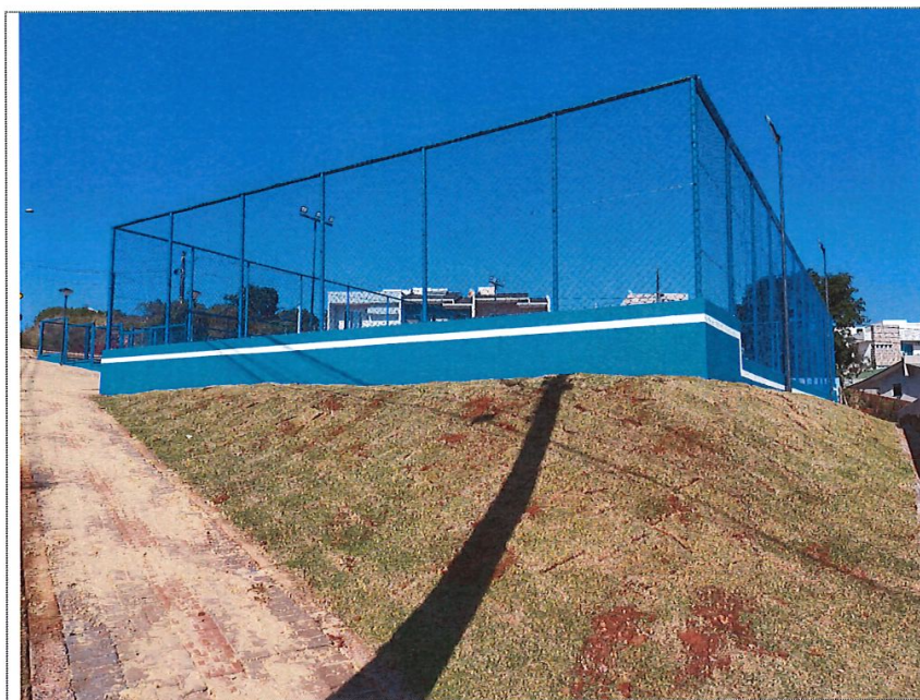
Pintura muretas playground, postes e luminárias e grama.
