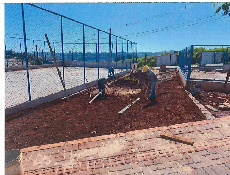
Escavação e reaterro
