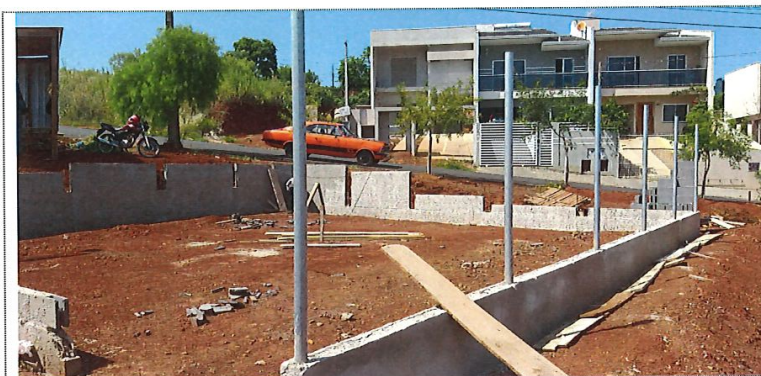
Escavação e reaterro vala playground
