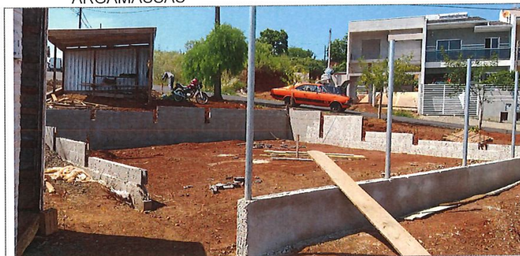
Impermeabilização de vigas baldrames no entorno do playground
