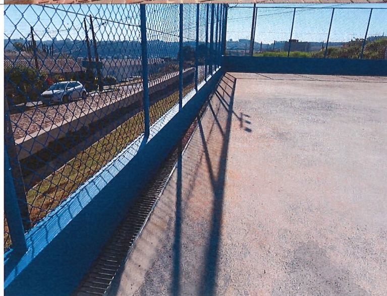
Canaleta de concreto e grelha de ferro – campo.
