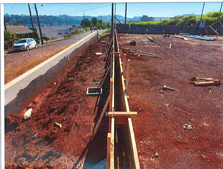
Fôrma e armadura da viga baldrame - campo
