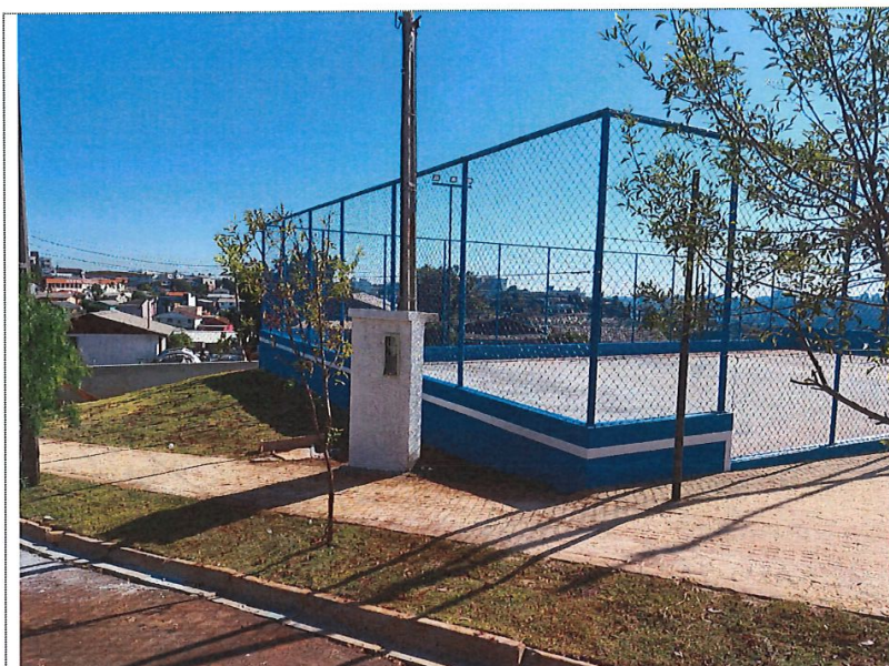
Alambrado Campo e mureta de medição
