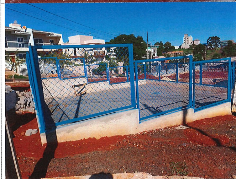
Emboço aplicado na mureta do playground
