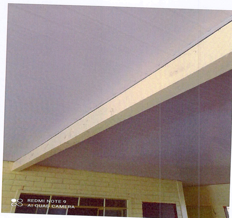
Foto 06: Forro PVC salas de aula.
