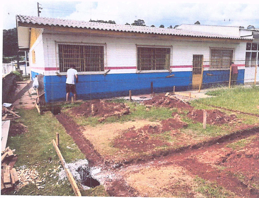
Foto 10: Locação e Escavação da fundação Ampliação Olavo Bilac
