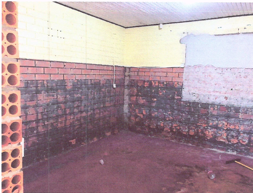
Foto 04: Demolição Revestimento Cerâmico Brinquedoteca
