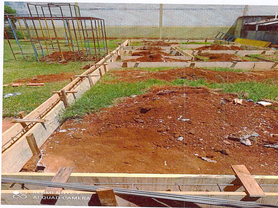
Foto 09: Caixaria e aço vigas baldrame construção salas de aula.
