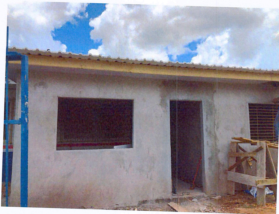
Foto 11: Finalização emboço, cobertura e telhamento ampliação brinquedoteca.
