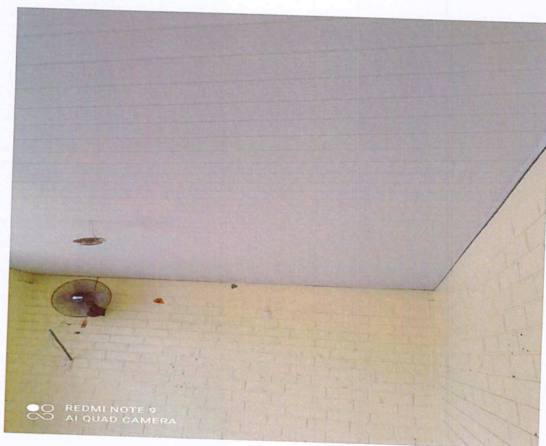
Foto 05: Forro PVC salas de aula.
