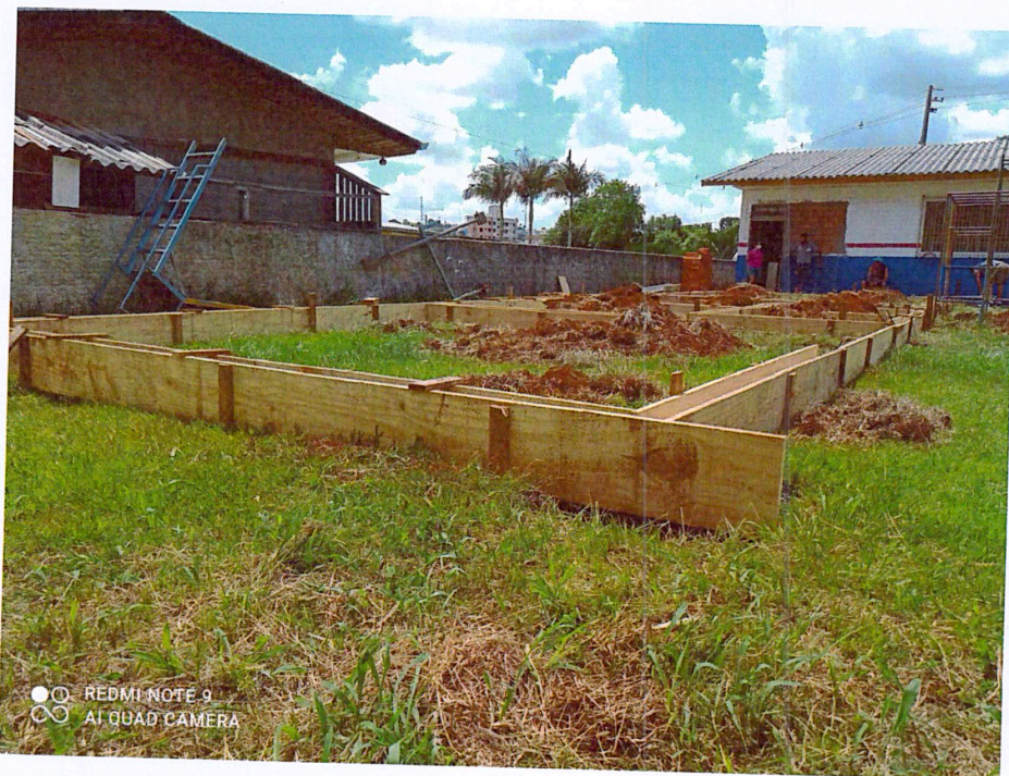
Foto 07: Caixaria vigas baldrame construção salas de aula.
