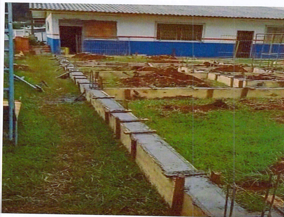
Foto 10: Vigas baldrame salas de aula concretadas.
