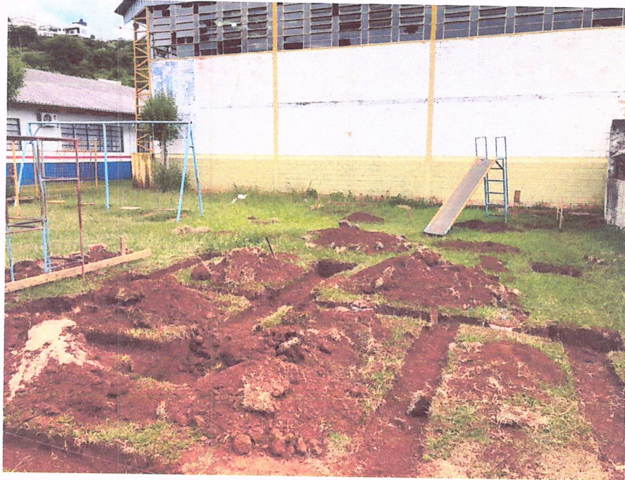
Foto 09: Locação e Escavação da fundação Ampliação Olavo Bilac
