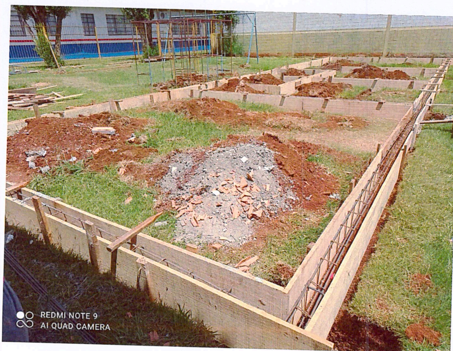
Foto 08: Caixaria vigas baldrame construção salas de aula.
