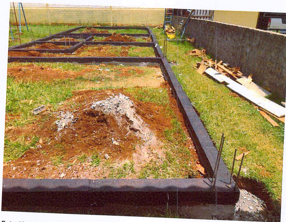
Foto 13: Vigas baldrame construção de salas de aula concretadas e impermeabilizadas.
