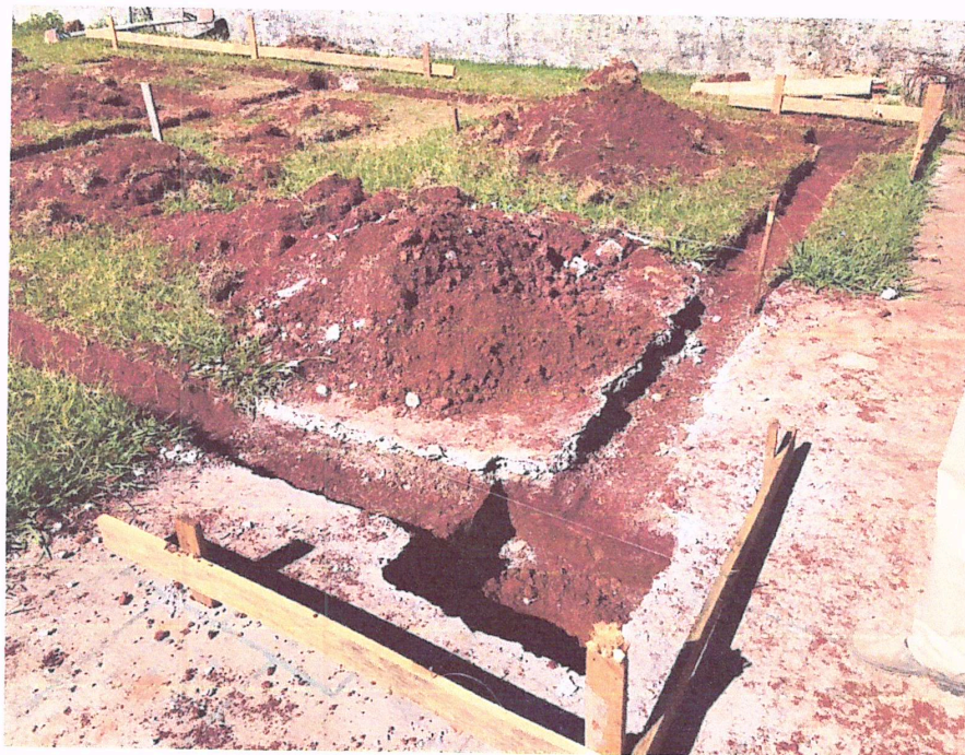
Foto 11: Locação e Escavação da fundação Ampliação Olavo Bilac
