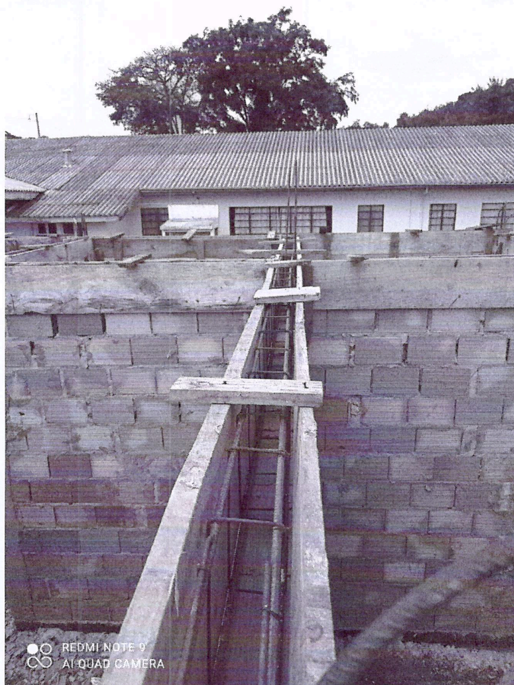
Foto 05: Ampliação Salas de Aula
