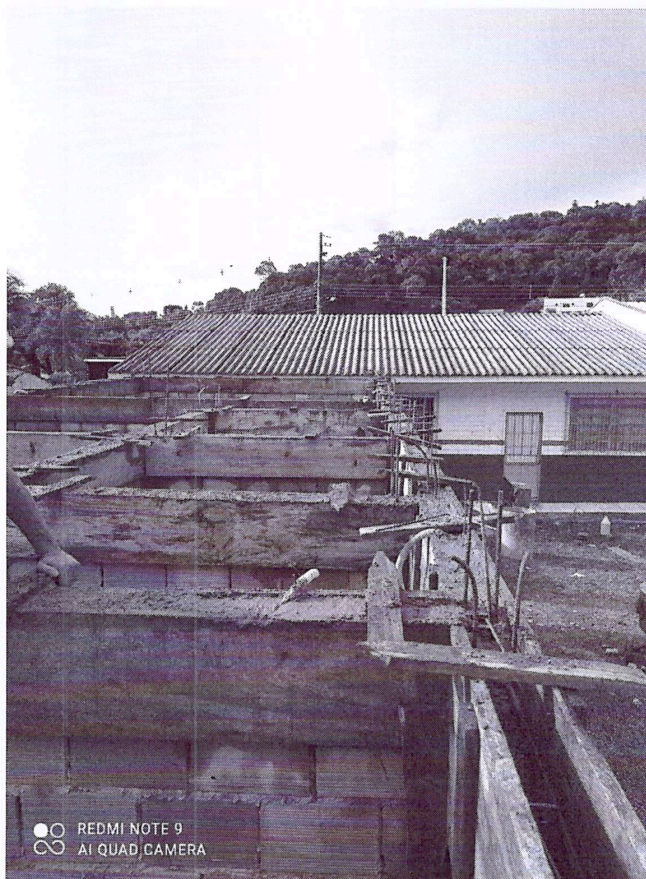
Foto 06: Concretagem Vigas de Cobertura
