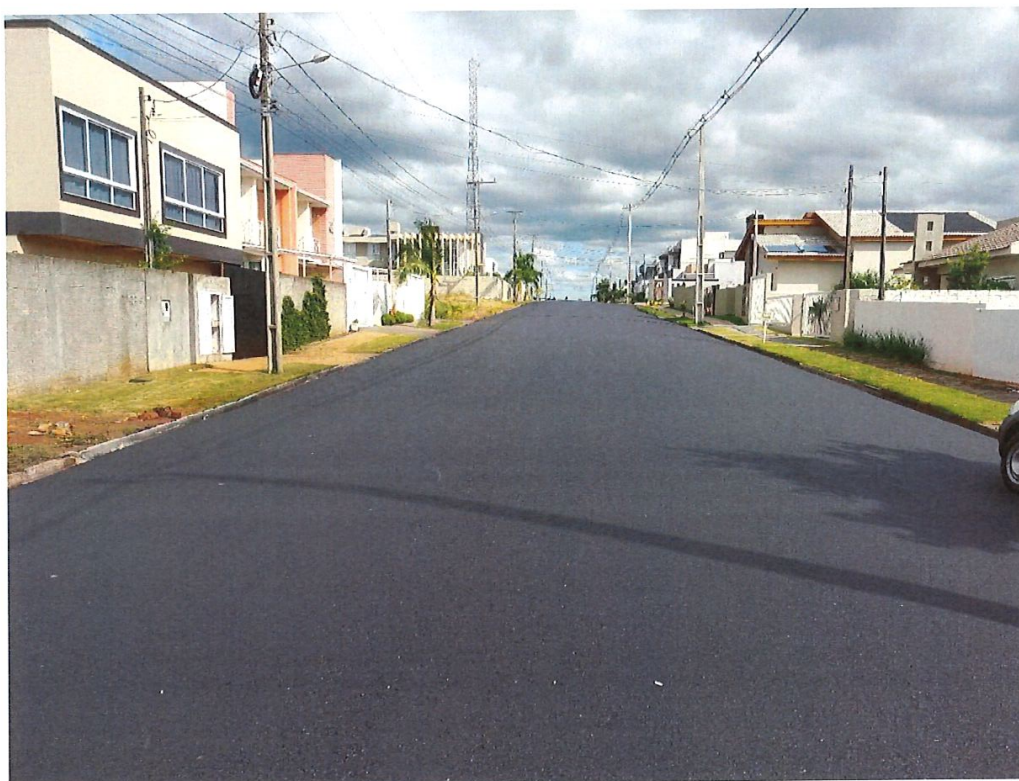
Foto 17: Rua Maria Bombarda Oldoni – Pavimentação
