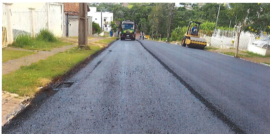
Foto 29: Rua Silva Jardim – Pavimentação
