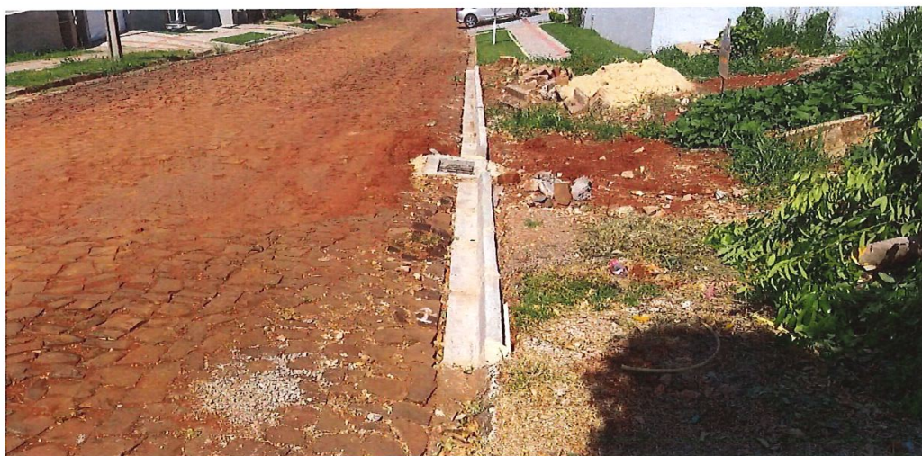
Foto 06: Rua Pedro Soares Trecho 02 – Meio-fio
