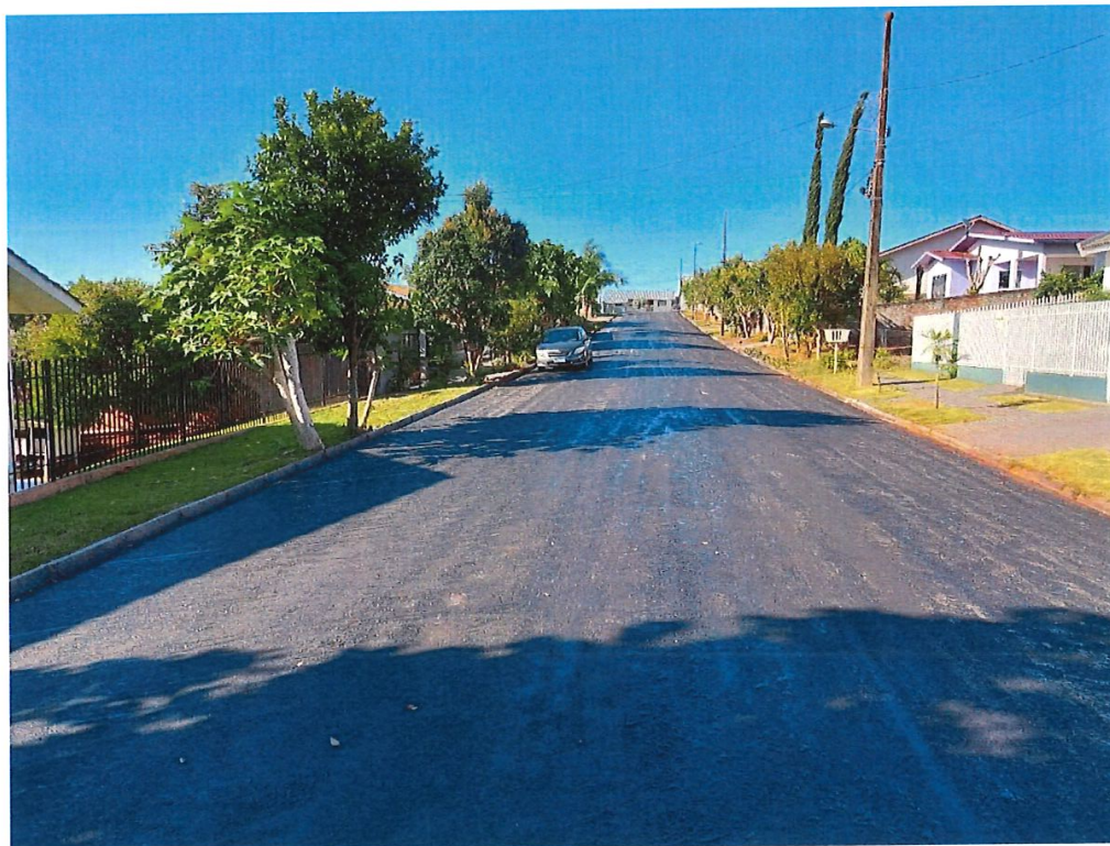
Foto 10: Rua Mário João Perim – Pavimentação
