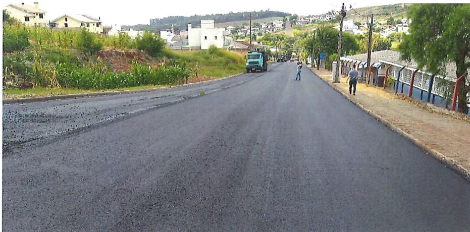
Foto 28: Rua Silva Jardim – Pavimentação
