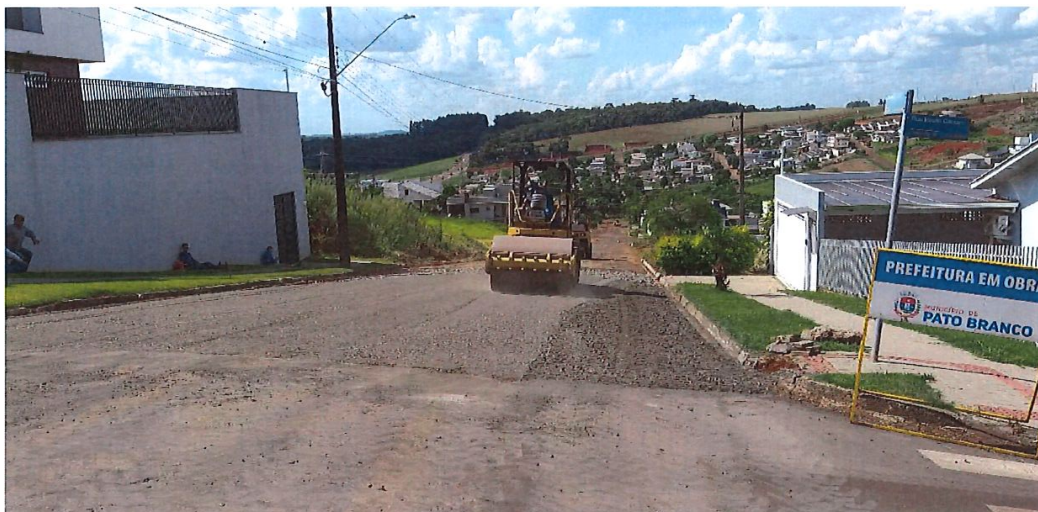
Foto 13: Rua Aimoré – Reforço de Base
