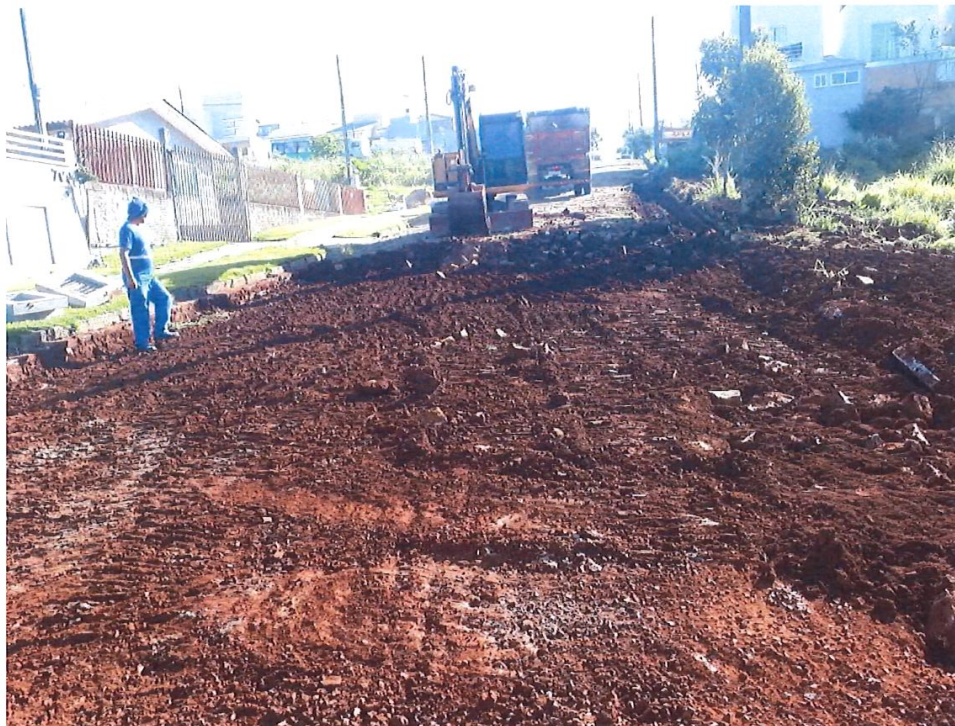
Foto 01: Escavação do Reforço de Base.
