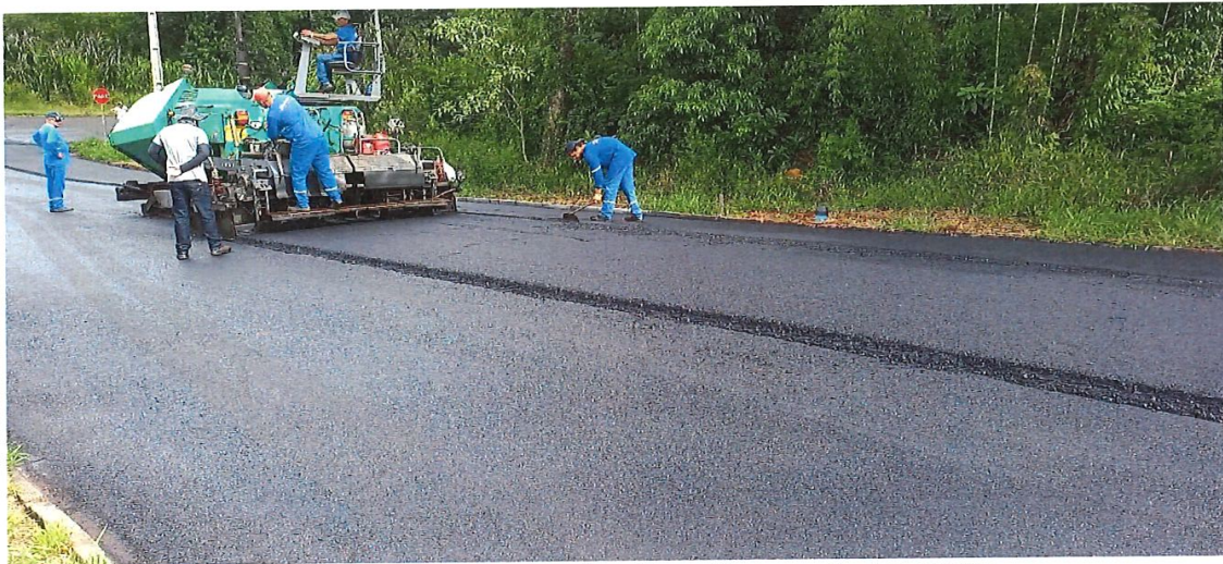
Foto 21: Rua Irineu Parzianello – Reperfilagem e Pavimentação
