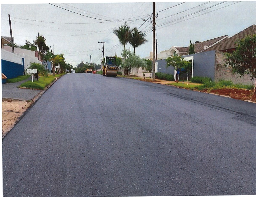
Foto 19: Rua Bolislau Fidalski - Pavimentação
