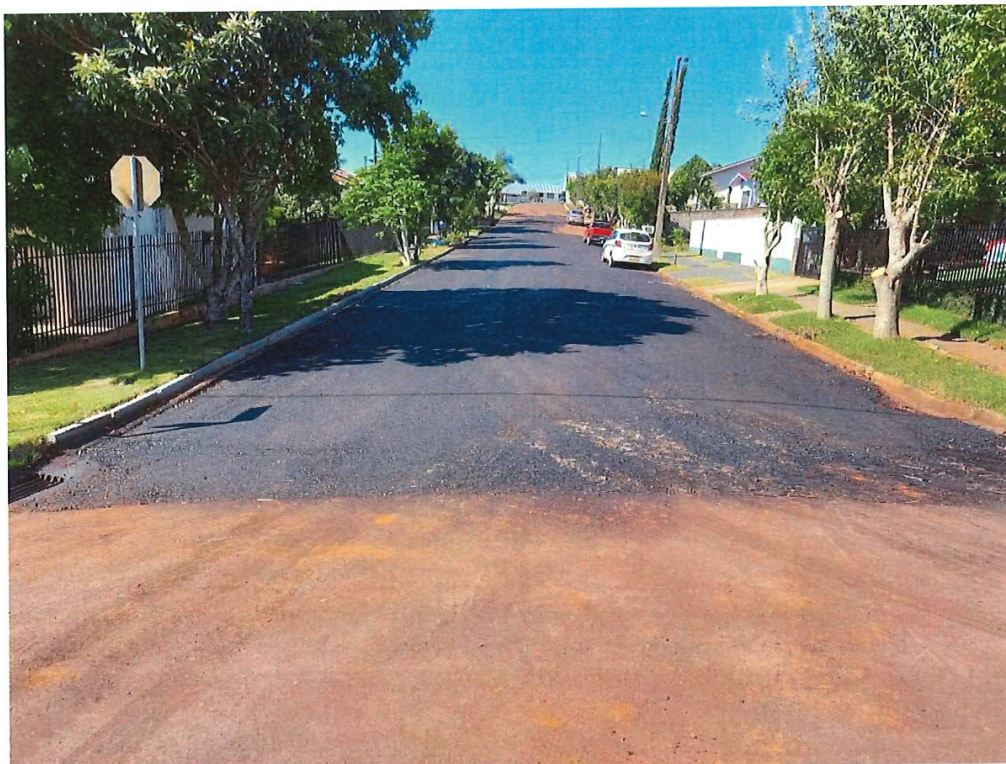
Foto 09: Rua Mário João Perim – Reforço de Base e Meio-Fio
