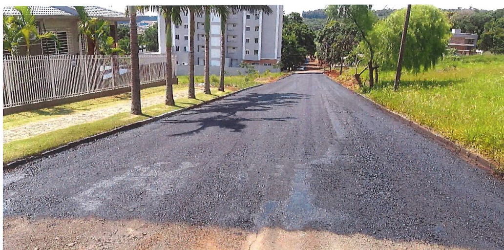
Foto 09: Rua Silveira Martins – Reforço de Base
