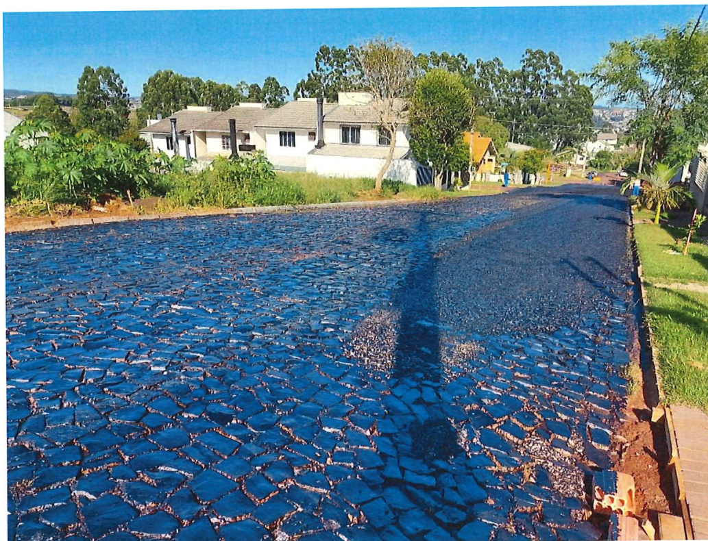
Foto 07: Rua Lídio Guerra – Pintura de Ligação e Reforço de Base
