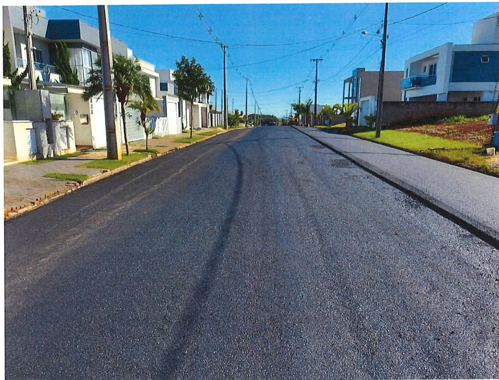
Foto 15: Rua Maria Bombarda Oldoni – Reperfilagem e Pavimentação
