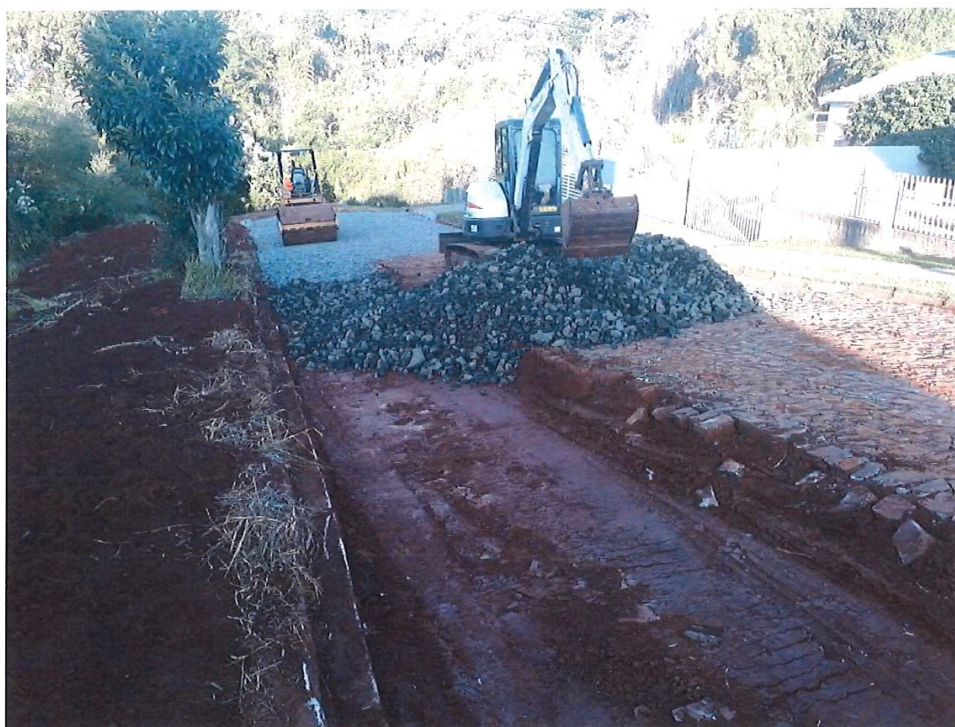
Foto 02: Execução da Sub-base em Macadame.
