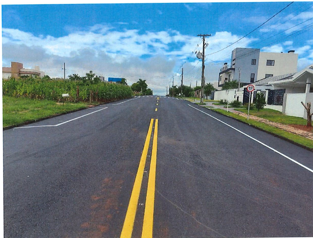
Foto 23: Rua Vitélio Parzianello – Pavimentação
