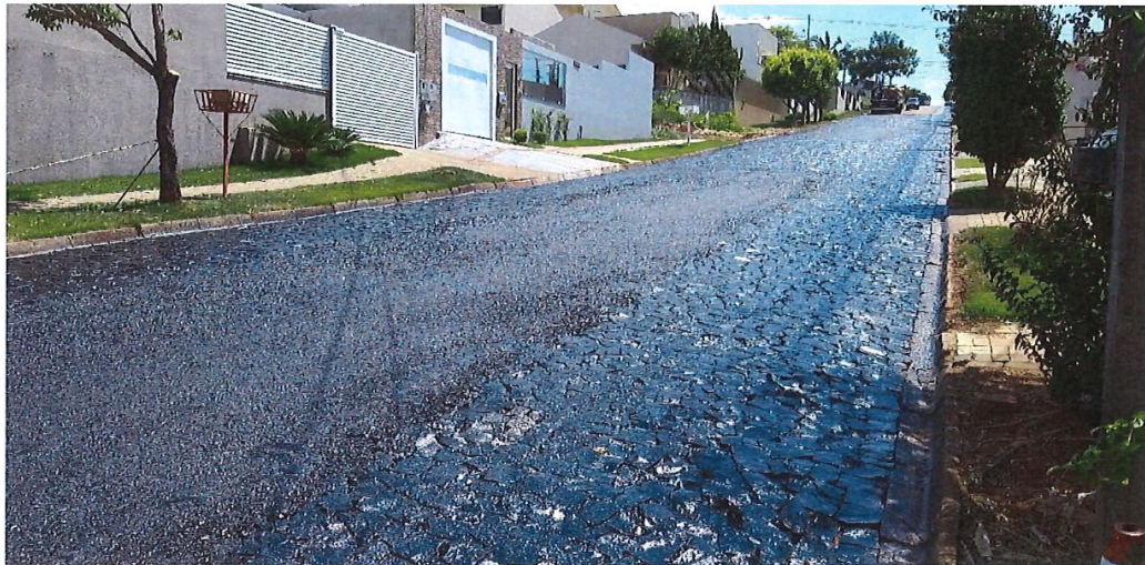
Foto 19: Rua Pedro Soares trecho 02 – Reforço de Base
