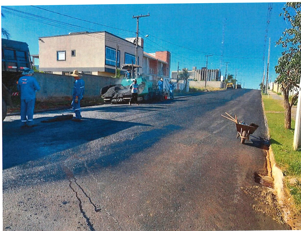
Foto 14: Rua Maria Bombarda Oldoni – Reperfilagem, Pintura de Ligação e Pavimentação
