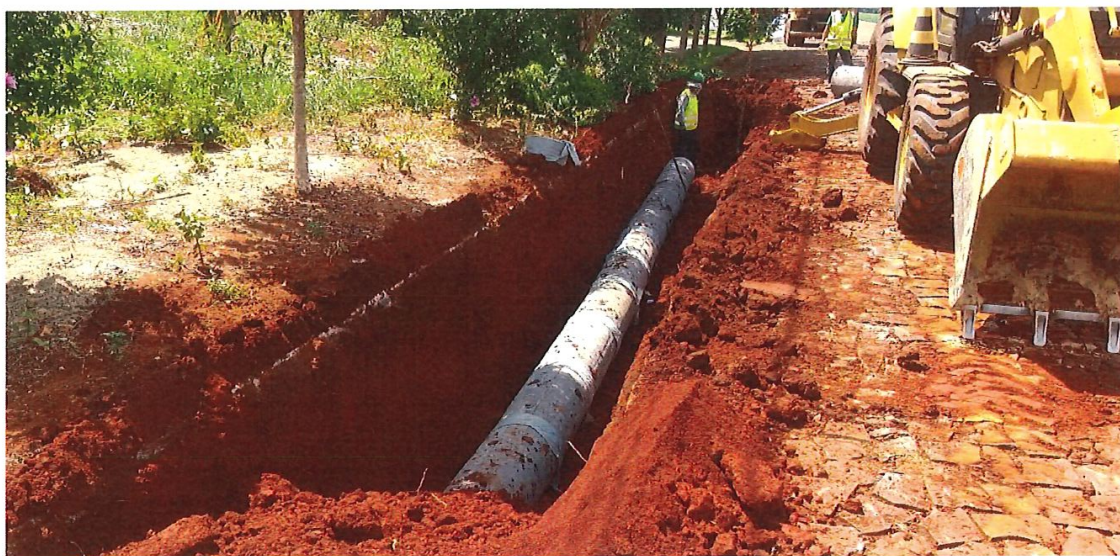
Foto 02: Rede de drenagem Rua Vit3lio Parzianello.
