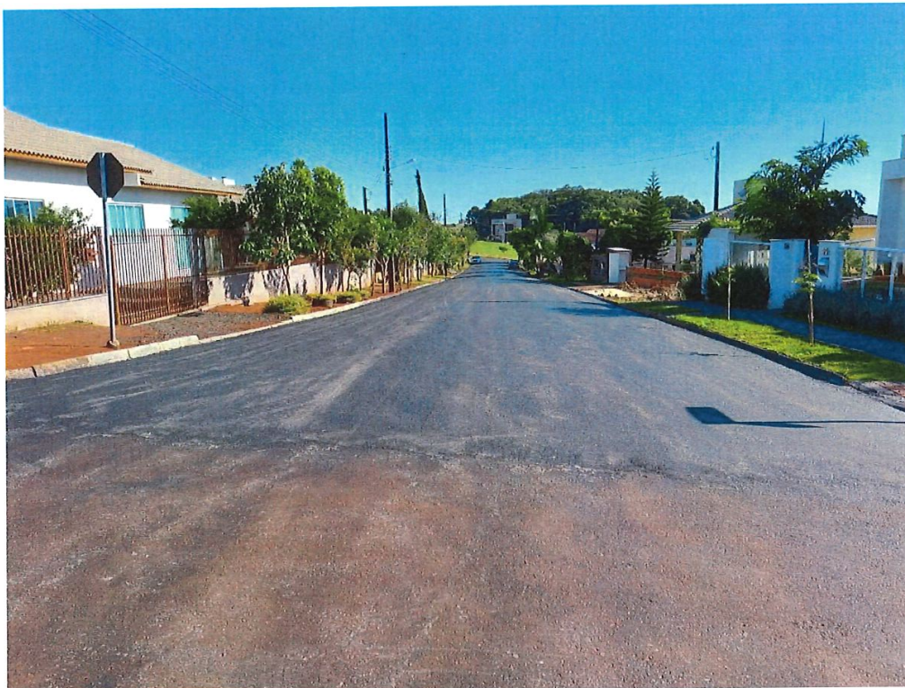
Foto 11: Rua Mário João Perim – Pavimentação
