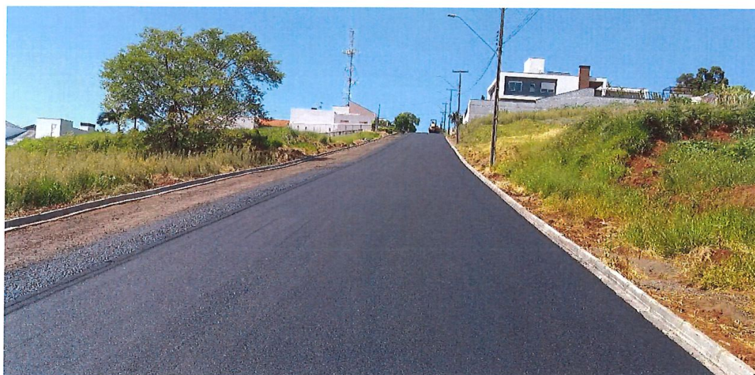
Foto 27: Rua Aimoré – Pavimentação
