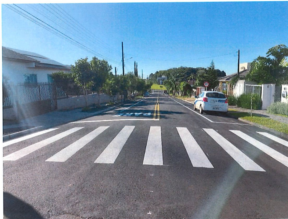
Foto 01: Rua Mario João Perim.
