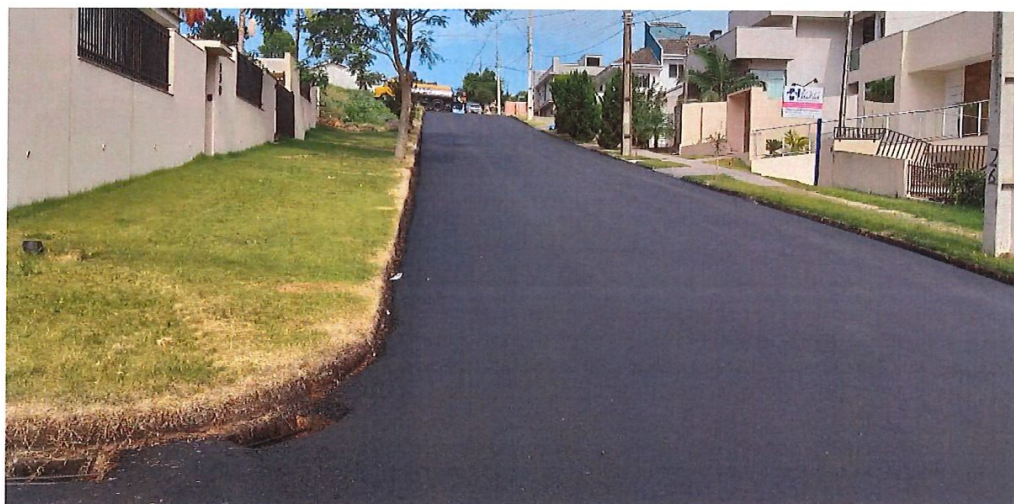
Foto 26: Rua Pedro Soares Trecho 02 – Pavimentação
