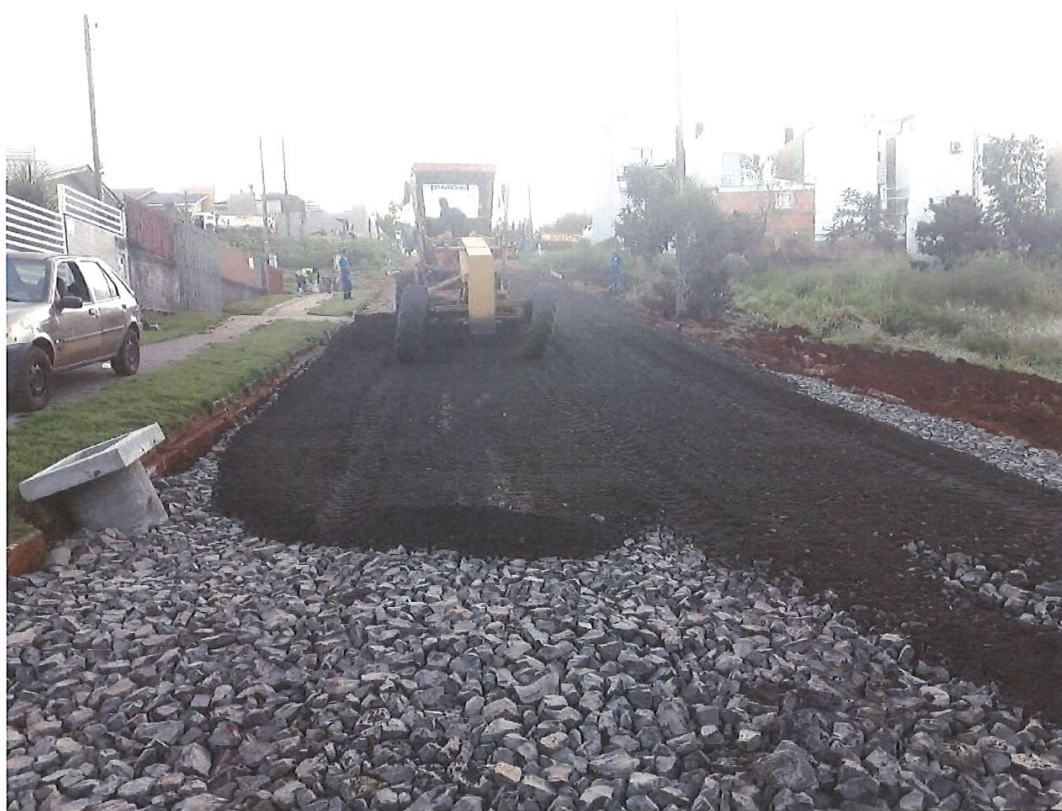
Foto 03: Execução da Base em Brita Graduada.
