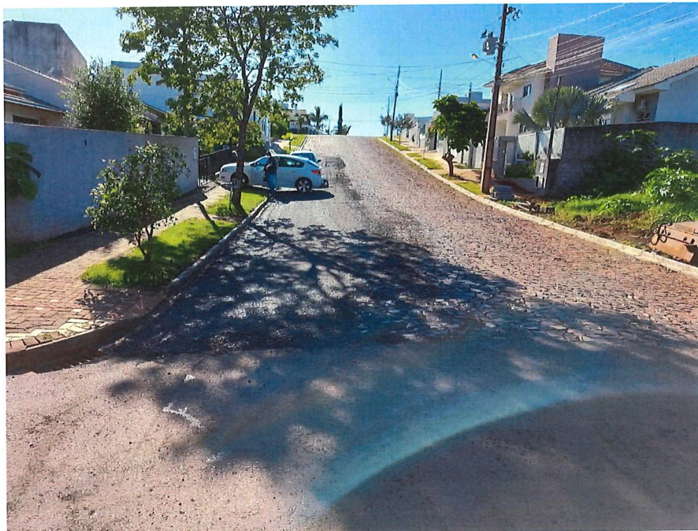
Foto 03: Rua Pioneiro Alberto Braun – Reforço de Base e Meio-Fio
