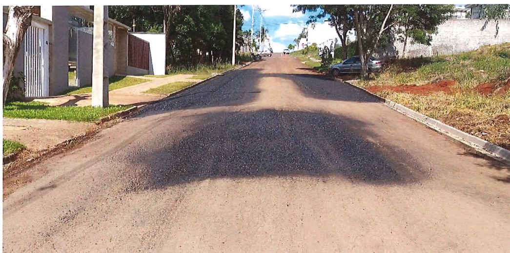
Foto 12: Rua Pedro Soares Trecho 01 – Reforço de Base
