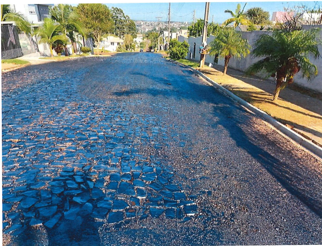
Foto 08: Rua Lídio Guerra – Pintura de Ligação e Reforço de Base e Meio-Fio
