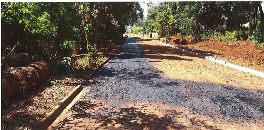
Foto 10: Rua Silveira Martins – Reforço de Base
