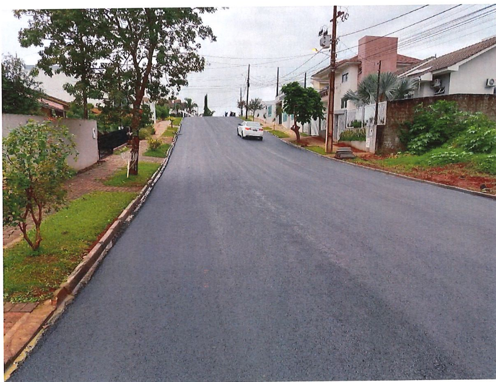
Foto 20: Rua Pioneiro Alberto Braun - Pavimentação
