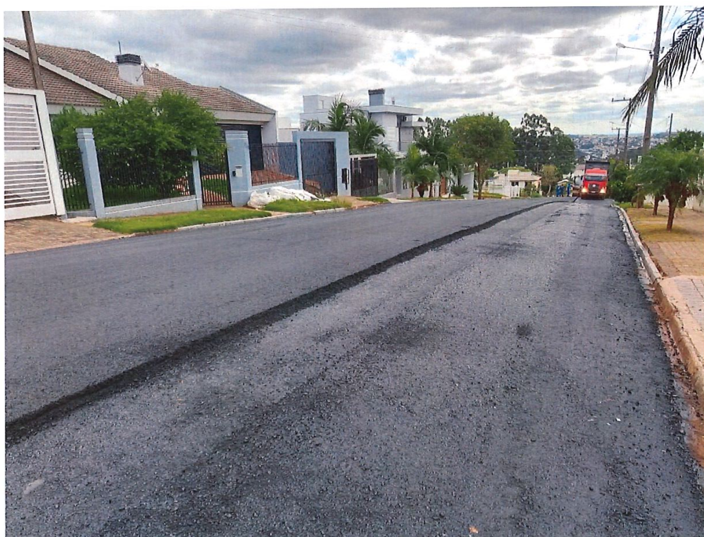
Foto 16: Rua Lídio Guerra - Pavimentação
