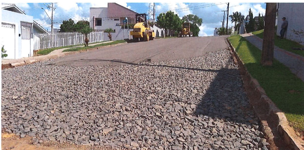
Foto 14: Rua Aimoré – Reforço de Base
