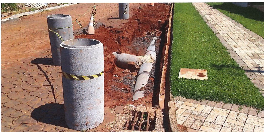
Foto 08: Rua Silva Jardim – Drenagem
