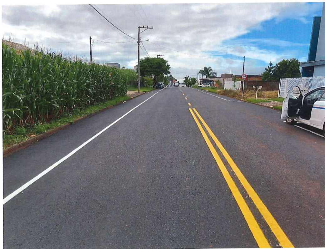
Foto 24: Rua Angela Parzianello – Pavimentação
