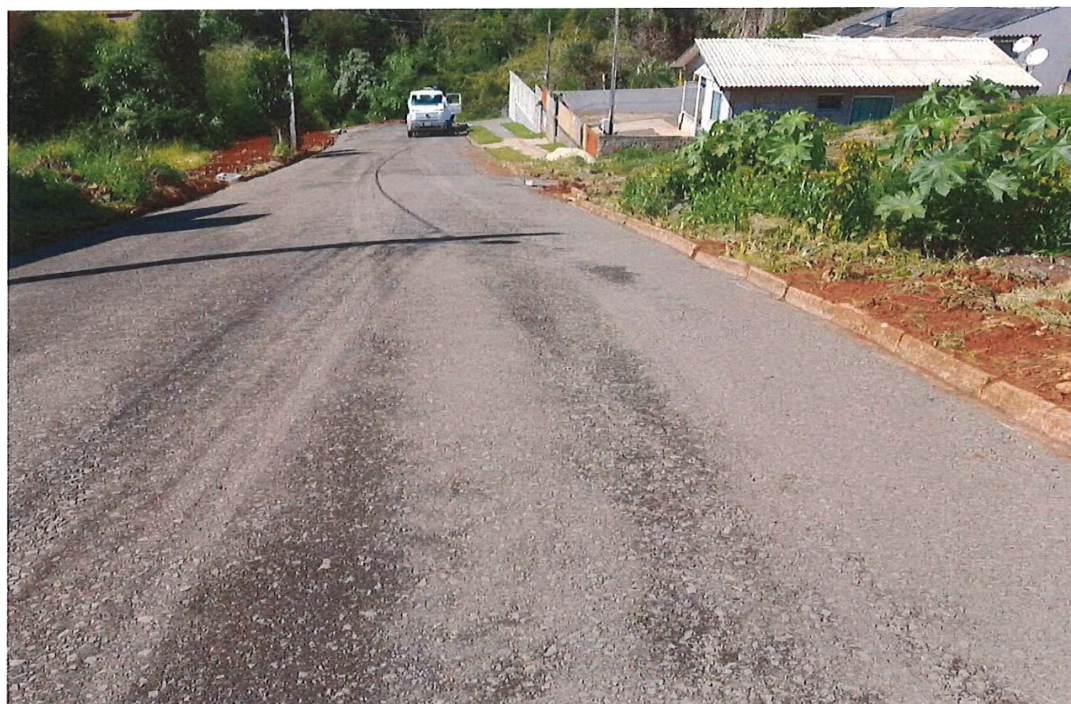
Foto 04: Execução da Base em Brita Graduada.
