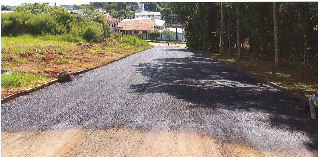
Foto 11: Rua Pedro Soares Trecho 01 – Reforço de Base
