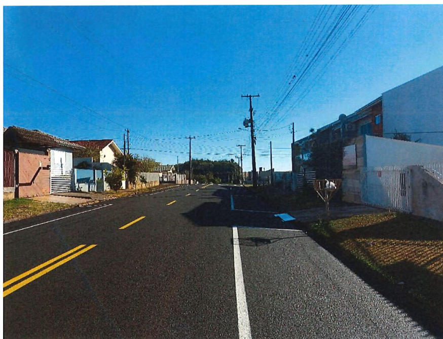
Foto 02: Rua Urbano Wittmann – vista 01
