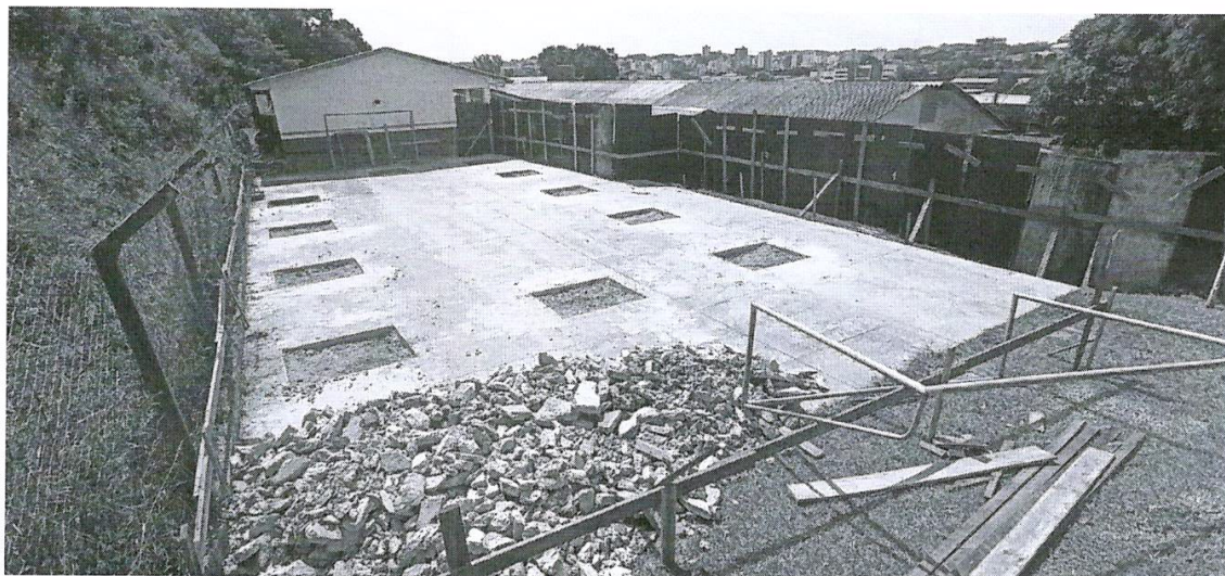
Foto 01: Marcação Fundações (locação)
