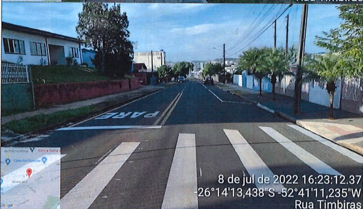
Imagem 11: Pavimentação CBUQ / Sinalização
