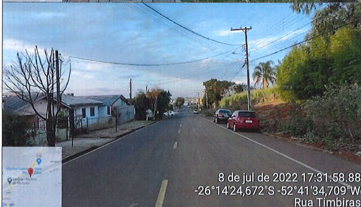
Imagem 23: Pavimentação CBUQ / Sinalização
