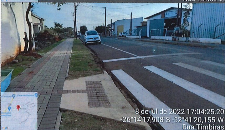
Imagem 17: Pavimentação CBUQ / Sinalização / Calçadas
