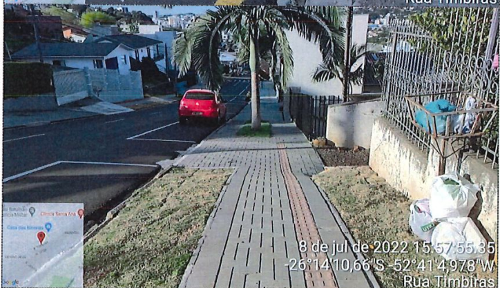
Imagem 06: Pavimentação CBUQ / Sinalização / Calçadas
