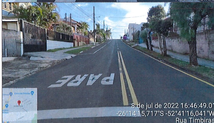
Imagem 15: Pavimentação CBUQ / Sinalização / Calçadas
