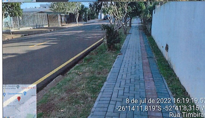
Imagem 08: Pavimentação CBUQ / Sinalização / Calçadas
