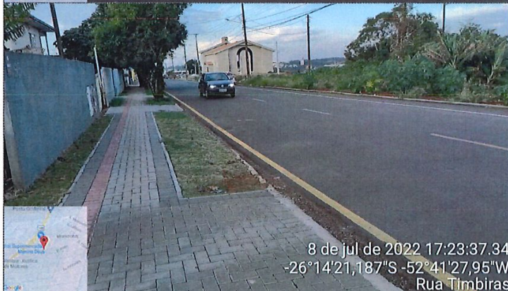
Imagem 21: Pavimentação CBUQ / Sinalização / Calçadas
