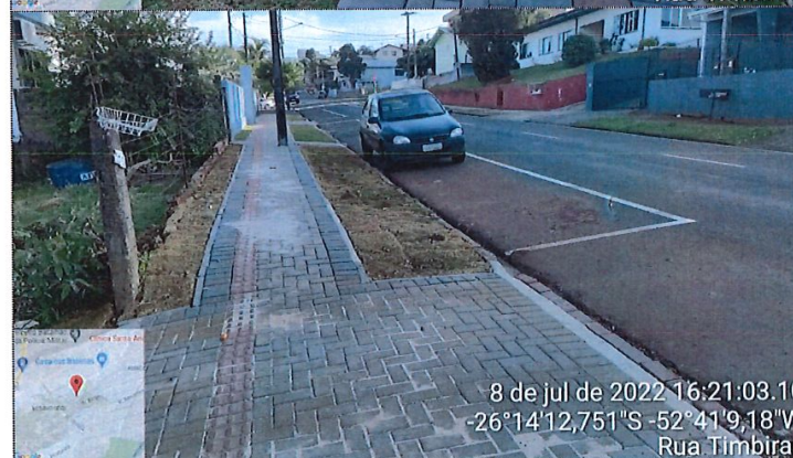
Imagem 09: Pavimentação CBUQ / Sinalização / Calçadas
