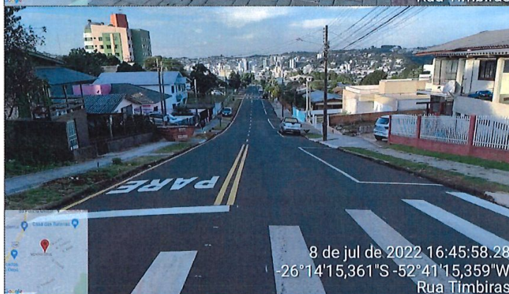
Imagem 14: Pavimentação CBUQ / Sinalização / Calçadas
