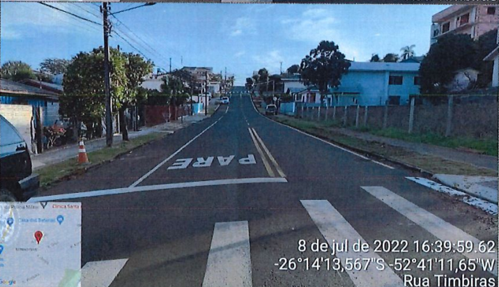
Imagem 12: Pavimentação CBUQ / Sinalização / Calçadas
