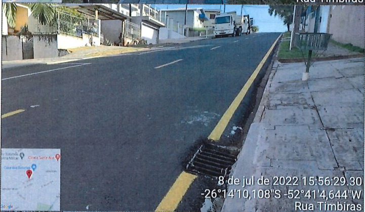
Imagem 05: Pavimentação CBUQ / Sinalização / Drenagem
