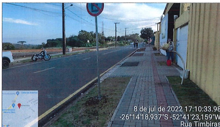
Imagem 19: Pavimentação CBUQ / Sinalização / Calçadas
