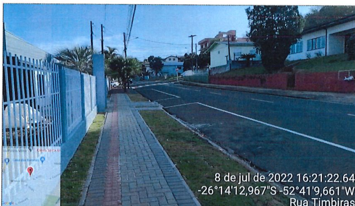
Imagem 10: Pavimentação CBUQ / Sinalização / Calçadas
