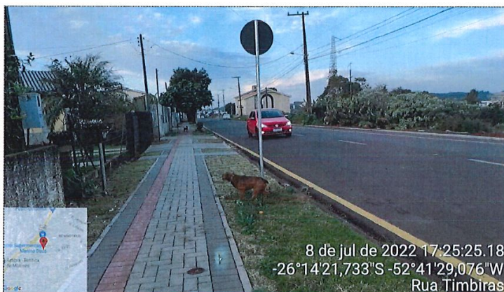
Imagem 22: Pavimentação CBUQ / Sinalização / Calçadas
