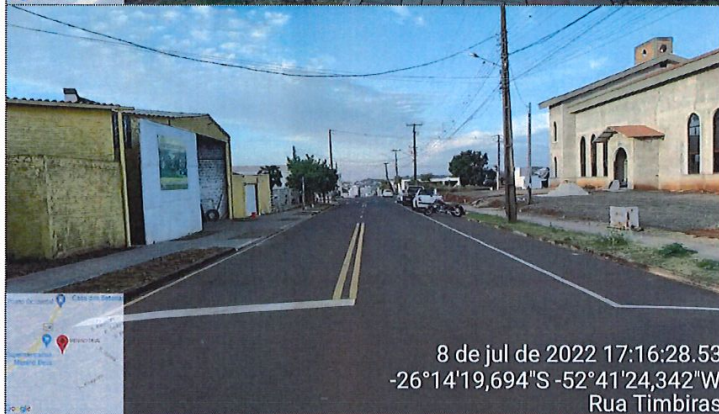
Imagem 20: Pavimentação CBUQ / Sinalização / Calçadas
