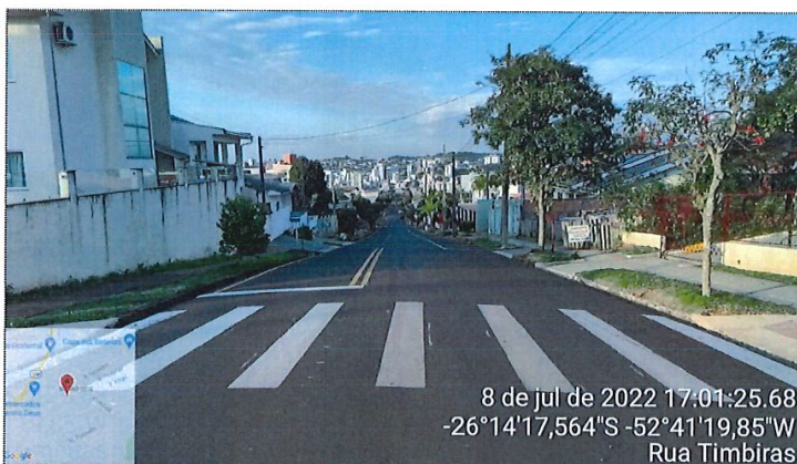
Imagem 16: Pavimentação CBUQ / Sinalização / Calçadas
