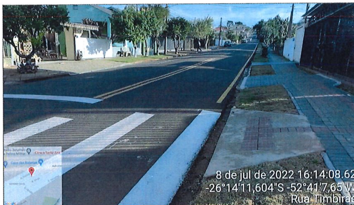
Imagem 07: Pavimentação CBUQ / Sinalização / Calçadas
