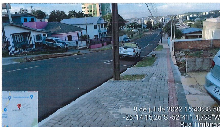
Imagem 13: Pavimentação CBUQ / Sinalização / Calçadas
