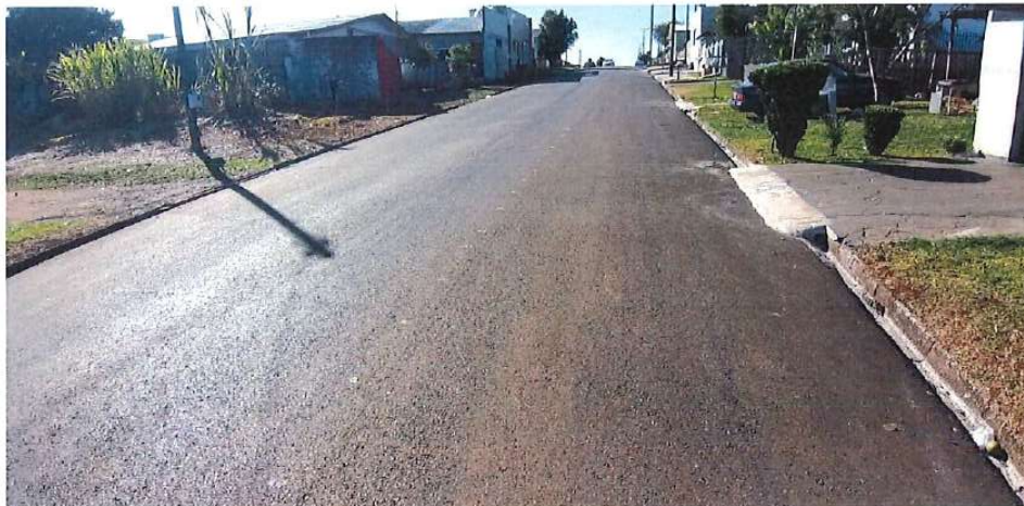
Foto 10: Rua Papa João XXIII – pavimentação
