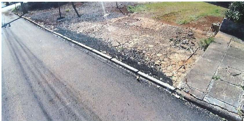
Foto 31: Rua Vieira da Costa – meio fio
