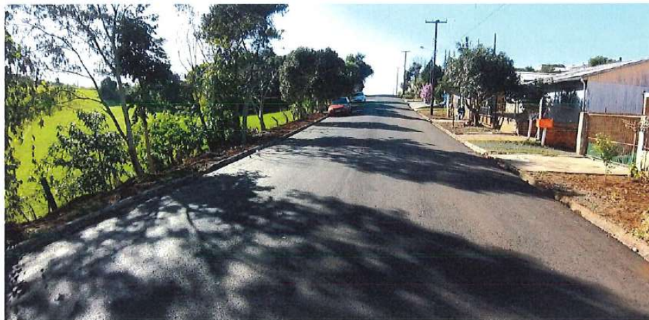
Foto 16: Rua do Príncipe – pavimentação
