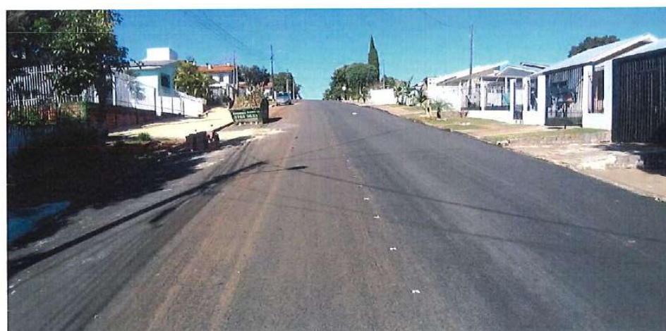
Foto 30: Rua Vieira da Costa – pavimentação
