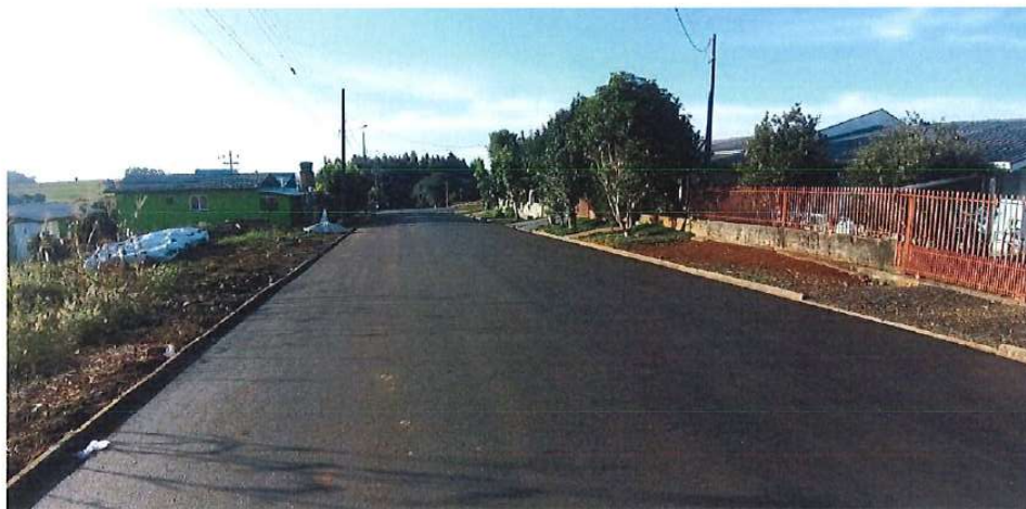
Foto 70: Rua Theóphilo Petrycoski – pavimentação
