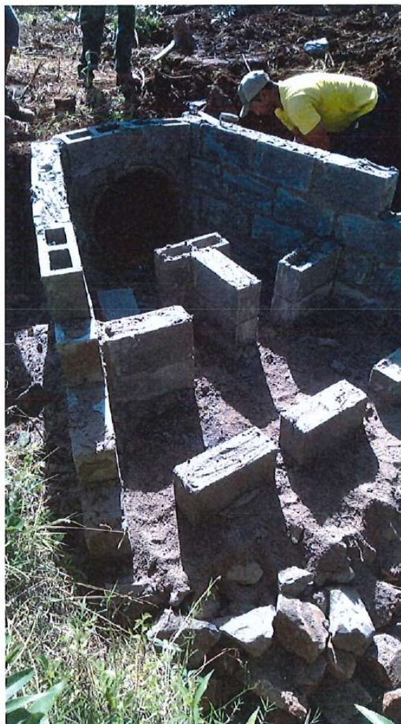
Foto 19: Dissipador de Energia
