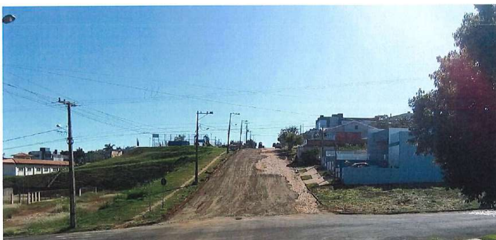
Foto 42: Rua Melci Dal Molin – reforço de base
