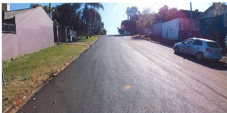
Foto 29: Rua Vieira da Costa – pavimentação
