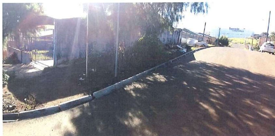
Foto 21: Rua Aldoino Dalmolin - meio fio
