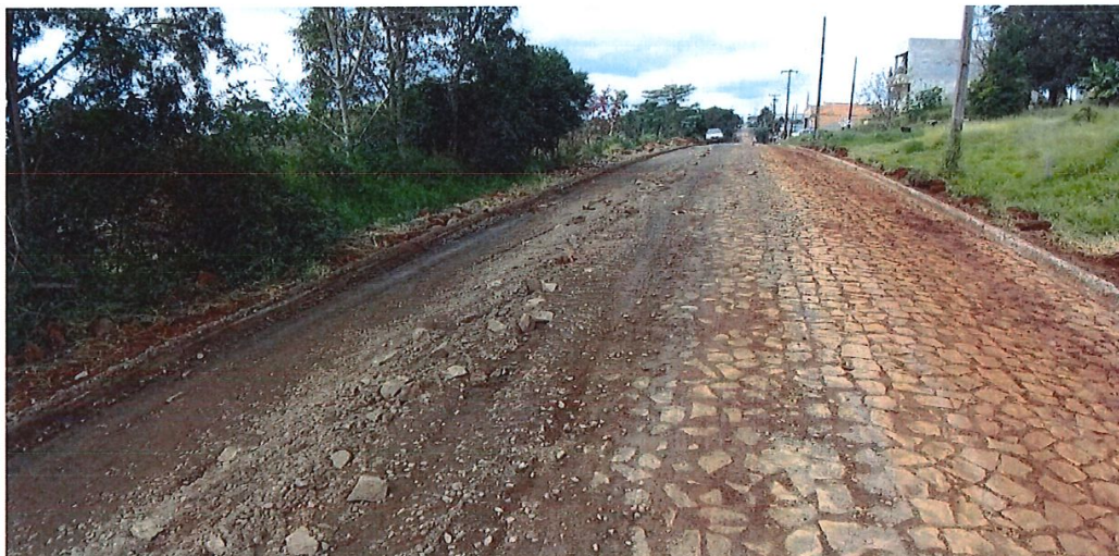
Foto 03: reforço de base Rua do Príncipe
