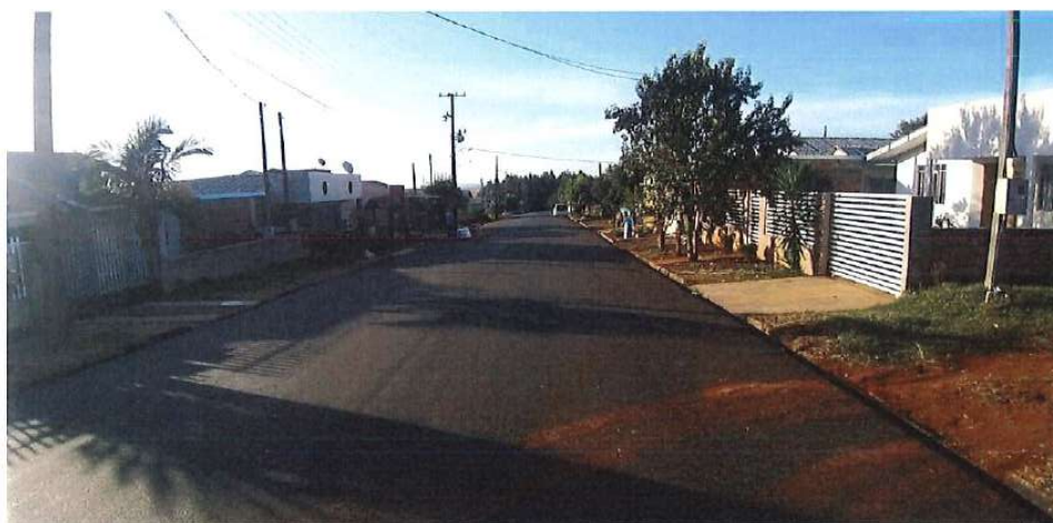
Foto 69: Rua Theóphilo Petrycoski – pavimentação
