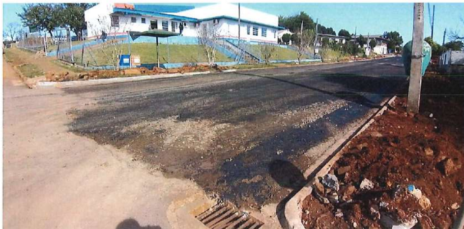
Foto 61: Rua 14 de Dezembro – reforço de base
