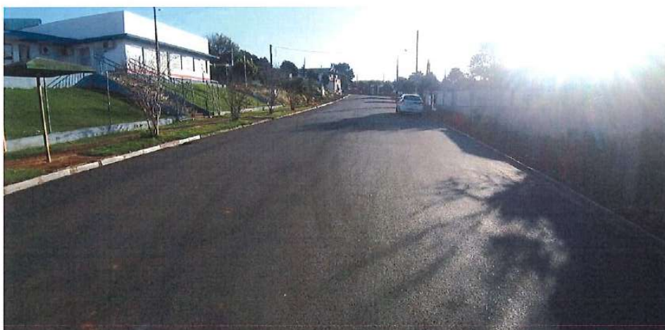
Foto 62: Rua 14 de Dezembro – pavimentação
