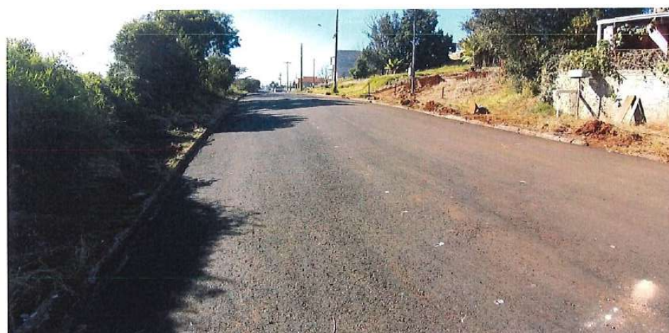
Foto 15: Rua do Príncipe – pavimentação
