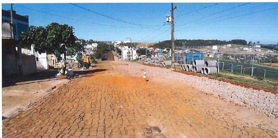
Foto 41: Rua Melci Dal Molin – reforço de base
