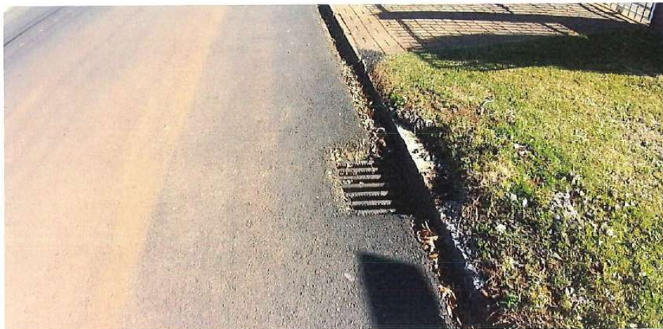
Foto 37: Rua Tuiuti - drenagem
