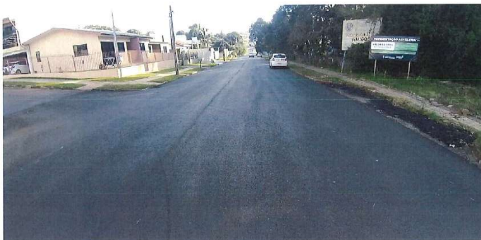
Foto 55: Rua José Fraron – pavimentação
