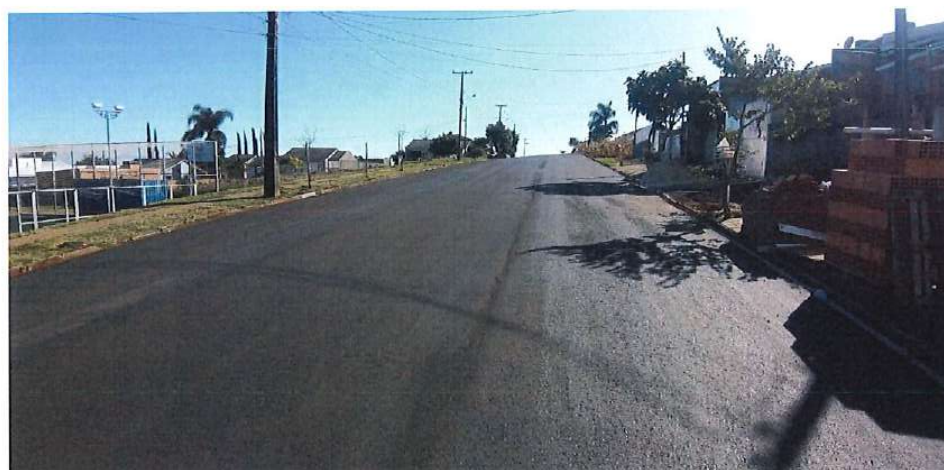
Foto 45: Rua Melci Dal Molin – pavimentação
