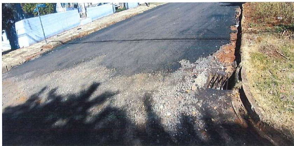
Foto 25: Rua Vieira da Costa – reforço de base e drenagem
