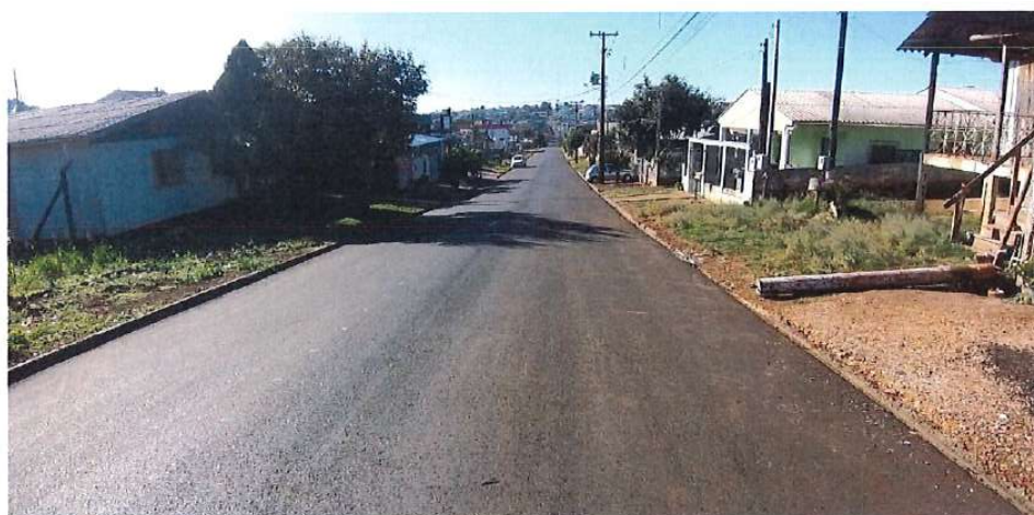
Foto 18: Rua do Príncipe – pavimentação
