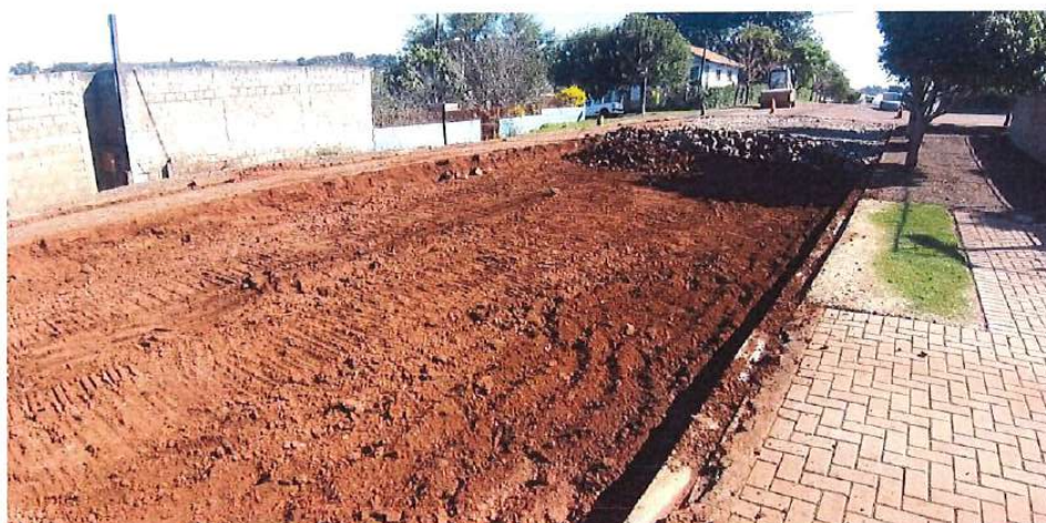
Foto 35: Rua Tuiuti - reforço de base
