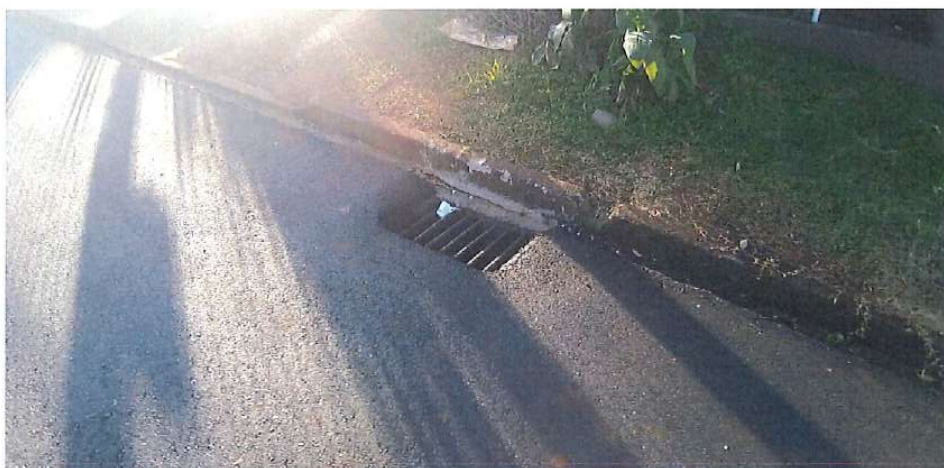
Foto 65: Rua 14 de Dezembro – drenagem
