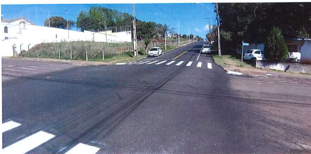
Foto 05: Rua Pedro José da Silva (trecho 02)
