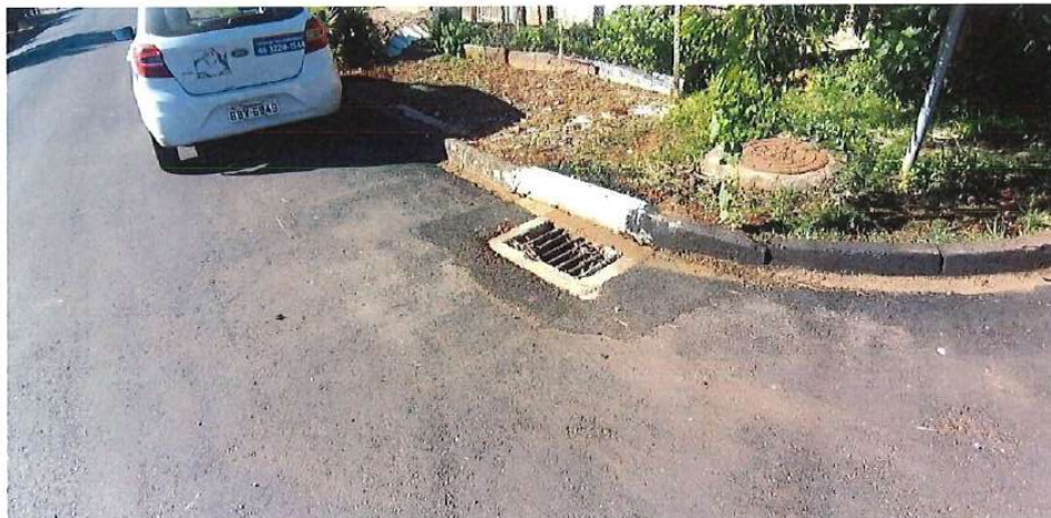
Foto 19: Rua do Príncipe – drenagem
