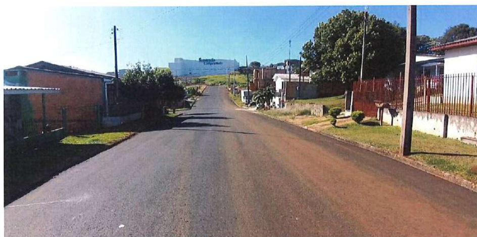
Foto 20: Rua Aldoino Dalmolin - pavimentação
