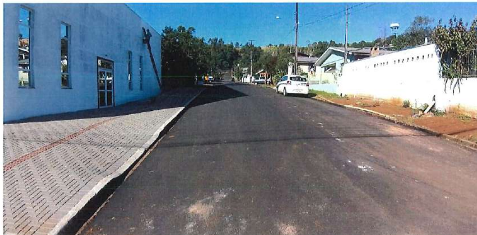
Foto 04: Rua da República - pavimentação
