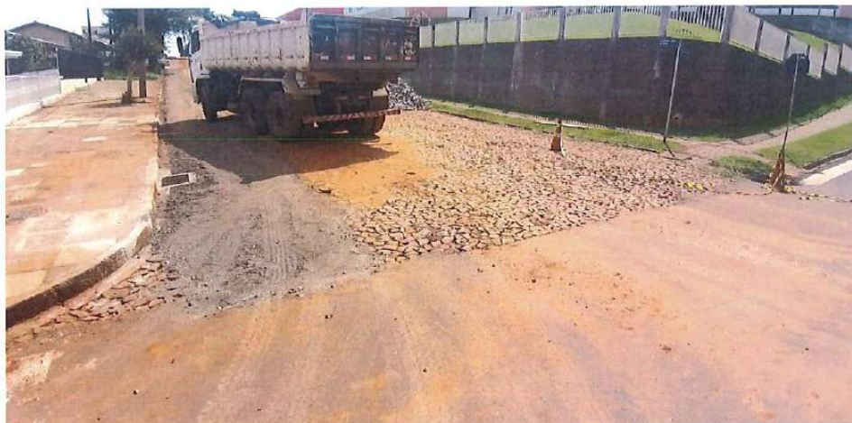
Foto 46: Rua Pedro José da Silva (Trecho 01) – reforço de base e drenagem
