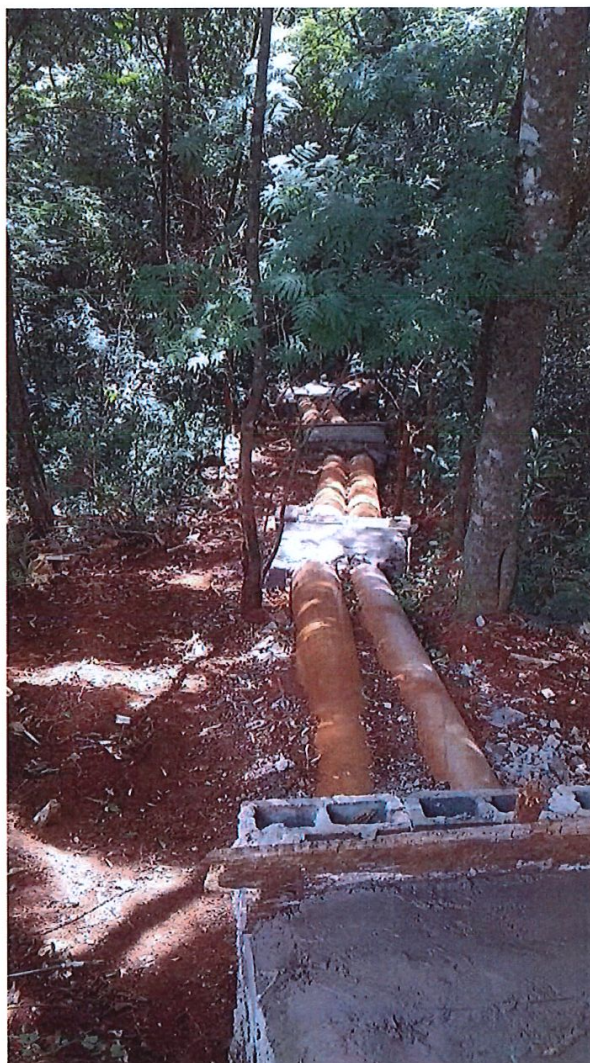
Foto 04: Drenagem Rua Tuiuti
