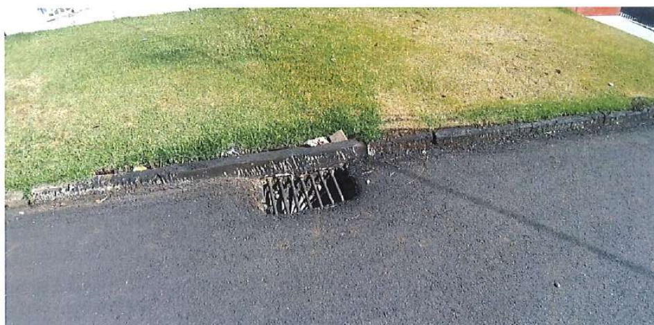
Foto 33: Rua Vieira da Costa – drenagem
