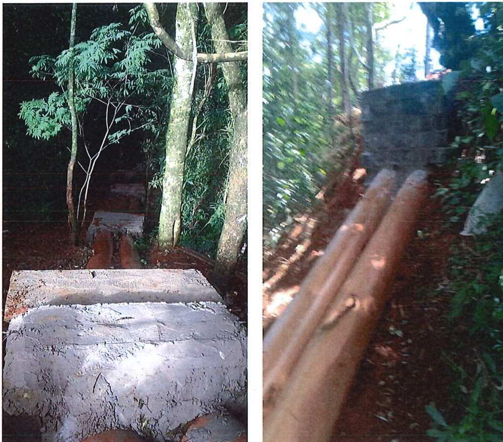
Foto 05: Drenagem Rua Tuiuti
