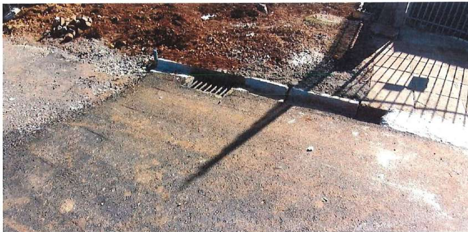
Foto 40: Rua Tuiuti – meio fio e drenagem
