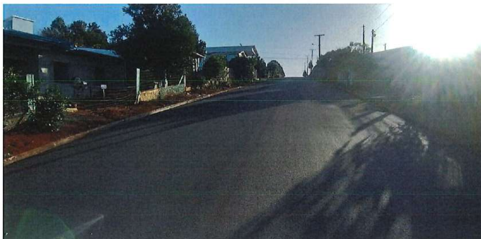
Foto 64: Rua 14 de Dezembro – pavimentação
