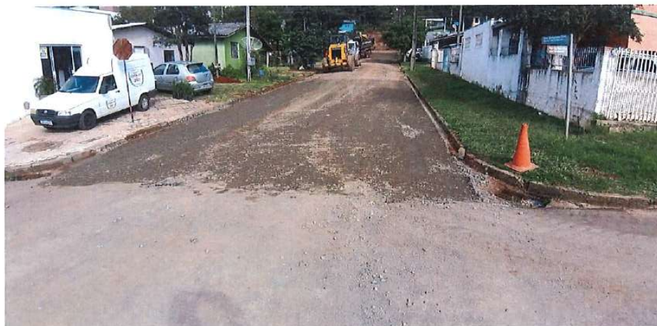
Foto 03: Rua da República - reforço de base
