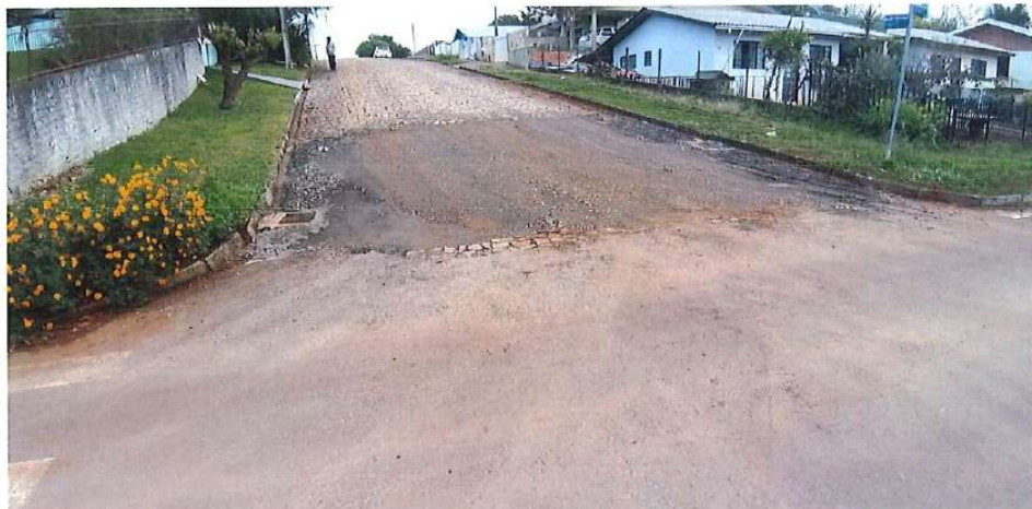
Foto 13: Rua do Príncipe – reforço de base
