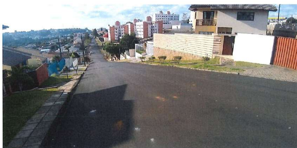
Foto 51: Rua Pedro José da Silva (Trecho 01) – pavimentação
