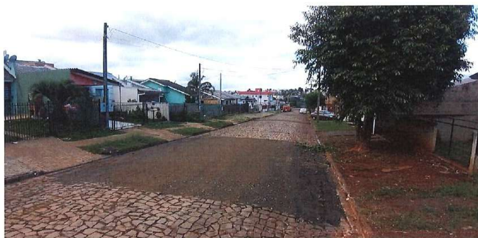
Foto 14: Rua do Príncipe – reforço de base
