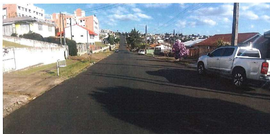
Foto 48: Rua Pedro José da Silva (Trecho 01) – pavimentação
