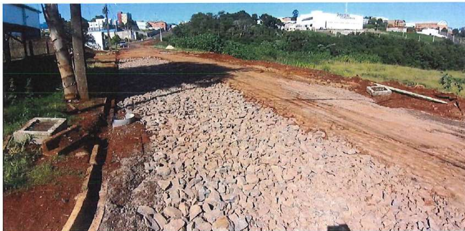
Foto 34: Rua Tuiuti - reforço de base
