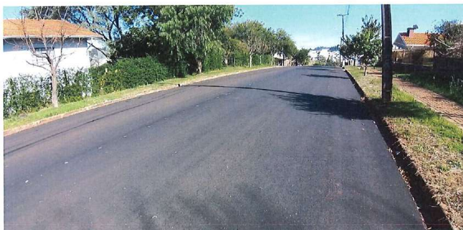
Foto 38: Rua Tuiuti - pavimentação
