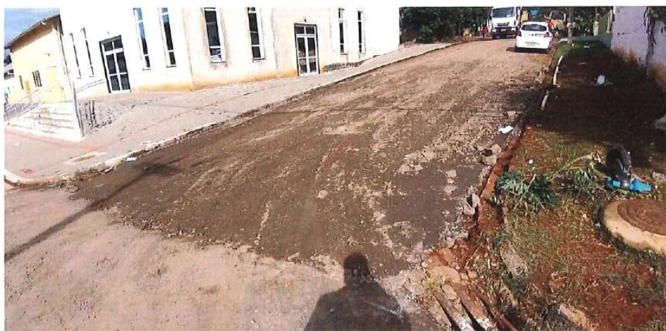
Foto 02: Rua da República - reforço de base
