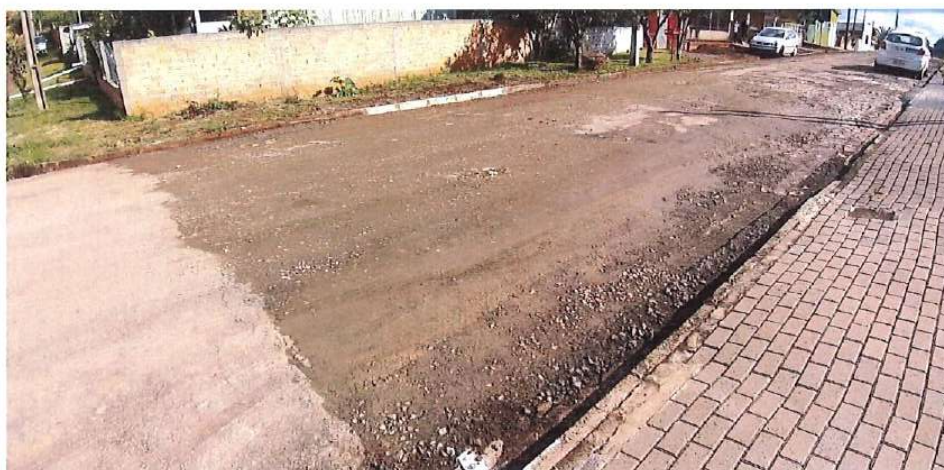
Foto 08: Rua Papa João XXIII – reforço de base e meio fio
