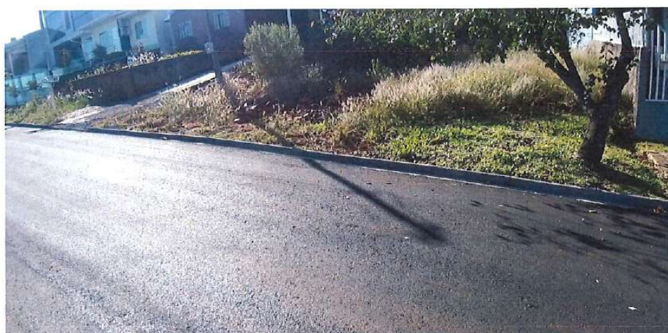
Foto 44: Rua Melci Dal Molin – meio fio
