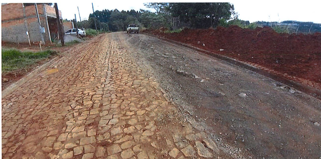
Foto 02: reforço de base Rua do Príncipe
