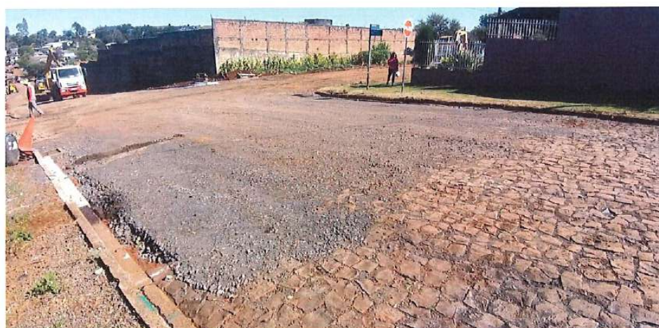
Foto 23: Rua Vieira da Costa – reforço de base
