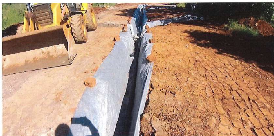
Foto 26: Rua Vieira da Costa – execução de dreno
