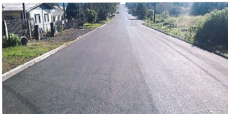
Foto 27: Rua Vieira da Costa – pavimentação e meio fio
