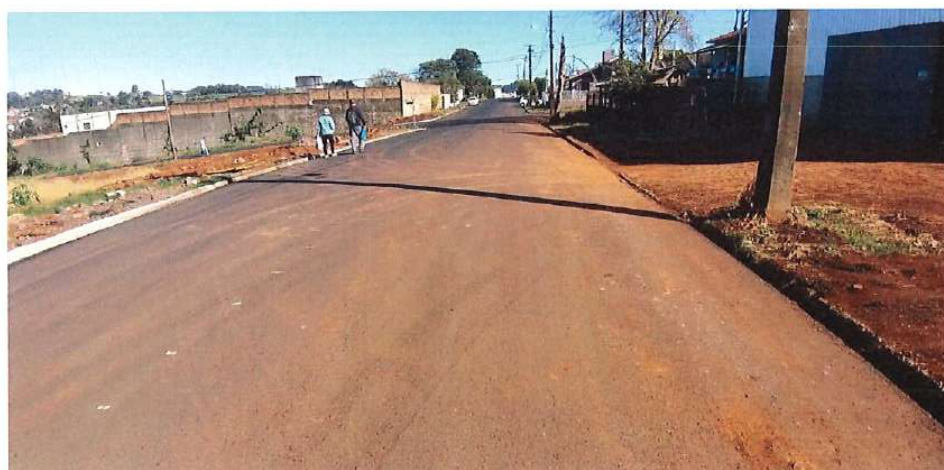
Foto 36: Rua Tuiuti - pavimentação e meio fio
