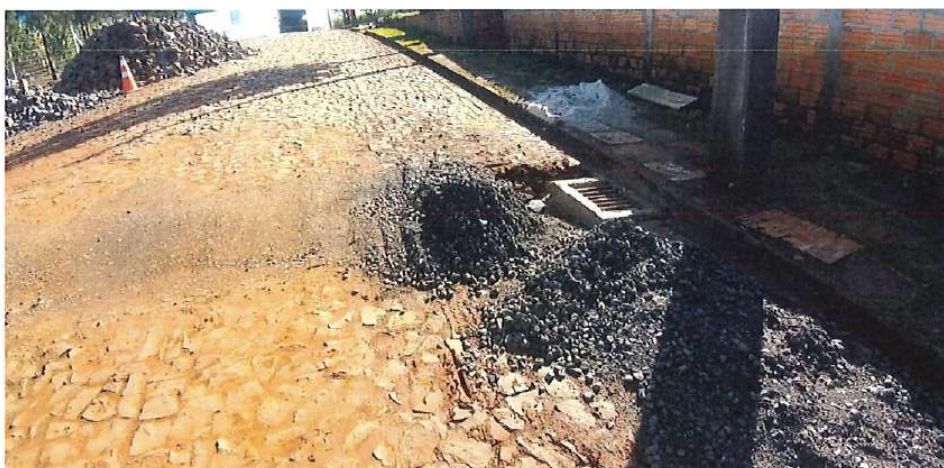
Foto 63: Rua 15 de Fevereiro – drenagem e reforço de base
