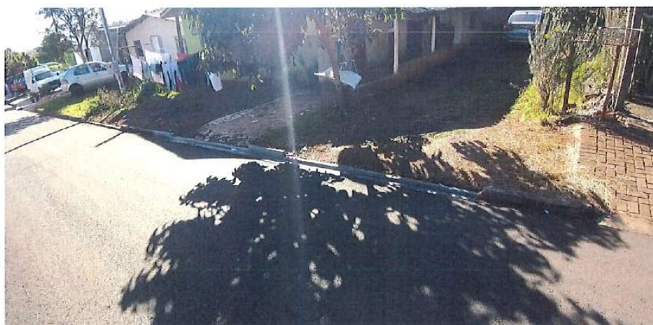
Foto 06: Rua da República - meio fio
