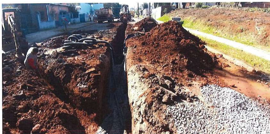
Foto 53: Rua José Fraron – execução de dreno
