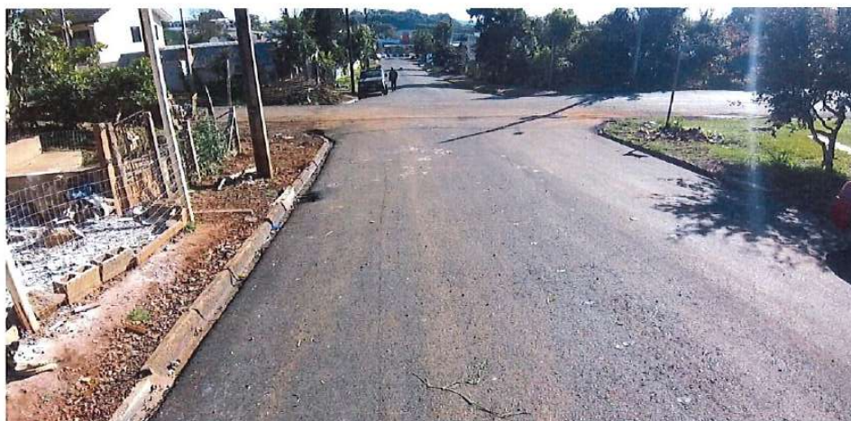
Foto 05: Rua da República - pavimentação
