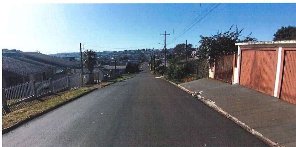
Foto 17: Rua do Príncipe – pavimentação
