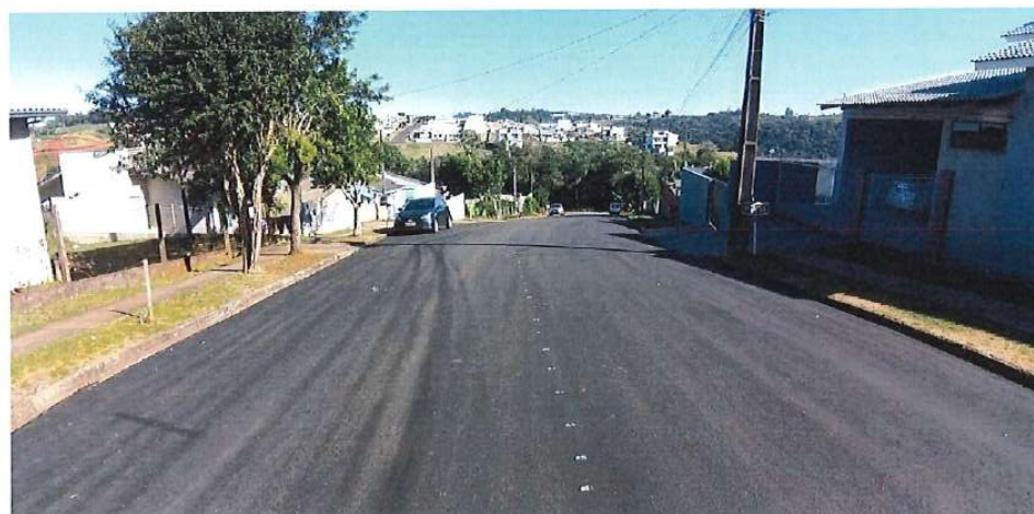
Foto 39: Rua Tuiuti - pavimentação
