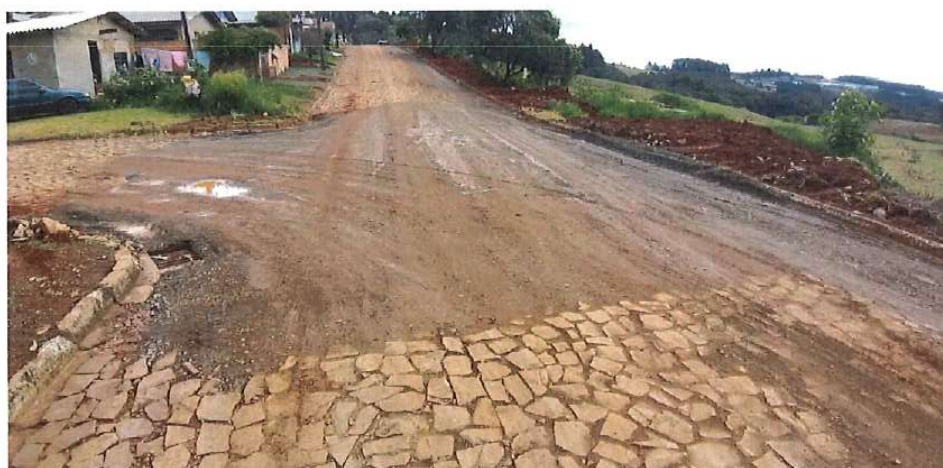
Foto 12: Rua do Príncipe – reforço de base
