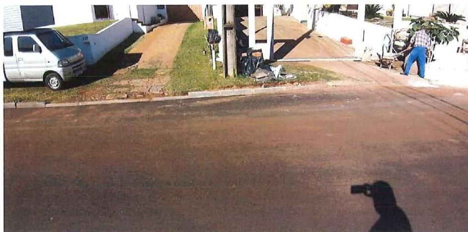
Foto 22: Rua Aldoino Dalmolin - meio fio
