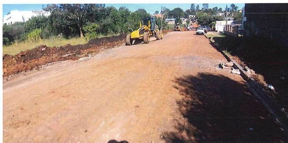
Foto 24: Rua Vieira da Costa – reforço de base e drenagem
