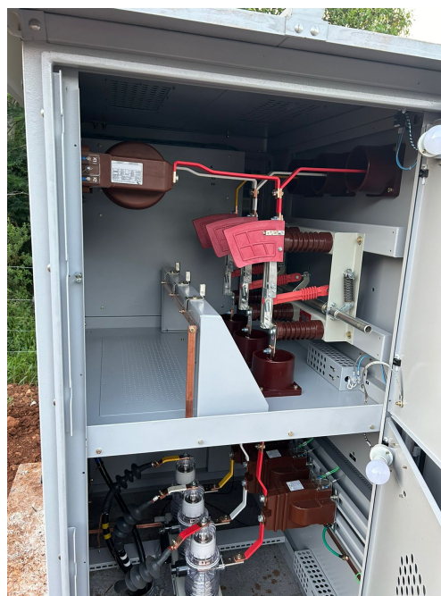
Figura 8 – Chave seccionadora – Visão posterior.
