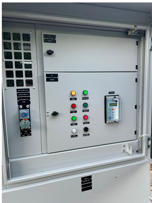
Figura 9 – Chave seccionadora – Visão Frontal.
