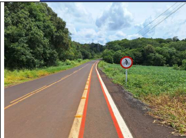
FOTO 13: SINALIZAÇÃO VERTICAL E HORIZONTAL
