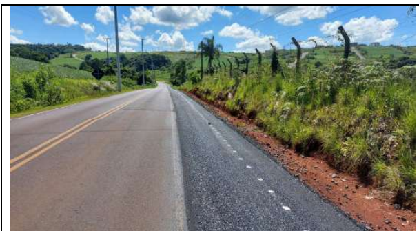
FOTO 03: BASE DE BRITA GRADUADA E IMPRIMAÇÃO
