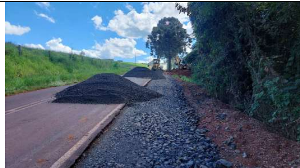
FOTO 08: EXECUÇÃO DE BASE DE BRITA GRADUADA
