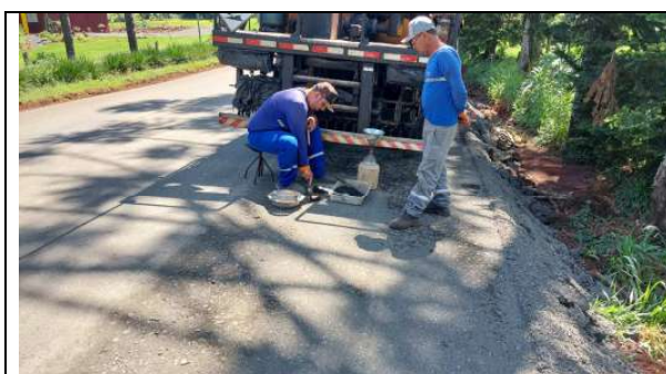
FOTO 06: ENSAIO BASE DE BRITA GRADUADA
