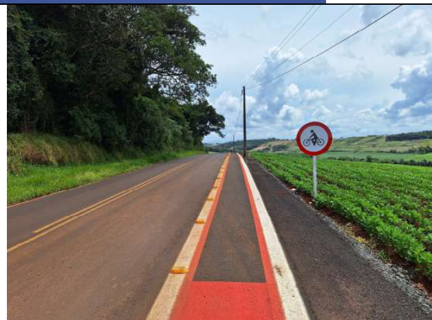
FOTO 14: SINALIZAÇÃO VERTICAL E HORIZONTAL
