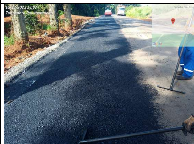
FOTO 17: PAVIMENTAÇÃO EM CBUQ
