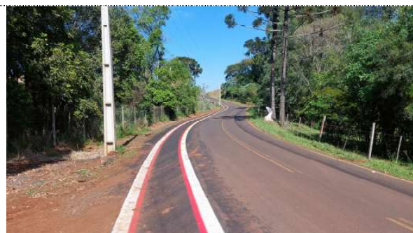
Fotografia 12. Ciclovia pavimentada com sinalização horizontal.
