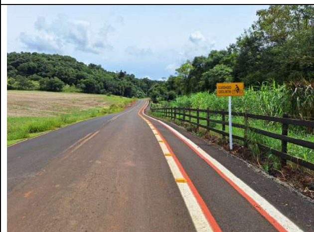
FOTO 15: SINALIZAÇÃO VERTICAL E HORIZONTAL
