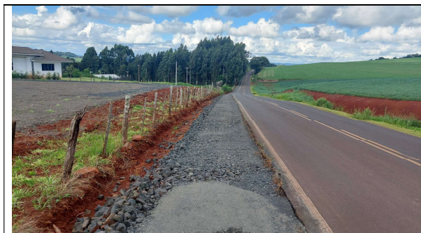
FOTO 06: SUB-BASE EM MACADAME
