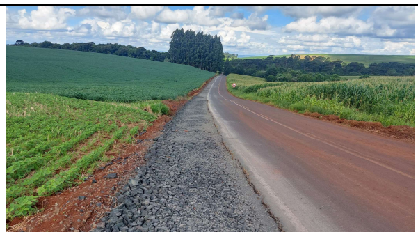
FOTO 07: SUB-BASE EM MACADAME
