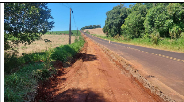
FOTO 02: ESCAVAÇÃO, COMPACTAÇÃO E REGULARIZAÇÃO
