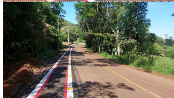
Fotografia 13. Ciclovia pavimentada com sinalização horizontal.
