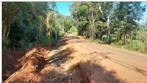
Fotografia 07: Sub-base em rachão (macadame).
