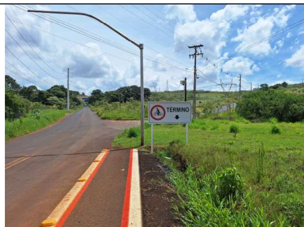
FOTO 12: SINALIZAÇÃO VERTICAL E HORIZONTAL
