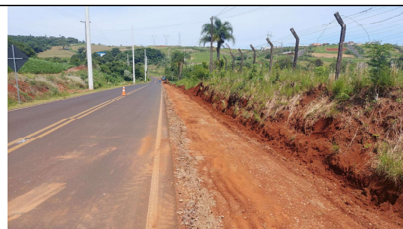
FOTO 03: ESCAVAÇÃO, COMPACTAÇÃO E REGULARIZAÇÃO
