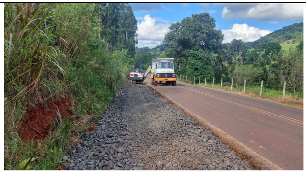
FOTO 09: SUB-BASE EM MACADAME
