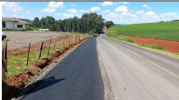
FOTO 07: BASE DE BRITA GRADUADA E IMPRIMAÇÃO
