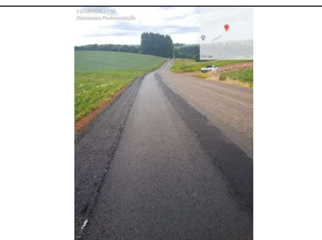
FOTO 18: PAVIMENTAÇÃO EM CBUQ
