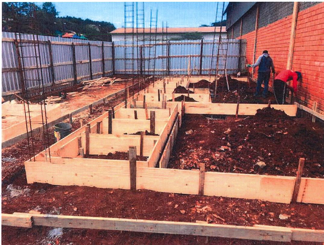
Foto 3: Locação e Estrutura de concreto (Fundação e Vigas Baldrame)
