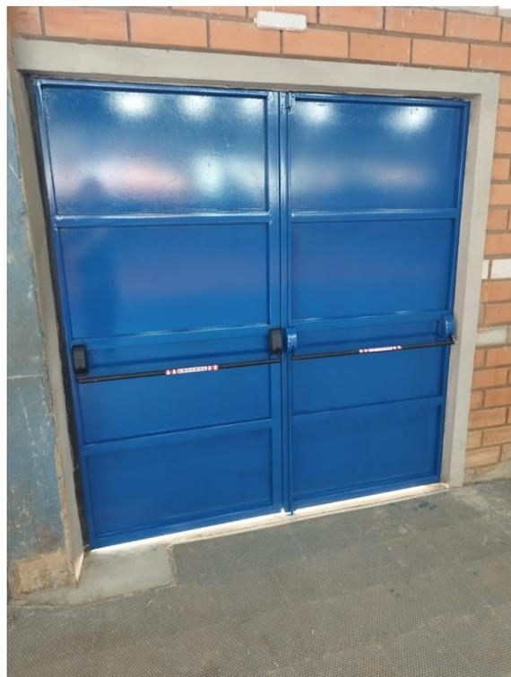
Foto 6: Pintura porta de ferro. (Saída de emergência)
