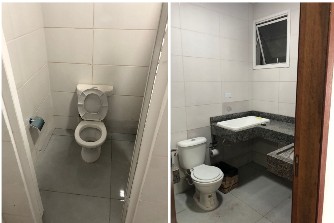
Foto 4: Vaso sanitário com assento. Bancada em granito. Revestimento cerâmico. Janela Basculante.
