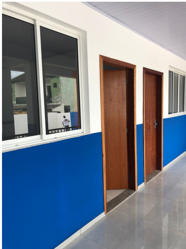
Foto 6: Janelas de alumínio e vidro; portas em madeira. Piso cerâmico. Pintura externa.
