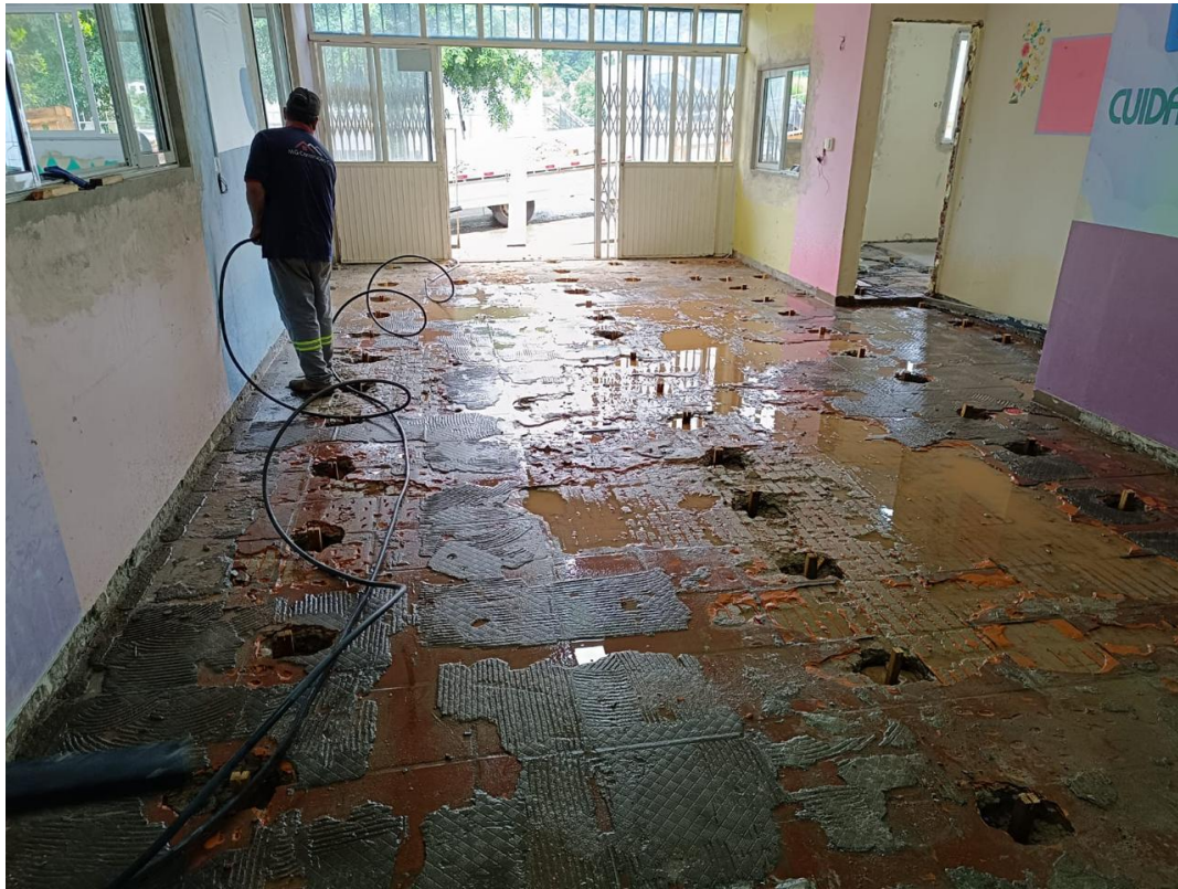
Foto 1: Remoção de revestimento cerâmico.
