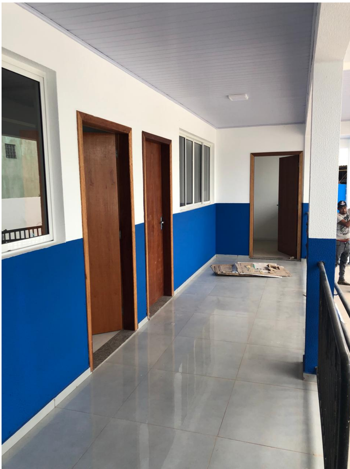
Foto 4: Pintura externa. Piso, portas e janelas. Guarda-corpo.
