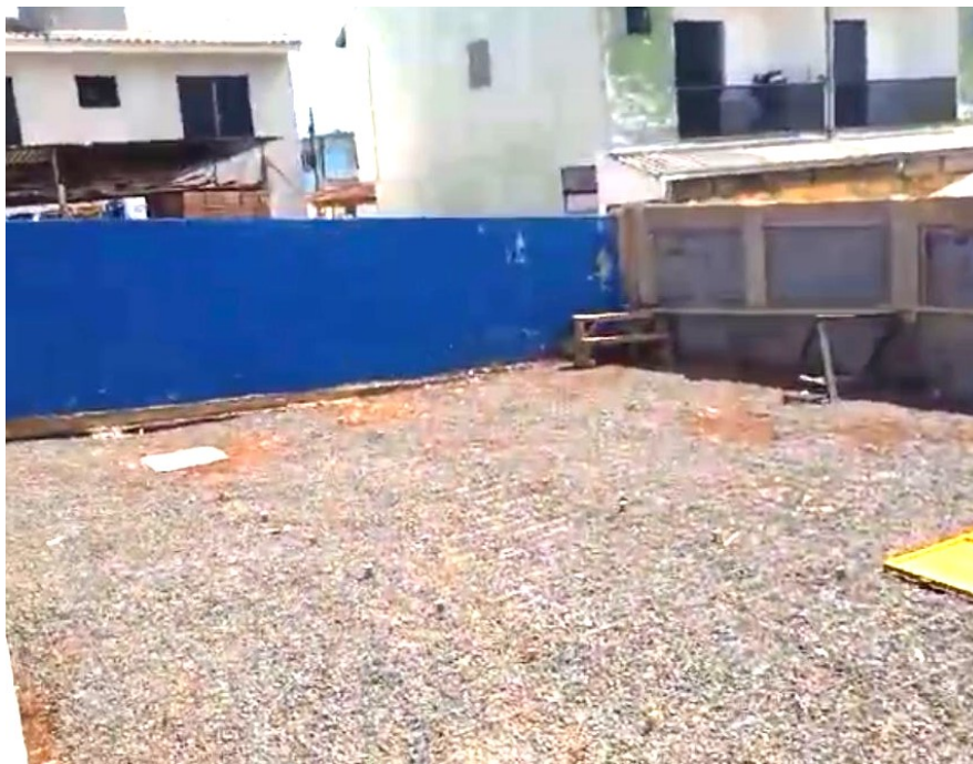
Foto 4: Muro de Arrimo e base para playground.
