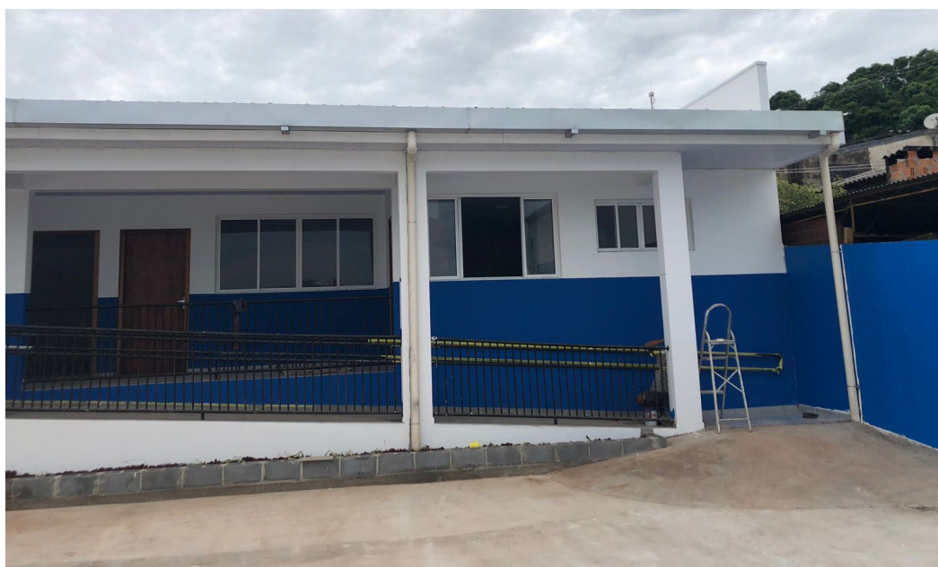
Foto 7: Calhas, Pintura externa, Janelas, Portas.
