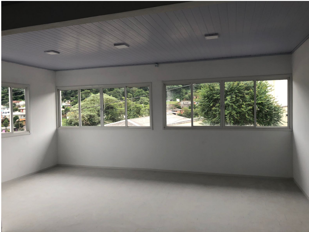
Foto 1: Janelas. Piso Vinílico. Pintura Interna.
