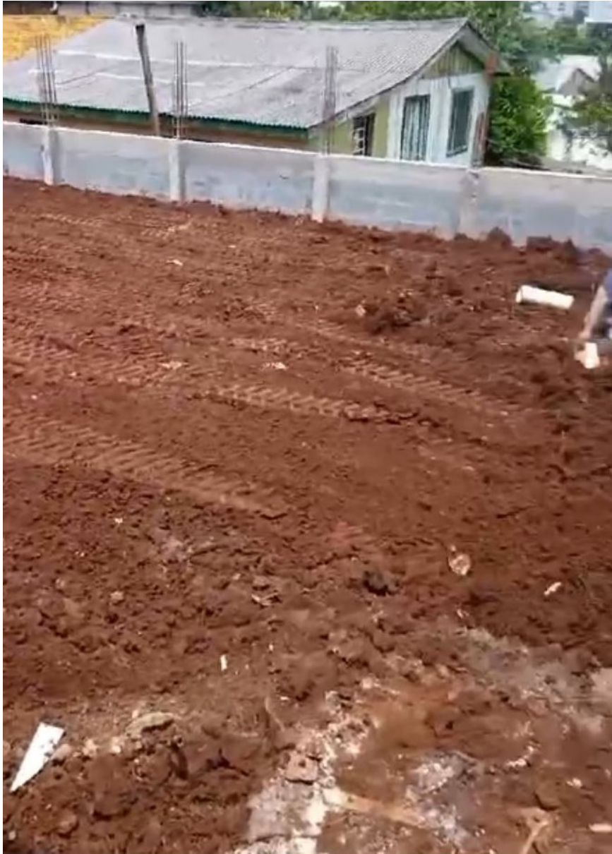
Foto 3: Muro de Arrimo e base para playground.
