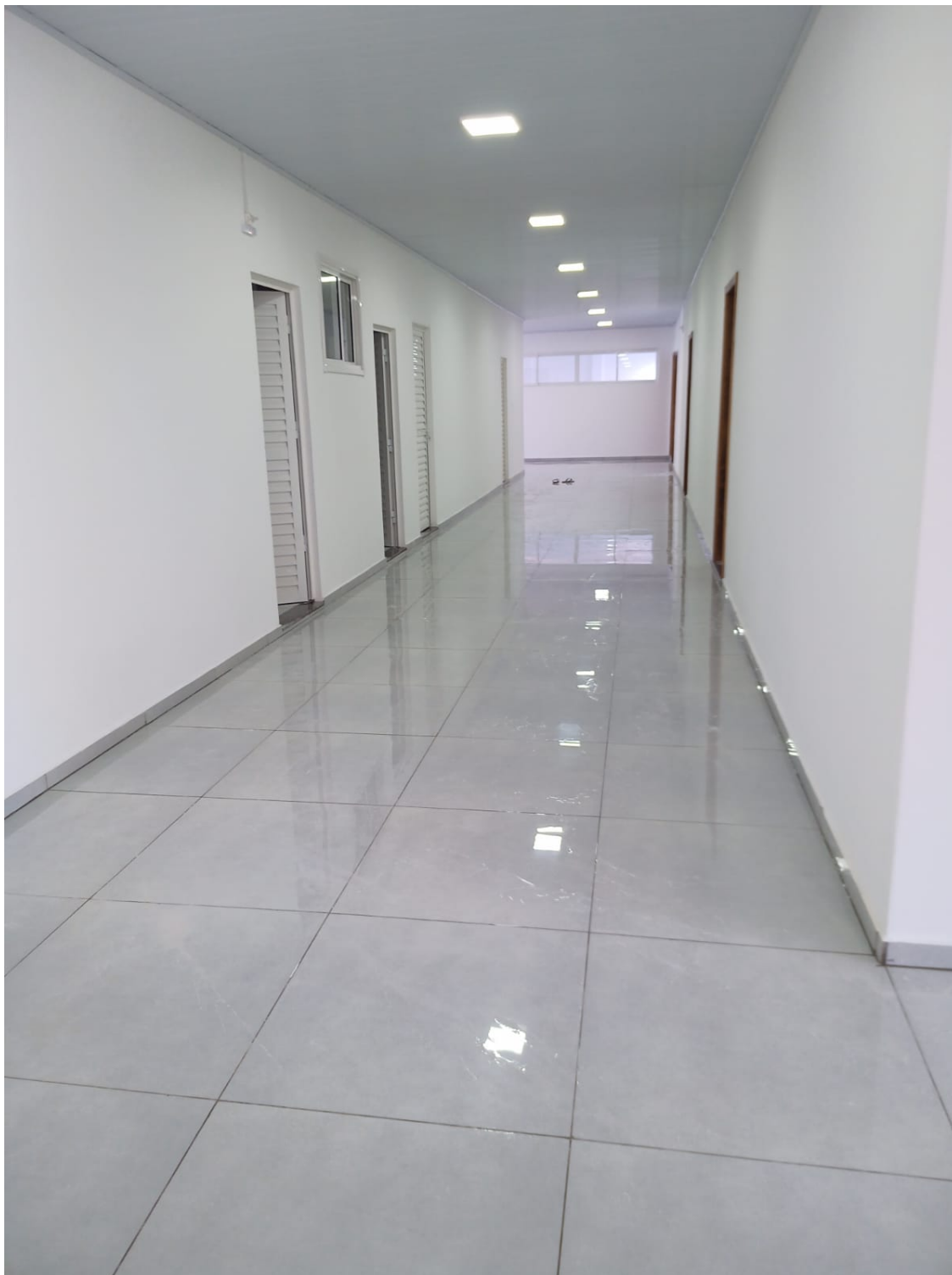
Foto 3: Área Interna (piso, portas, janelas, forro e iluminação).
