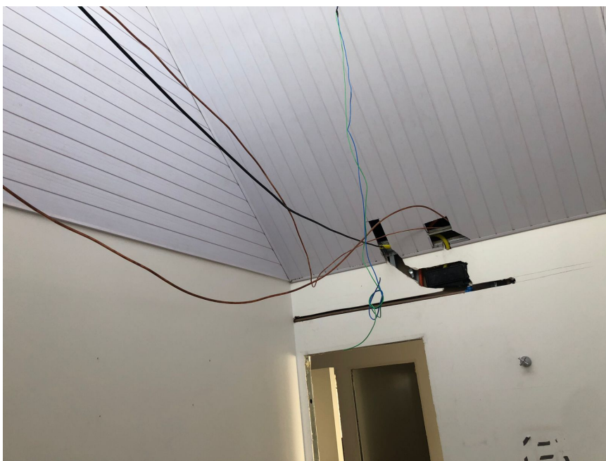
Foto 7: Troca de fiação elétrica e pontos de ar condicionado.
