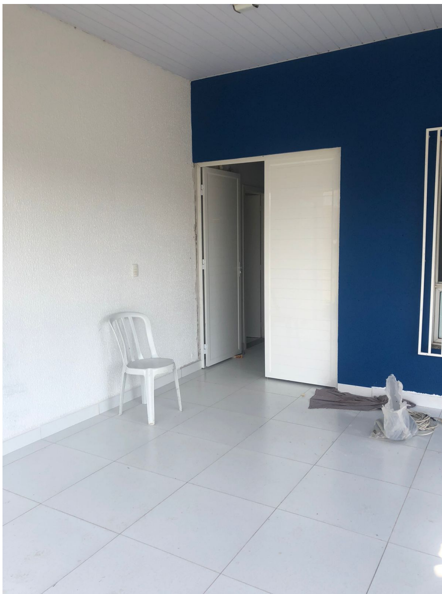
Foto 2: Piso; Porta; pintura externa.
