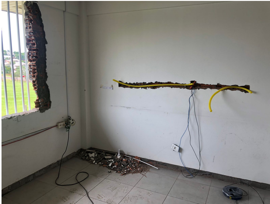
Foto 8: Remoção de alvenaria e colocação de novas aberturas. Novos pontos de elétrica.
