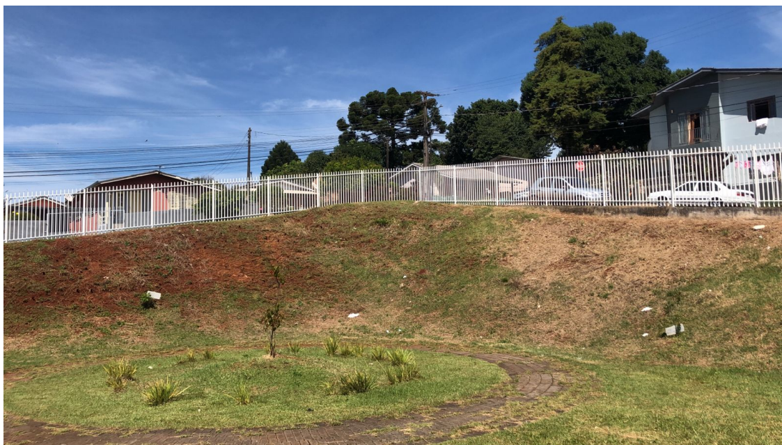
Foto 6: Pintura de Cercamento externo.
