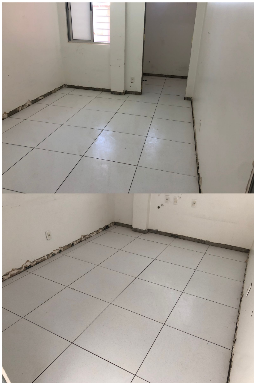
Foto 3: Execução de piso cerâmico.
