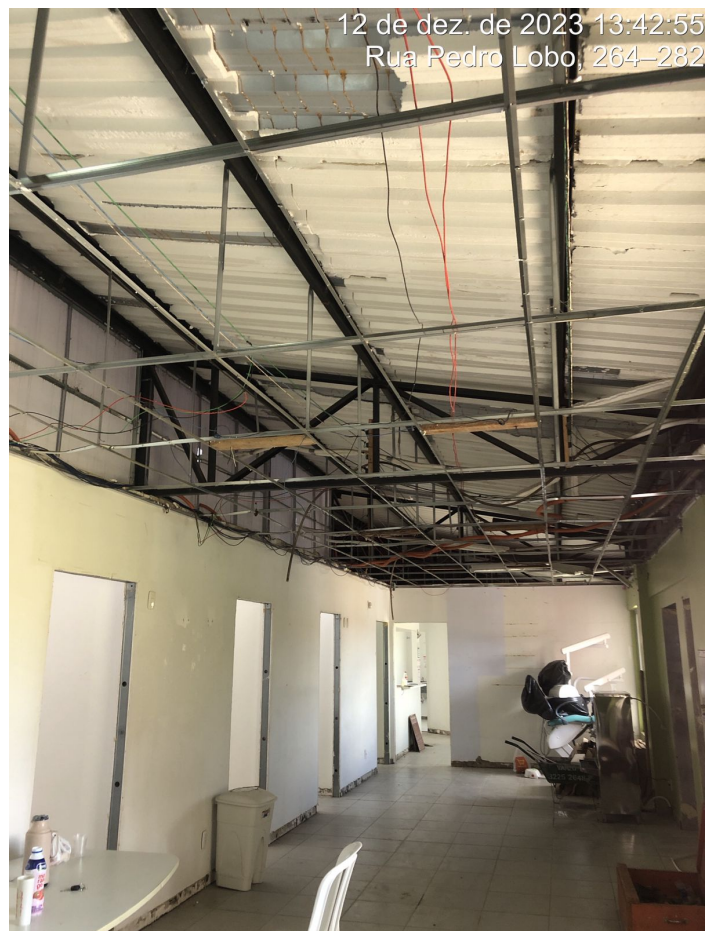
Foto 6: Remoção e troca de forro de PVC.
