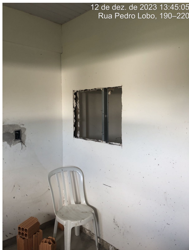
Foto 9: Paredes em drywall. Abertura de óculo.
