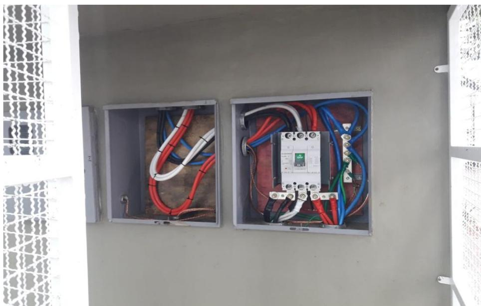
Figura 8 – Detalhe de passagem caixa DN e caixa GN Especial
