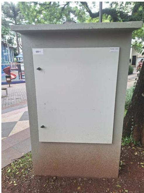
Figura 15 – QD-2 Com mureta e caixa com tampa
