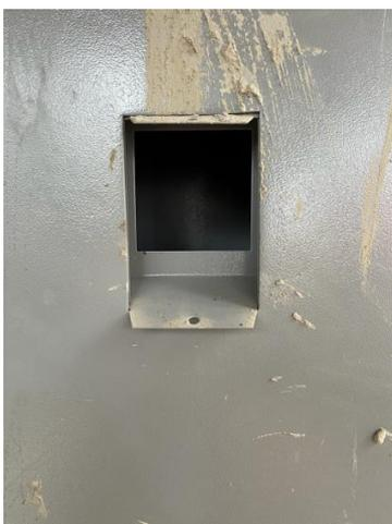
Figura 6 – Detalhe da caixa de proteção sem o disjuntor.
