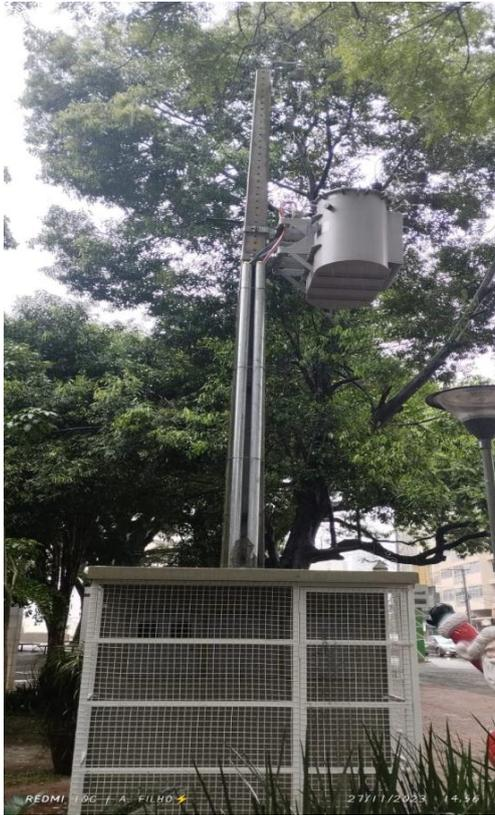
Figura 5 – Eletroduto Galvanizado e cabeamento
