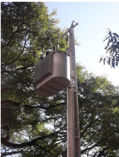
Figura 4 – Detalhe das buchas, para-raios, cruzeta, suporte do transformador e parafusos.
