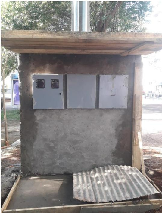
Figura 1 – Mureta com caixas de medição e proteção.
