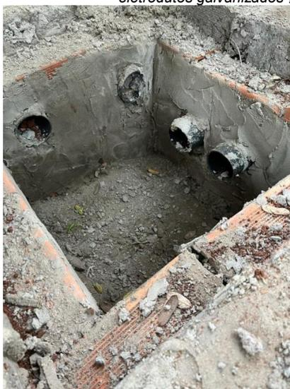
Figura 3 – Detalhe da construção da caixa de passagem.
