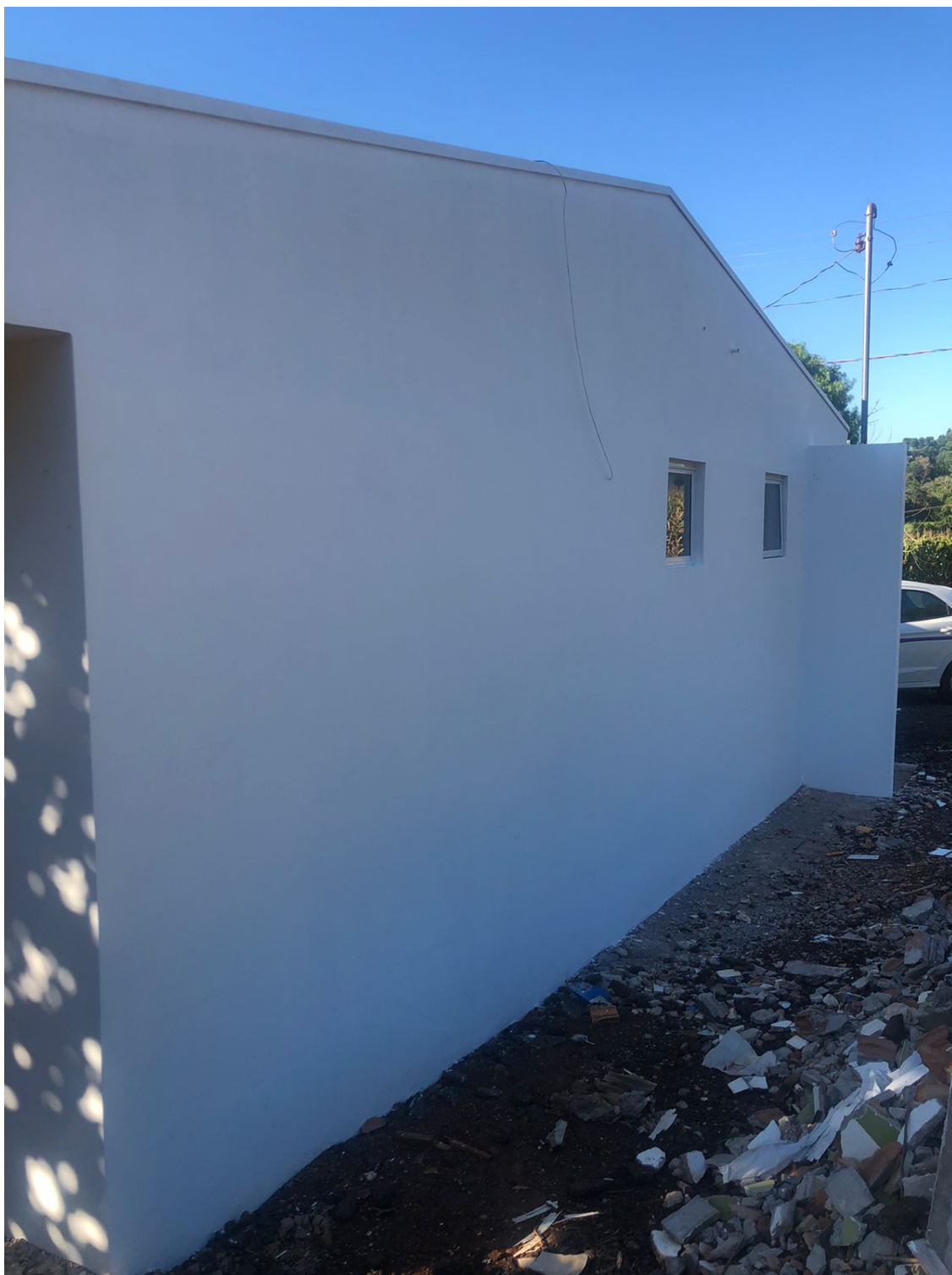
Foto 2: lateral da Unidade. Pintura externa e aberturas.
