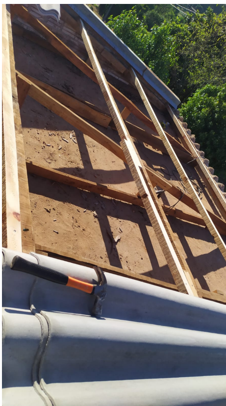
Foto 2: Remoção de cobertura e troca do telhamento.
