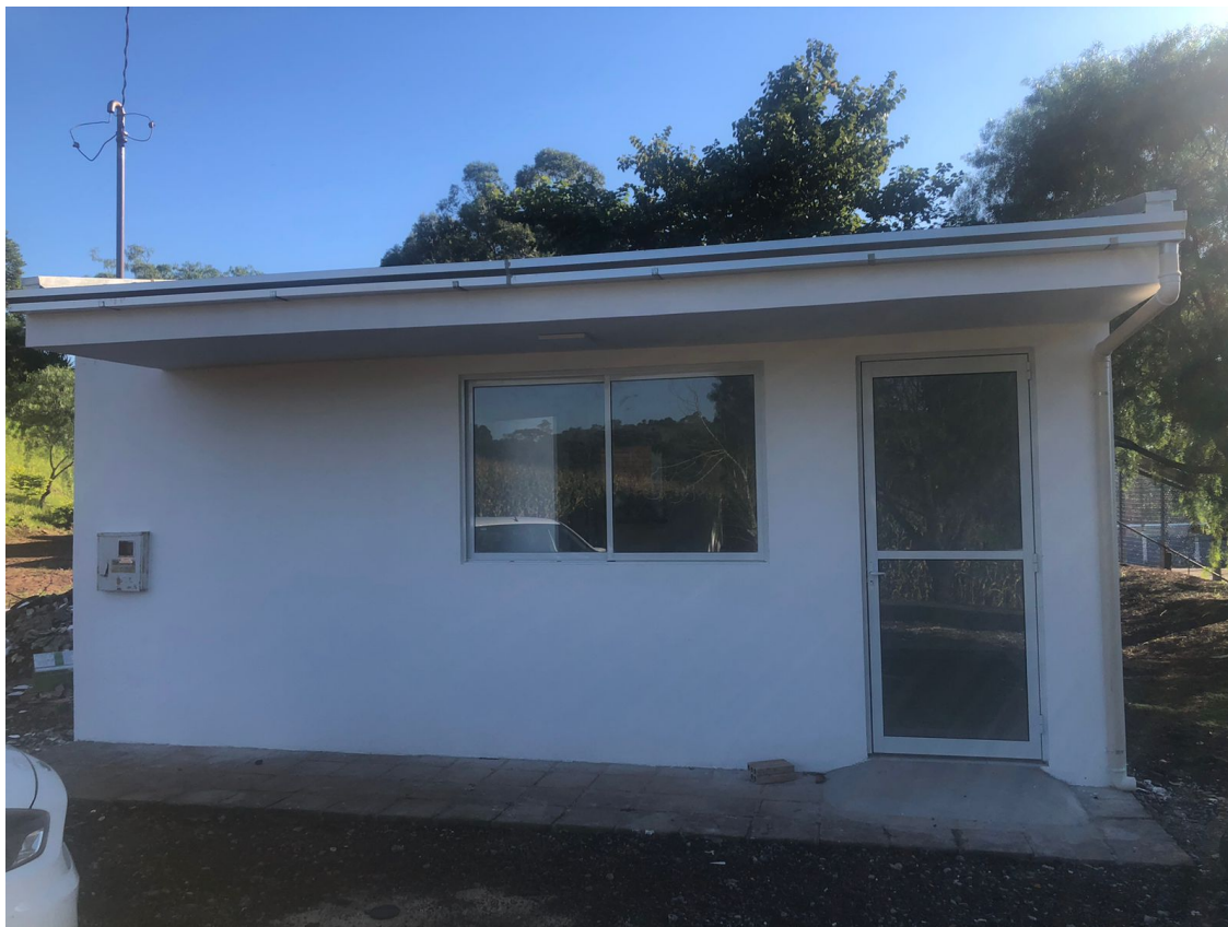
Foto 1: Frente da Unidade. Aberturas (portas e janelas) e Pintura externa.
