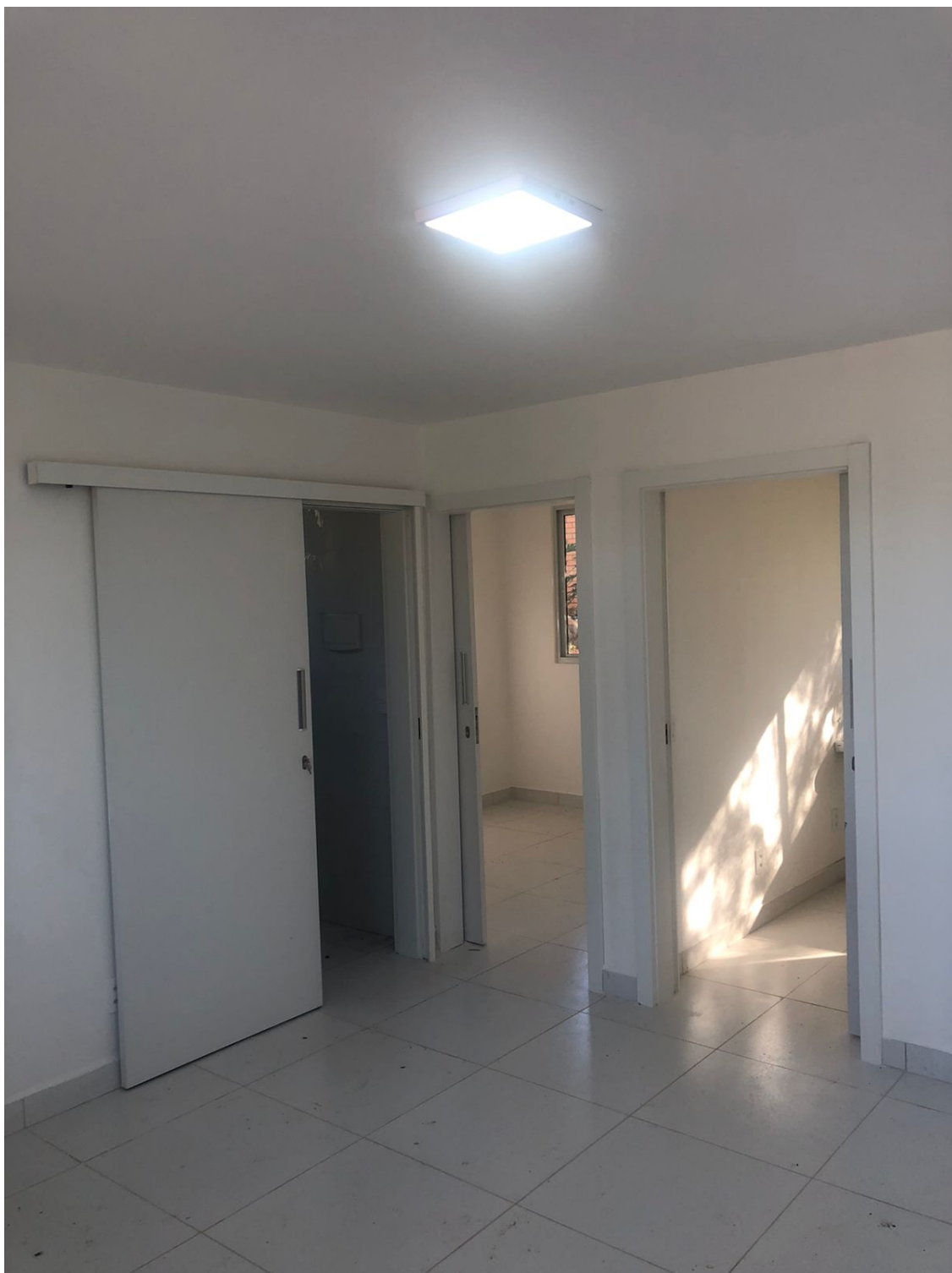
Foto 3: Área Interna. Portas de correr; Pintura; Luminárias; Piso cerâmico.
