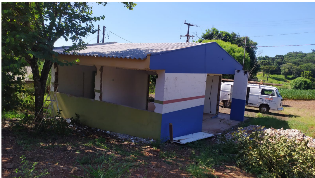
Foto 3: Remoção de Aberturas. Telhado trocado. Emassamento interno. Rufos.
