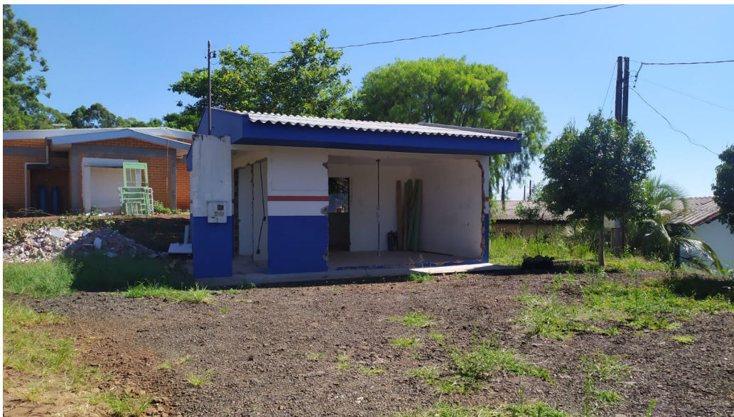
Foto 1: Remoção de Aberturas e Paredes.
