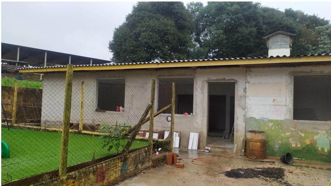
Foto 5: Revestimento externo (chapisco/emboço).
