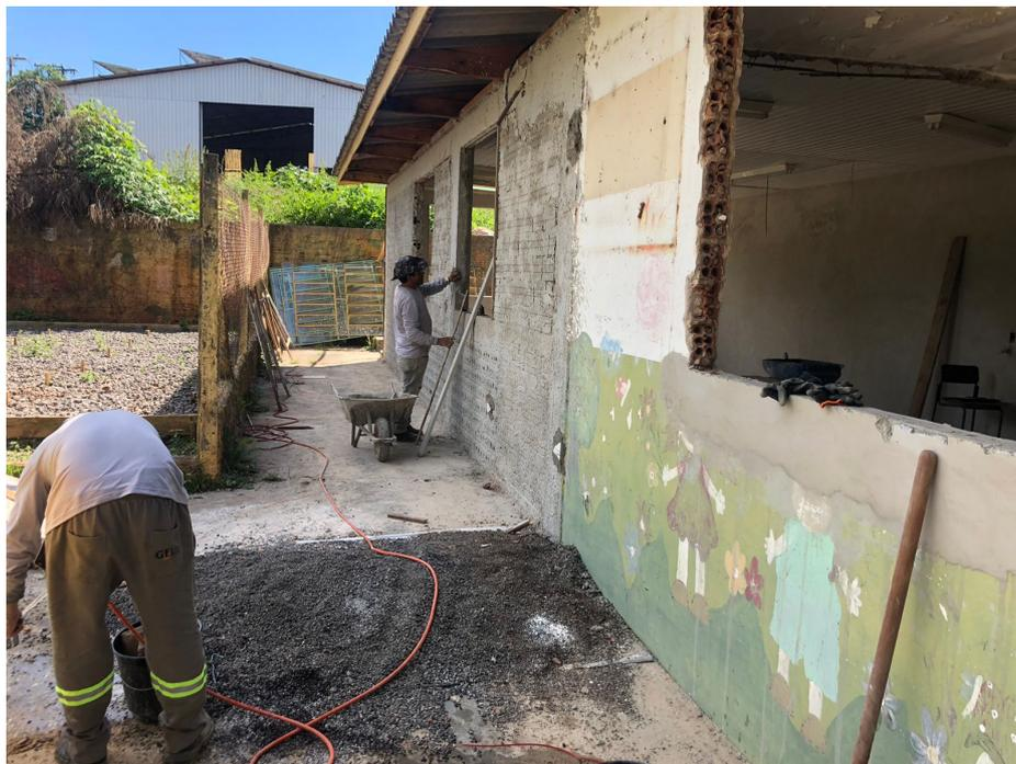
**Foto 1: Remoção de Aberturas. Revestimentos externo.**
