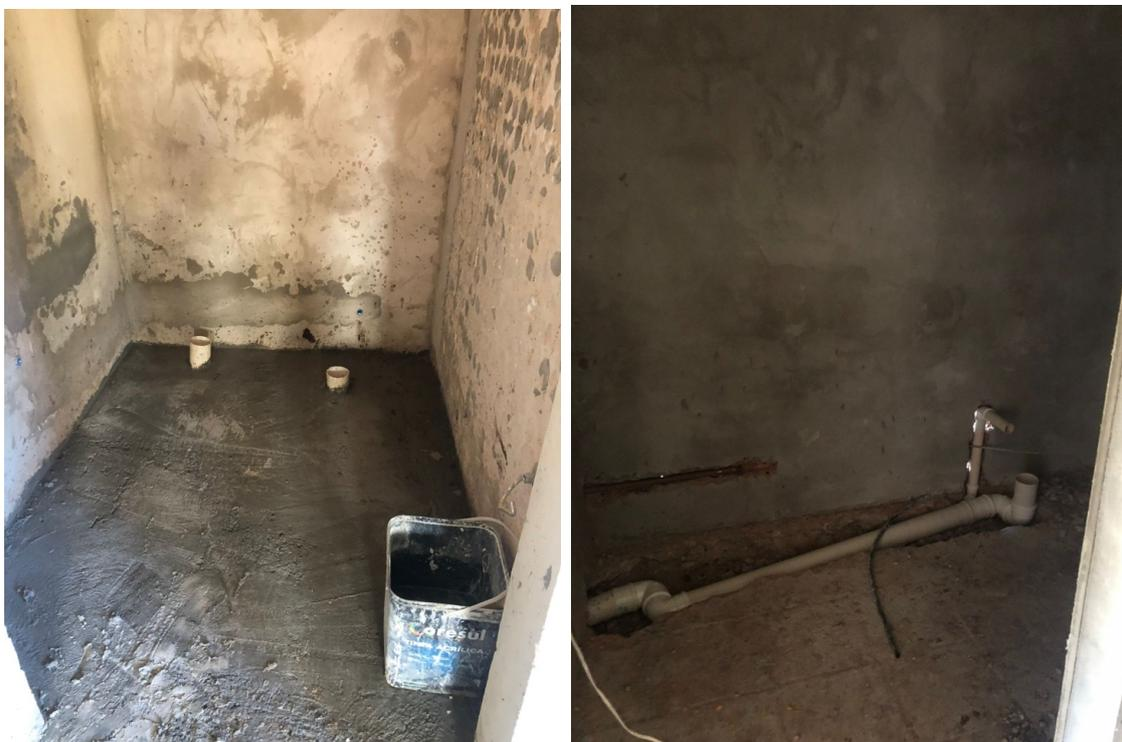
Foto 2: Pontos de esgoto.
