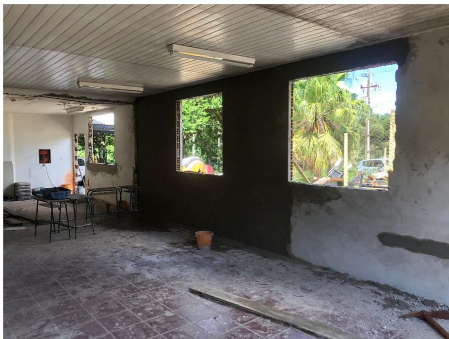
**Foto 2: Remoção de Aberturas. Revestimentos internos.**
