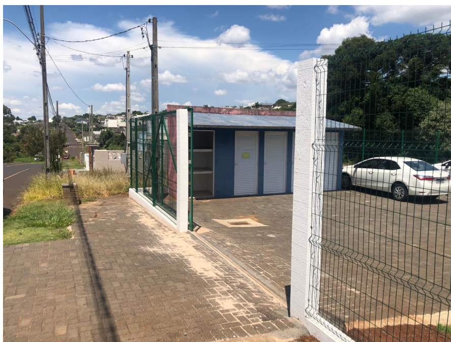
Foto 2: Cercamento e portão de acesso ao estacionamento.
