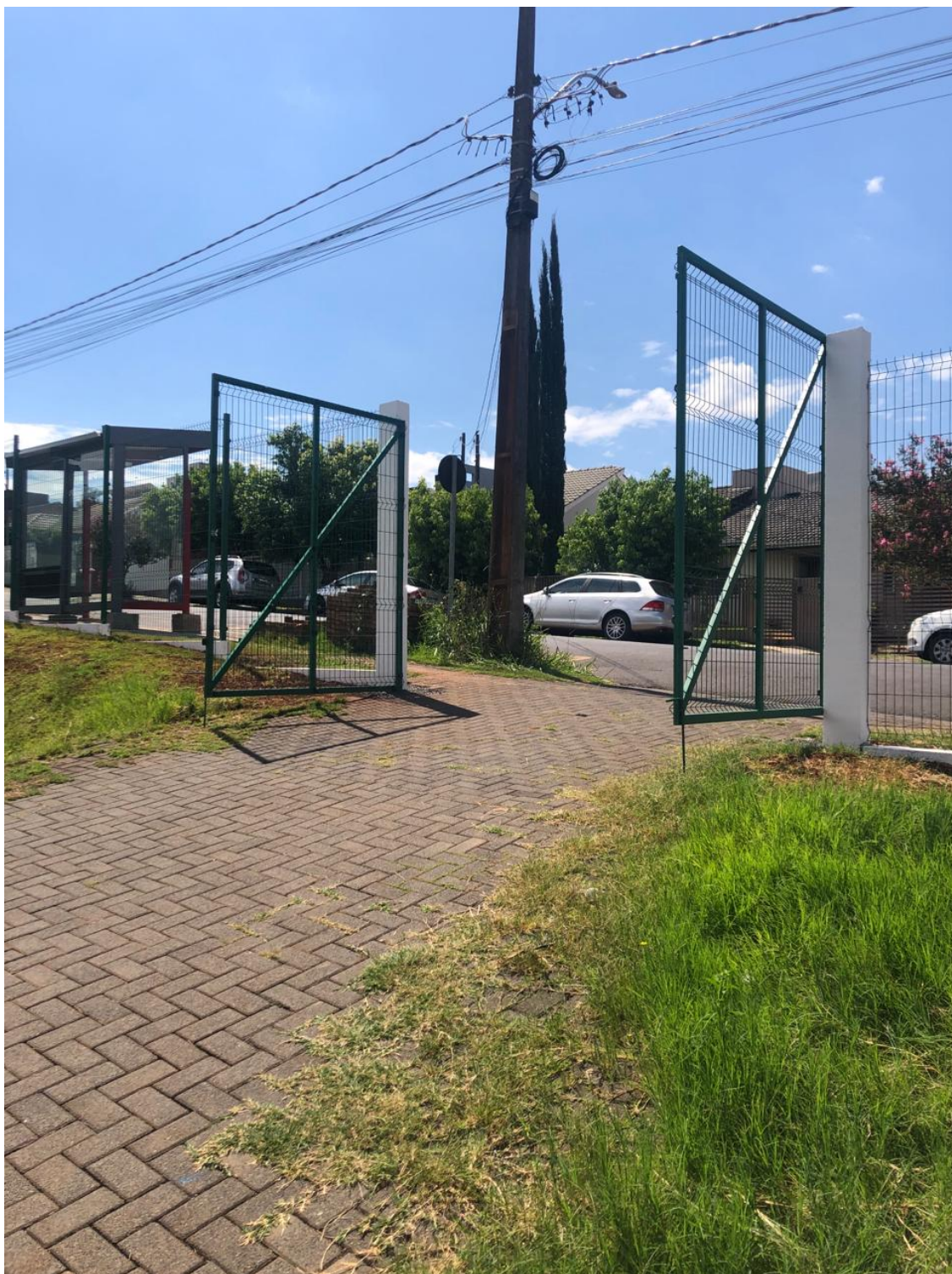
Foto 4: Portão de abrir. Acesso de veículos.
