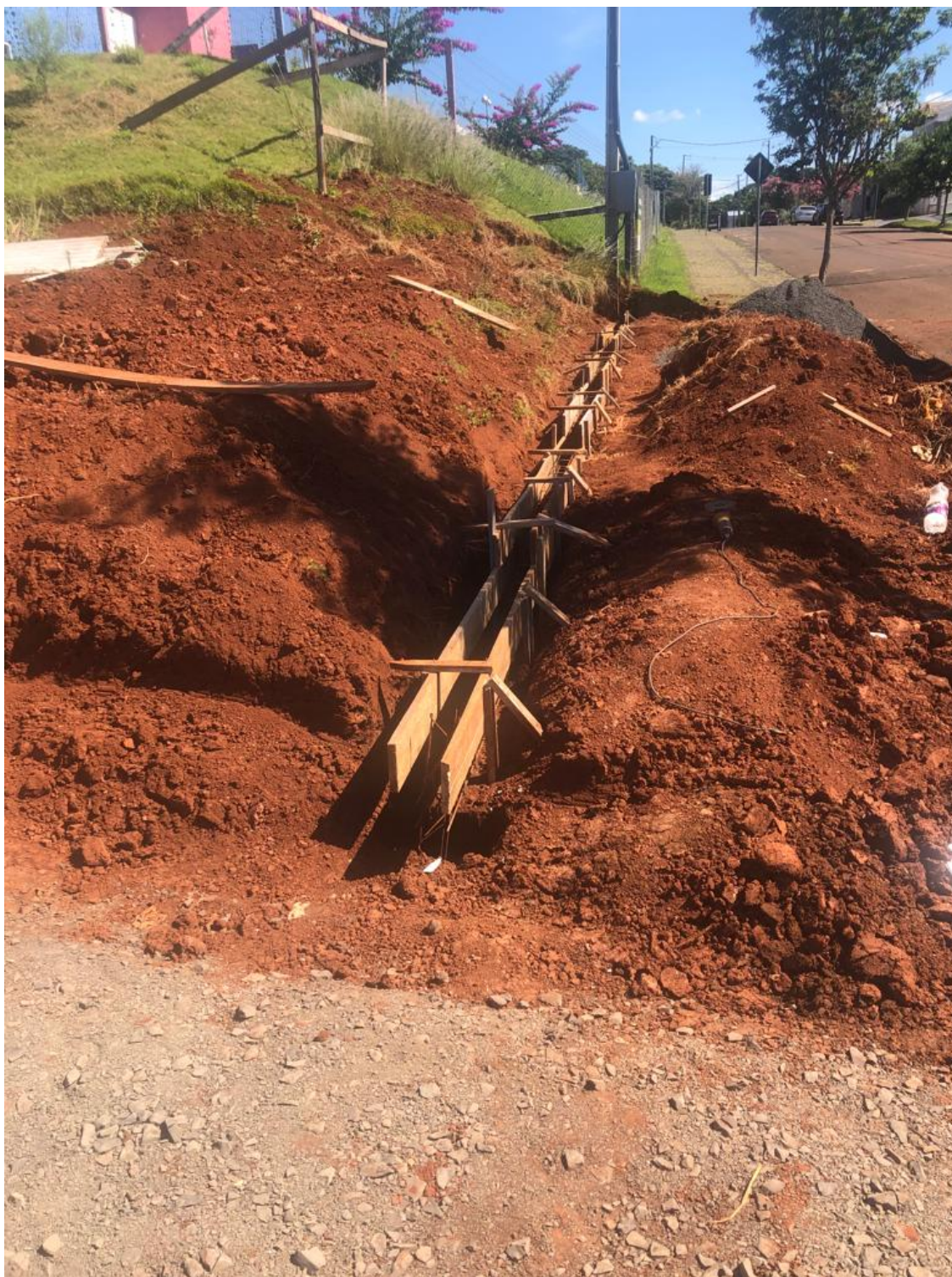
Foto 3: Escavações. Formas e ferragem.
