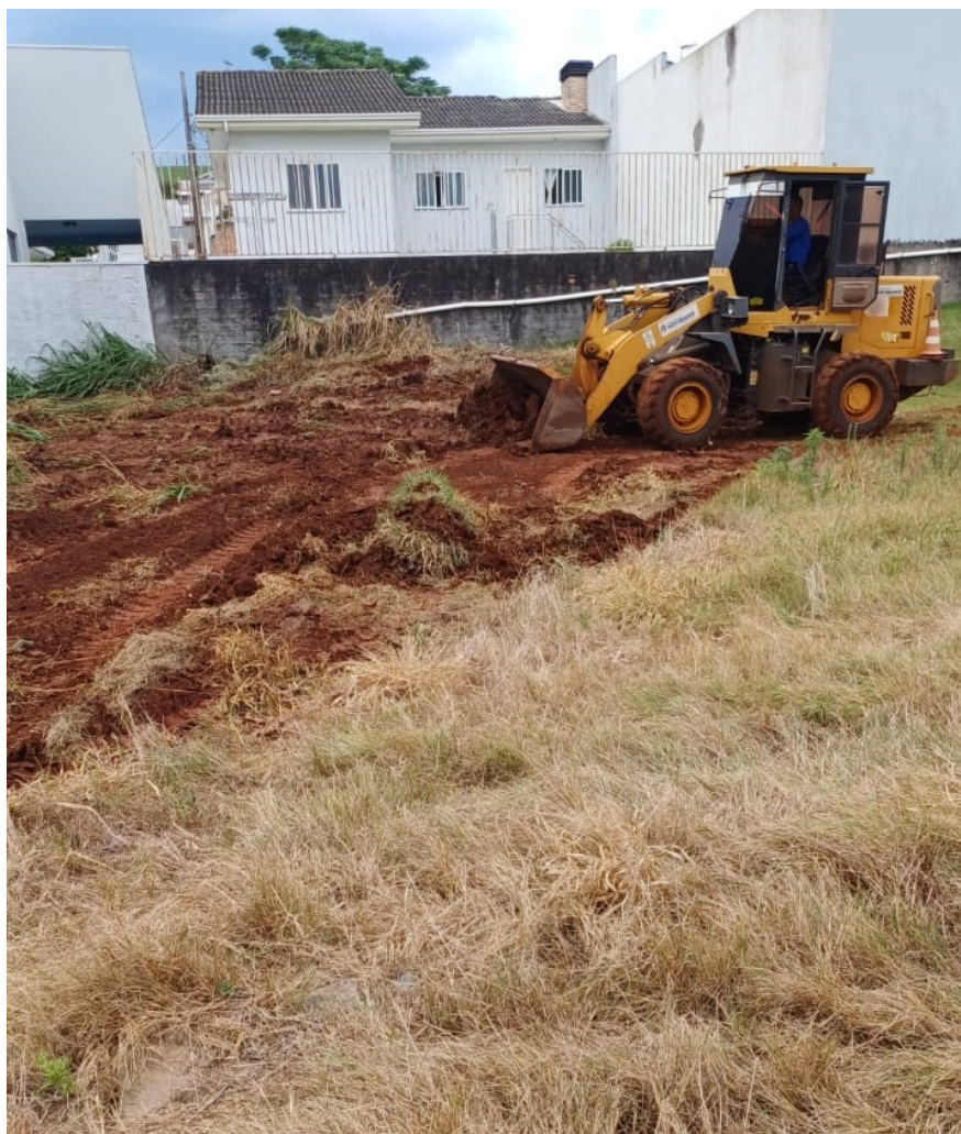
Foto 1: Limpeza mecanizada do local.
