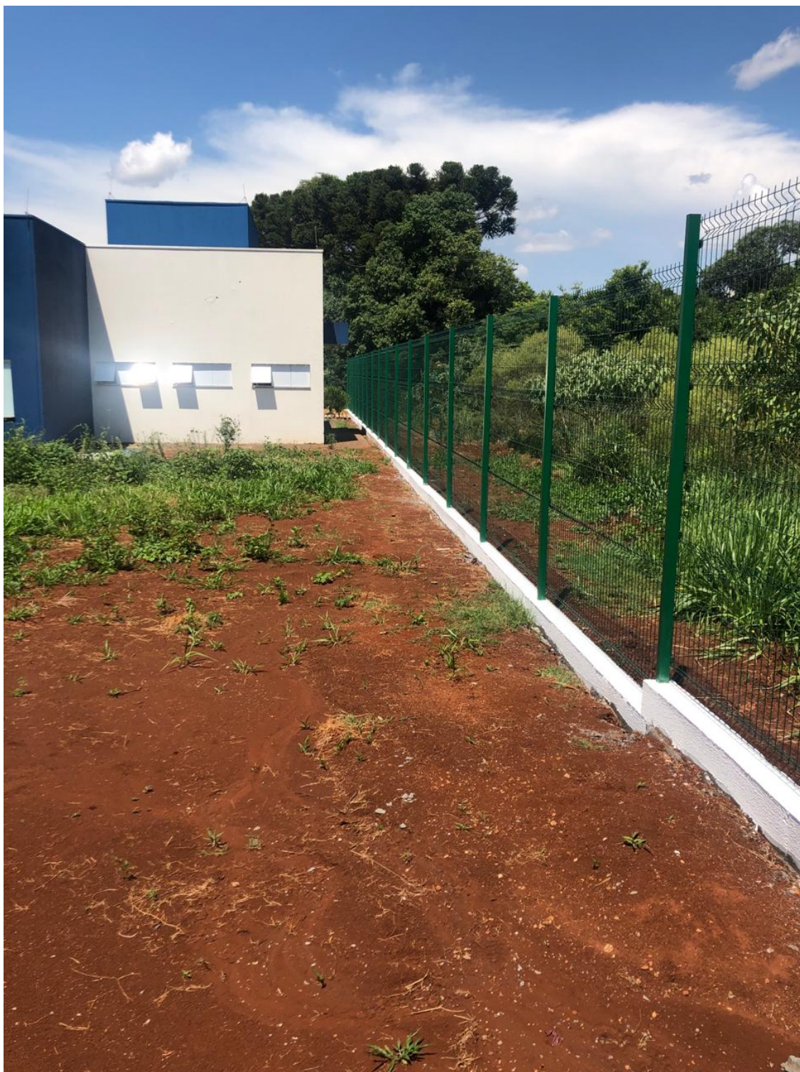
Foto 3: Cercamento fundos da unidade.
