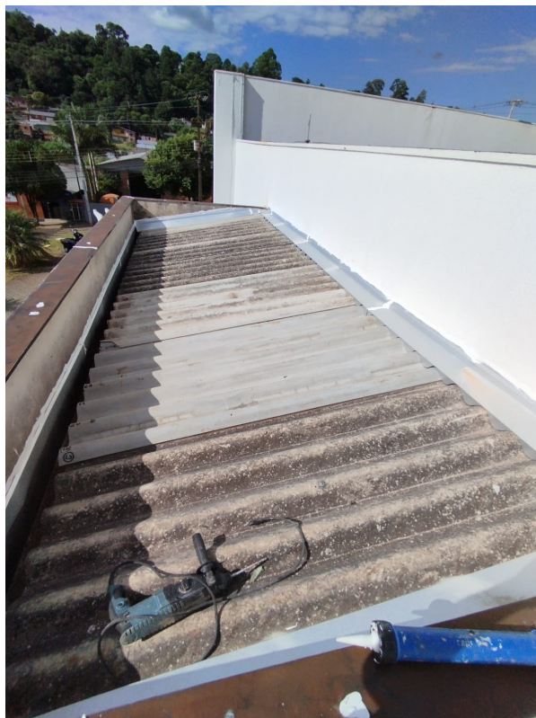
Foto 2: Troca de telhamento em fibrocimento.
