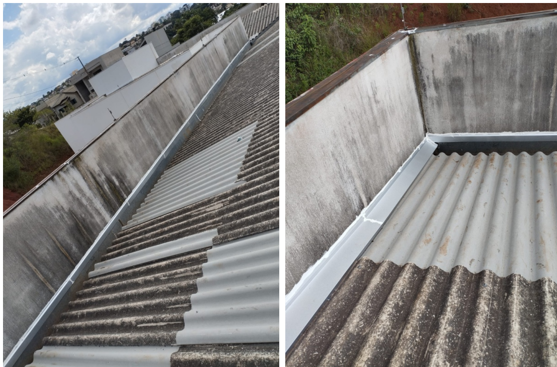
Foto 4: Troca de telhas em fibrocimento e reparo em rufos e calhas.
