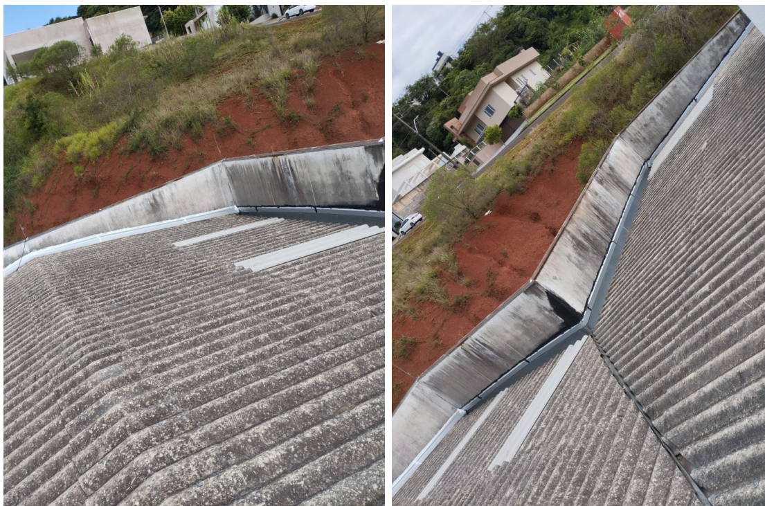
Foto 3: Troca de telhas em fibrocimento e reparo em rufos e calhas.
