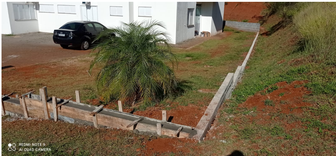
Foto 4: Concretagem das vigas..
