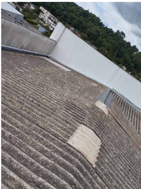
Foto 1: Troca de Cumeeira.
