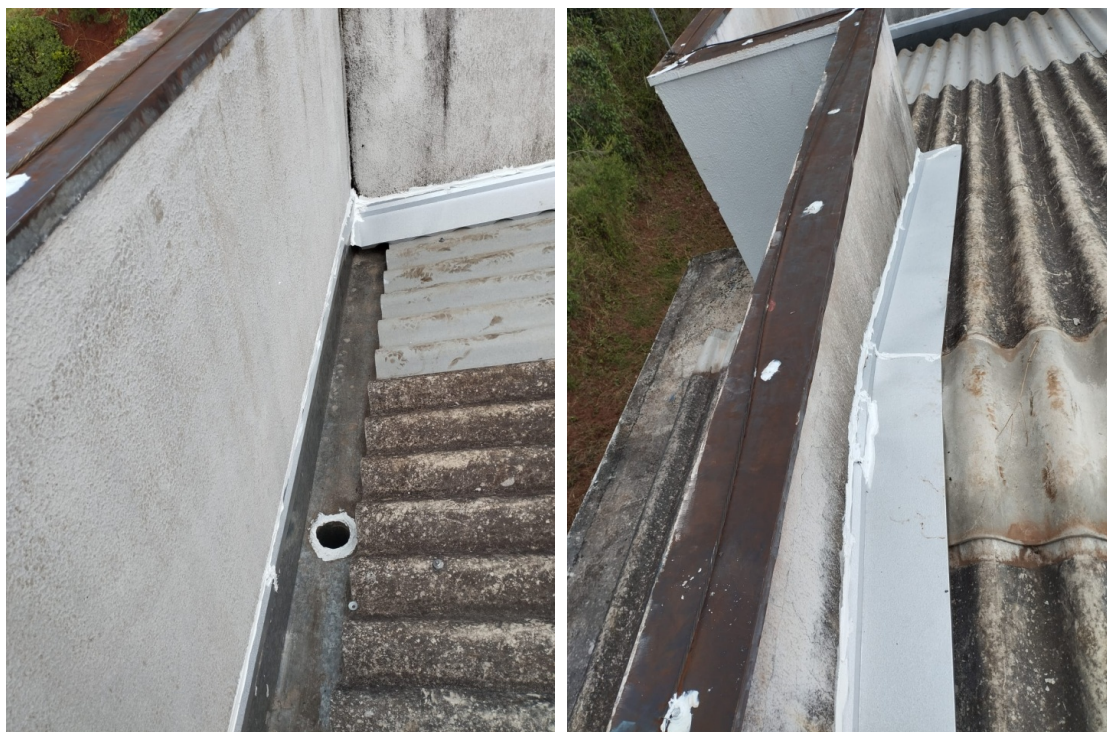
Foto 5: Reparo em rufos e calhas.
