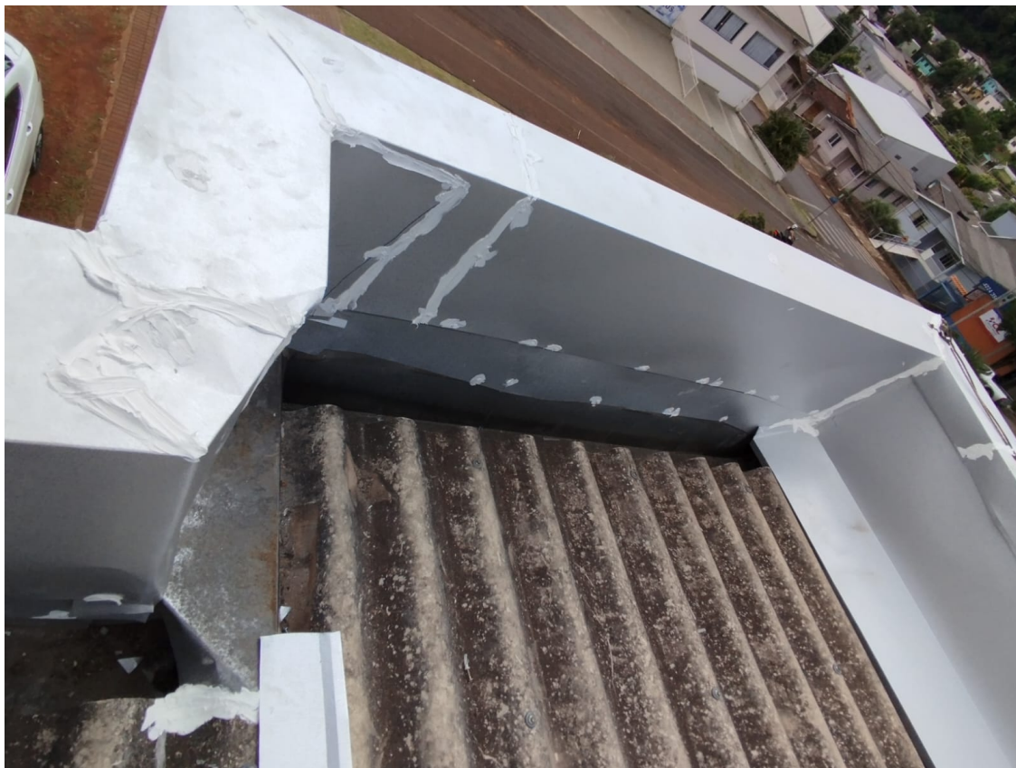
Foto 6: Reparo em rufos e calhas.
