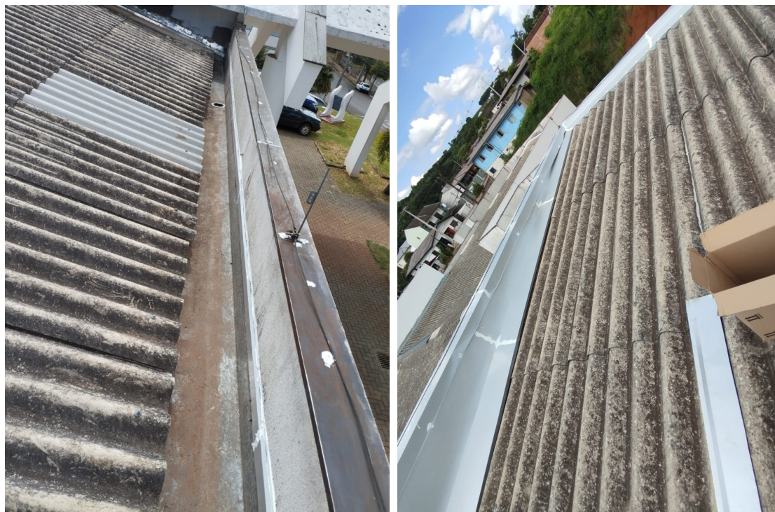
Foto 7: Reparo em rufos e calhas.
