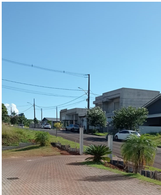
Foto 2: Pilares e vigas baldrame da Lateral da unidade, Rua Maurício Batista Menosso.
