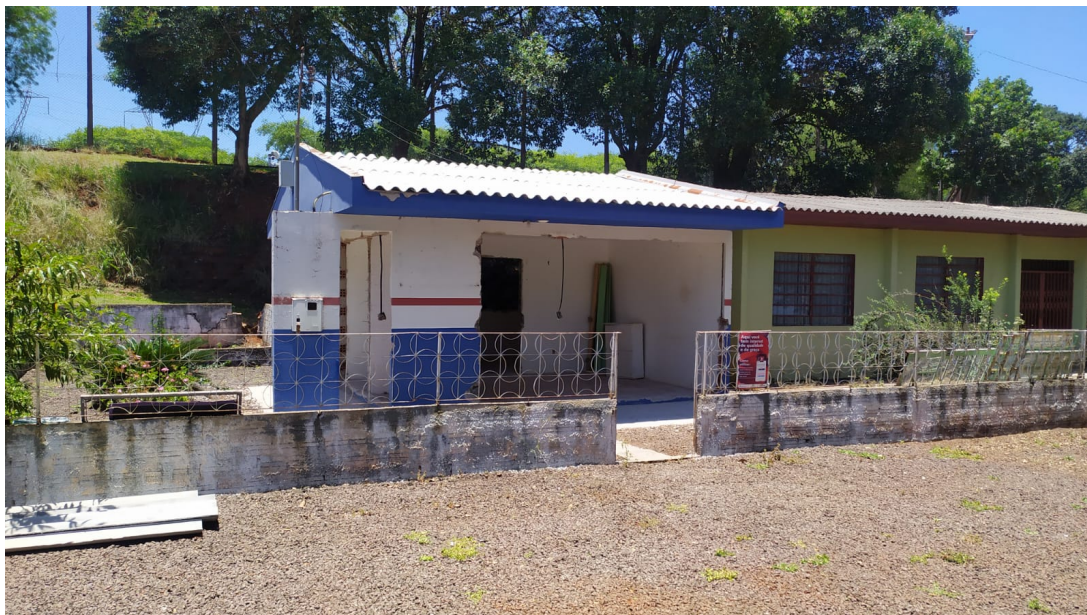
Foto 3: Remoção de Aberturas e Paredes. Trocas do telhamento. Piso em concreto.
