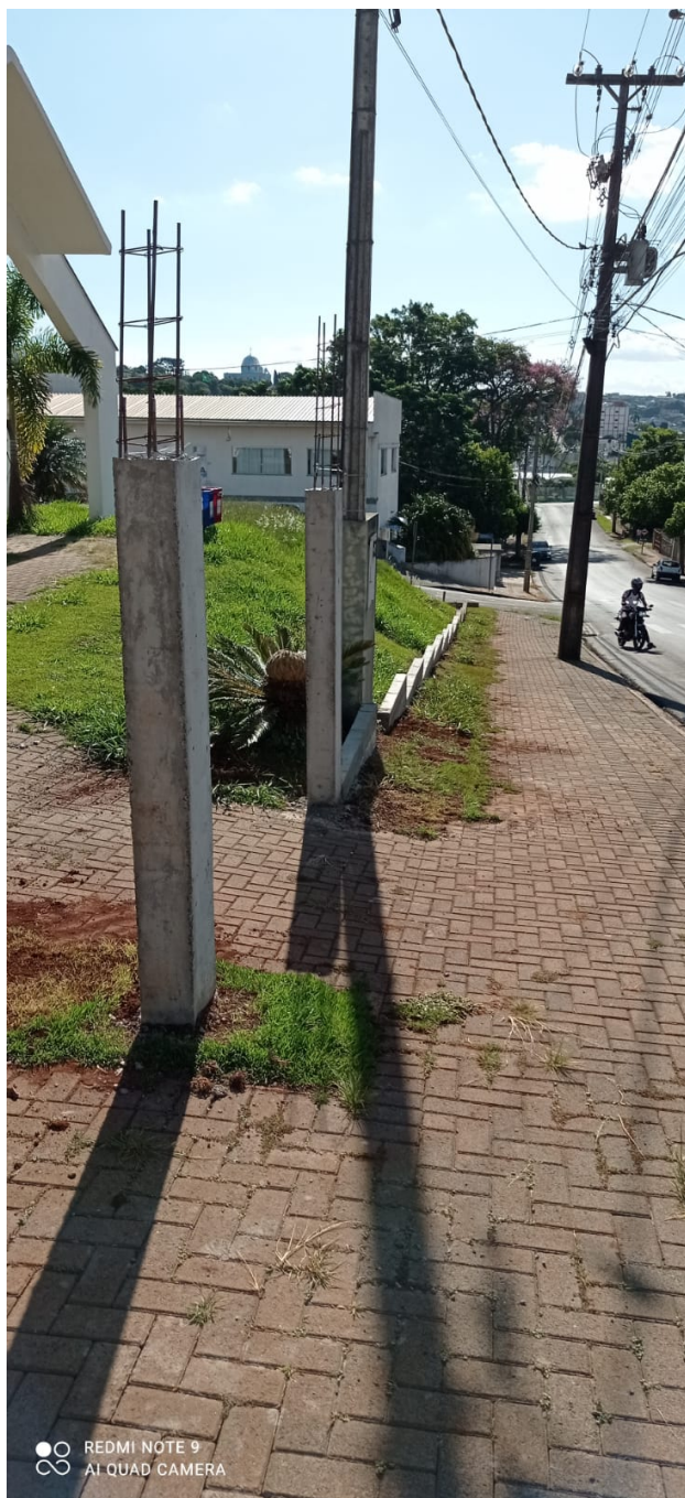
Foto 1: Pilares e vigas baldrame de frente da unidade, Rua Industrial.
