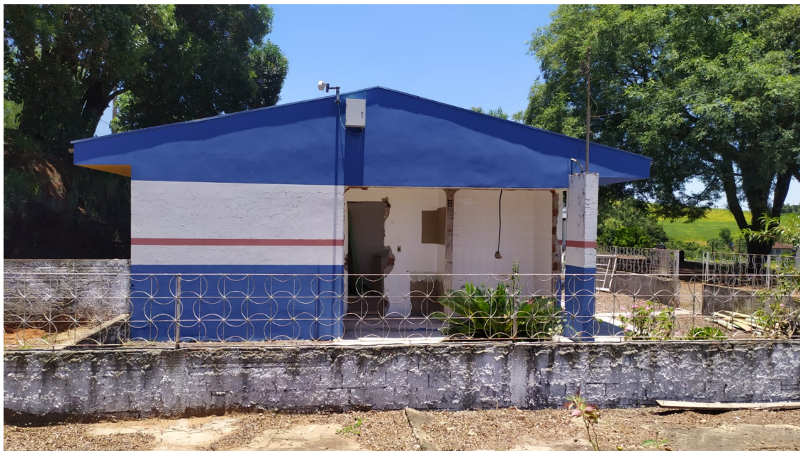
Foto 1: Remoção de Aberturas e Paredes.
