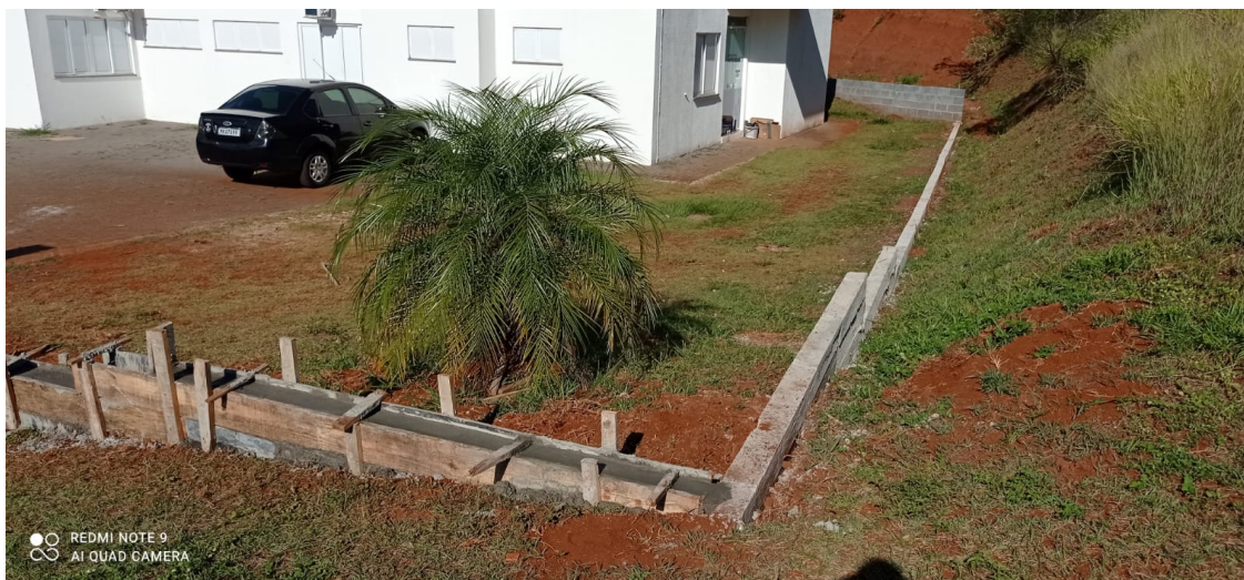
Foto 4: Concretagem das vigas..
