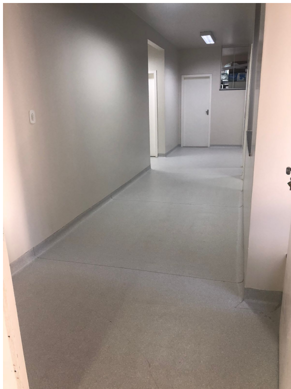
Foto 3: Manta Vinílica instalada
