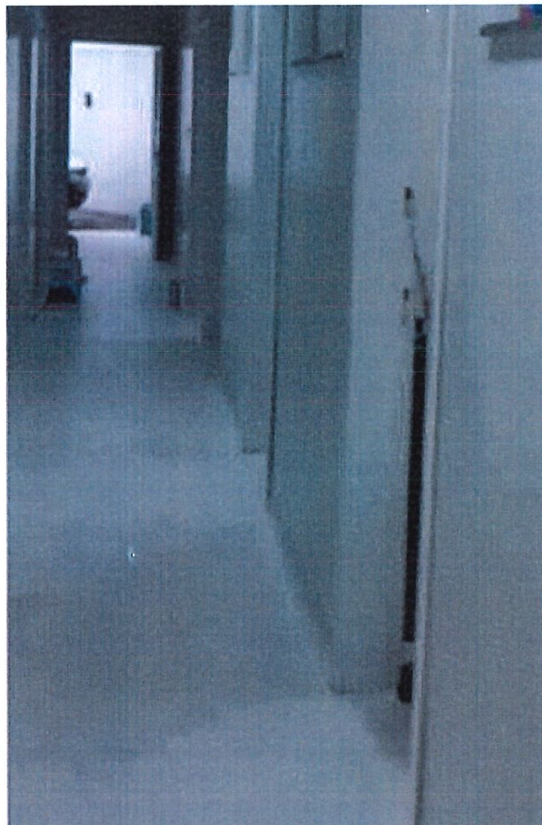
Foto 3: Manta vinílica instalada
