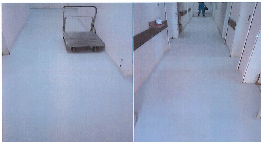
Foto 5: Manta vinílica instalada
