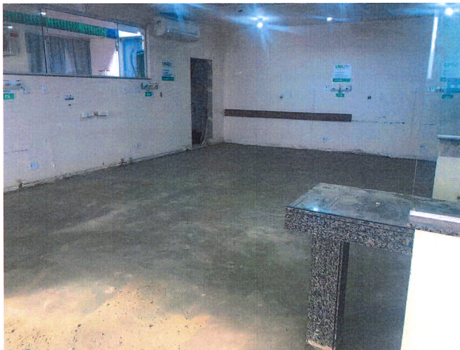
Foto 4: Regularização de Contrapiso com argamassa
