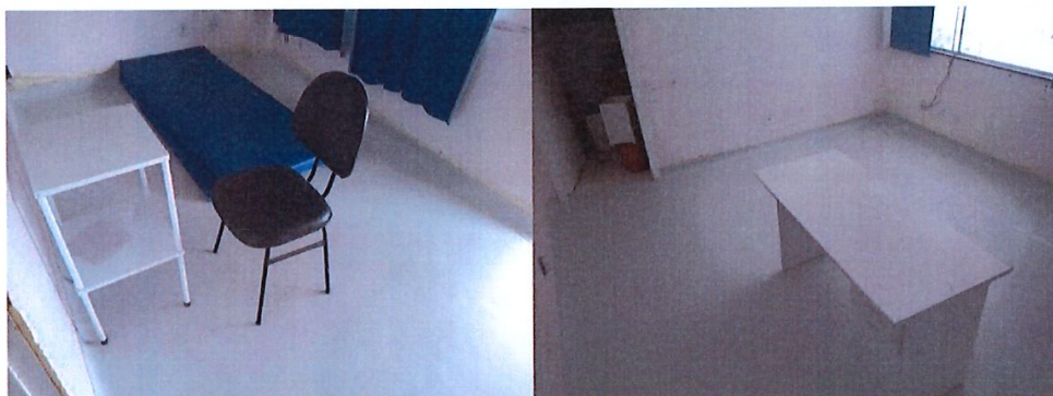
Foto 2: Manta vinílica instalada
