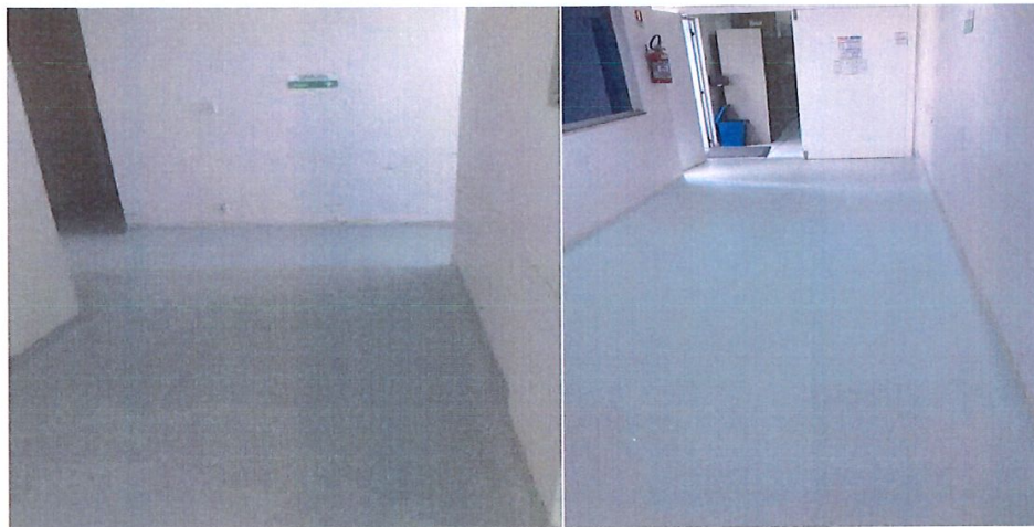
Foto 1: Manta vinílica instalada
