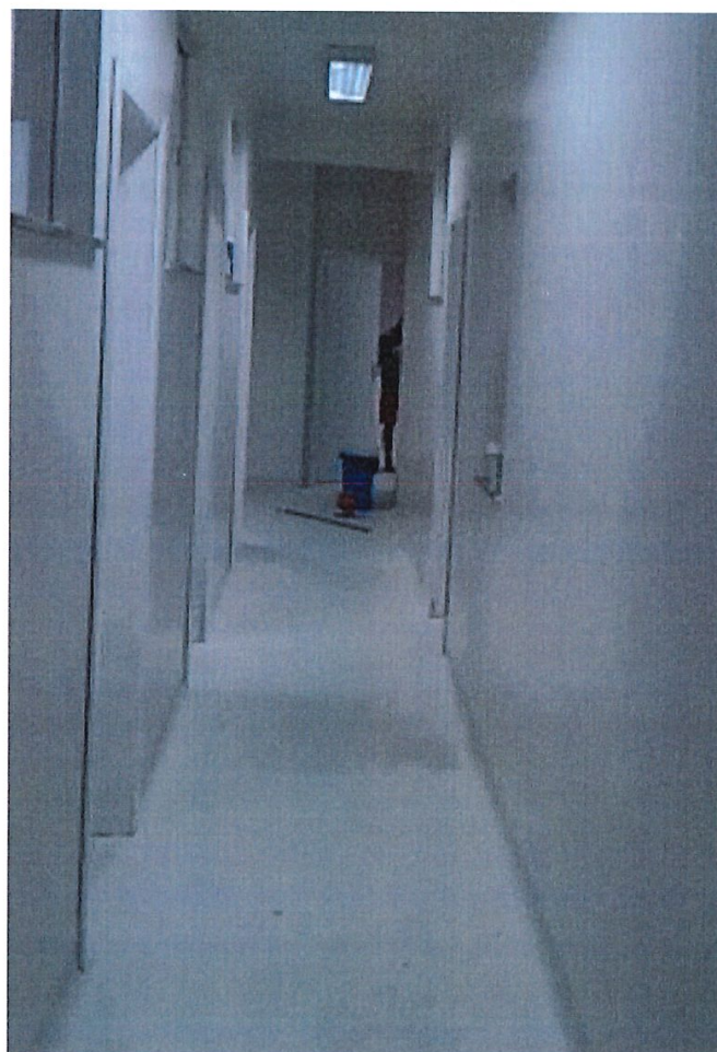
Foto 2: Manta vinílica instalada
