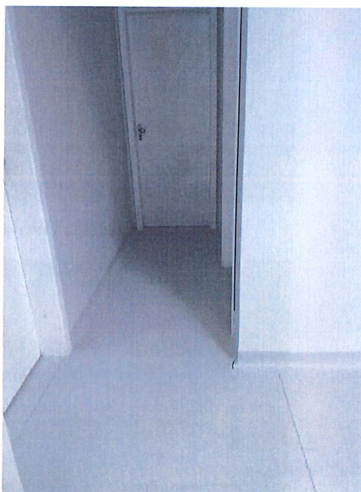
Foto 6: Manta vinílica instalada
