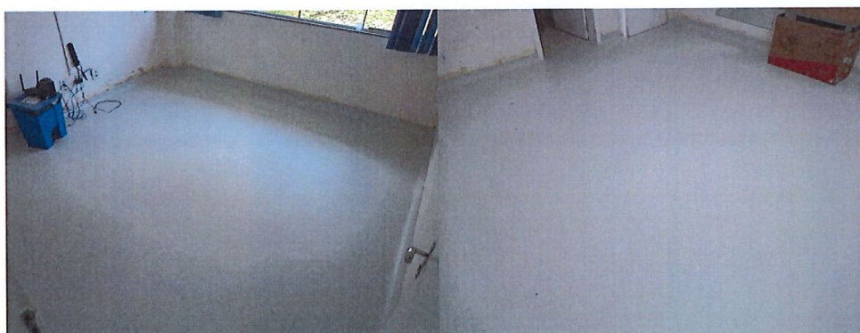
Foto 3: Manta vinílica instalada
