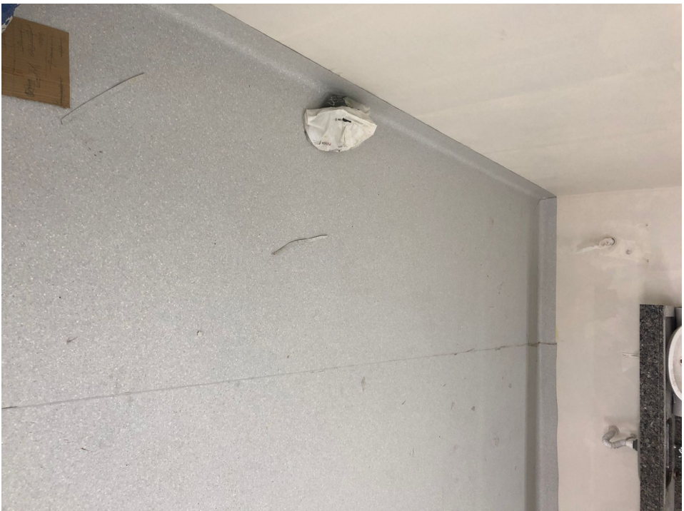
Foto 2: Manta vinílica instalada
