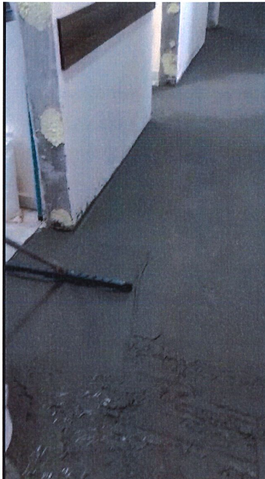
Foto 4: Contrapiso com argamassa
