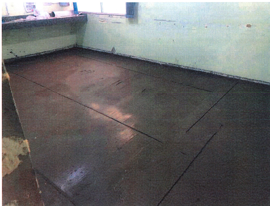
Foto 3: Regularização de Contrapiso com argamassa
