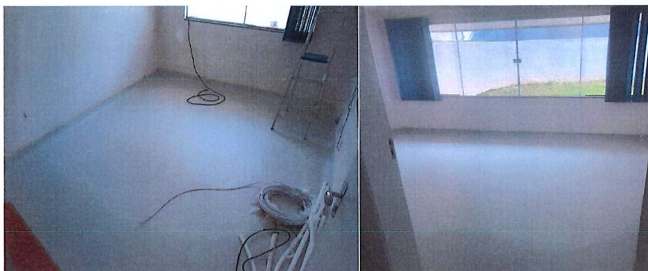
Foto 4: Manta vinílica instalada
