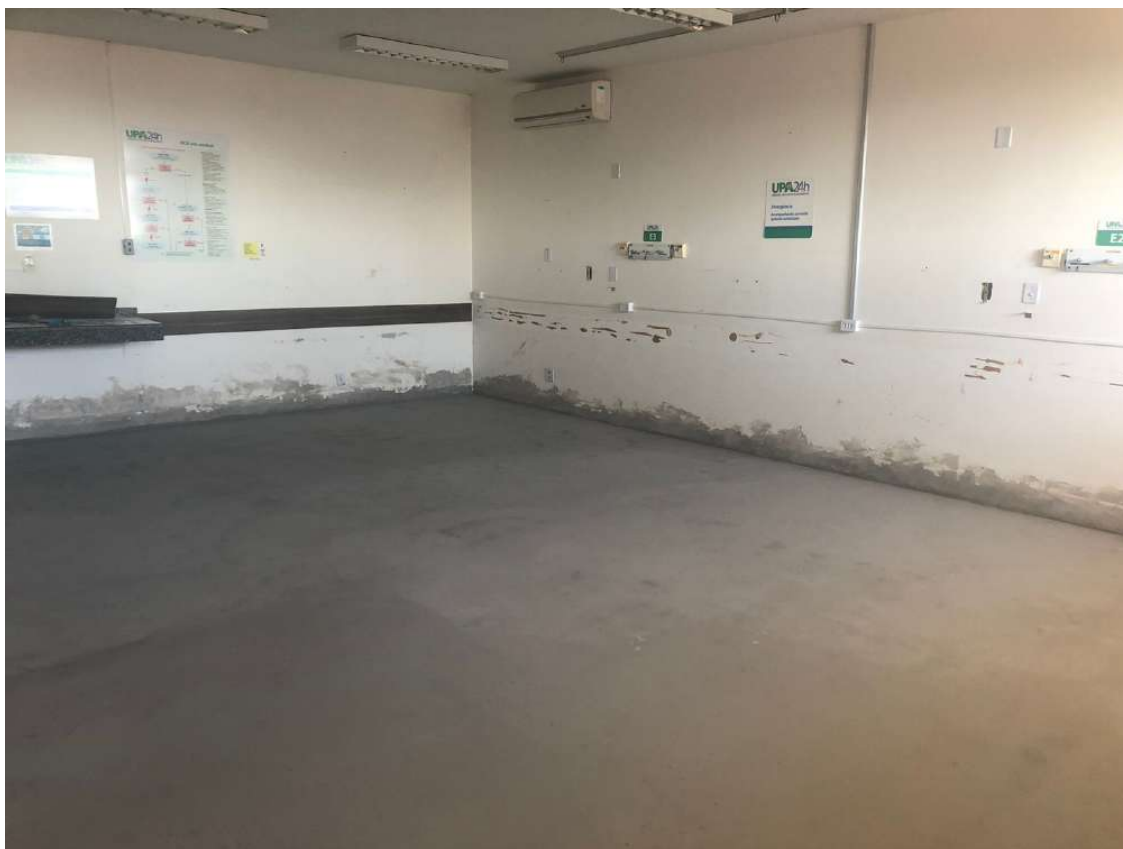
Foto 1: Retirada do piso existente e regularização do contrapiso
