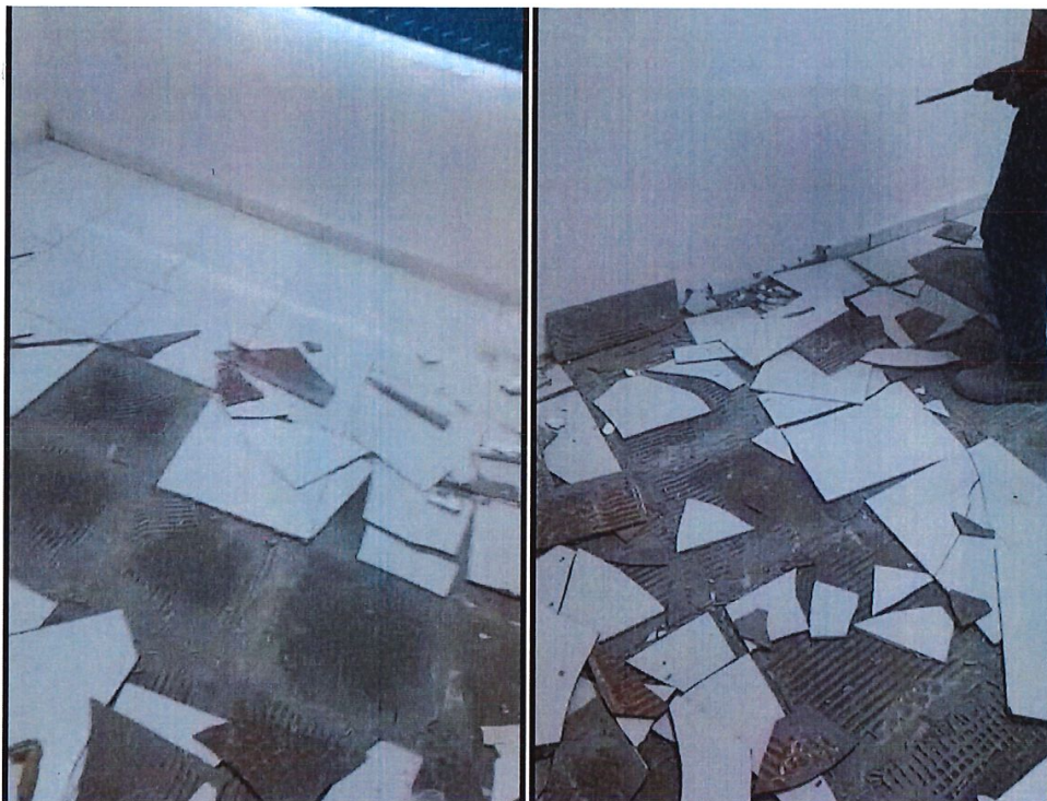
Foto 1: Demolição de Revestimento Cerâmico
