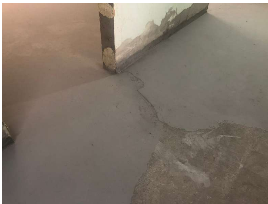
Foto 2: Regularização do piso e remoção das portas
