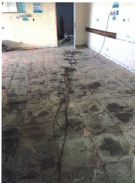
Foto 2: Remoção de Revestimento Cerâmico
