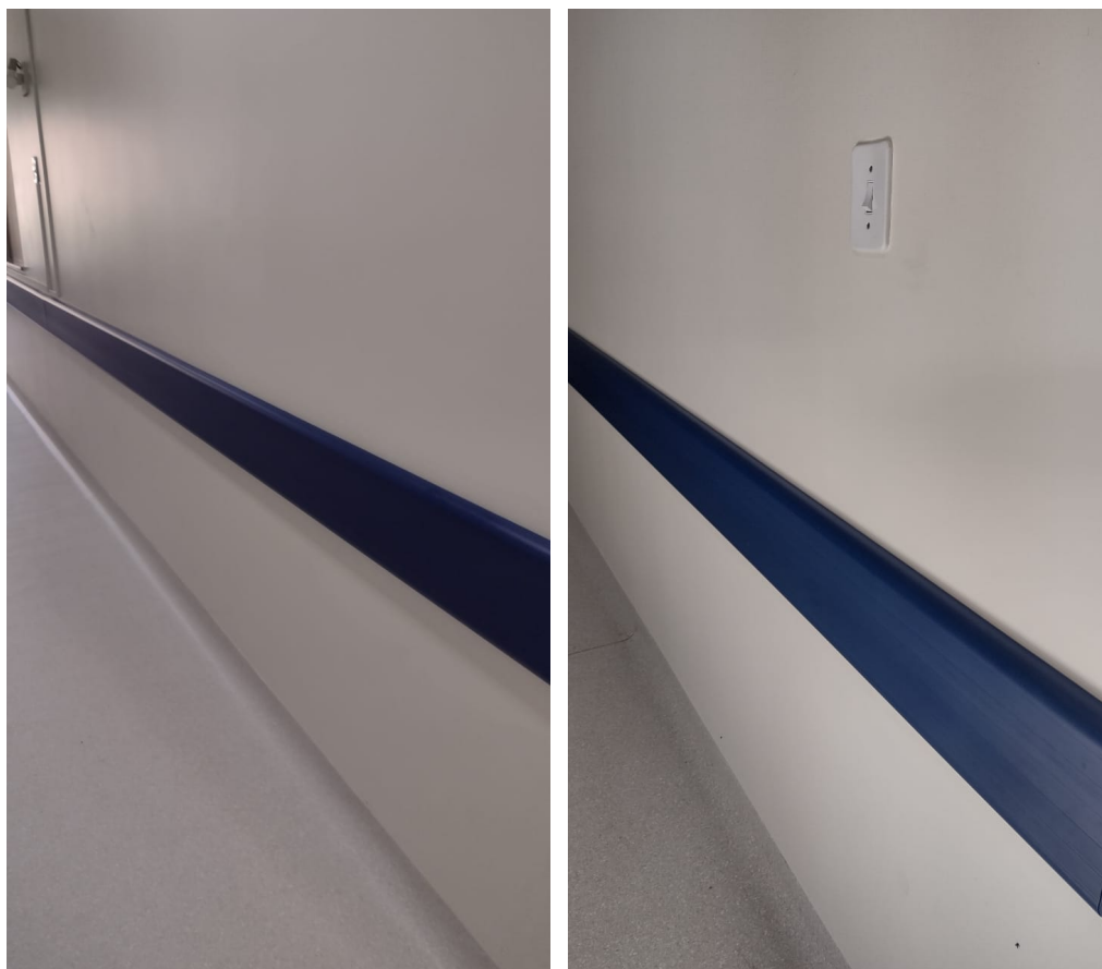
Foto 3: Bata maca instalado
