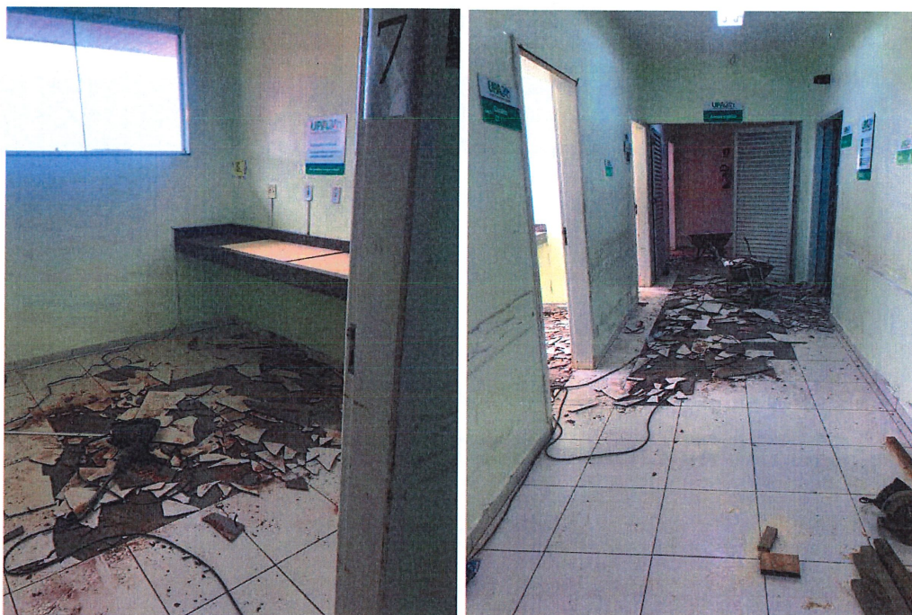
Foto 1: Demolição de Revestimento Cerâmico
