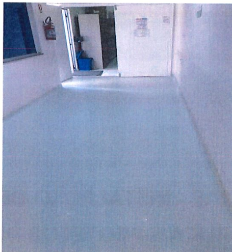
Foto 1: Manta vinílica instalada
