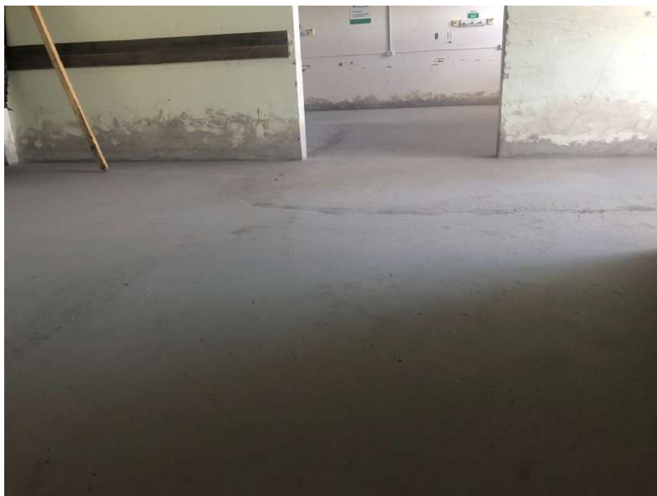
Foto 3: Regularização do piso e remoção das portas
