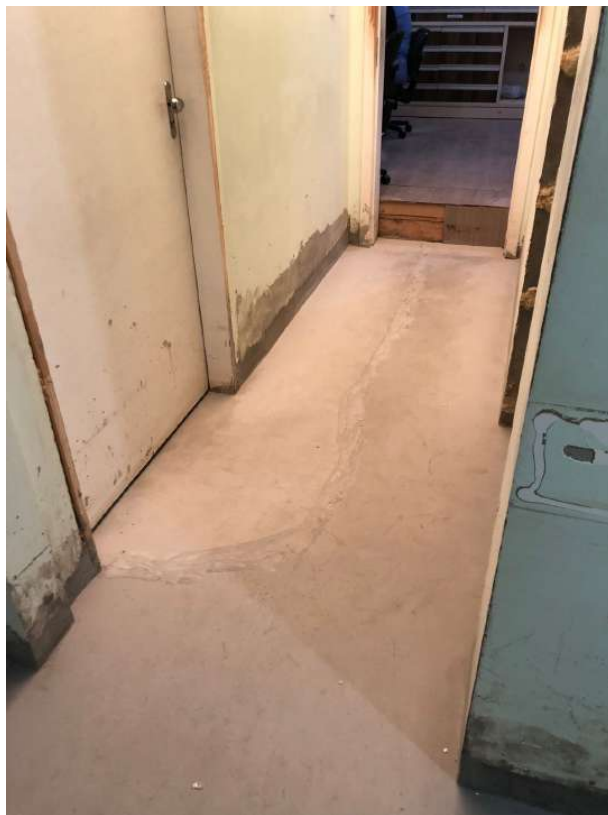
Foto 3: Regularização do piso e remoção das portas
