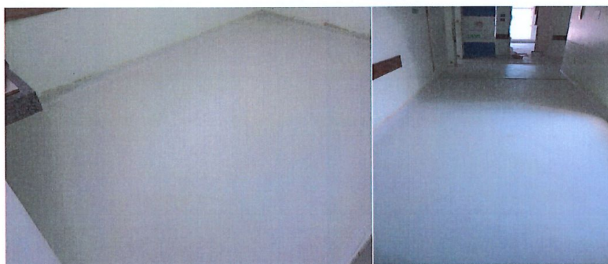
Foto 6: Manta vinílica instalada
