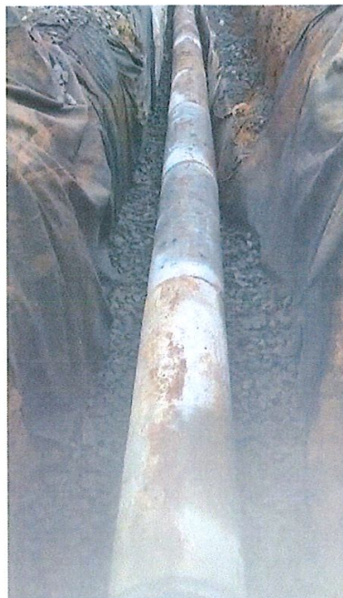
Foto 5: Trincheiras drenantes durante o processo de construção
