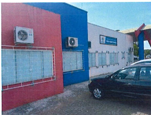
Foto 7: grades nas janelas
