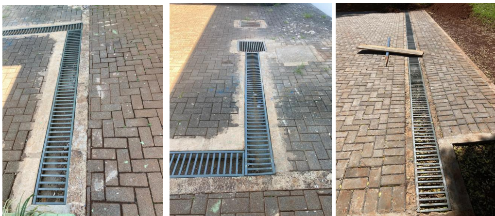
Foto 1: Canaleta de drenagem com grelha
