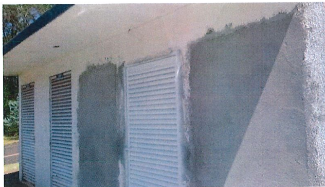
Foto 9: Porta na central de resíduos
