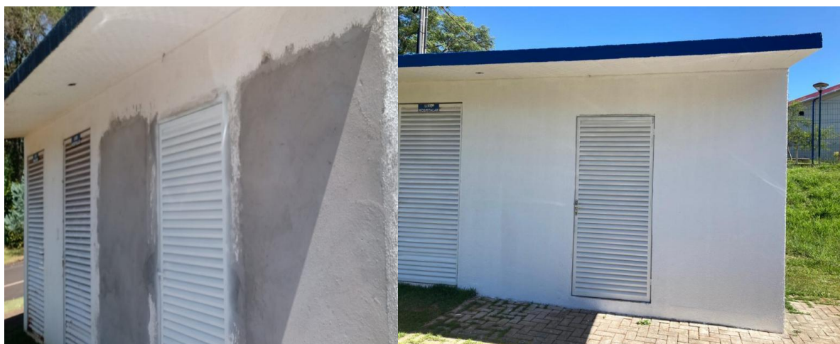
Foto 6: Fechamento das aberturas em alvenaria na central de resíduos
