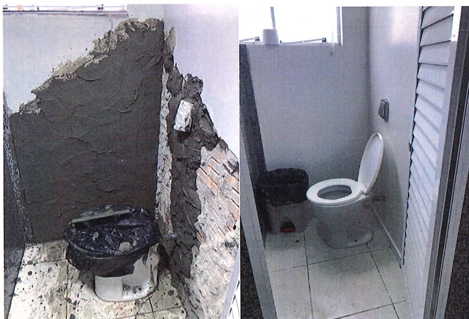
Foto 4: Conserto do encanamento vaso sanitário do banheiro
