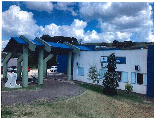
Foto 1: Pintura externa da unidade
