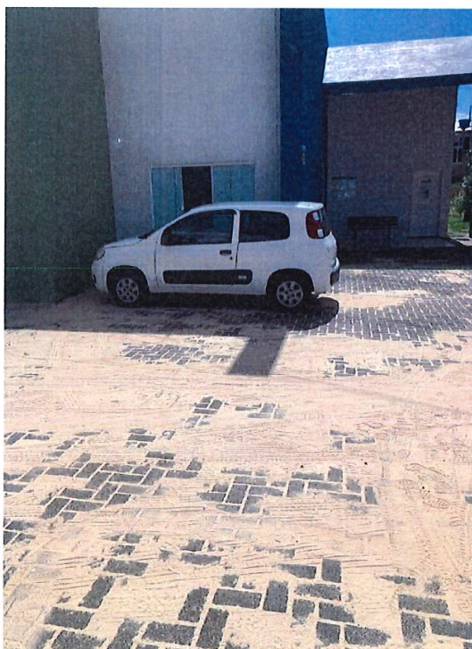
Foto 8: Nivelamento do estacionamento existente
