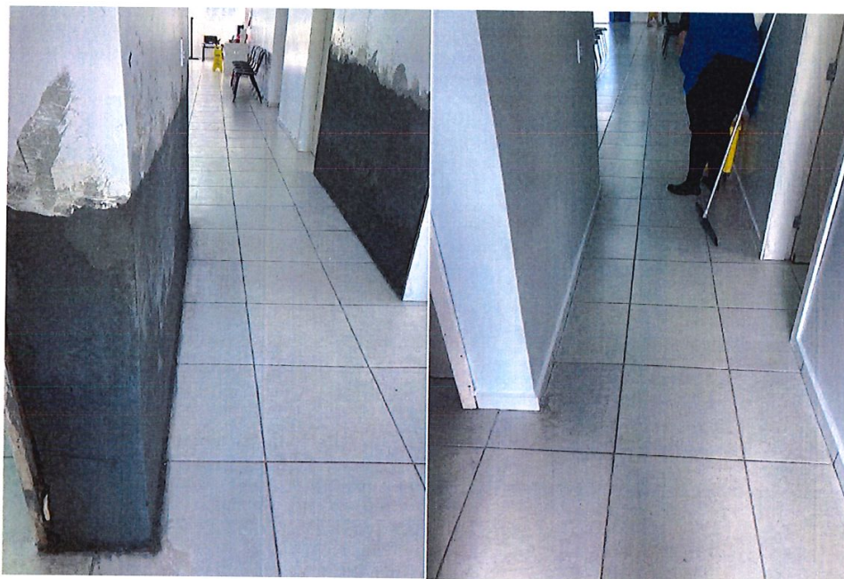
Foto 5: Conserto do revestimento das paredes danificada pela infiltração
