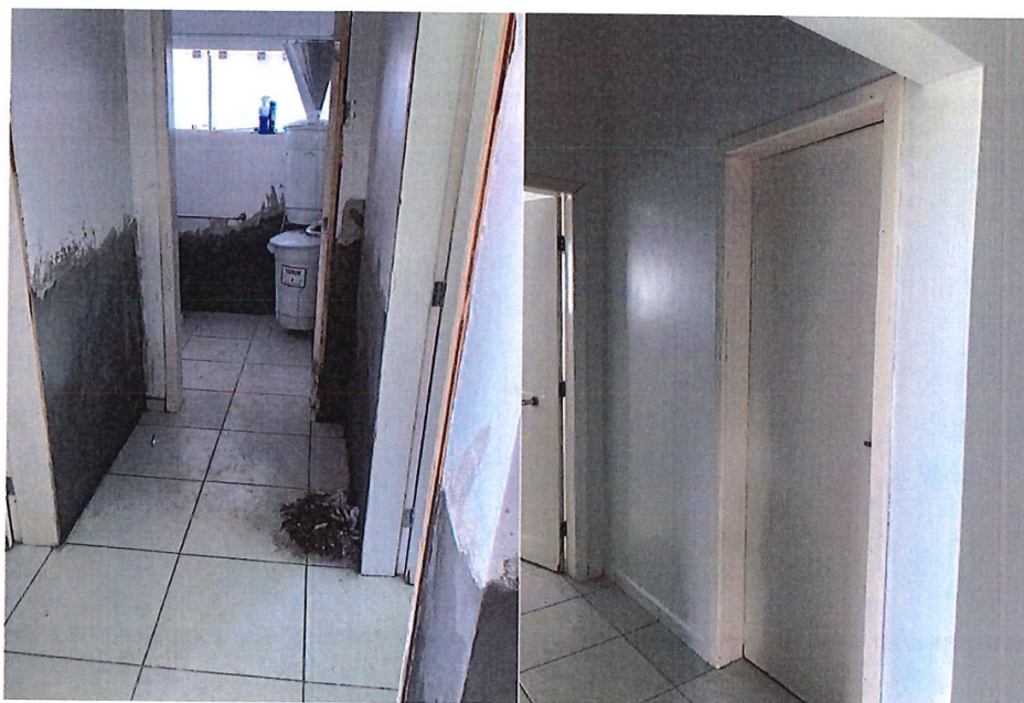
Foto 6: Conserto do revestimento das paredes danificada pela infiltração na área dos vestiários e dos banheiros
