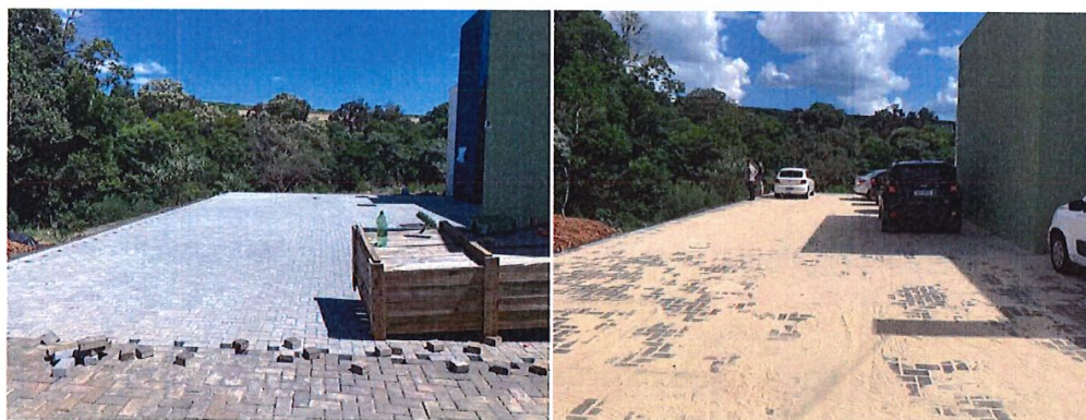
Foto 2: Ampliação do estacionamento na lateral da unidade
