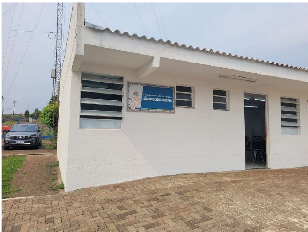
Foto 4: Pintura externa e pavimentação com blocos intertravados.
