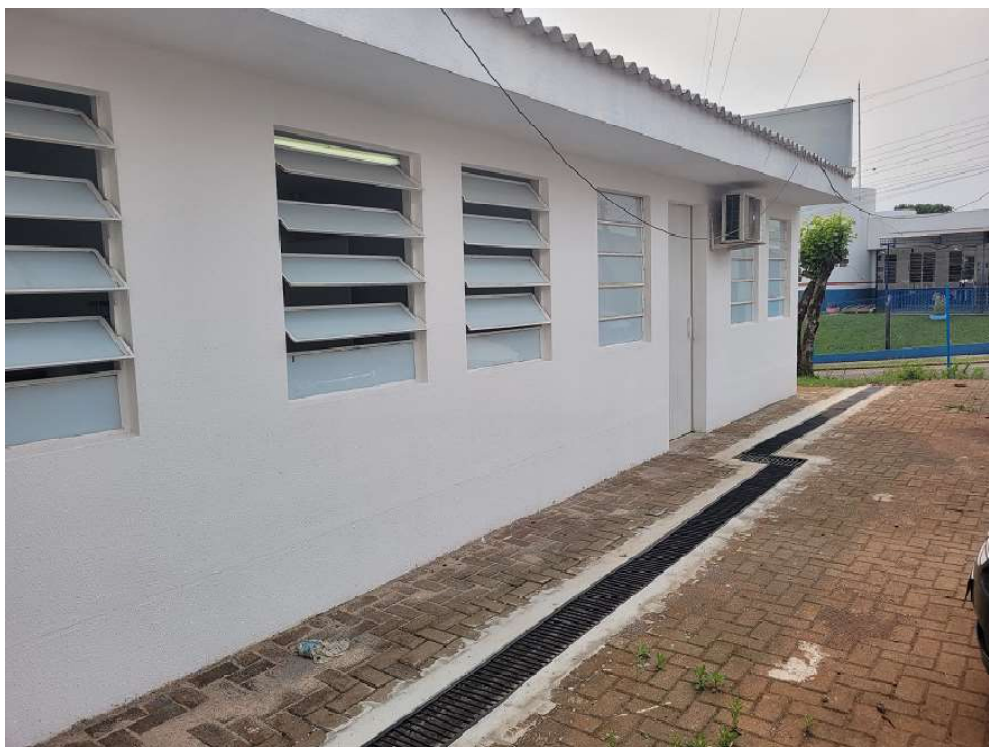
Foto 2: Pintura externa. Canaleta de Drenagem.
