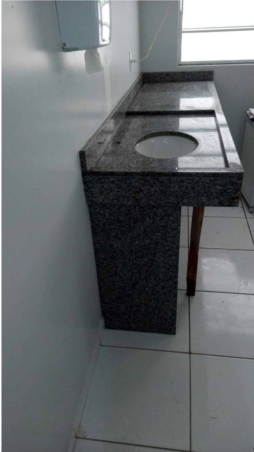
Foto 5: Instalação de bancada.
