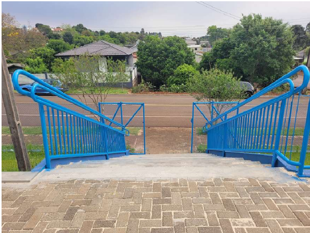
Foto 3: Guarda-corpo nas escadas.
