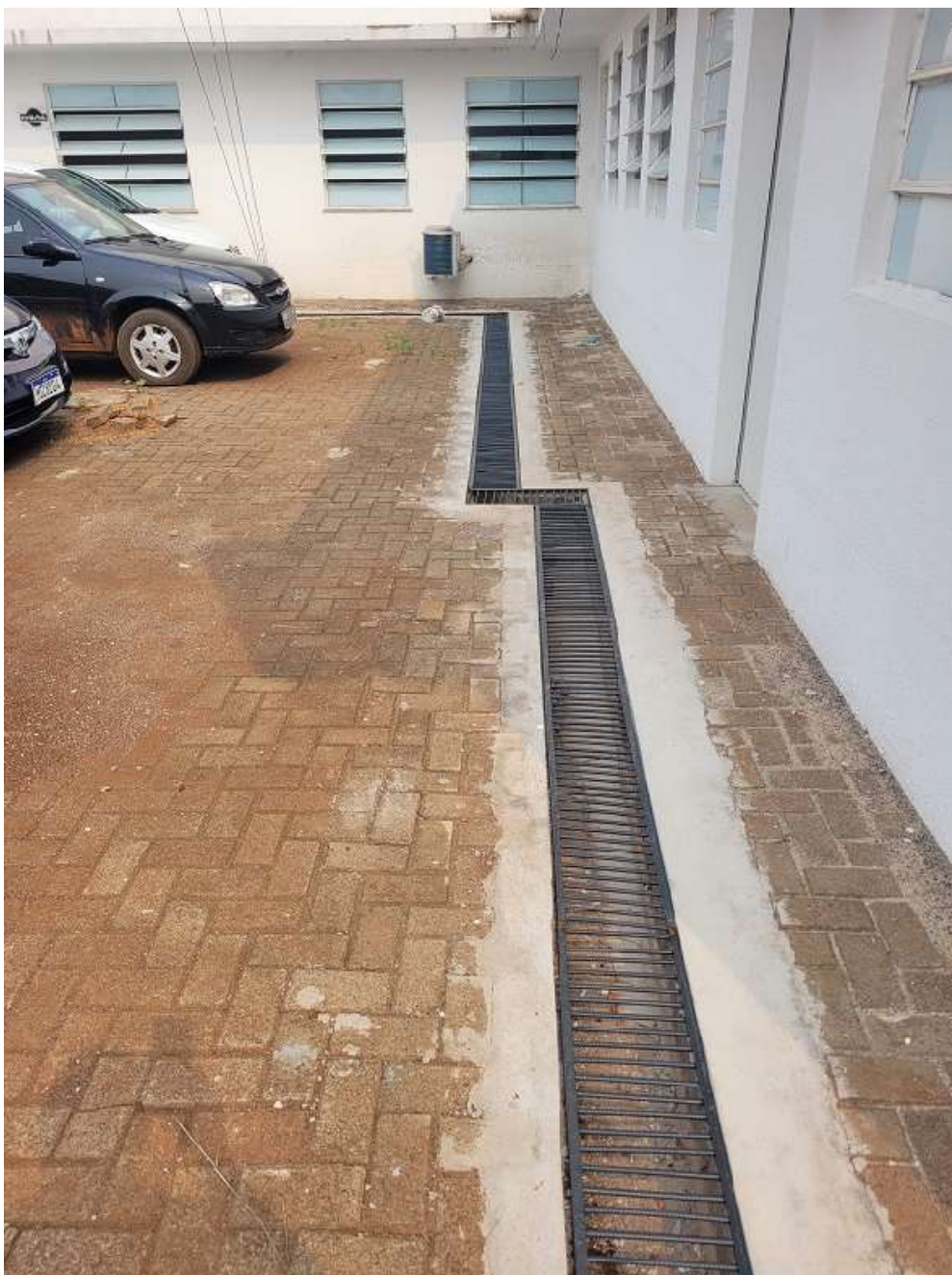
Foto 1: Pintura externa. Canaleta de Drenagem.
