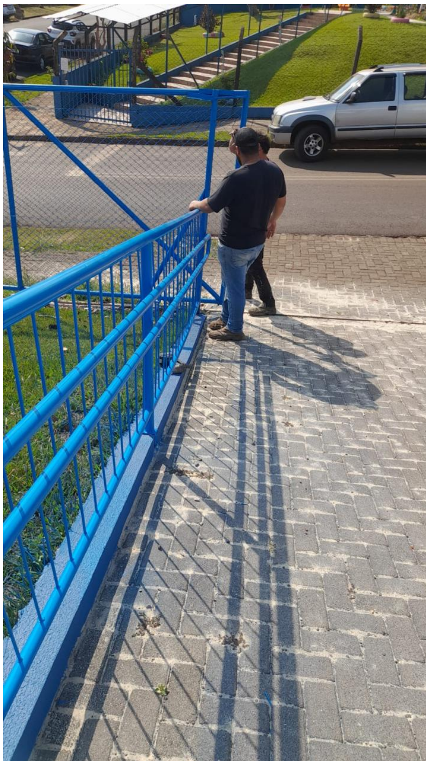
Foto 2: Guarda-corpo e corrimão.
