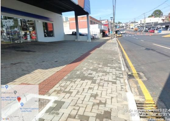
Imagem 25: Pavimentação em CBUQ, calçadas, meio-fio, drenagem e sinalização da via.
