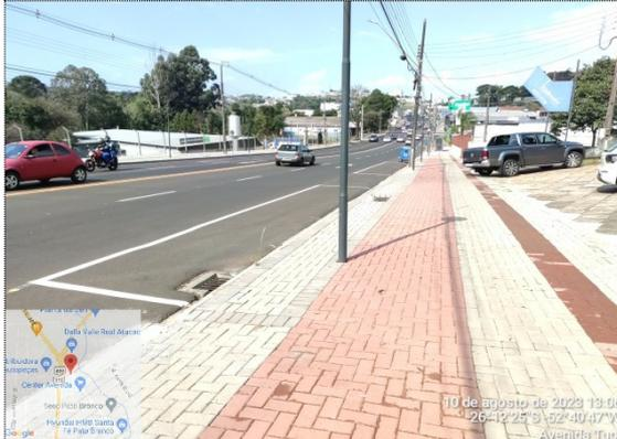
Imagem 35: Pavimentação em CBUQ, calçadas, meio-fio, drenagem e sinalização da via.
