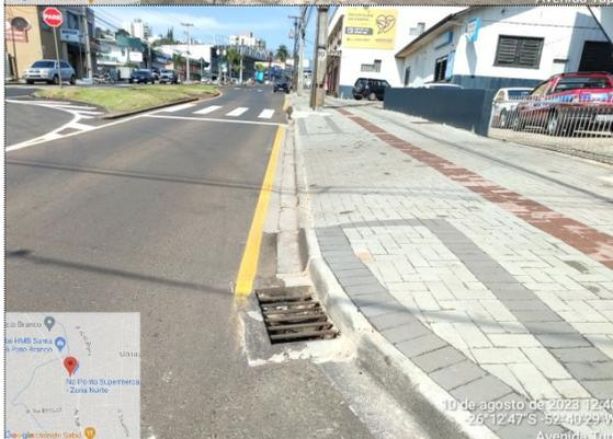
Imagem 24: Pavimentação em CBUQ, calçadas, meio-fio, drenagem e sinalização da via.
