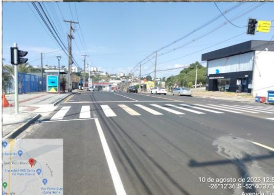
Imagem 29: Pavimentação em CBUQ, calçadas, meio-fio, drenagem e sinalização da via.
