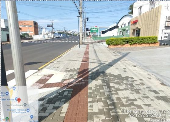
Imagem 31: Pavimentação em CBUQ, calçadas, meio-fio, drenagem e sinalização da via.
