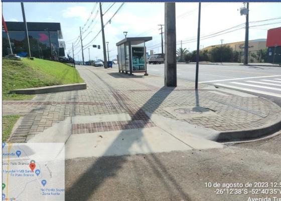
Imagem 28: Pavimentação em CBUQ, calçadas, meio-fio, drenagem e sinalização da via.
