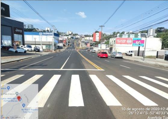
Imagem 26: Pavimentação em CBUQ, calçadas, meio-fio, drenagem e sinalização da via.
