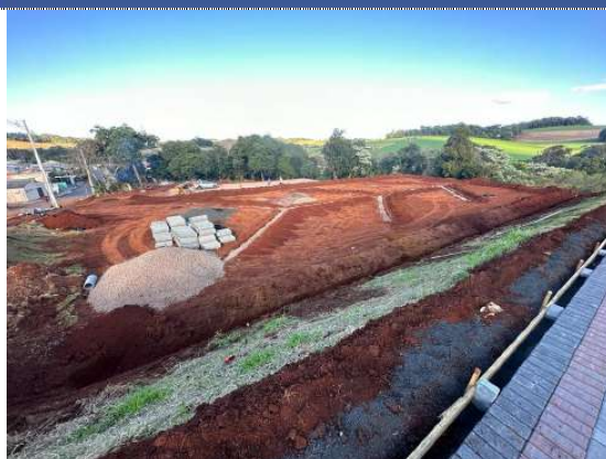
6 – Sistema de Drenagem espinha de Peixe Campo de Grama
