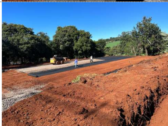
19 – Base de Pavimentação
