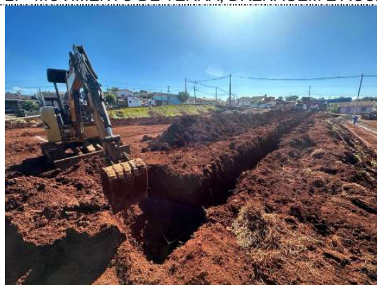
5 – Escavação de Valas
