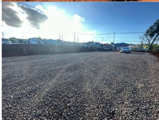
20 – Base de Pavimentação
