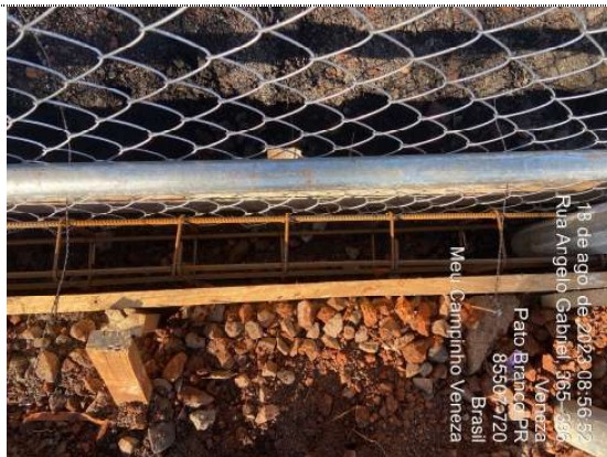
14 – Formas e Armação Vigas Baldrame para concretagem
