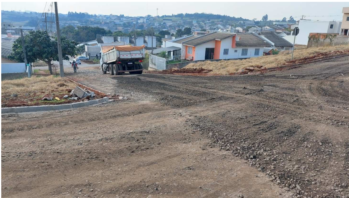
Fotografia 07: Rua Áurea Zandoná Trecho 1 – Execução de Base com BGS.
