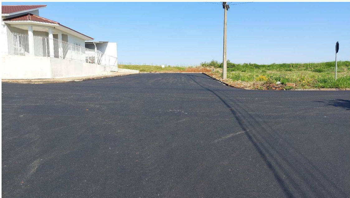
Fotografia 15: Rua Áurea Zandoná Trecho 1 – Execução da Pavimentação com CBUQ.
