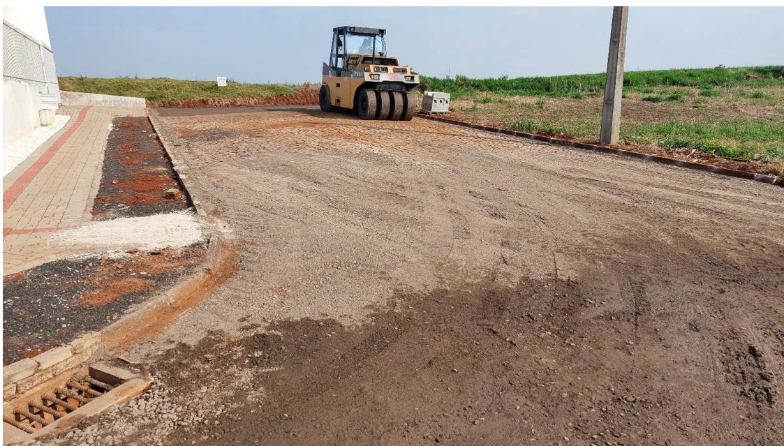
Fotografia 08: Rua Áurea Zandoná Trecho 1 – Execução de Base com BGS.
