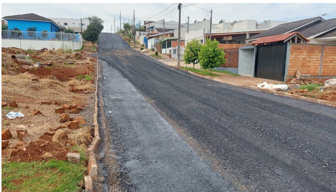
Fotografia 21: Rua Emília Rosa Pietrobelli – Execução de Reperfilagem com CBUQ.
