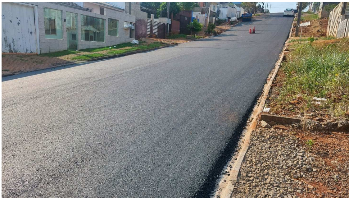
Fotografia 32: Rua Nelson Colla – Execução da Pavimentação em CBUQ.
