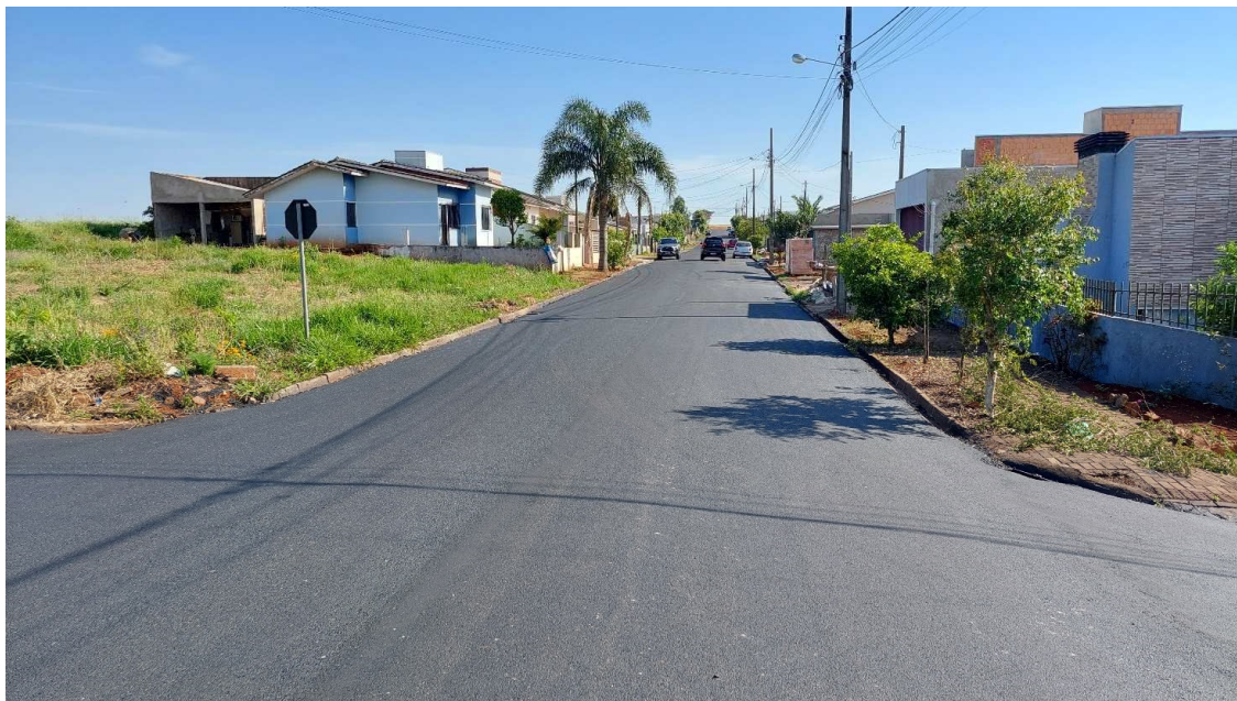
Fotografia 05: Rua Abraão Ribeiro - Execução da Pavimentação com CBUQ.
