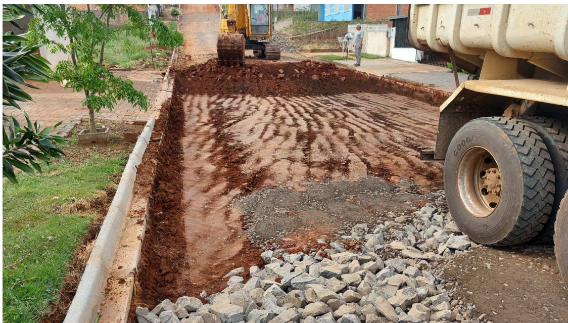
Fotografia 26: Rua Nelson Colla – Execução da Escavação e Compactação.
