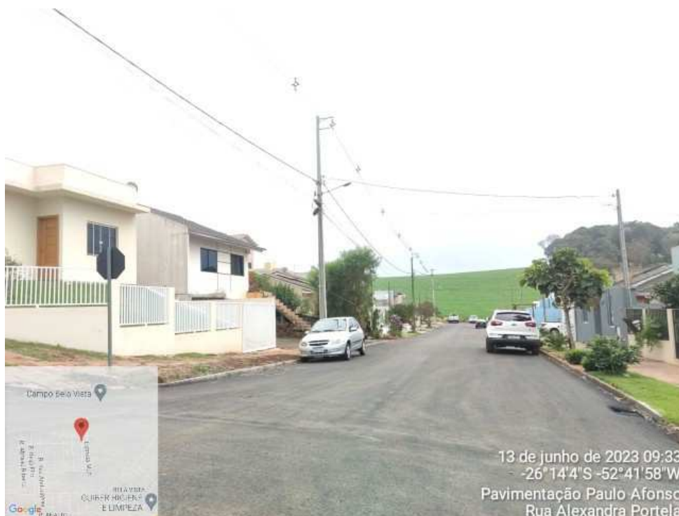
Fotografia 04: Rua Alexandre Portela
