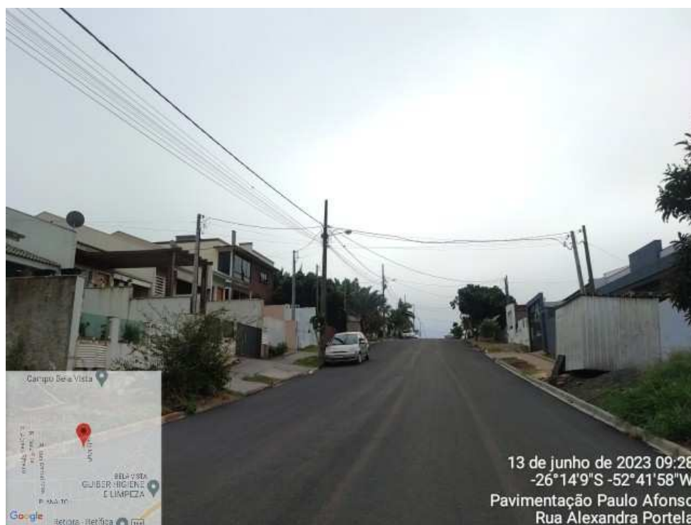
Fotografia 02: Rua Alexandre Portela
