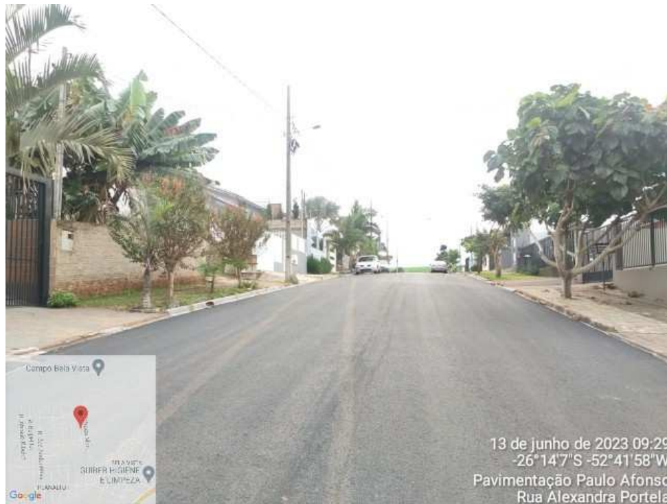
Fotografia 01: Rua Alexandre Portela
