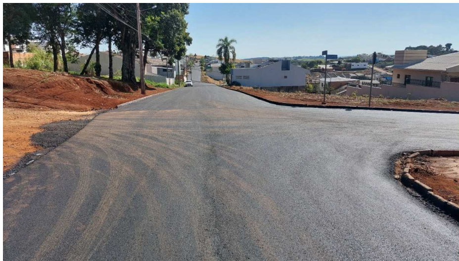
Fotografia 17: Pavimentação Rua Beija Flor.
