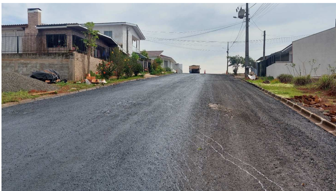
Fotografia 12: Rua Áurea Zandoná Trecho 1 – Execução da Pintura de Ligação.
