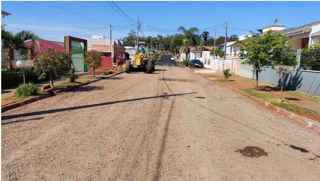
Fotografia 03: Rua Abraão Ribeiro - Execução de Base com BGS e Imprimação.
