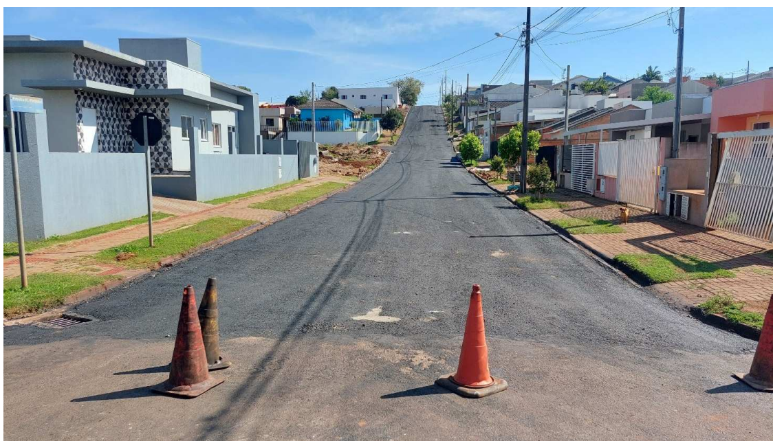
Fotografia 23: Rua Emília Rosa Pietrobelli – Execução de Reperfilagem com CBUQ.
