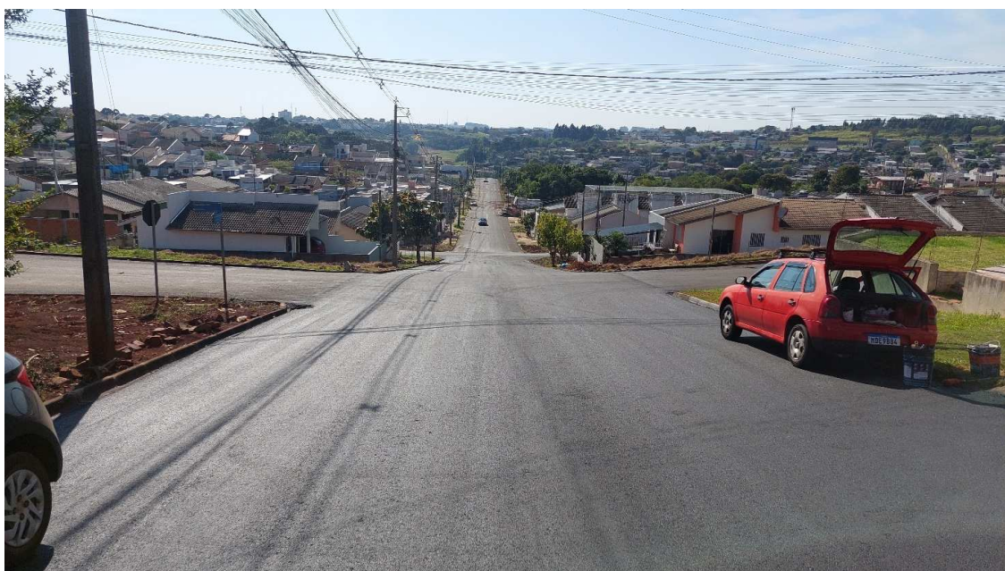
Fotografia 14: Rua Áurea Zandoná Trecho 1 – Execução da Pavimentação com CBUQ.
