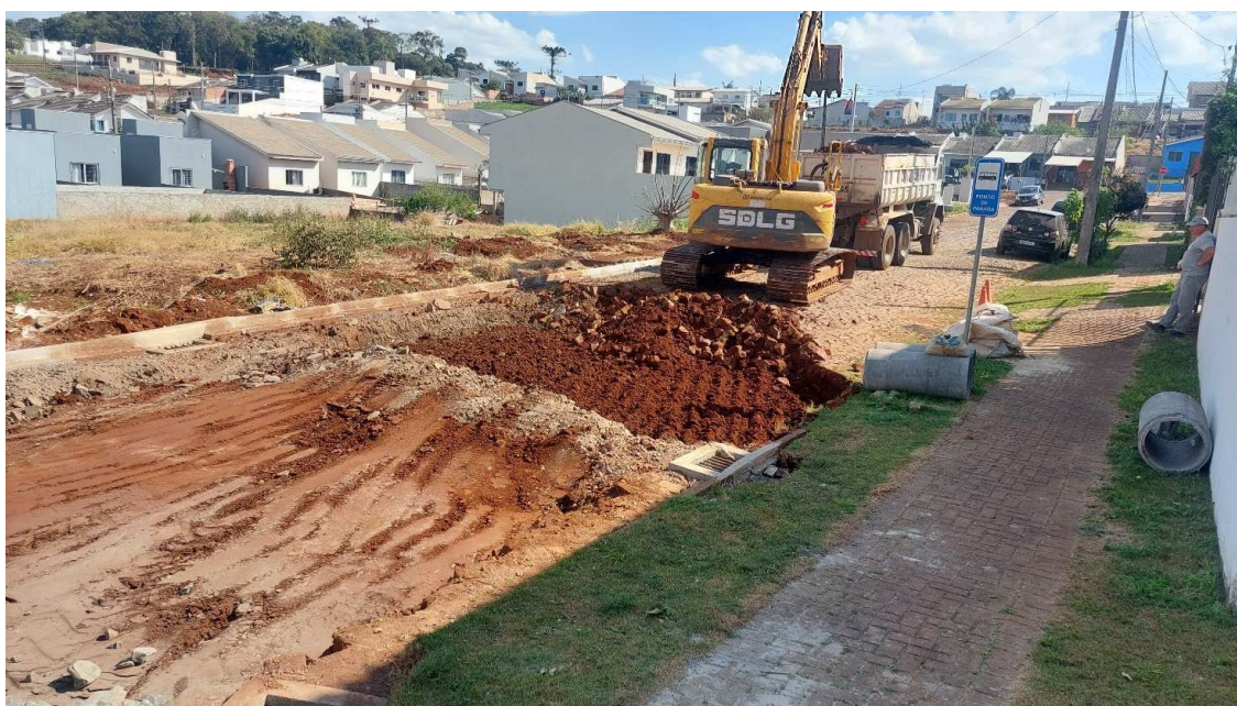
Fotografia 16: Rua Alexandre Popia – Execução de Escavação e Compactação.
