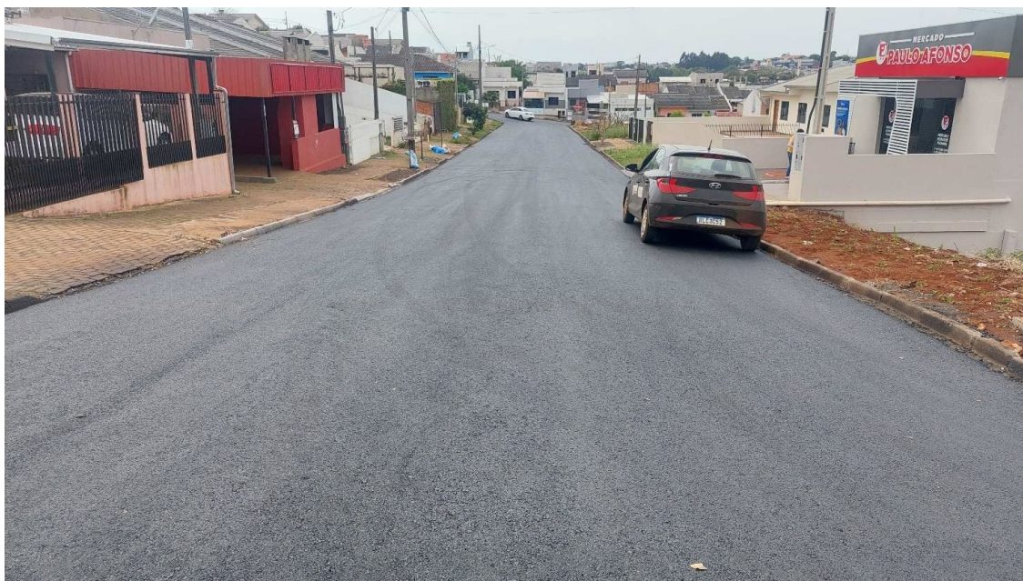
Fotografia 18: Rua Alexandre Popia – Execução da Pavimentação com CBUQ.
