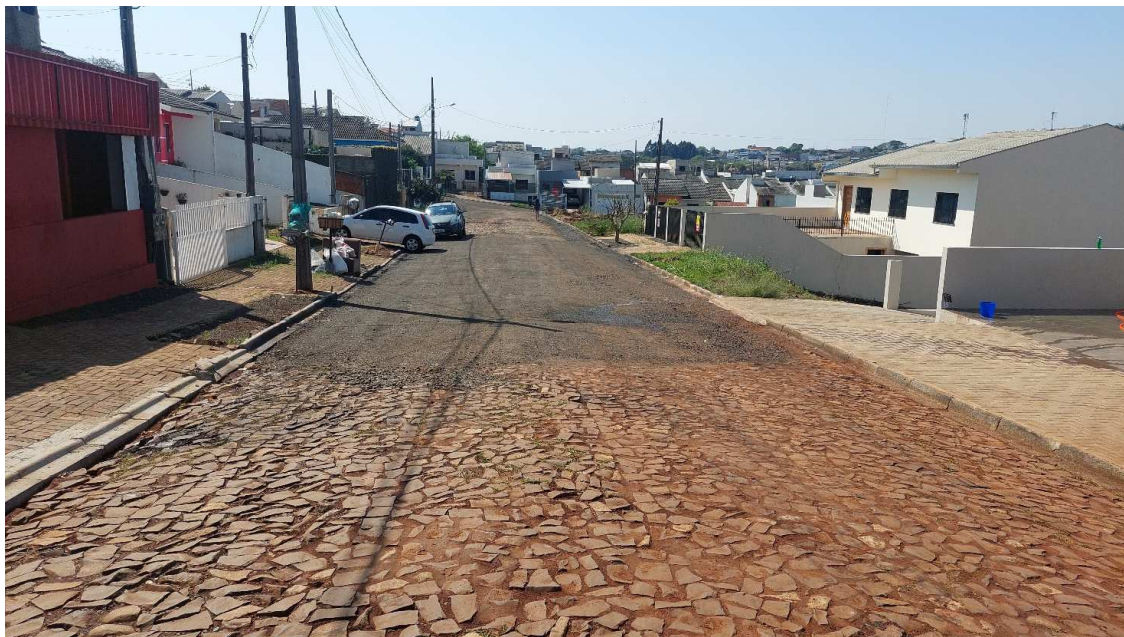
Fotografia 17: Rua Alexandre Pópia – Execução de Base em BGS.
