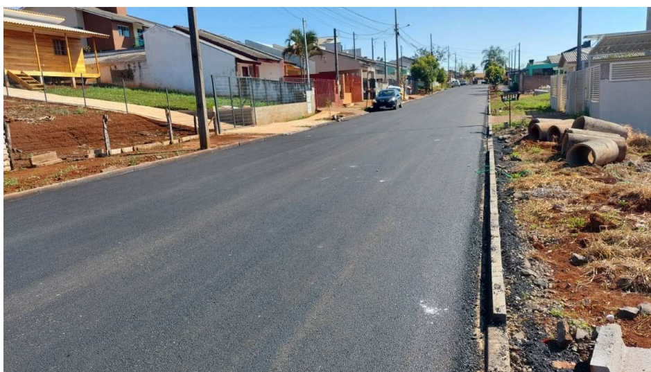
Fotografia 18: Pavimentação Rua Beija Flor.
