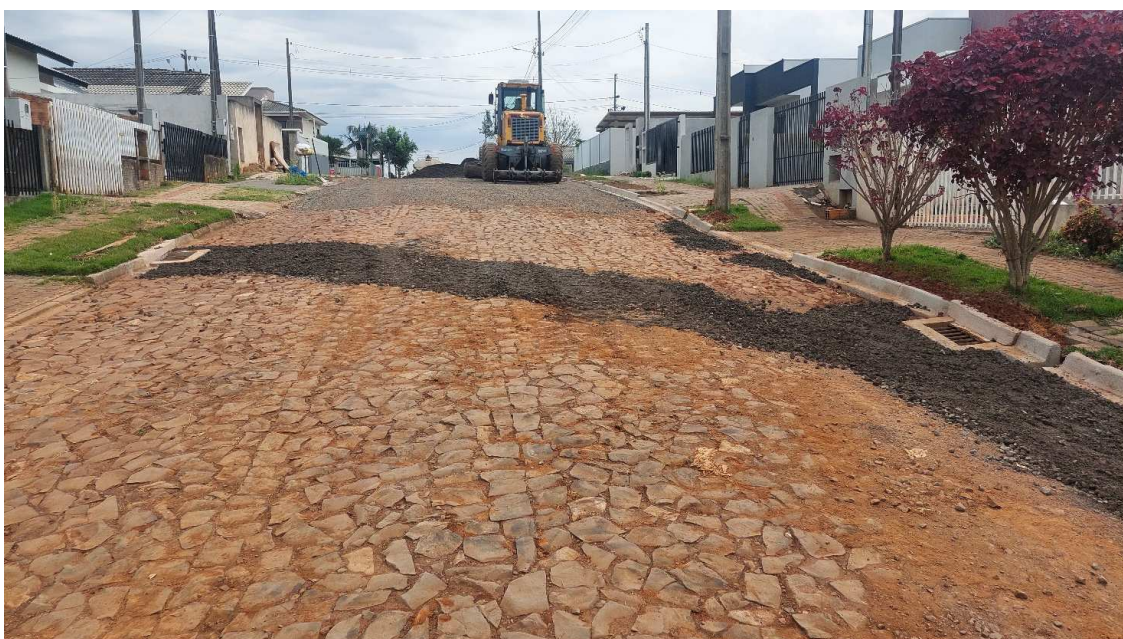
Fotografia 29: Fotografia 28: Rua Nelson Colla – Execução da Base em BGS.
