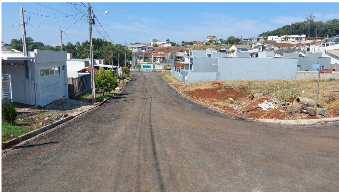
Fotografia 20: Rua Emília Rosa Pietrobelli – Execução de Base com BGS.
