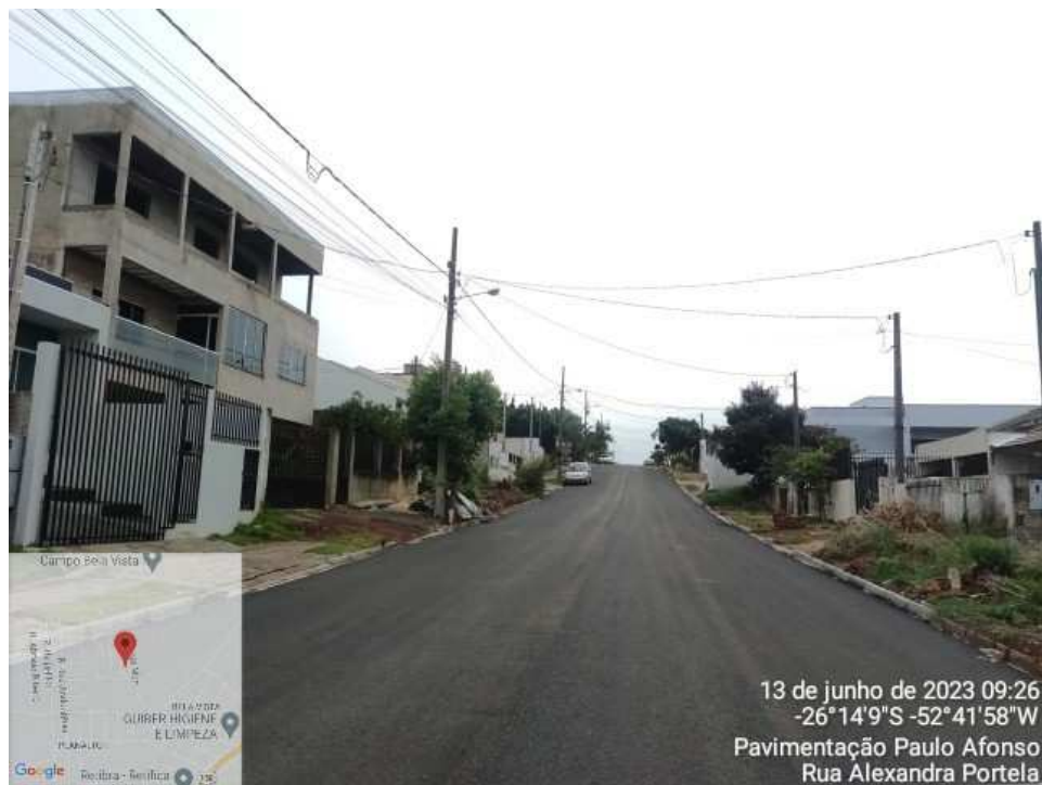
Fotografia 03: Rua Alexandre Portela
