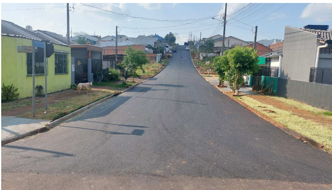
Fotografia 31: Rua Nelson Colla – Execução da Pavimentação em CBUQ.
