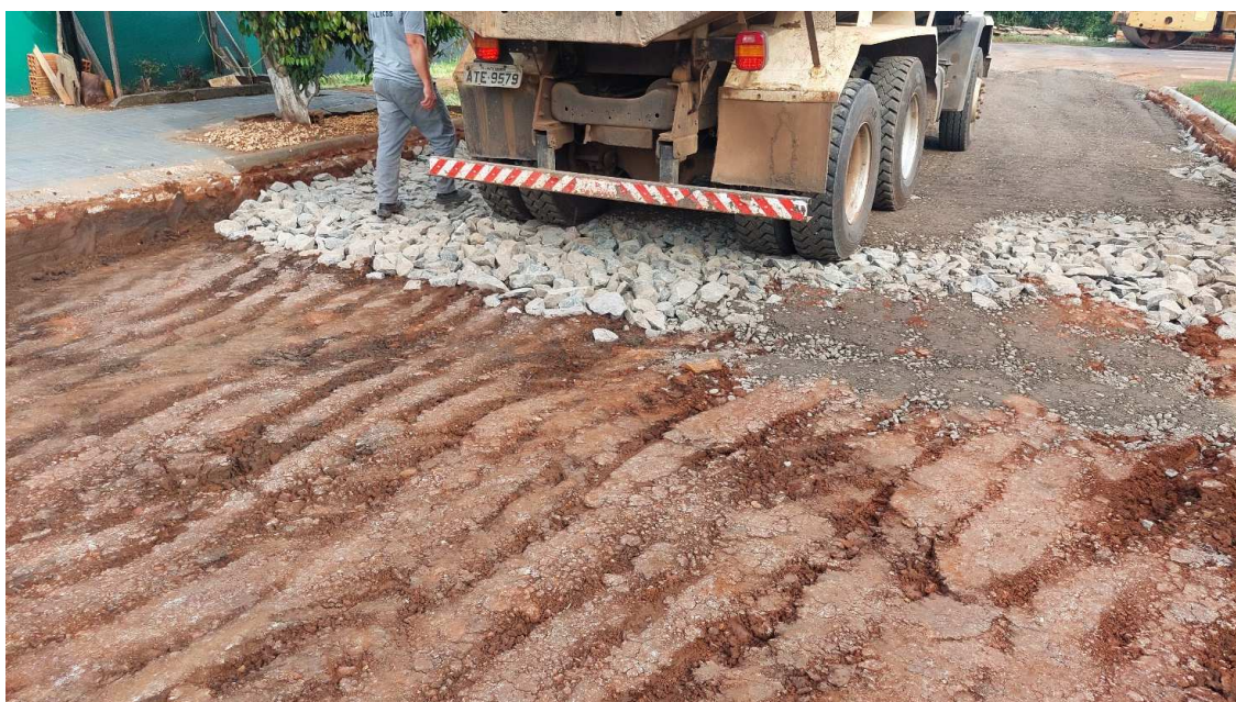
Fotografia 27: Rua Nelson Colla – Execução da Sub-Base em Macadame.
