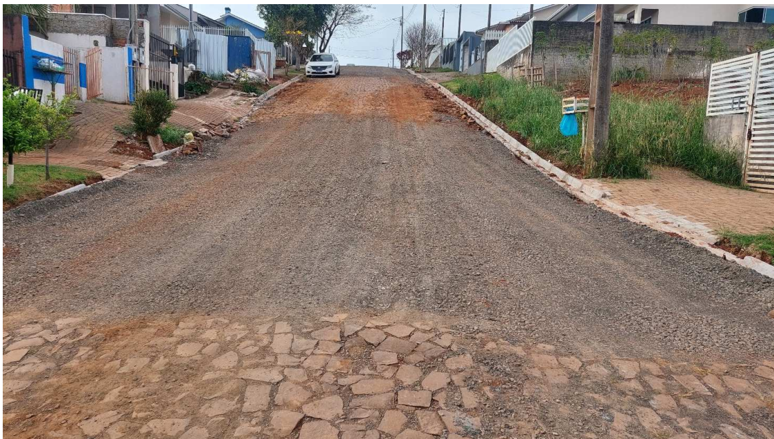
Fotografia 28: Rua Nelson Colla – Execução da Base em BGS.
