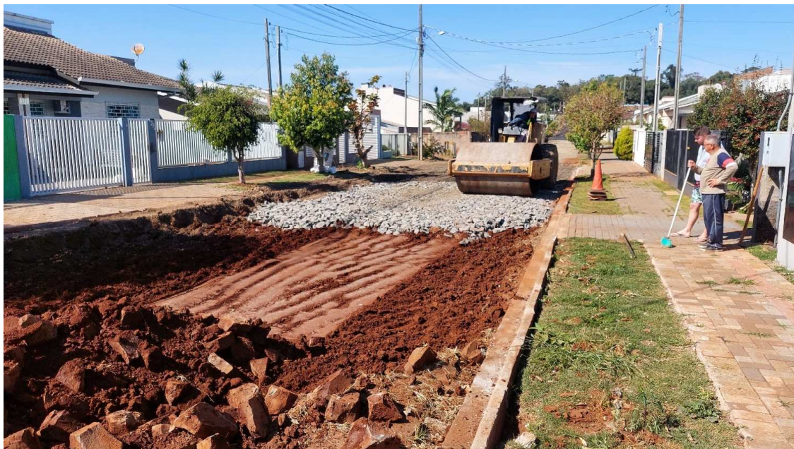
Fotografia 01: Rua Abraão Ribeiro – Escavação, Regularização e Compactação e Execução de Sub-base com macadame.
