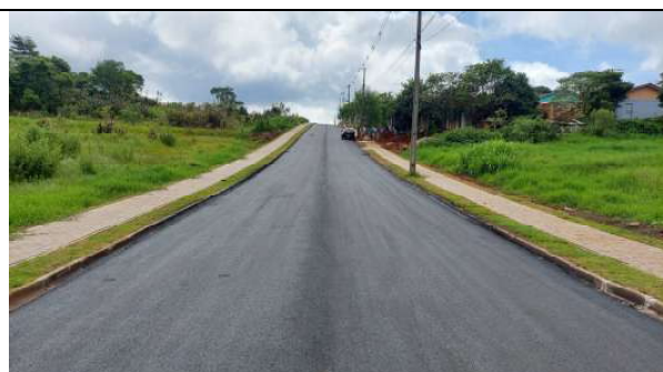
PAVIMENTAÇÃO EM CBUQ RUA ANDRÉ CAVALLI (FOTO 22)
