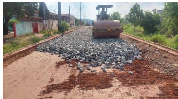
EXECUÇÃO DO MACADAME RUA ANDRÉ CAVALLI (FOTO 8)
