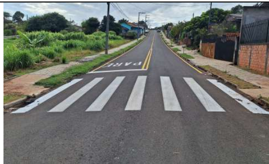
PAVIMENTAÇÃO EM CBUQ E SINALIZAÇÃO HORIZONTAL RUA CELESTE MOCAELIN (FOTO 8)
