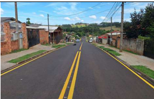
SINALIZAÇÃO HORIZONTAL E CALÇADAS RUA CELESTE MOCELIN (FOTO 9)
