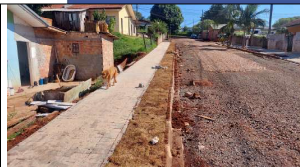
EXECUÇÃO DAS CALÇADAS RUA ASSIS ANDREATTA (FOTO 19)
