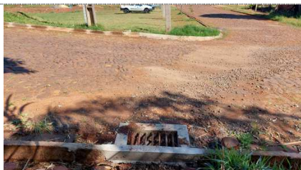
Fotografia 09: Drenagem Rua João Lora – BLn's 1 e 2.
