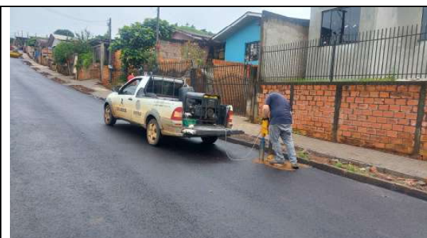
EXECUÇÃO DE ENSAIOS TECNOLÓGICOS RUA CELESTE MOCELIN (FOTO 35)
