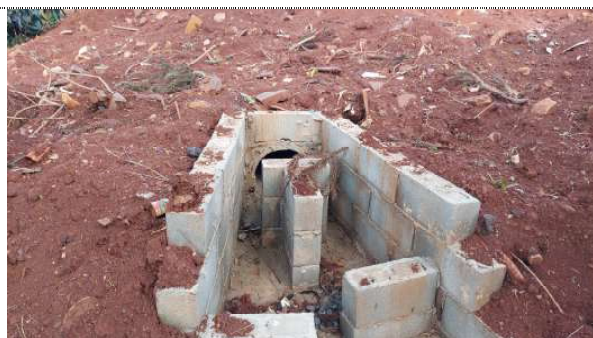
Fotografia 13: Drenagem Rua Celeste Mocelin – Dissipador.
