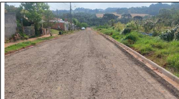
EXEC. DA BRITA GRADUADA RUA ANDRÉ CAVALLI (FOTO 7)
