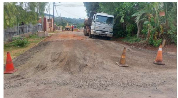
EXECUÇÃO DA BASE RUA ASSIS ANDREATTA (FOTO 4)
