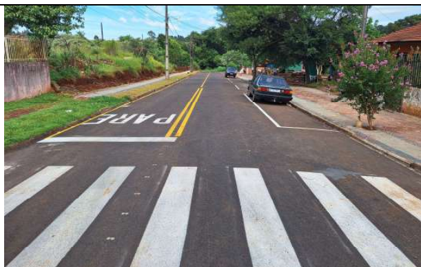
PAVIMENTAÇÃO EM CBUQ E SINALIZAÇÃO HORIZONTAL RUA MARÍLIA (FOTO 3)
