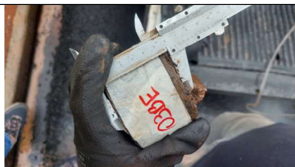
EXECUÇÃO DE ENSAIOS TECNOLÓGICOS RUA ANDRE CAVALLI (FOTO 34)
