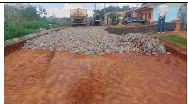
EXECUÇÃO DO MACADAME RUA ANDRÉ CAVALLI (FOTO 6)
