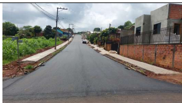
PAVIMENTAÇÃO EM CBUQ E CALÇADAS RUA CELESTE MOCELIN (FOTO 28)
