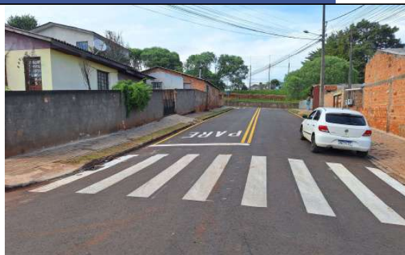
PAVIMENTAÇÃO EM CBUQ, SINALIZAÇÃO HORIZONTAL E CALÇADAS RUA ASSIS ANDREATTA (FOTO 20)
