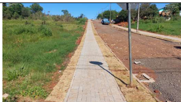
EXECUÇÃO DAS CALÇADAS RUA ANDRÉ CAVALLI (FOTO 16)
