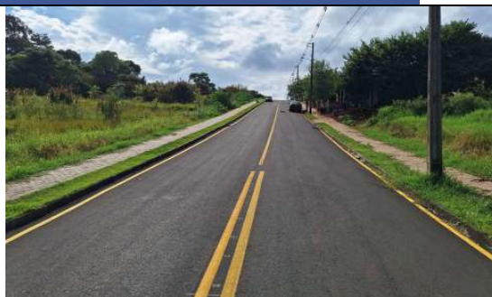
PAVIMENTAÇÃO EM CBUQ, SINALIZAÇÃO HORIZONTAL E CALÇADAS RUA ANDRÉ CAVALLI (FOTO 14)
