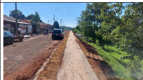
EXECUÇÃO DAS CALÇADAS RUA ANDRÉ CAVALLI (FOTO 17)
