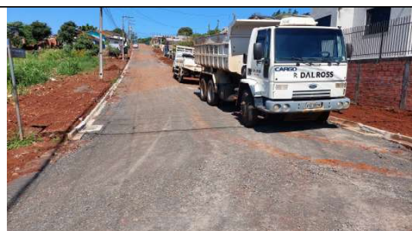
EXECUÇÃO DA BASE RUA CELESTE MOCELIN (FOTO 12)
