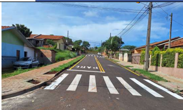
PAVIMENTAÇÃO EM CBUQ, SINALIZAÇÃO HORIZONTAL RUA ASSIS ANDREATTA (FOTO 19)
