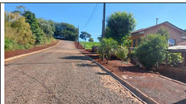
EXECUÇÃO DE MEIO-FIOS RUA JOÃO LORA (FOTO 15)
