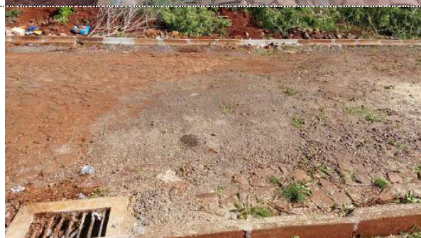
Fotografia 16: Drenagem Rua Marília - BLn's 1 e 2.
