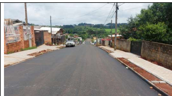
PAVIMENTAÇÃO EM CBUQ E CALÇADAS RUA CELESTE MOCELIN (FOTO 27)
