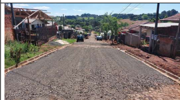
EXECUÇÃO DA BASE RUA CELESTE MOCELIN (FOTO 11)
