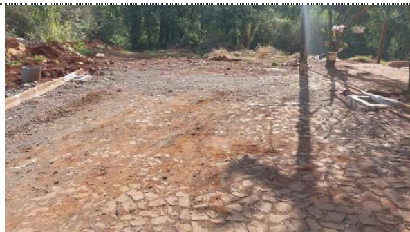
Fotografia 17: Drenagem Rua Marília - BLn's 3 e 4.
