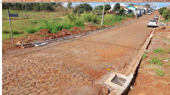
Fotografia 11: Drenagem Rua Celeste Mocelin – BLn's 3 e 4.
