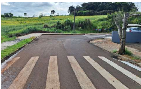
PAVIMENTAÇÃO EM CBUQ, SINALIZAÇÃO HORIZONTAL RUA ANDRÉ CAVALLI (FOTO 16)
