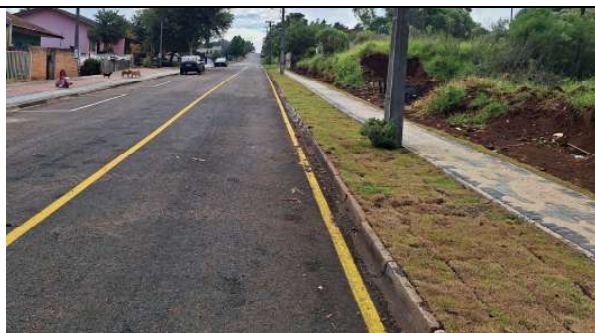
CALÇADA RUA MARÍLIA (FOTO 5)
