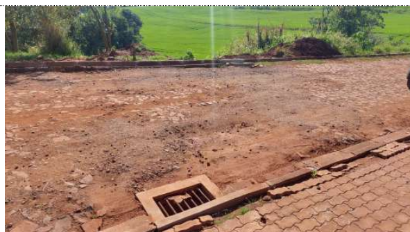
Fotografia 05: Drenagem Rua André Cavalli – BLn's 11 e 12.
