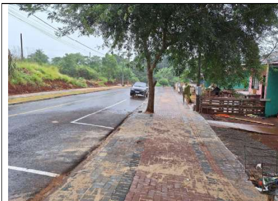
CALÇADA E SINALIZAÇÃO HORIZONTAL RUA MARÍLIA (FOTO 4)
