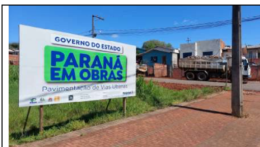
PLACA DA OBRA ATUALIZADA (FOTO 1)
