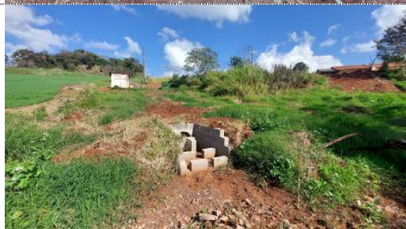
Fotografia 07: Drenagem Rua André Cavalli – Dissipador.
