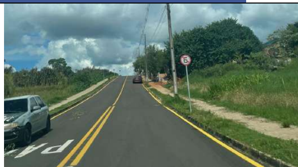
SINALIZAÇÃO VERTICAL E HORIZONTAL RUA ANDRÉ CAVALLI (FOTO 32)
