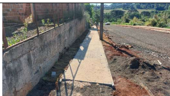
EXECUÇÃO DAS CALÇADAS RUA ANDRÉ CAVALLI (FOTO 18)
