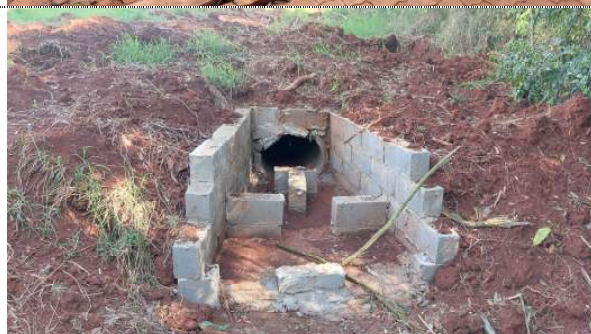
Fotografia 06: Drenagem Rua André Cavalli – Dissipador.
