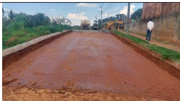
REGULARIZAÇÃO E COMPAC. RUA ANDRÉ CAVALLI (FOTO 5)
