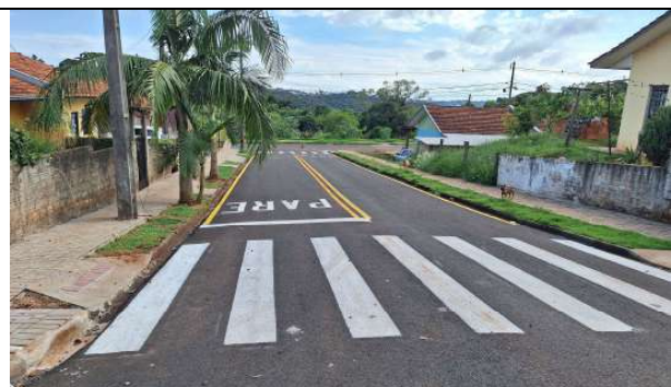
PAVIMENTAÇÃO EM CBUQ, SINALIZAÇÃO HORIZONTAL E CALÇADAS RUA ASSIS ANDREATTA (FOTO 21)
