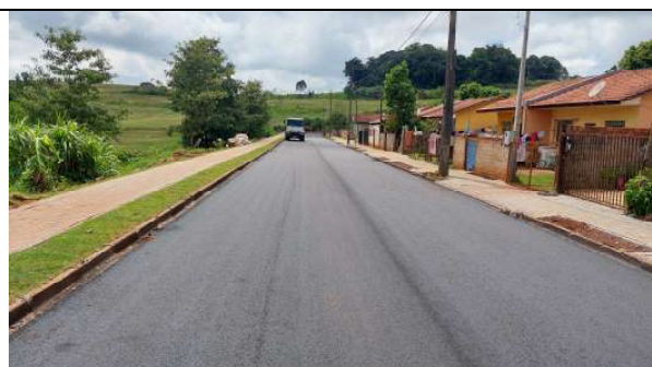
PAVIMENTAÇÃO EM CBUQ RUA ANDRÉ CAVALLI (FOTO 24)
