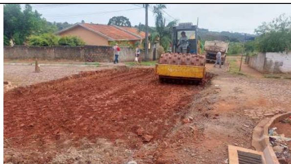
ESCAVAÇÃO E COMPAC. RUA ASSIS ANDREATTA (FOTO 3)
