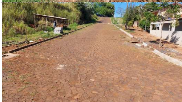
Fotografia 08: Drenagem Rua João Lora – BLn3, Bls1 e Meio Fio.
