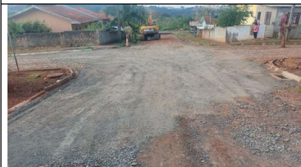
EXECUÇÃO DA BASE RUA ASSIS ANDREATTA (FOTO 9)
