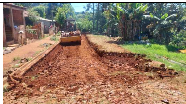
ESCAVAÇÃO E COMPAC. RUA CELESTE MOCELIN (FOTO 10)
