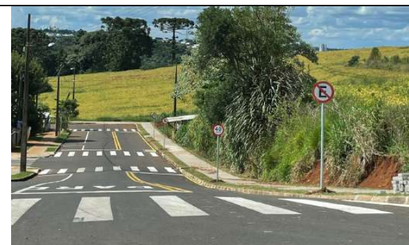
SINALIZAÇÃO VERTICAL E HORIZONTAL RUA JOÃO LORA (FOTO 22)
