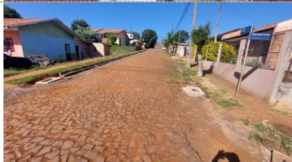
Fotografia 14: Drenagem Rua Assis Andreatta – BLn's 3 e 4.
