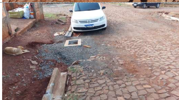
Fotografia 15: Drenagem Rua Assis Andreatta – BLn's 1 e 2.
