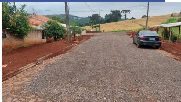
EXECUÇÃO DA BASE E REGULARIZAÇÃO DAS CALÇADAS RUA JOÃO LORA (FOTO 14)
