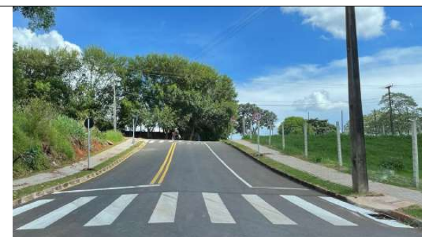
SINALIZAÇÃO VERTICAL E HORIZONTAL RUA JOÃO LORA (FOTO 23)
