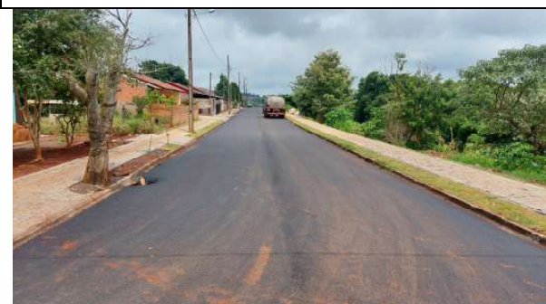
PAVIMENTAÇÃO EM CBUQ RUA ANDRÉ CAVALLI (FOTO 23)
