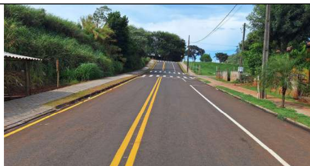
PAVIMENTAÇÃO EM CBUQ, SINALIZAÇÃO HORIZONTAL RUA JOÃO LORA (FOTO 17)
