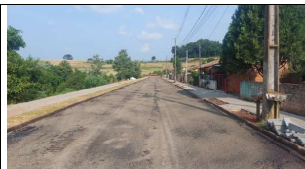
IMPRIMAÇÃO E CALÇADAS RUA ANDRÉ CAVALLI (FOTO 21)
