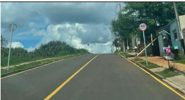
SINALIZAÇÃO VERTICAL E HORIZONTAL RUA ANDRÉ CAVALLI (FOTO 33)
