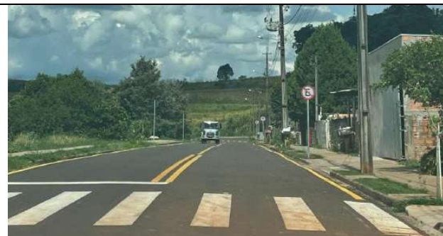
SINALIZAÇÃO VERTICAL E HORIZONTAL RUA ANDRÉ CAVALLI (FOTO 34)
