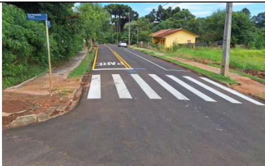
PAVIMENTAÇÃO EM CBUQ E SINALIZAÇÃO HORIZONTAL RUA CELESTE MOCELIN (FOTO 7)
