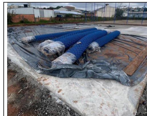
07. Piso de Concreto – quadra de basquete
