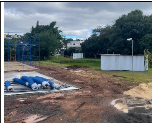
03. Execução de estacas e piso
