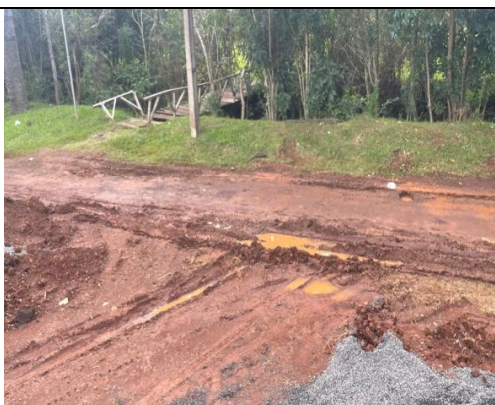
06. Terraplenagem e demolição de passeio
