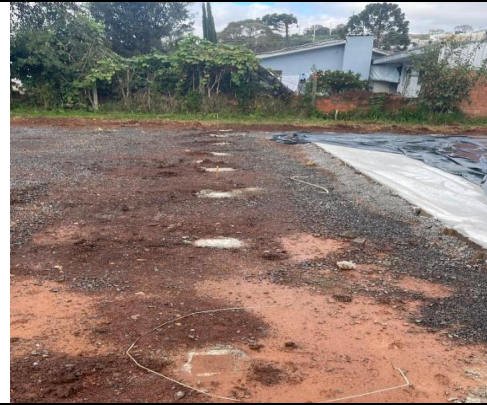
08. Estaca/Brocas e espera para alambrados
