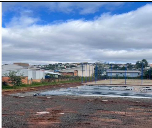
02. Estaca/Brocas e espera para alambrados
