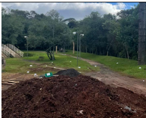
04. Demolição de pavimento asfáltico
