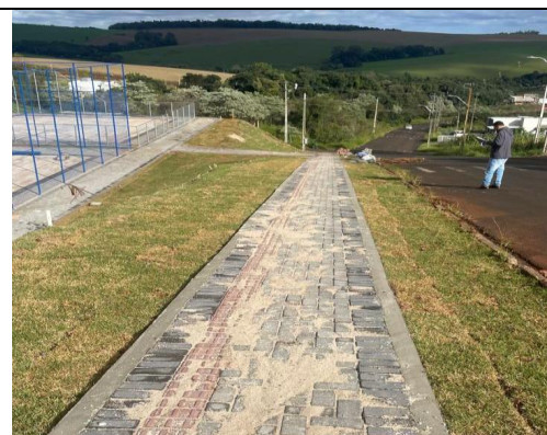
03. CALÇADA FRENTE DA OBRA.
