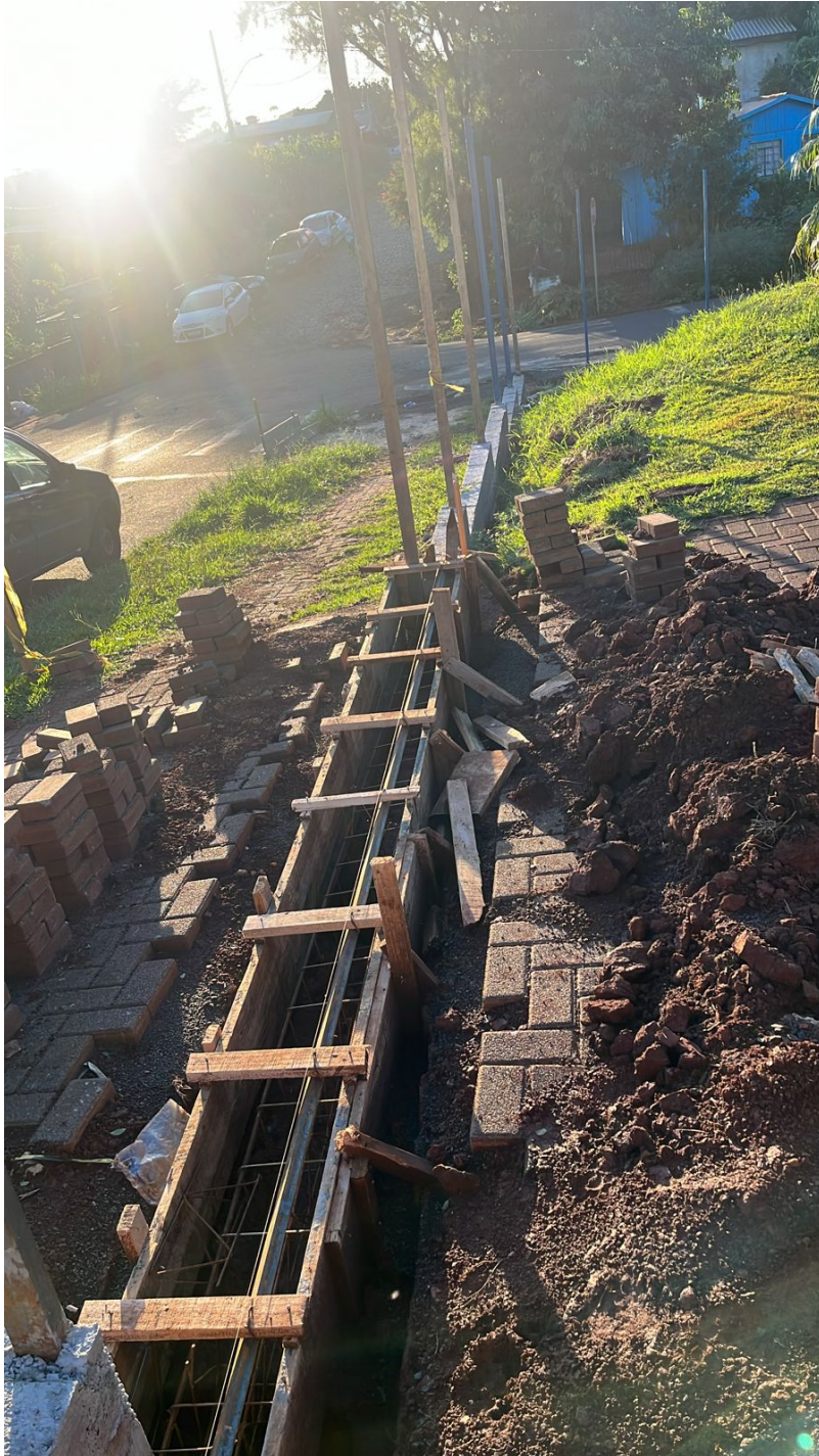
Foto 1: Vigas de cercamento.
