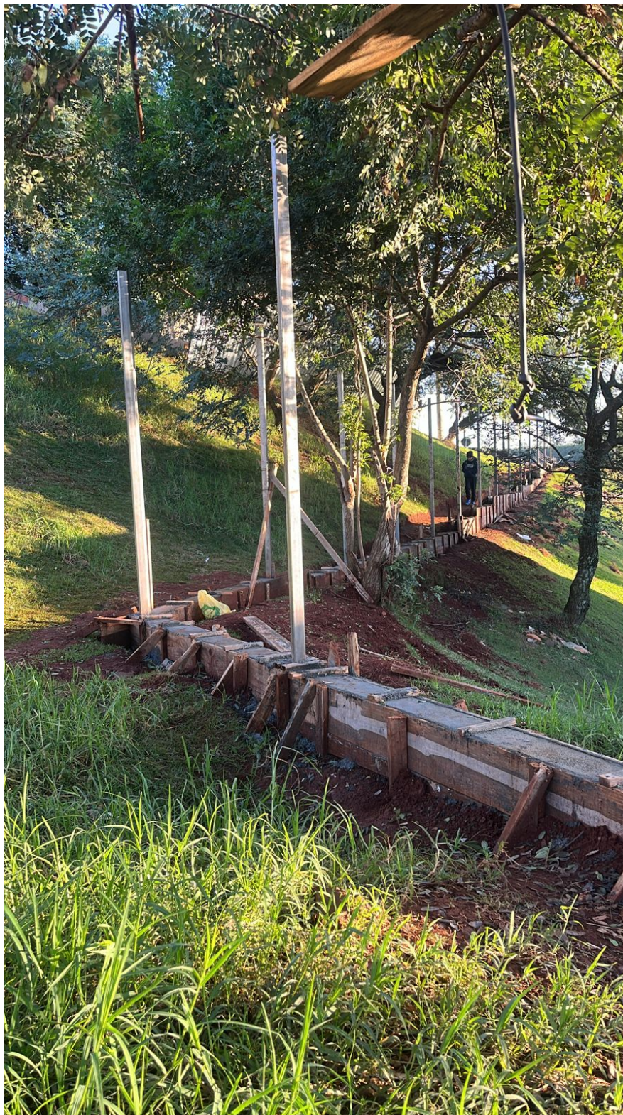
Foto 2: Concretagem de Vigas Baldrames.
