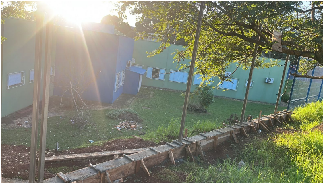
Foto 3: Concretagem de Vigas Baldrames.
