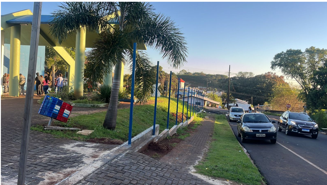
Foto 4: Viga baldrame do cercamento.
