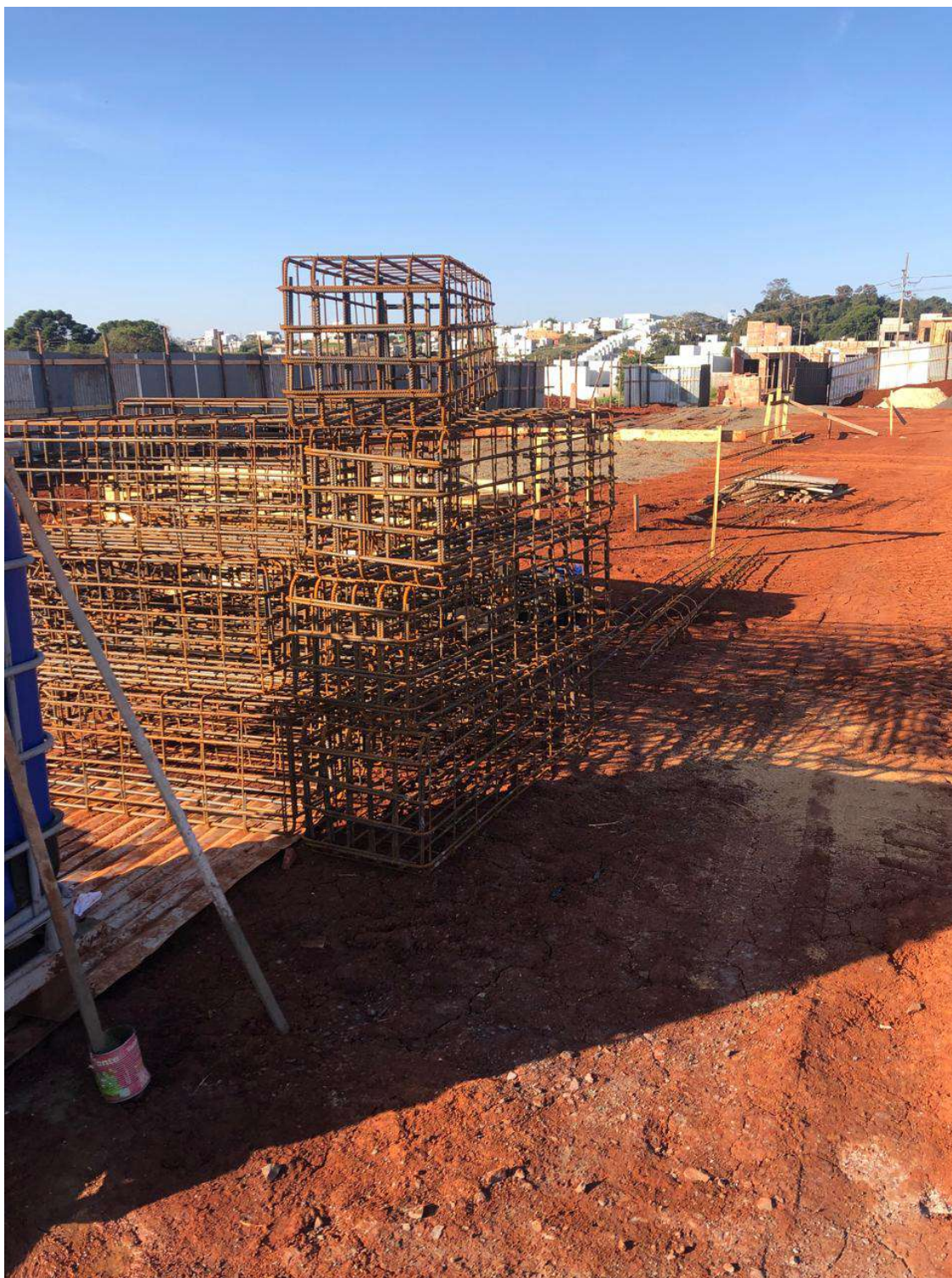
Foto 4: Armadura blocos de fundações.
