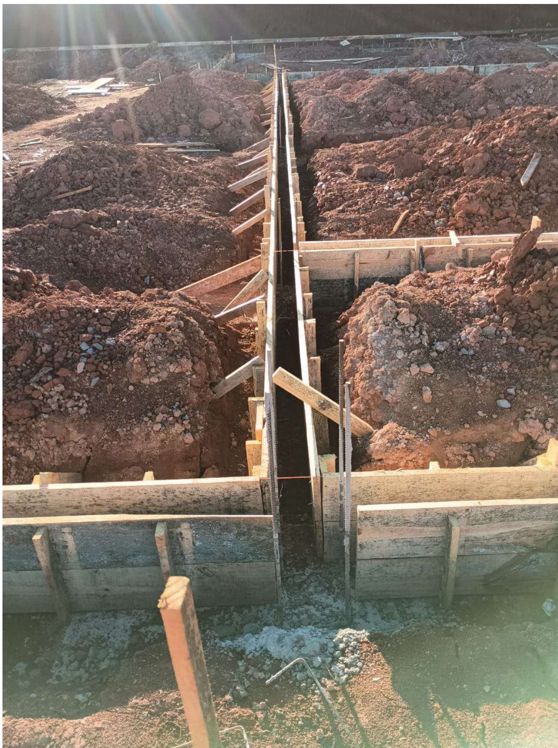
Foto 9: Caixaria para vigas baldrames.
