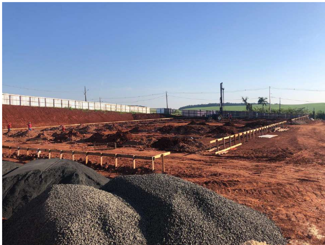
Foto 2: Locação e escavação de estacas e blocos.
