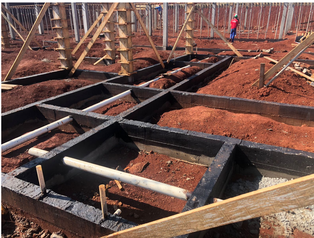
Foto 5: Baldrame e Tubulações de esgoto.
