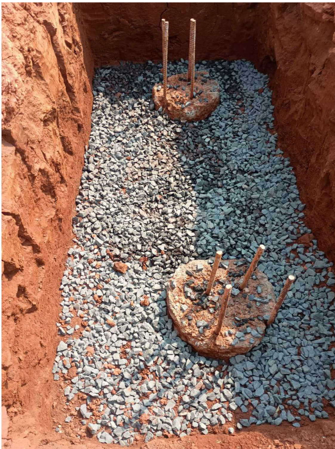
Foto 6: Estacas concretadas, lastro de material granular.
