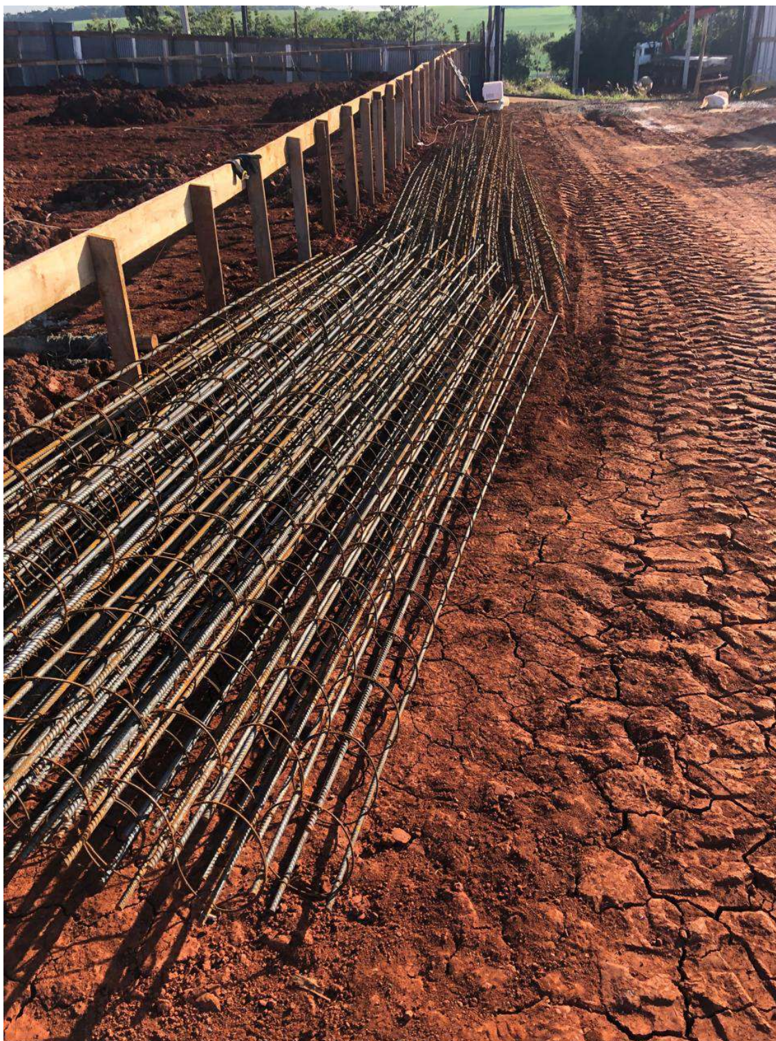
Foto 3: Armação das Estacas.
