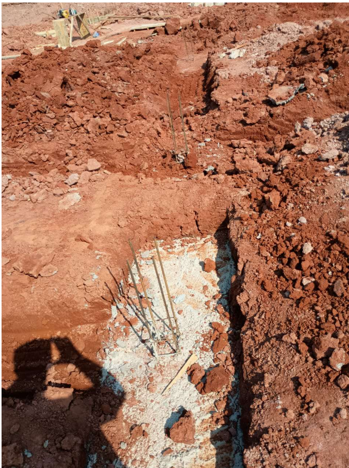
Foto 8: Blocos de fundação concretados.
