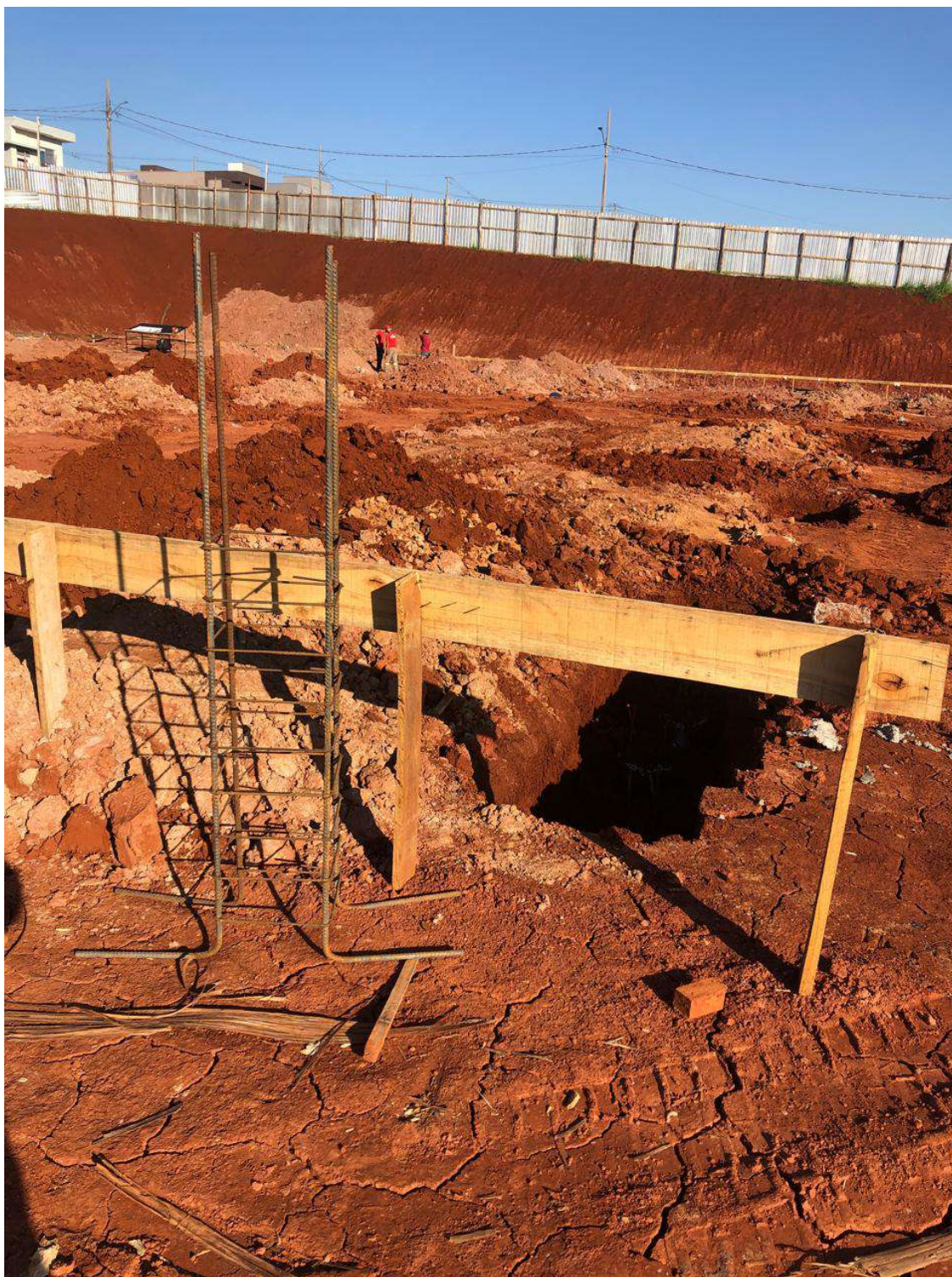
Foto 5: blocos e arranque de pilares.
