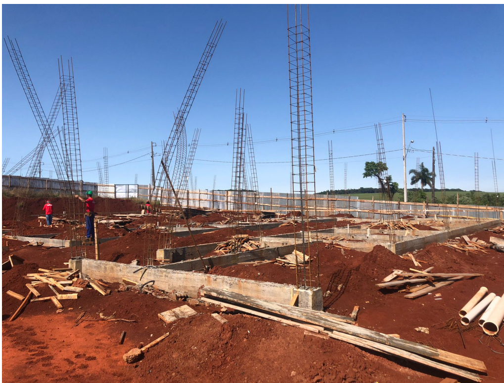
Foto 6: Baldrame e armadura de pilares.
