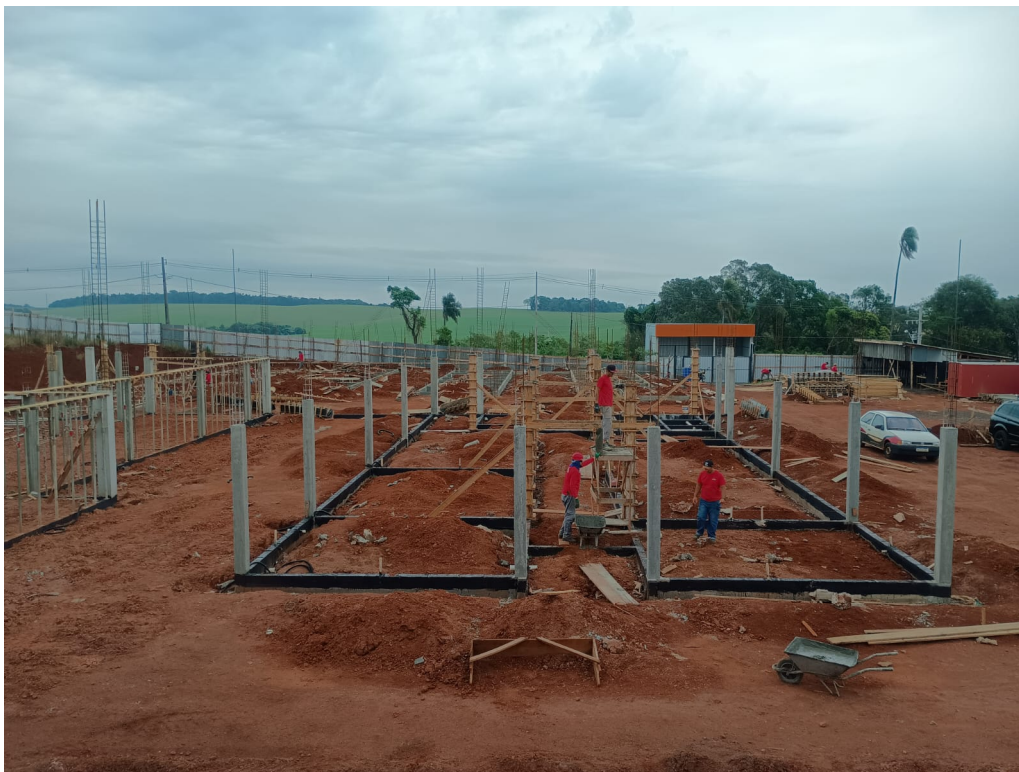
Foto 3: Pilares, vigas baldrame impermeabilizadas e reaterro.
