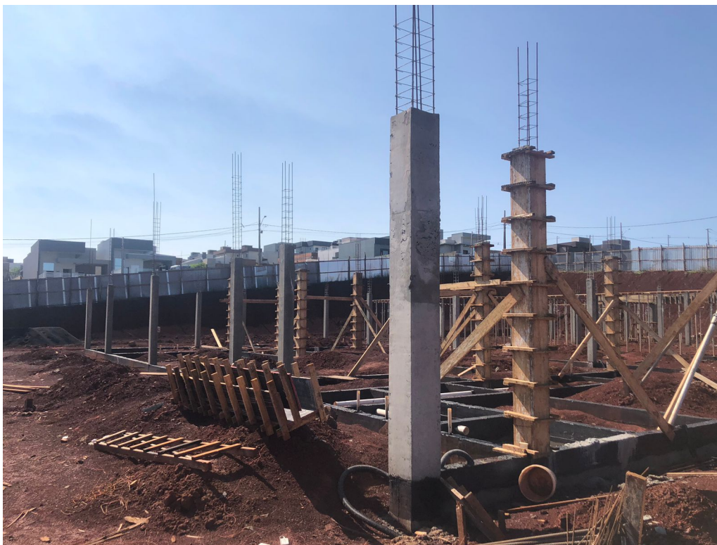
Foto 4: Pilares concretados e vigas baldrame impermeabilizadas.
