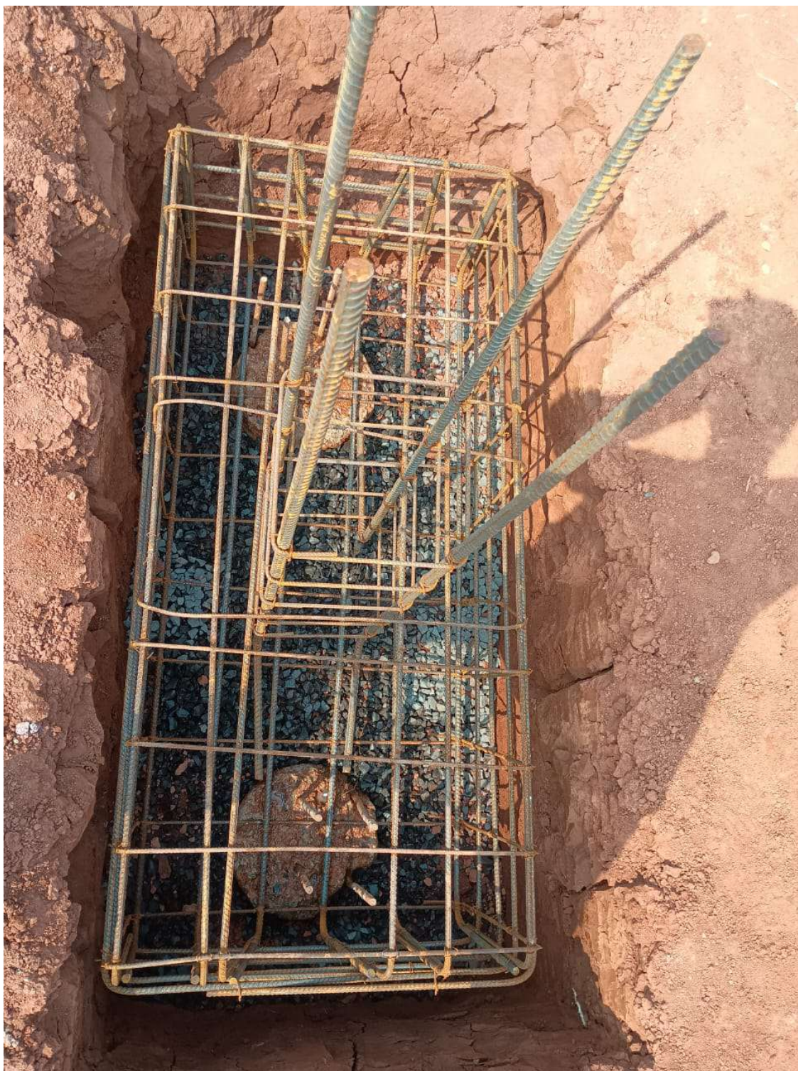
Foto 7: Armadura blocos de fundações.
