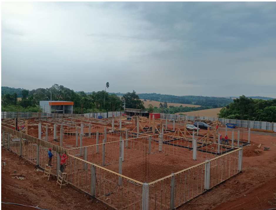
Foto 1: Imagem panorâmica da Obra.
