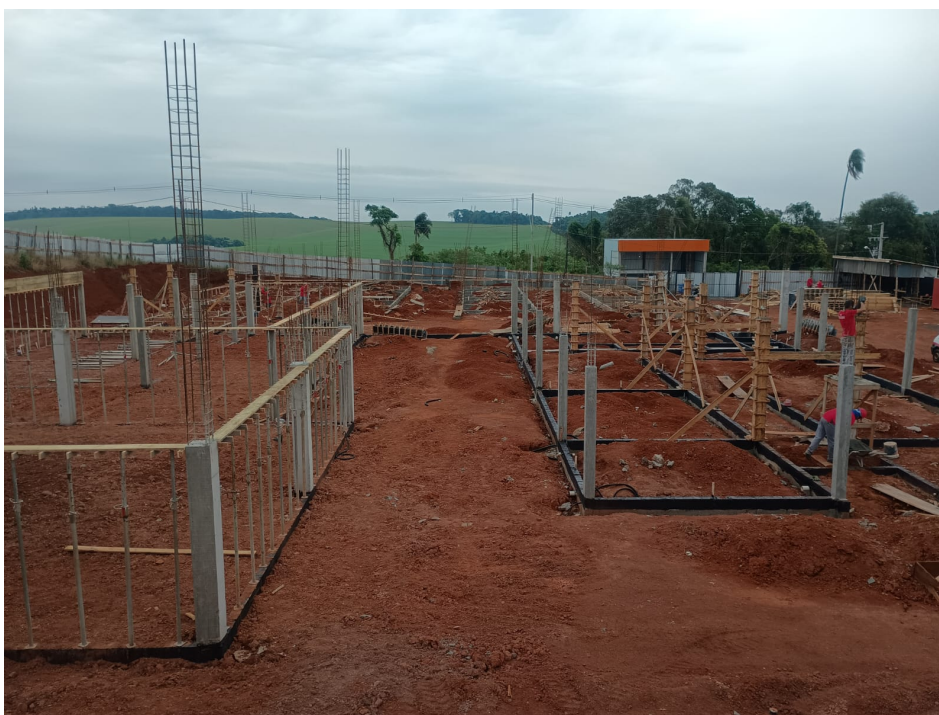
Foto 2: Imagem panorâmica da Obra.
