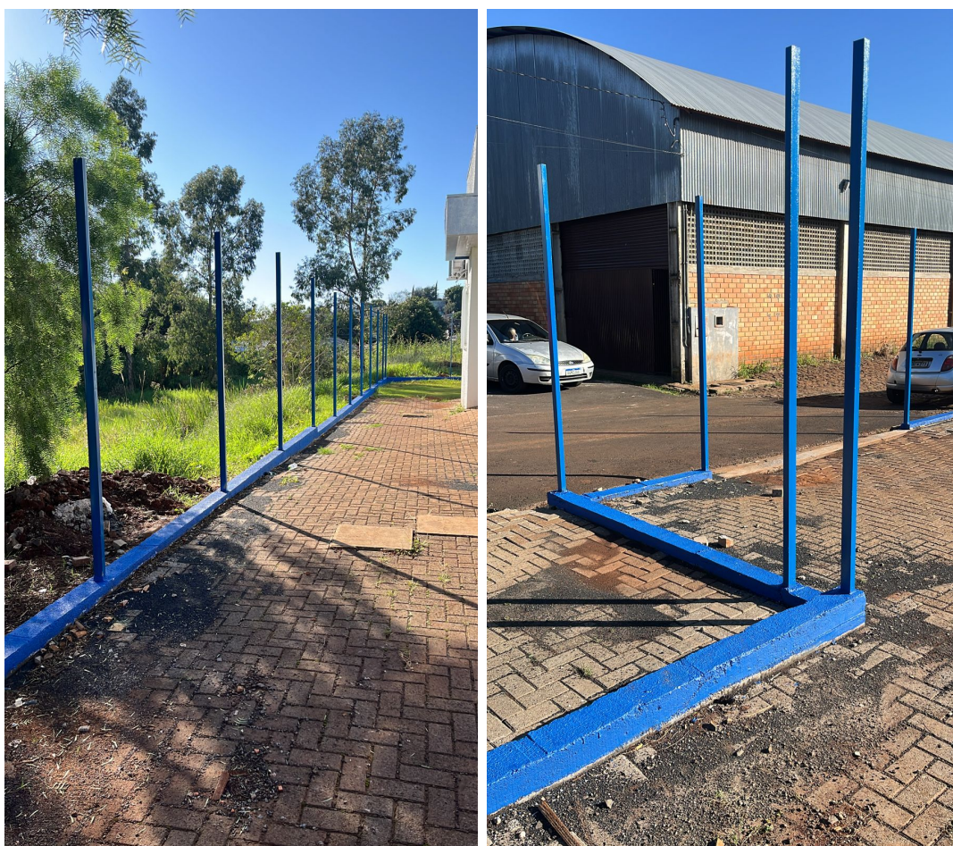
Foto 3: Viga baldrame do cercamento.
