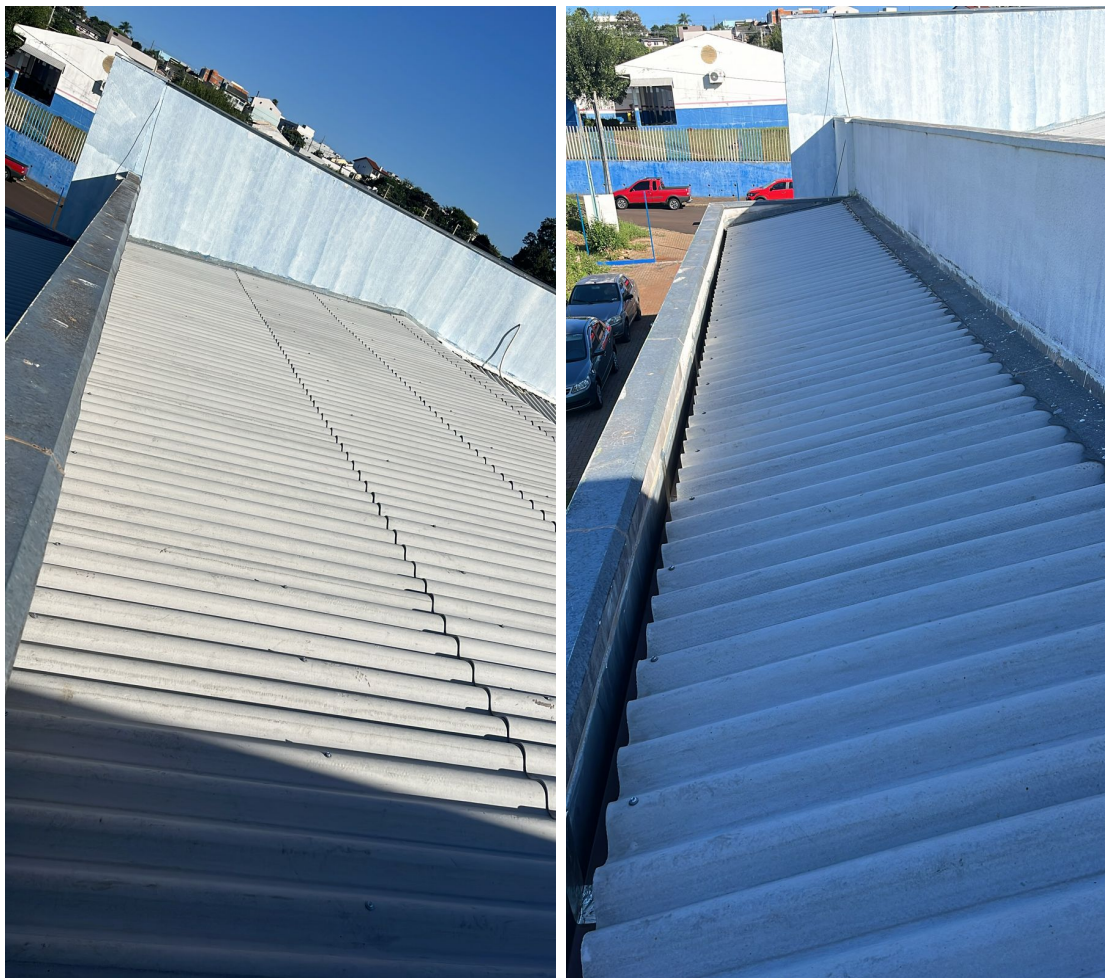
Foto 1: Troca das telhas em fibrocimento.
