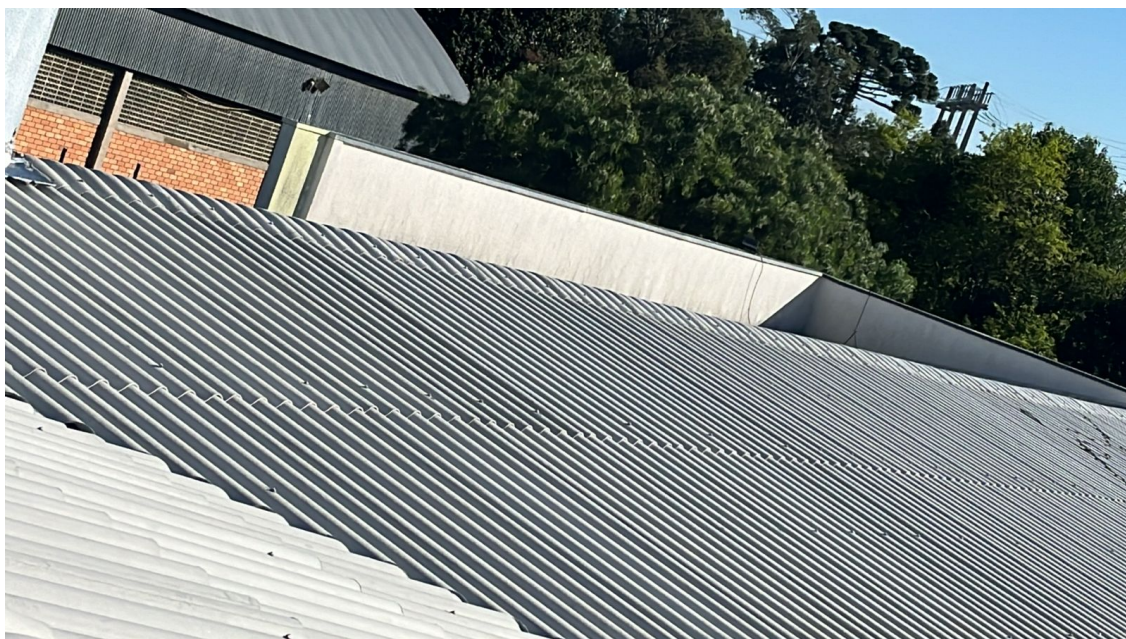
Foto 2: Telhas e cumeeiras em fibrocimento.
