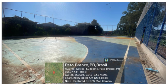
2 | Piso de concreto
