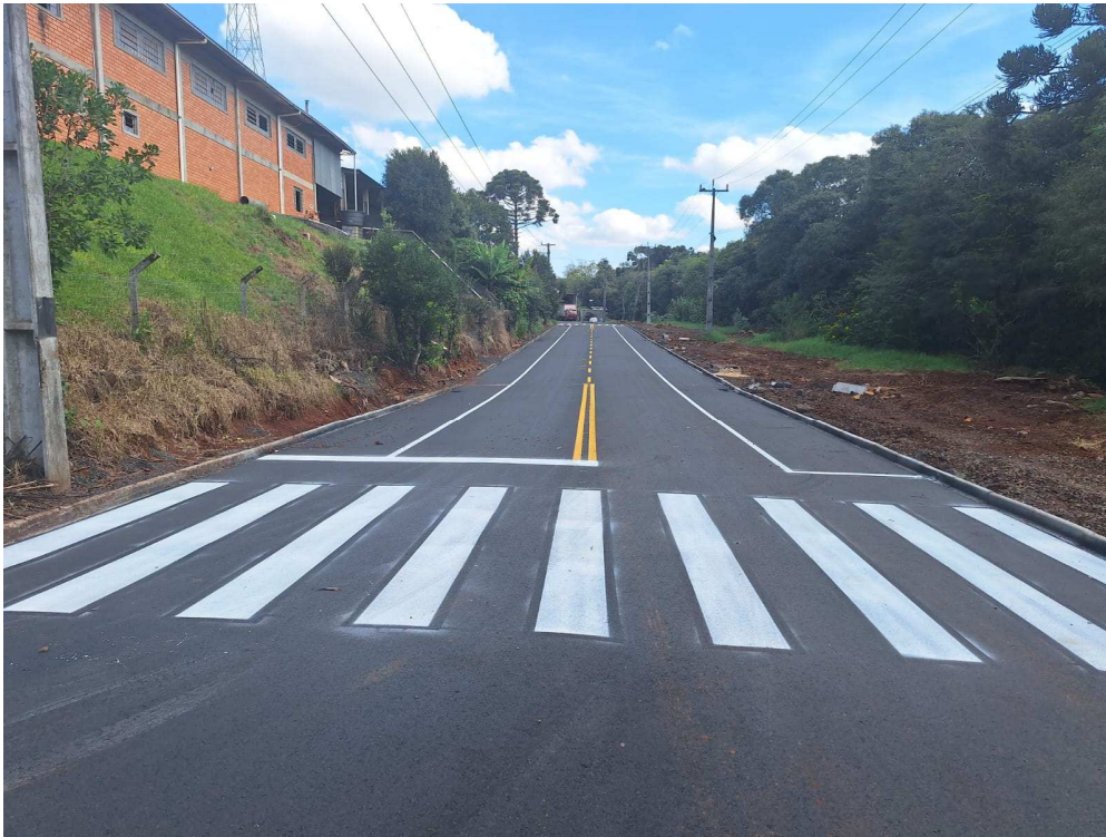
Foto 26: Sinalização Rua Pedro Detoni Trecho 2.
