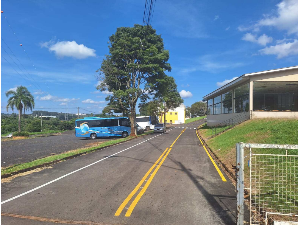
Foto 25: Sinalização Rua C.
