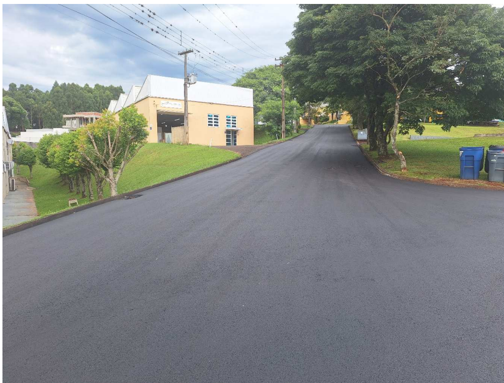
Foto 17: Pavimentação Rua B.
