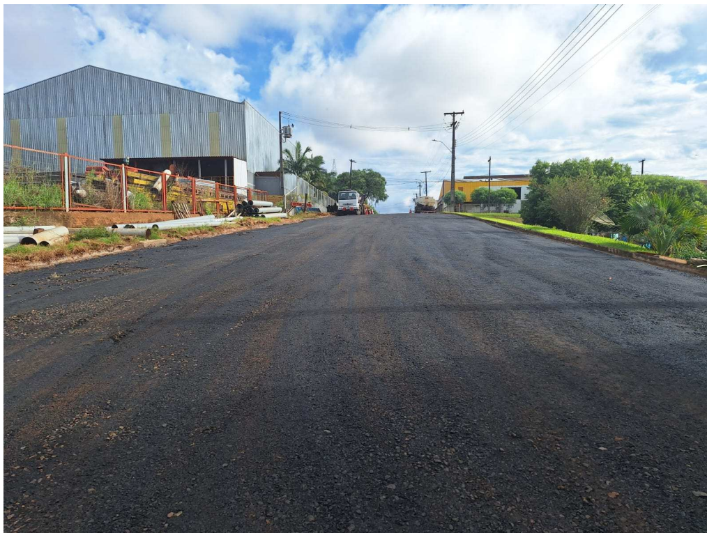
Foto 05: Reperfilagem Rua Ulisses Viganó.
