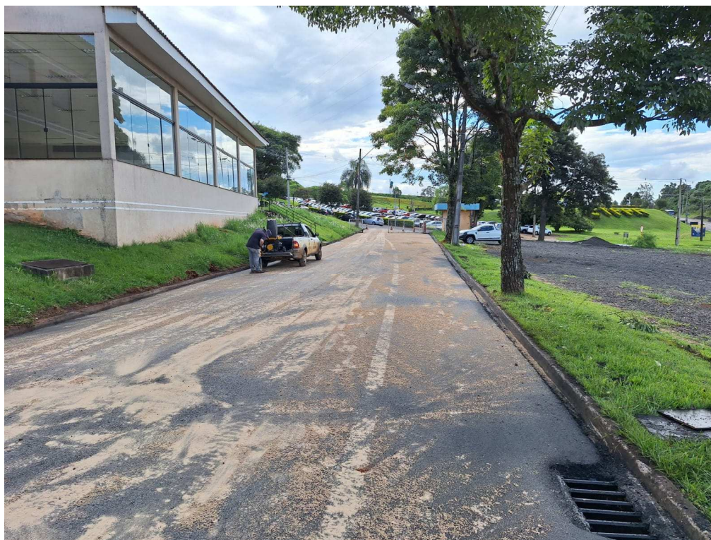
Foto 20: Extração de Corpo de Prova Rua C.
