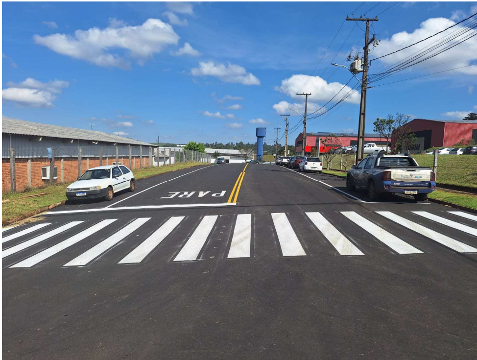
Foto 21: Sinalização Travessa Ademar Cantu.
