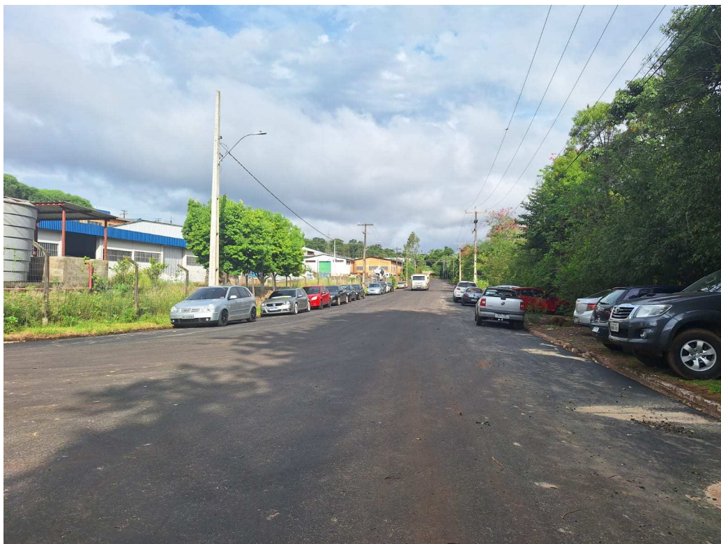
Foto 06: Execução de CBUQ Rua Getúlio Dal Pasquale Trecho 1.
