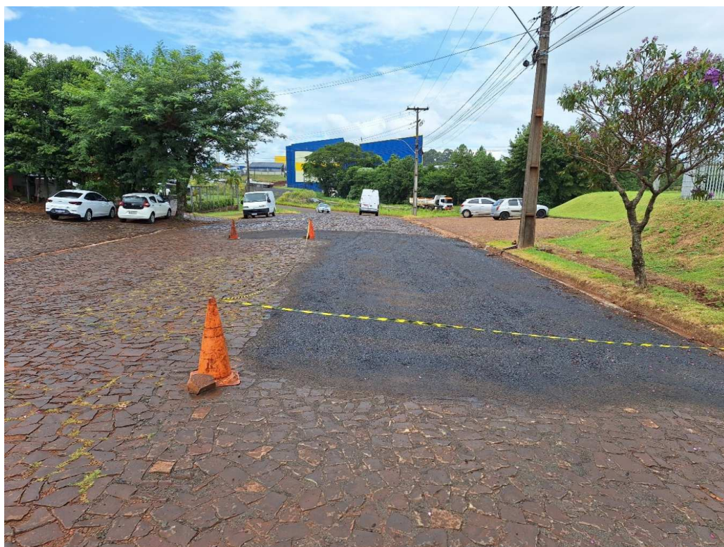
Foto 04: Imprimação Rua Pioneiro Avelino A. Chioquetta.
