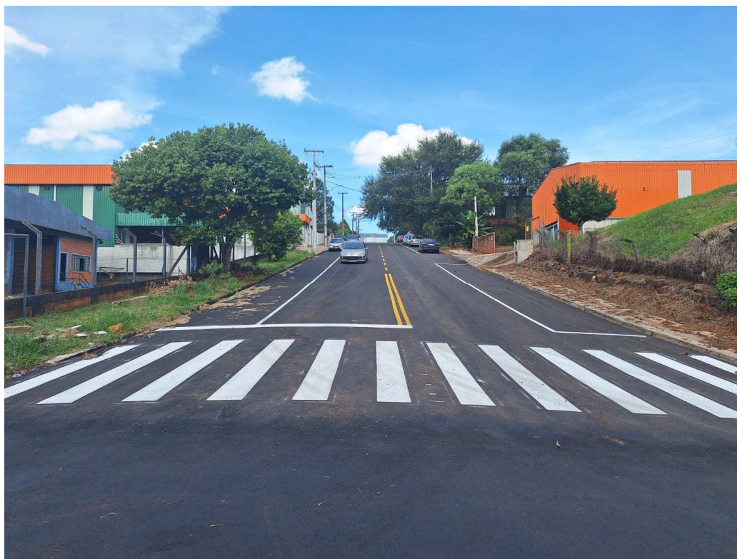
Foto 30: Sinalização Rua Pedro Detoni Trecho 1.
