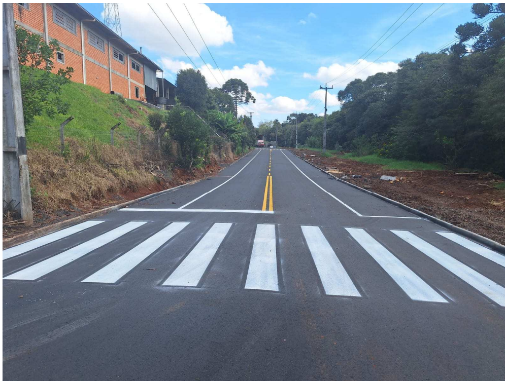
Foto 26: Sinalização Rua Pedro Detoni Trecho 2.
