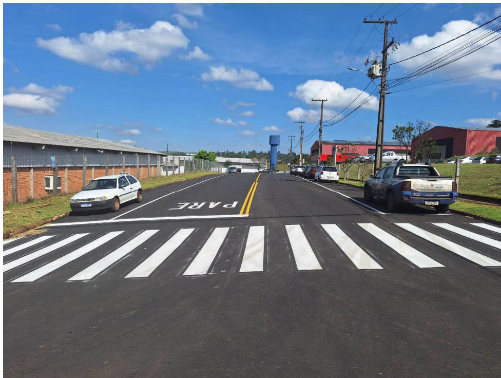
Foto 21: Sinalização Travessa Ademar Cantu.
