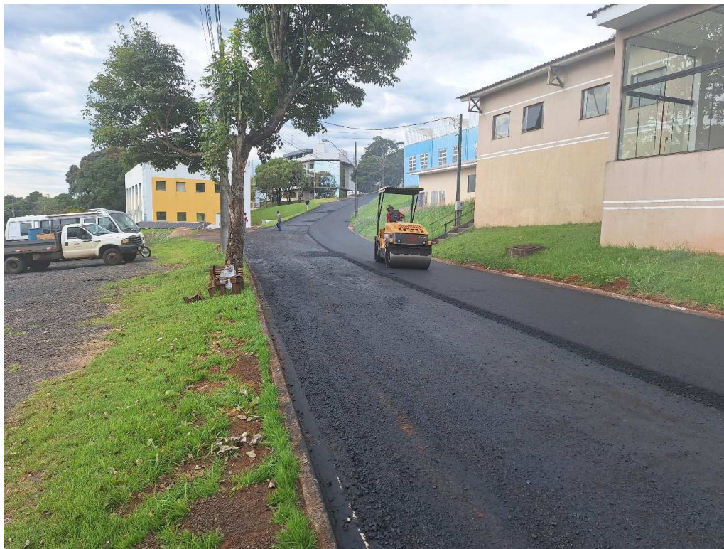
Foto 15: Execução CBUQ Rua C.
