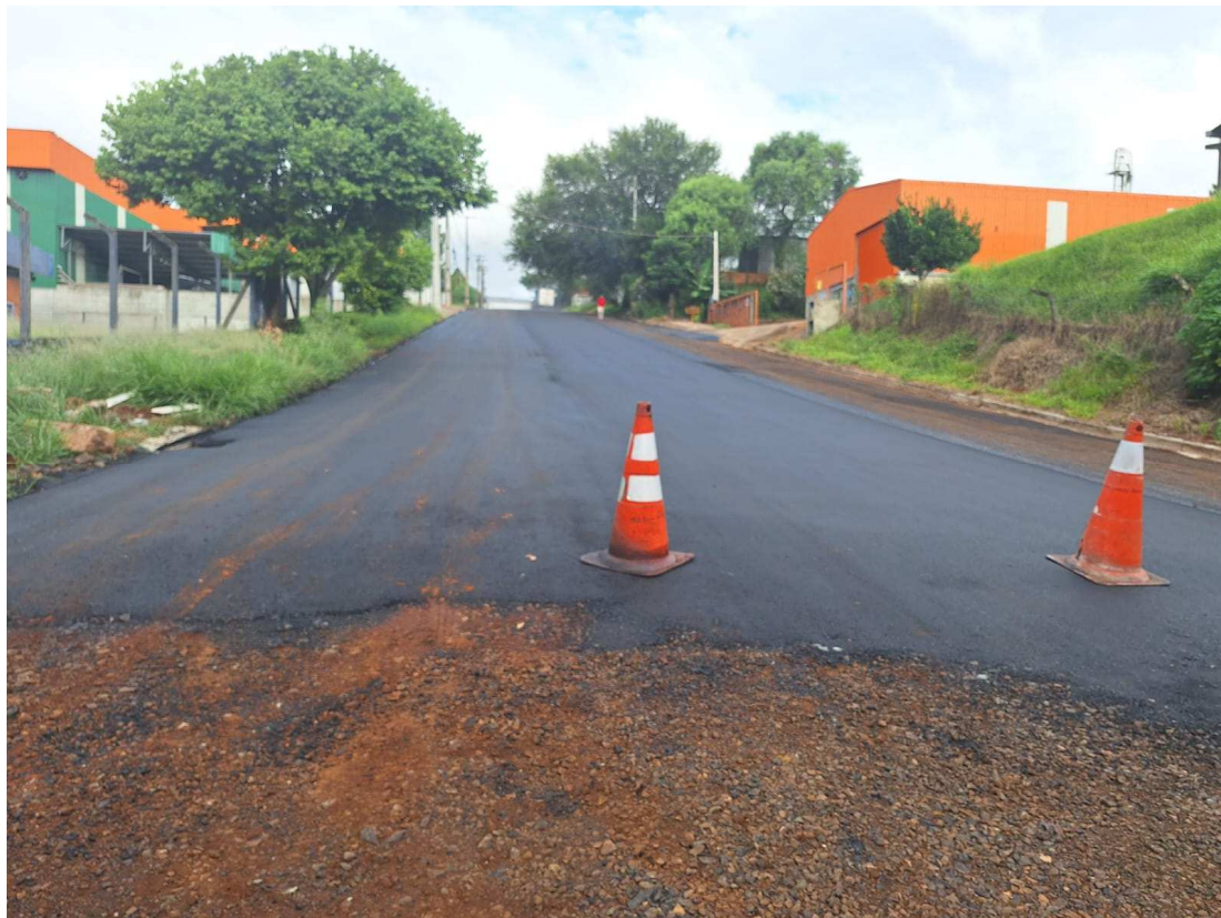
Foto 04: Execução de CBUQ Rua Pedro Detoni Trecho 1.
