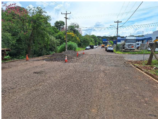
Foto 01: Reforço de Base Rua Getúlio Dal Pasquale Trecho 1.
