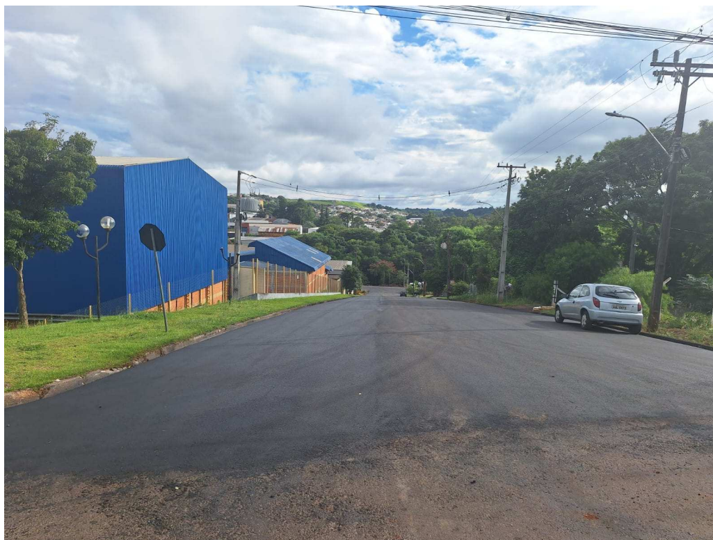
Foto 08: Execução de CBUQ Rua Ulisses Viganó.
