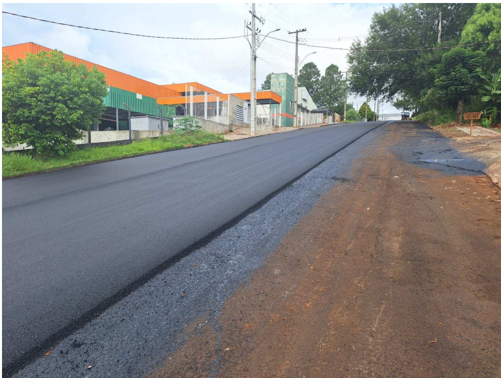
Foto 09: Execução de CBUQ Rua Pedro Detoni Trecho 1.
