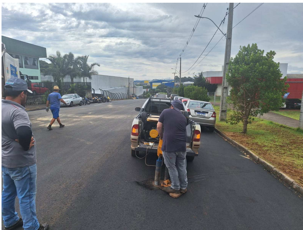
Foto 18: Extração de Corpo de Prova Rua Pioneiro A. A. Chioquetta.
