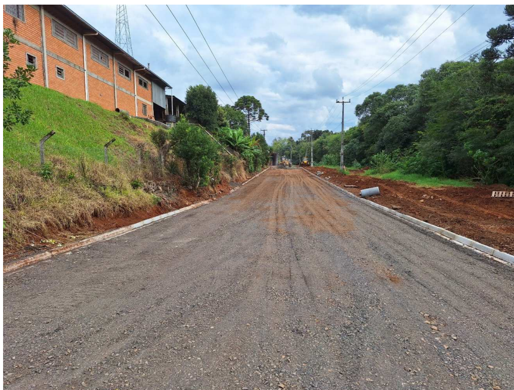
Foto 10: Execução de Base Rua Pedro Detoni Trecho 2.
