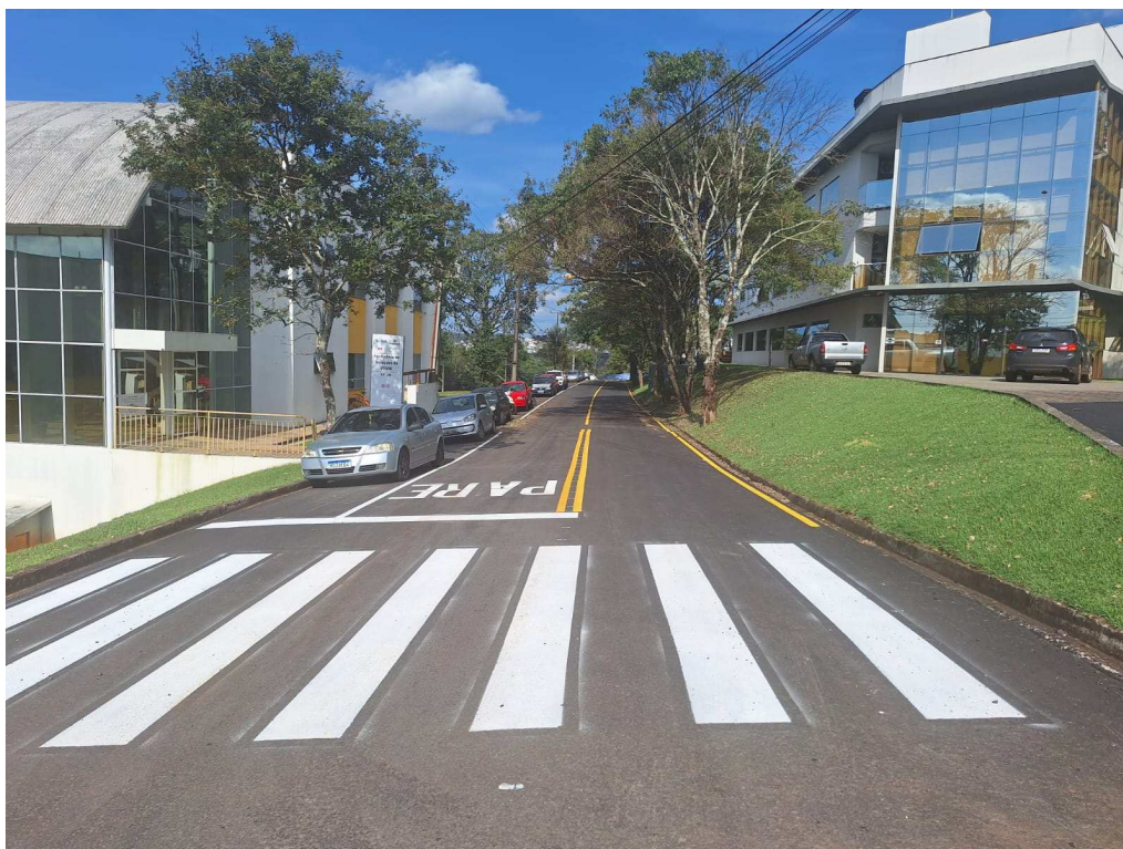
Foto 23: Sinalização Rua A.
