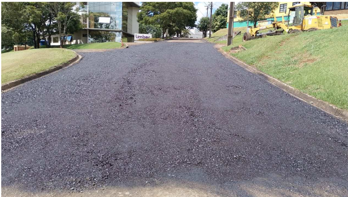
Foto 09: Imprimação Rua C.
