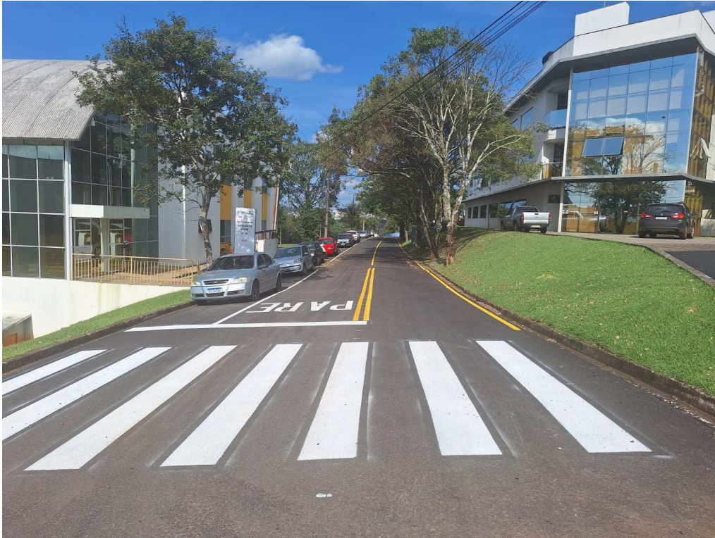
Foto 23: Sinalização Rua A.
