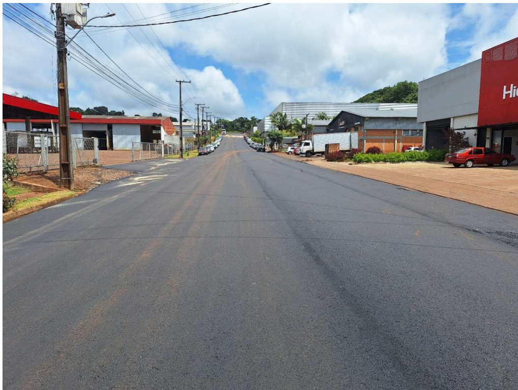
Foto 11: Pavimento Rua Pioneiro Avelino A. Chioquetta.
