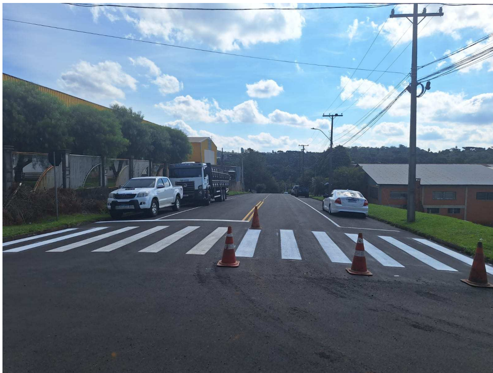
Foto 27: Sinalização Rua Pedro Detoni Trecho 1.
