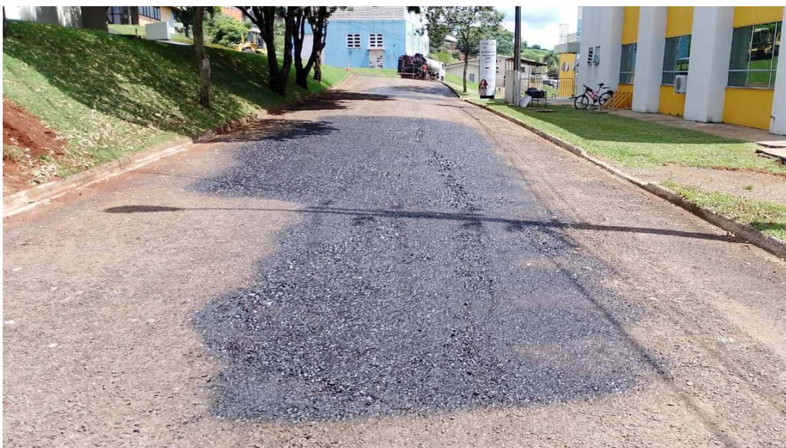
Foto 10: Imprimação Rua A.
