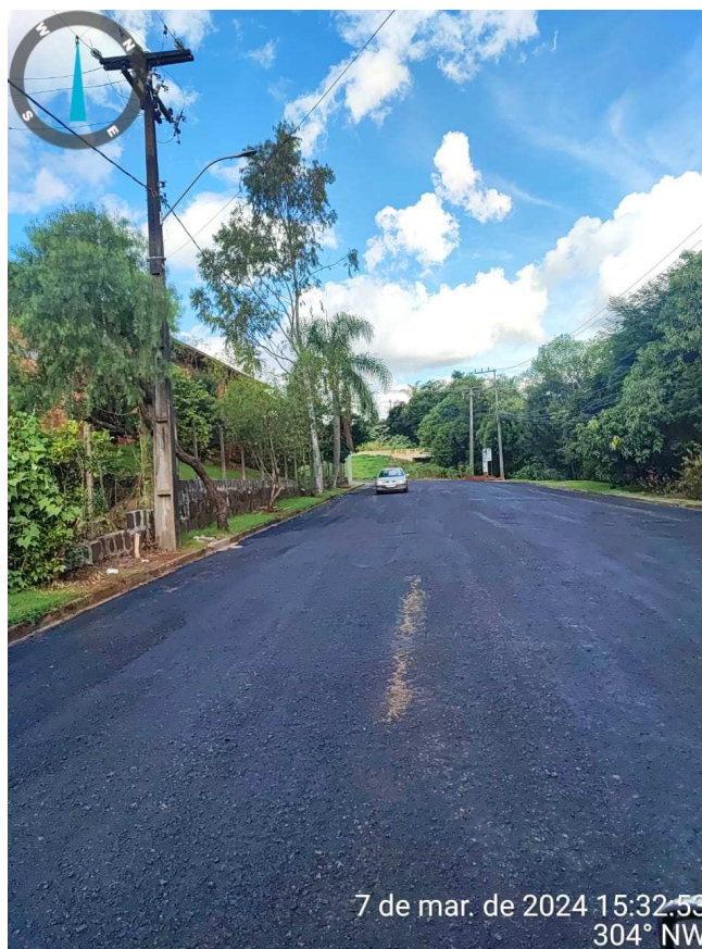
Foto 02: Reperfilagem Rua Getúlio Dal Pasquale Trecho 1.
