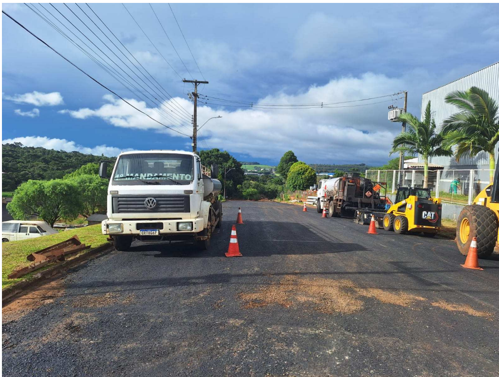
Foto 07: Reperfilagem Rua Ulisses Viganó.
