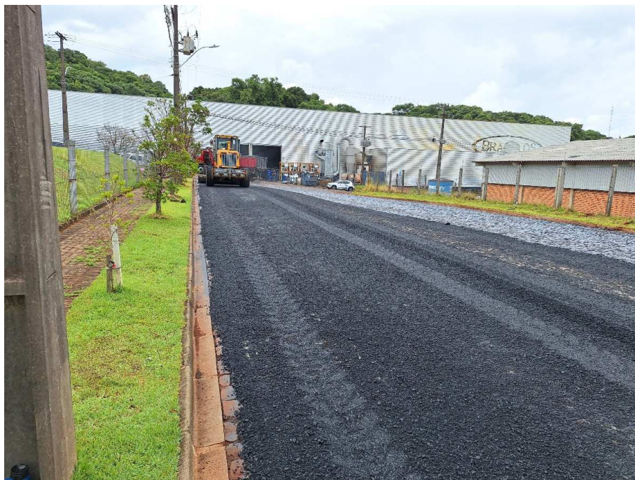
Foto 02: Pintura de Ligação e Reperfilagem Travessa Ademar Cantu.
