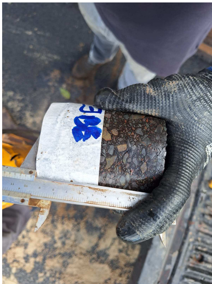
Foto 21: Extração de Corpo de Prova Rua C.
