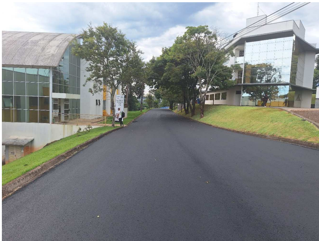
Foto 16: Pavimentação Rua A.
