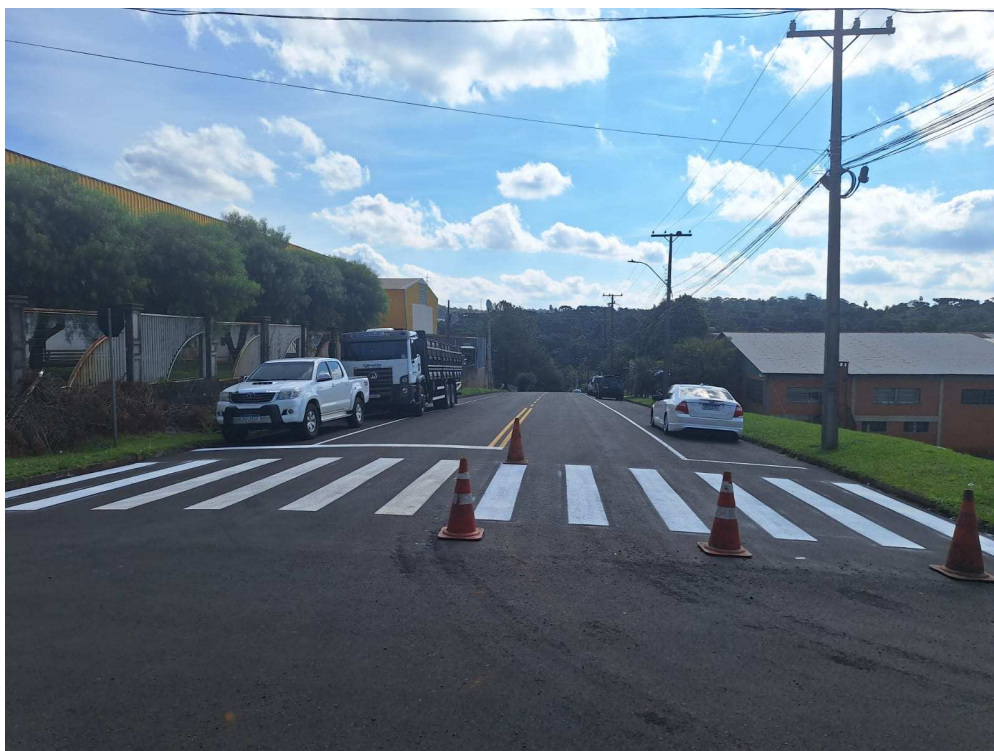
Foto 27: Sinalização Rua Pedro Detoni Trecho 1.
