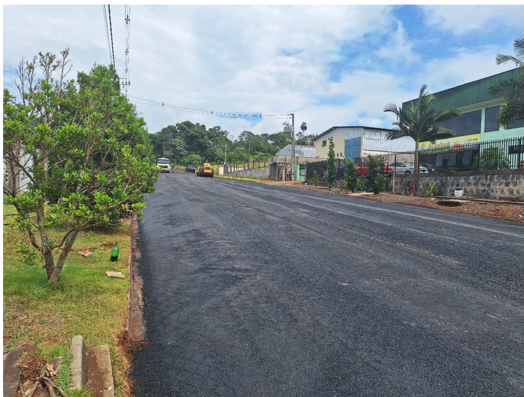
Foto 06: Reperfilagem Rua Pioneiro Avelino A. Chioquetta.
