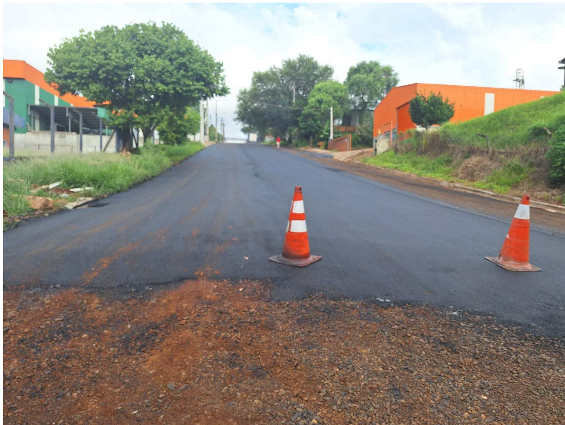
Foto 04: Execução de CBUQ Rua Pedro Detoni Trecho 1.
