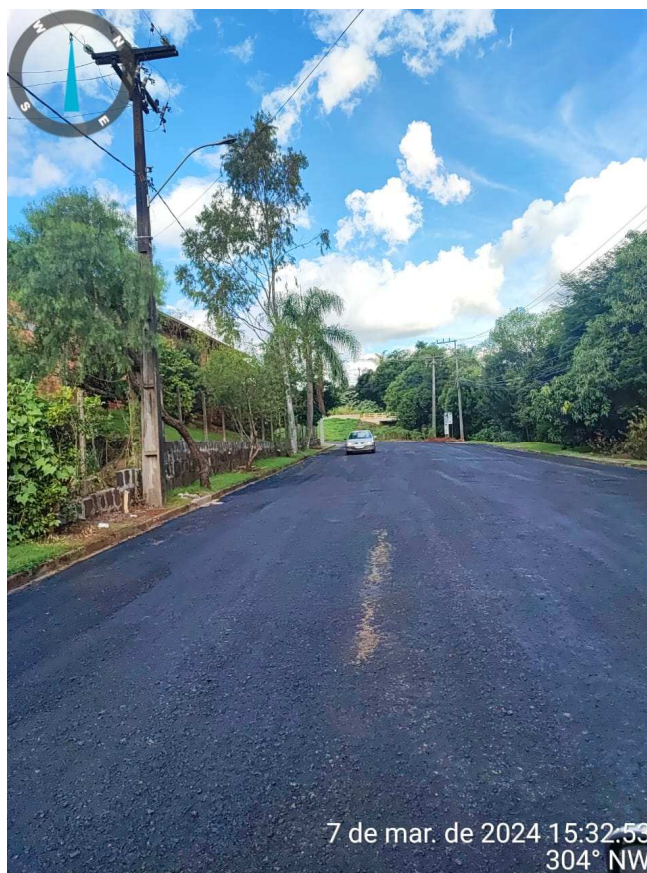
Foto 02: Reperfilagem Rua Getúlio Dal Pasquale Trecho 1.
