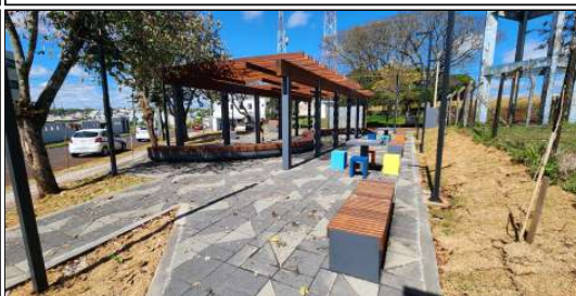
11 | banco de concreto, piso permeável, grama, pergolado
