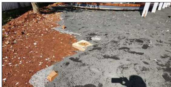
4 | base para piso permeável, instalações elétricas
