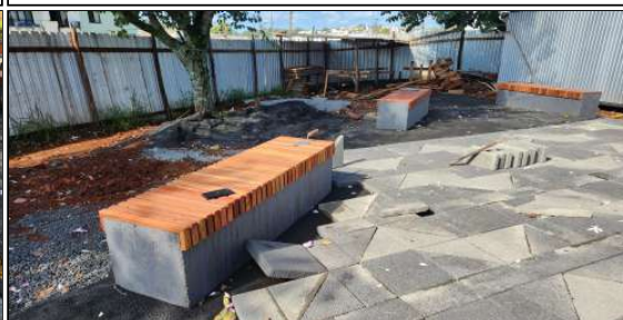
7 | piso permeável, bancos de concreto, instalações elétricas
