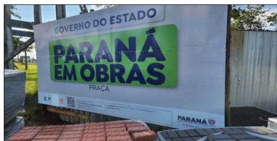
1 | Placa de obra
