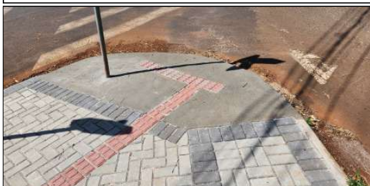
8 | rampa de acessibilidade
