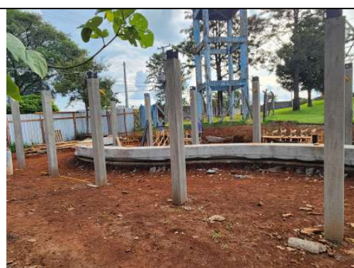
F9: BANCO EM FORMATO DE S, ESTRUTURA DO PERGOLADO
