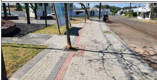
6 | Execução de paver, plantio de grama
