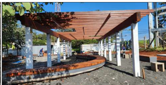
5 | banco de concreto, pergolado, instalações elétricas
