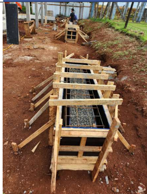
F7: MONTAGEM DOS BANCOS DE CONCRETO
