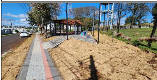
10 | Execução de paver, plantio de grama e arvores
