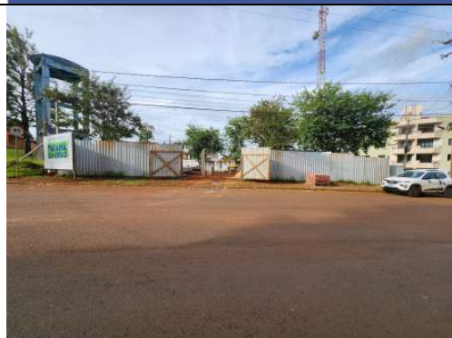
F11: PLACA DE OBRA, TAPUME
