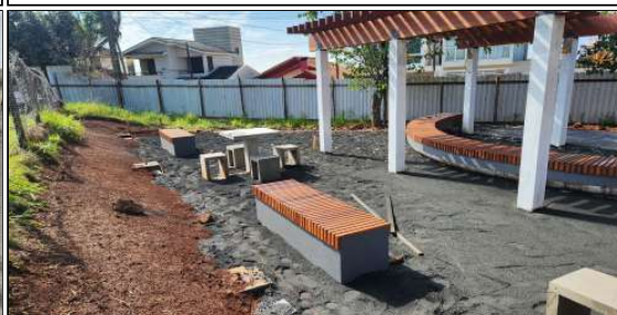
15 | bancos e mesa de concreto, pergolado, piso permeável, instalações elétricas
