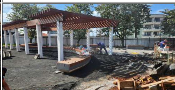
11 | bancos de concreto, pergolado, piso permeável, instalações elétricas
