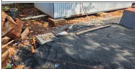
8 | base para piso permeável, instalações elétricas
