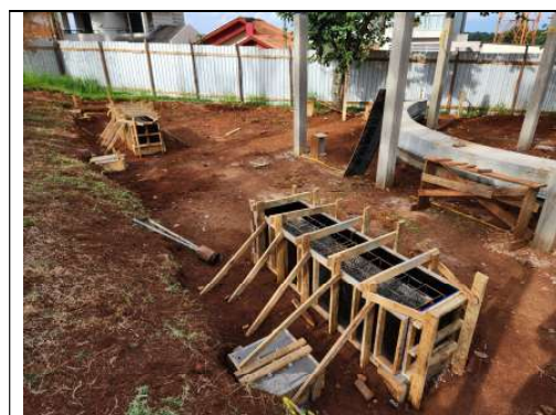
F6: MONTAGEM DOS BANCOS DE CONCRETO
