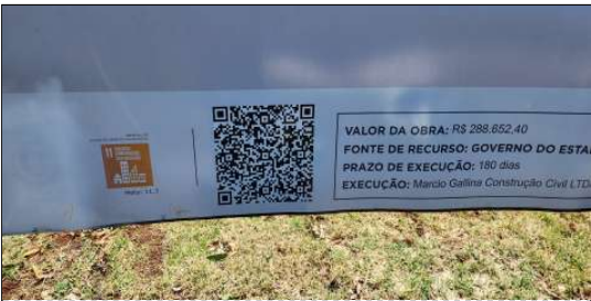
3 | Detalhe da placa de obra
