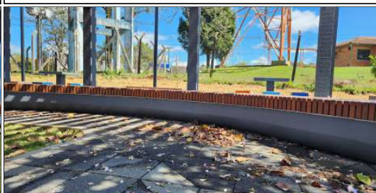
15 | instalações elétricas no banco
