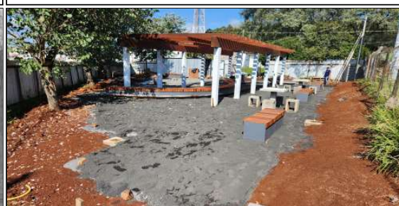
3 | bancos e mesa de concreto, pergolado, piso permeável, instalações elétricas
