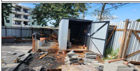
18 | container, mureta do bebedouro, sumidouro
