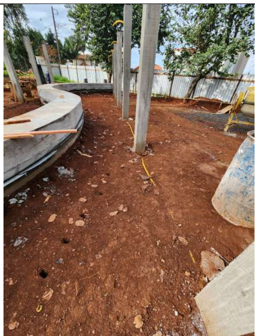
F13: ELETRODUTOS PARA INSTALAÇÕES ELÉTRICAS
