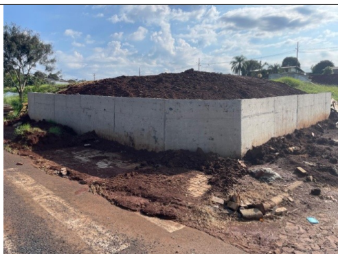
F1-MURO DE CONTEÇÃO
