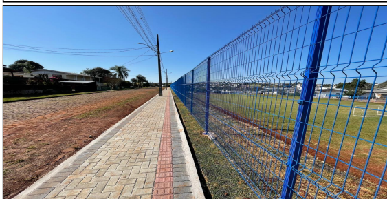
7 | ALAMBRADO E CALÇADA
