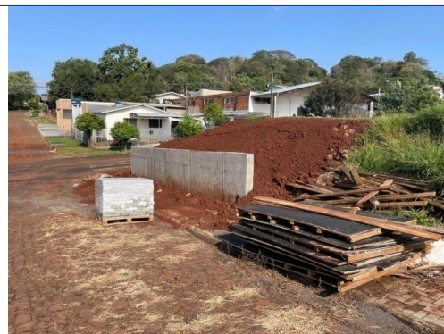
F2- MURO DE CONTEÇÃO
