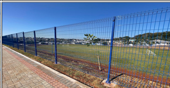
8 | ALAMBRADO E ARVORES
