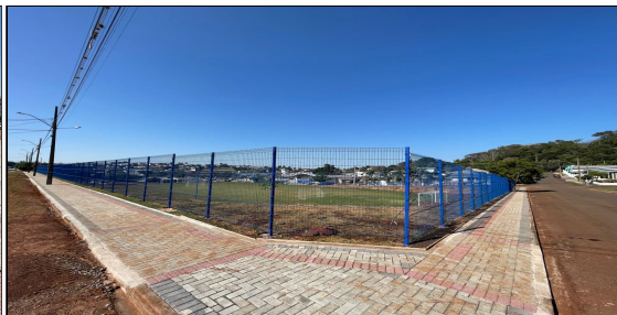
6 | ALAMBRADO E CALÇADA
