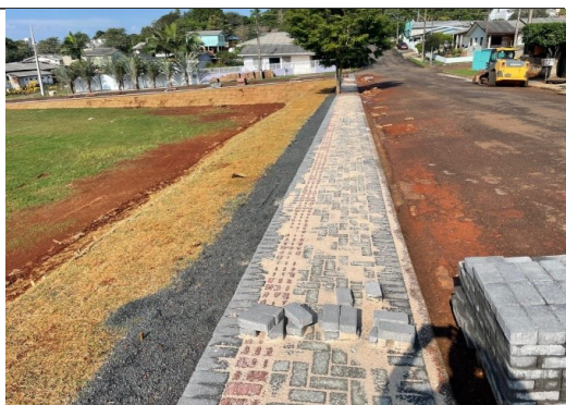
F5-DETALHE DA CALÇADA
