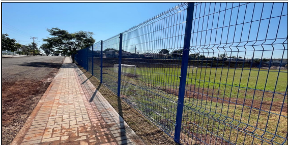
4 | ALAMBRADO E CALÇADA
