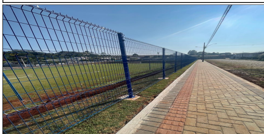
5 | ALAMBRADO E CALÇADA
