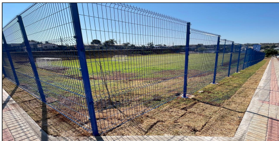
5 | ALAMBRADO E CALÇADA
