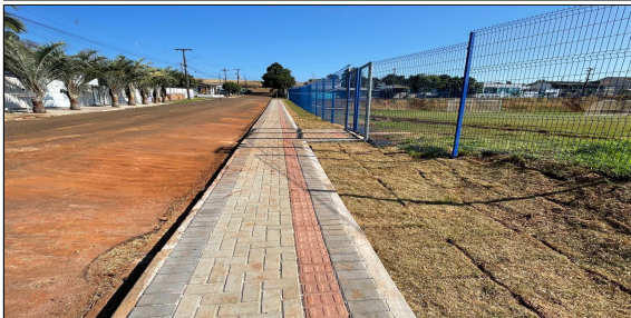
3 | ALAMBRADO E CALÇADA
