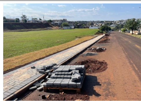
F4- DETALHE DA CALÇADA
