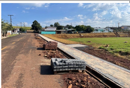
F3- DETALHE DA CALÇADA
