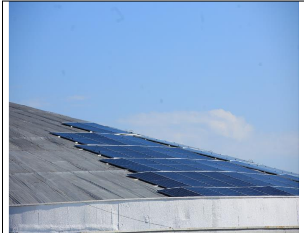
INICIO COLOCAÇÃO DE PAINEL SOLAR (GINASIO DOLIVAR LAVARDA)
