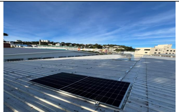
INICIO DA INSTALAÇÃO DE PAINEL SOLAR (ESCOLA ROCHA POMBO)
