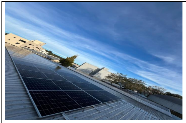
PAINEL INSTALADO FINAL OBRA (ESCOLA ROCHA POMBO)
