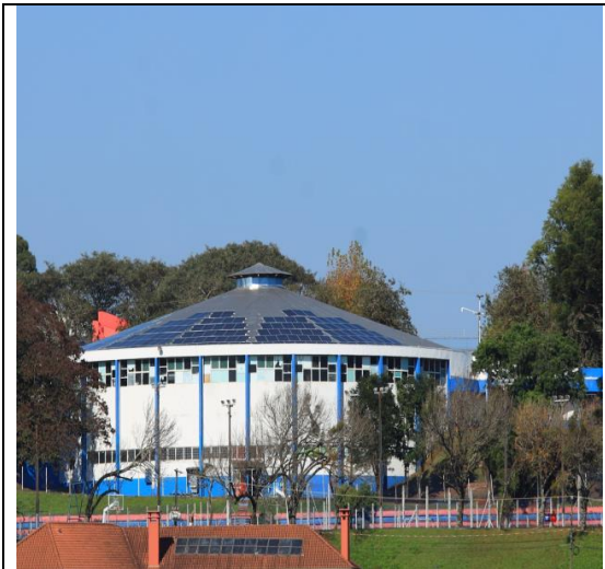
TERMINO INSTALAÇÃO DE PAINEL SOLAR (GINASIO DOLIVAR LAVARDA)
