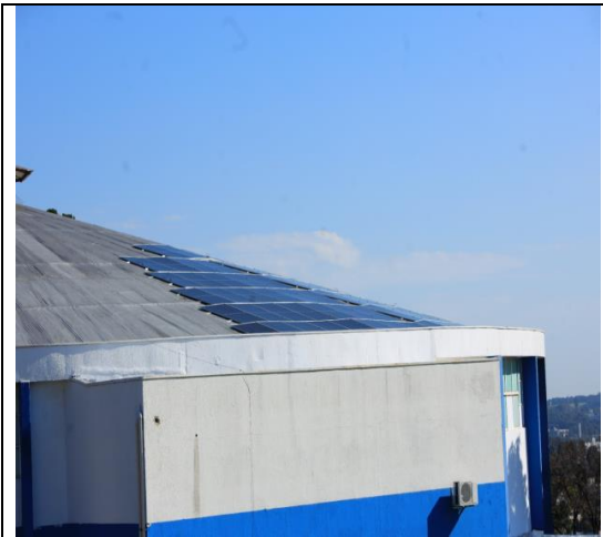
INSTALAÇÃO DE PAINEL SOLAR (GINASIO DOLIVAR LAVARDA)
