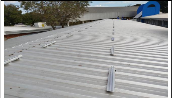
INICIO COLOCAÇÃO DE PERFIL (ESCOLA ROCHA POMBO)
