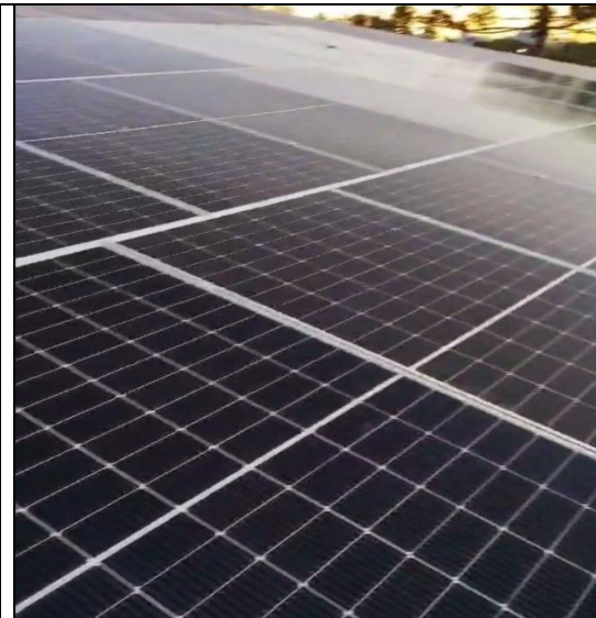
PAINEL SOLAR INSTALADOS (GINASIO DOLIVAR LAVARDA)
