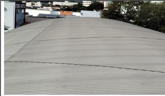
TELHADO LIMPO PARA COLOCAÇÃO DE PLACAS(ESCOLA ROCHA POMBO)
