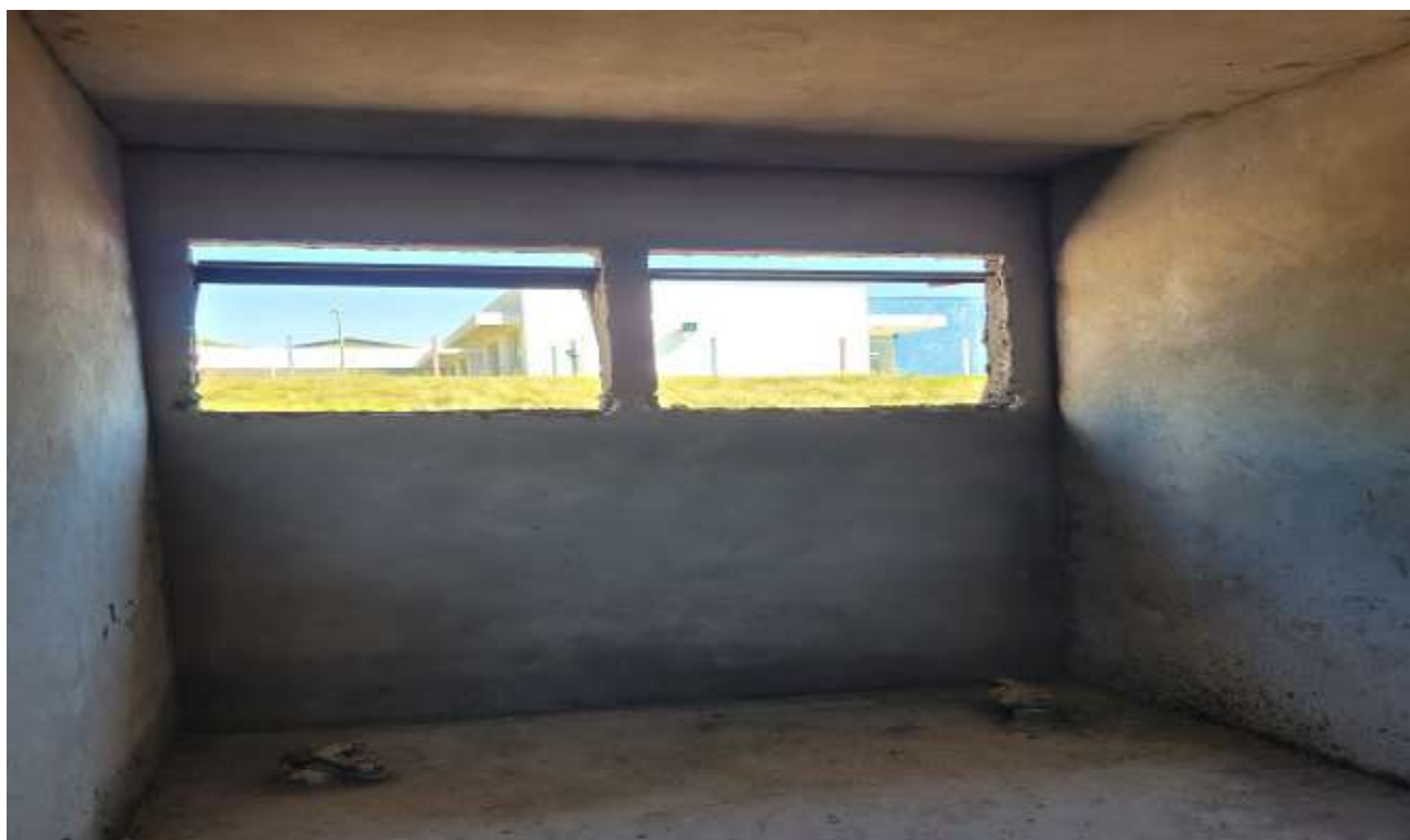
Foto 4: Reboco e Piso Interno.
