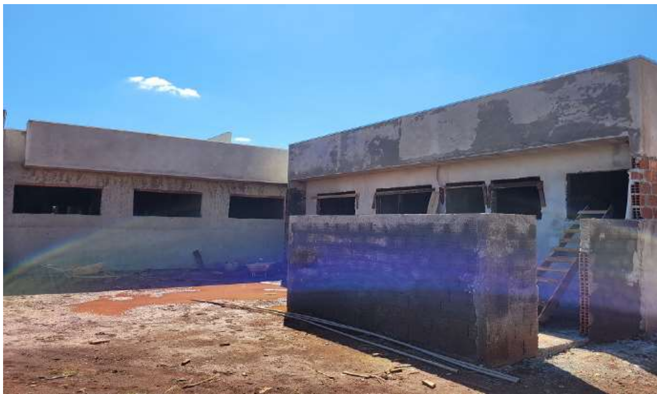
Foto 3: Lateral Direita (reboco externo, platibandas).
