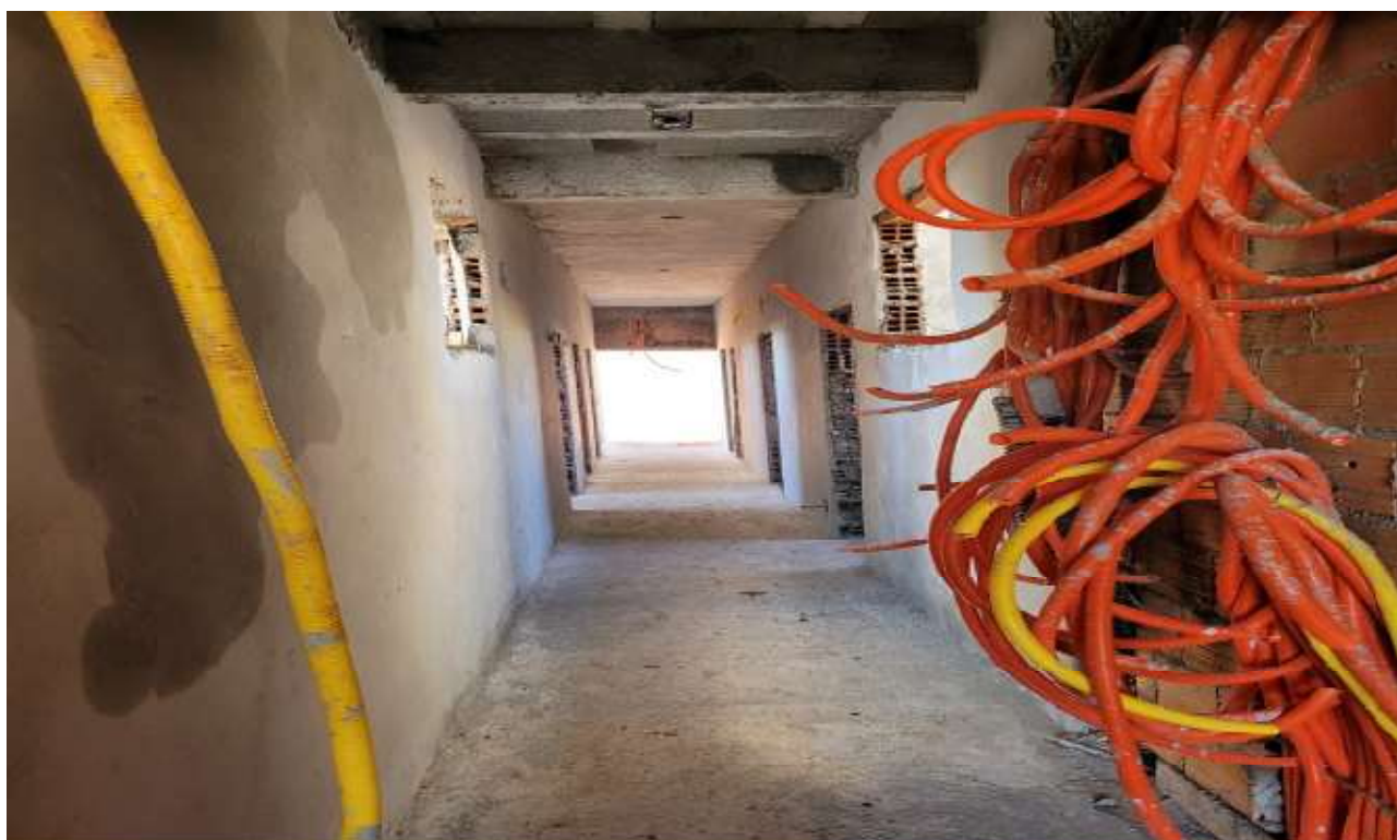
Foto 6: Instalações elétricas (eletrodutos).
