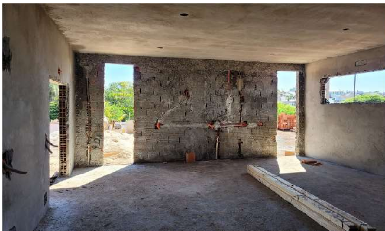
Foto 2: Instalações Elétricas; Revestimento de piso interno.
