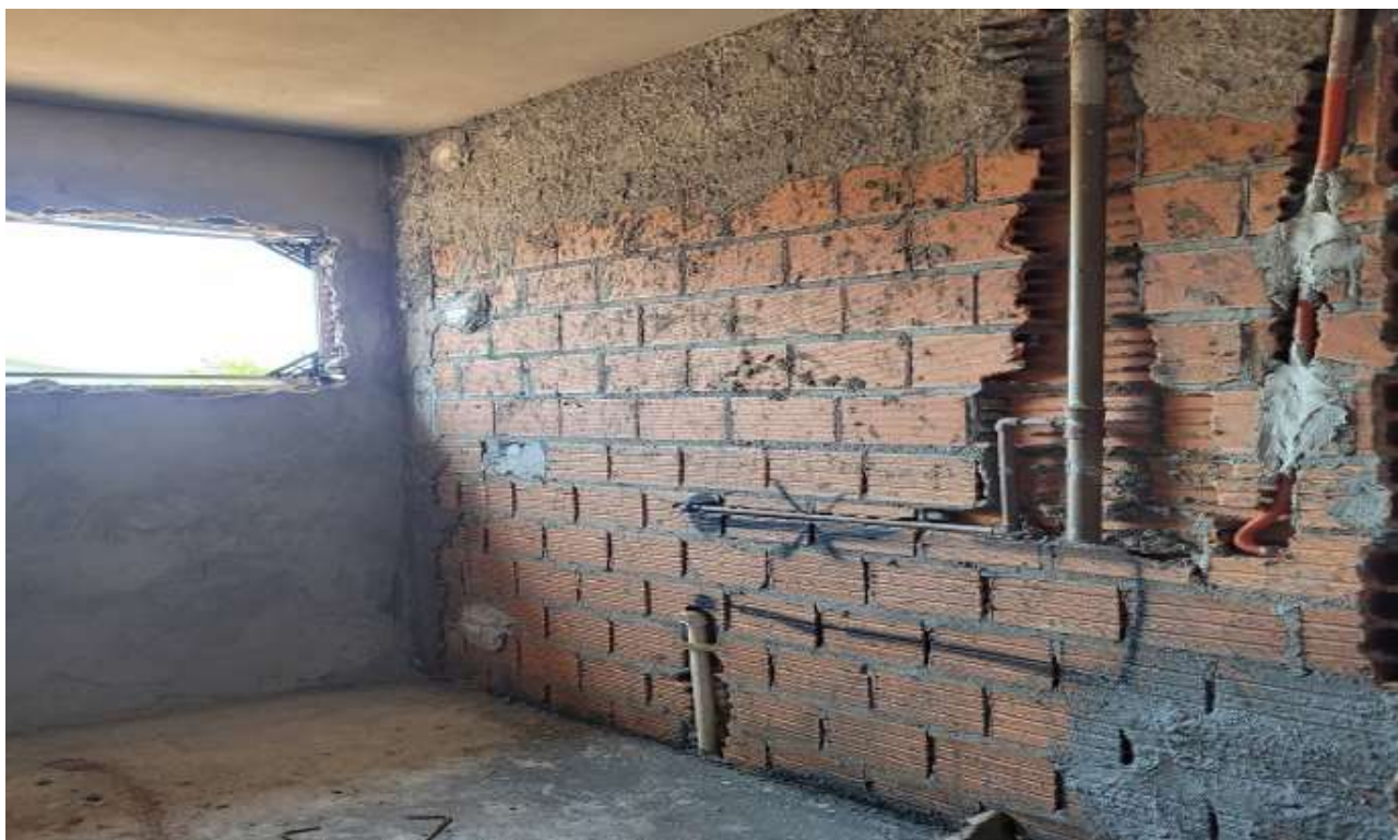
Foto 7: Instalações hidrossanitárias.
