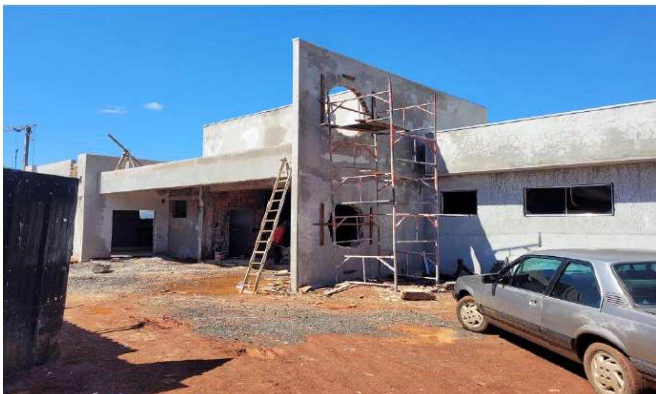
Foto 1: fachada da Obra (execução de reboco, colocação de contra-marcos nas aberturas).
