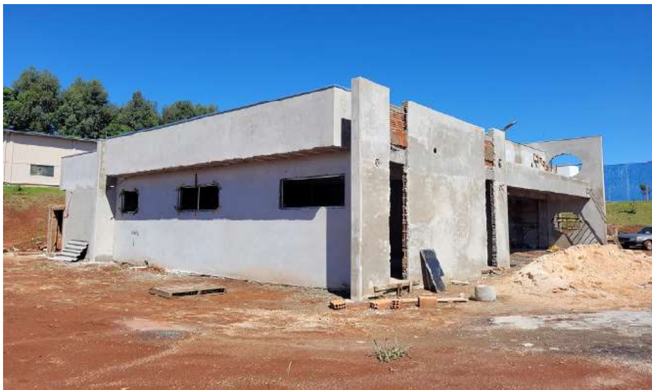
Foto 5: Lateral Esquerda. (platibandas/ Cobertura).
