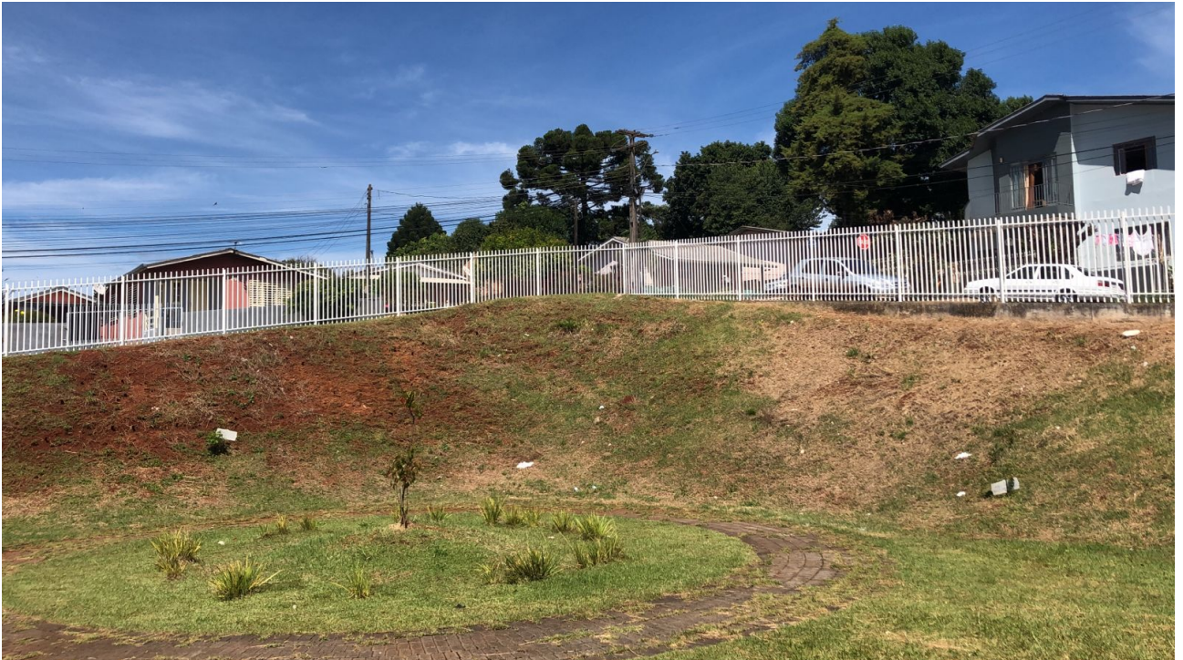
Foto 6: Pintura de Cercamento externo.
