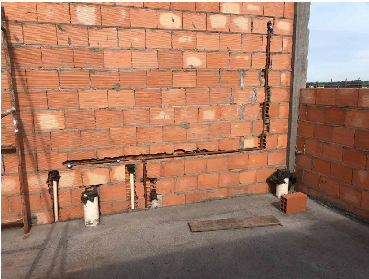
Foto 6: Ligações de água e esgoto..
