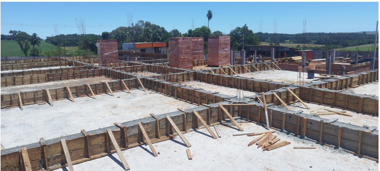
Foto 2: Laje 1 e vigas concretadas.
