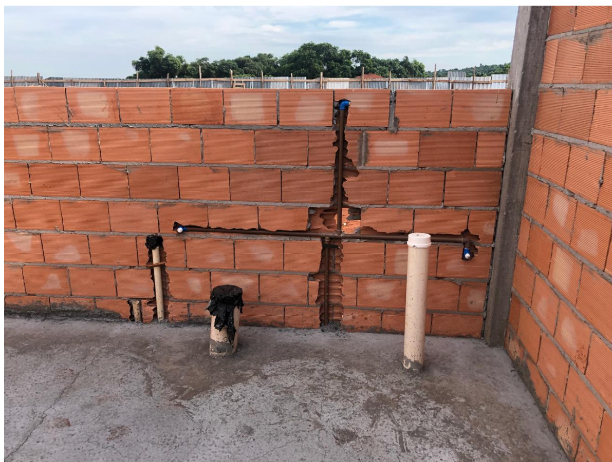
Foto 7: Ligações de Água e Esgoto.
