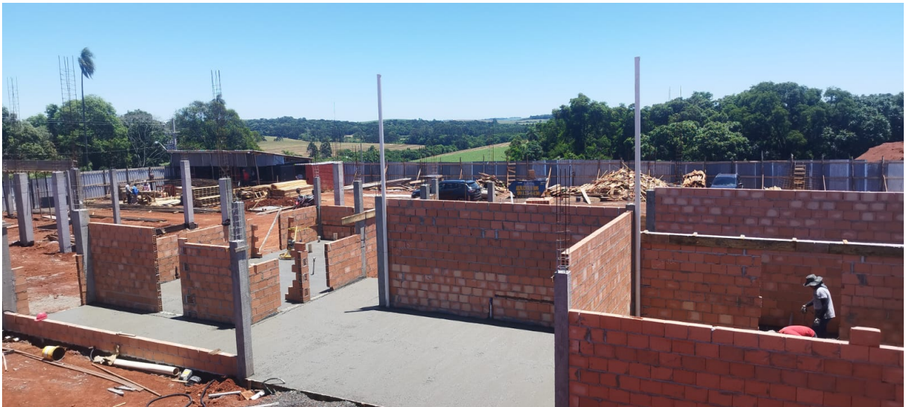
Foto 4: Levantamento de Alvenaria e execução de piso.
