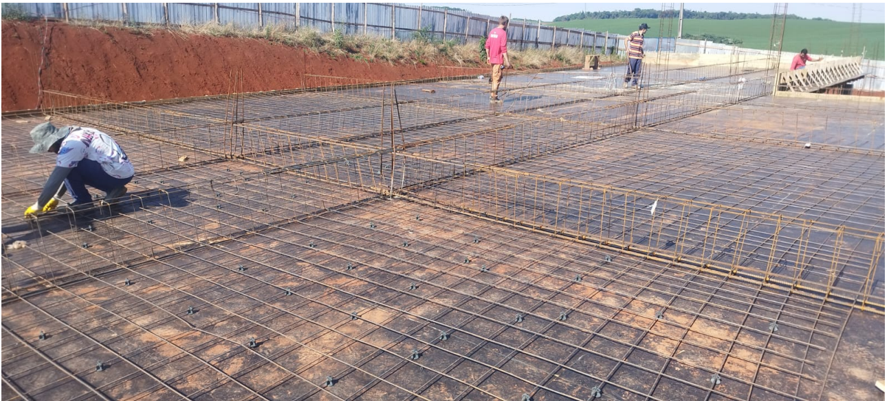
Foto 3: Fôrmas e Armação da laje nº2.
