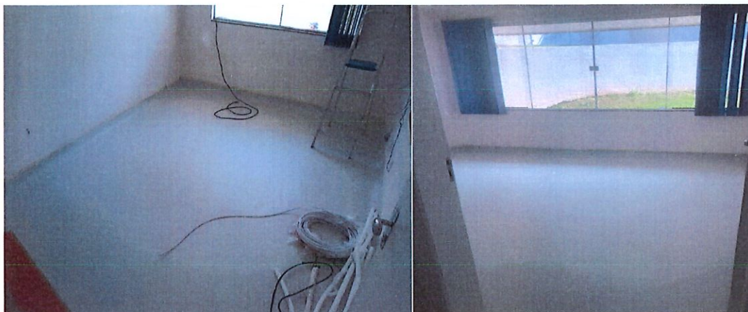
Foto 4: Manta vinílica instalada
