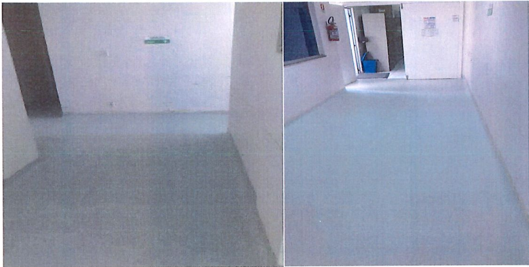
Foto 1: Manta vinílica instalada
