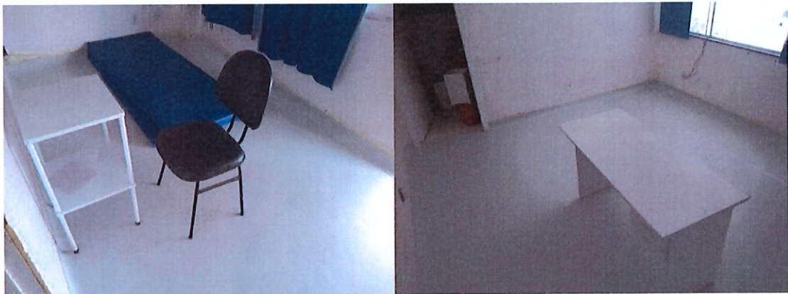
Foto 2: Manta vinílica instalada
