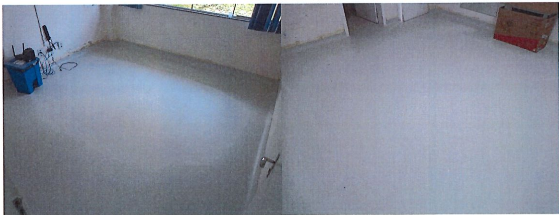
Foto 3: Manta vinílica instalada
