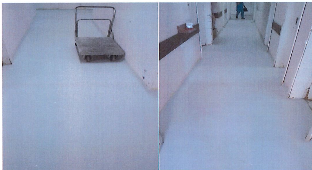
Foto 5: Manta vinílica instalada
