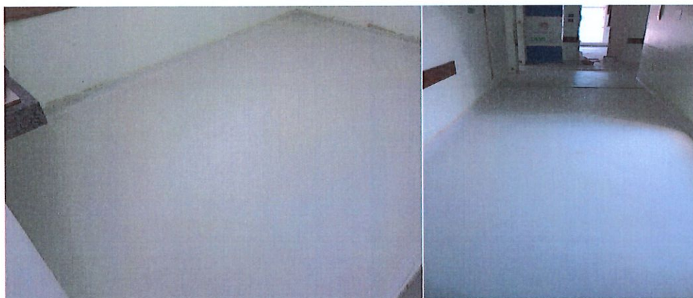
Foto 6: Manta vinílica instalada
