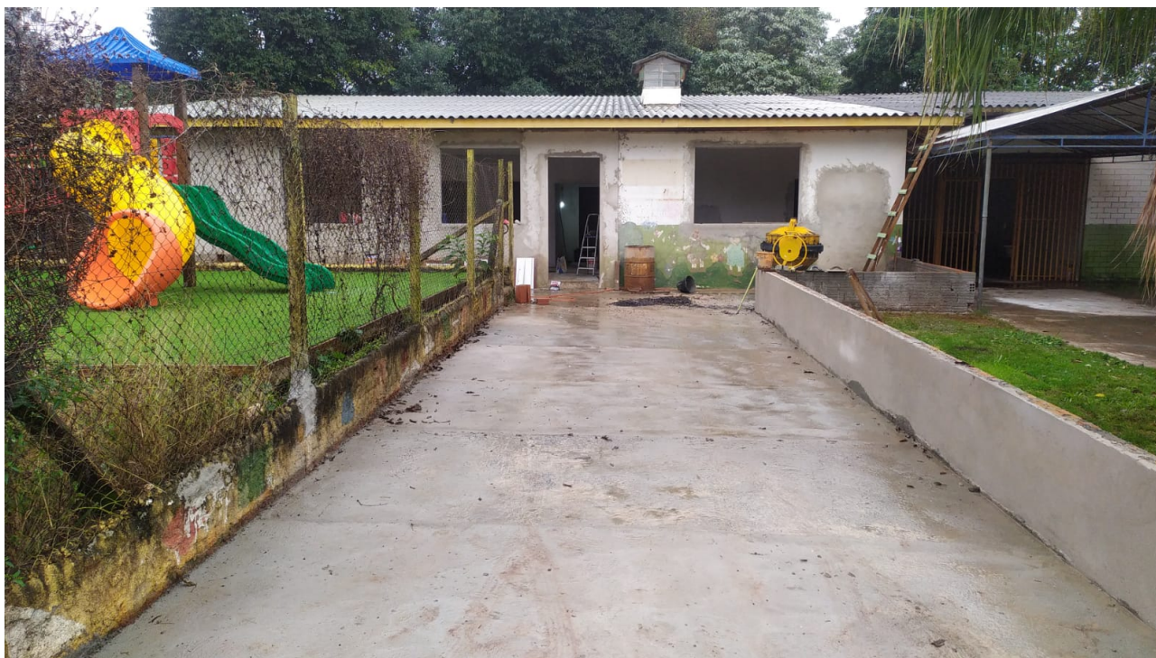
Foto 2: Mureta em concreto/ impermeabilização.
