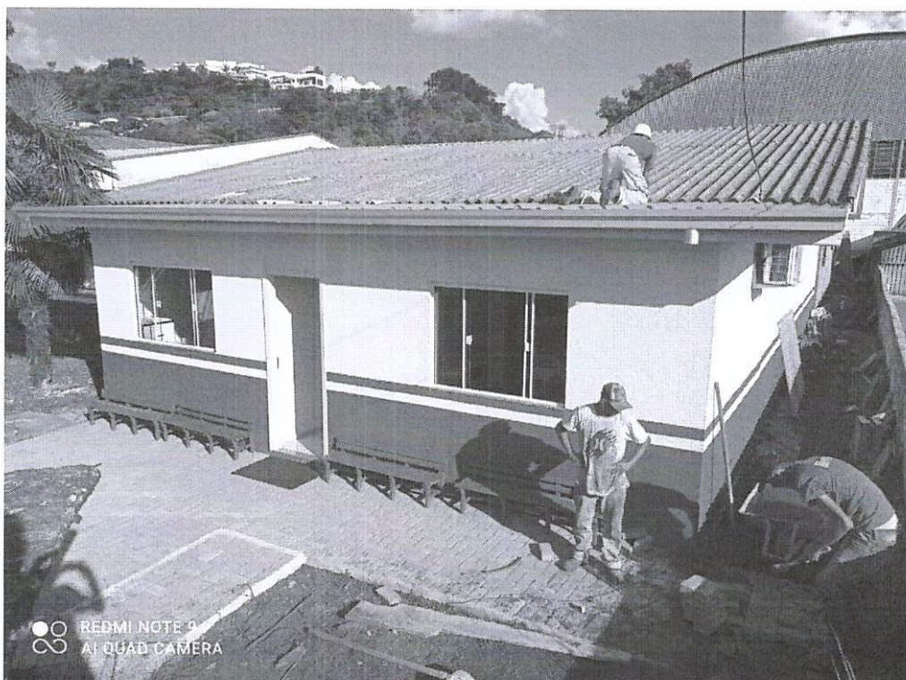
Foto 04: Calhas e telhados
