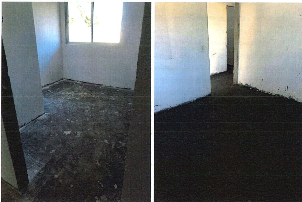
Foto 2: Contrapiso em concreto.
