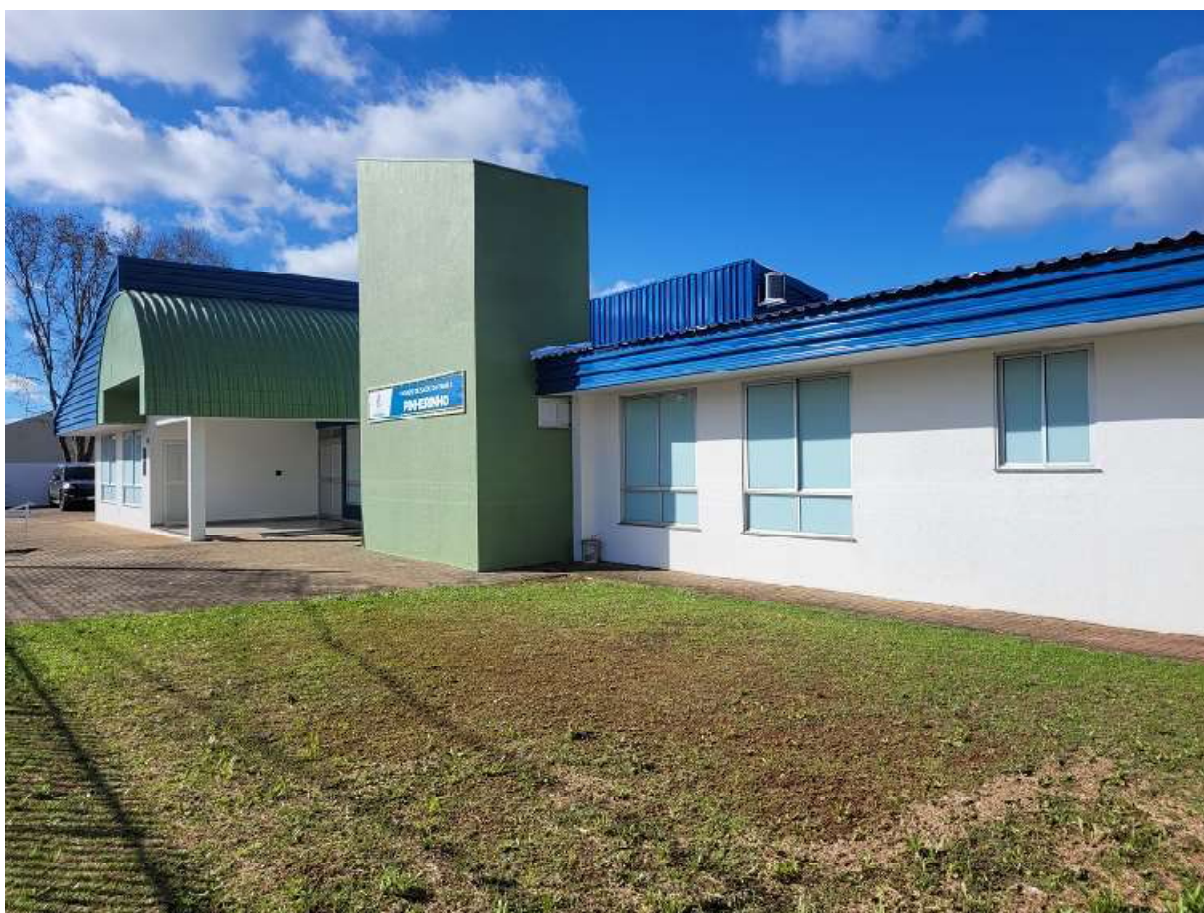
Foto 2: Frente da Obra
