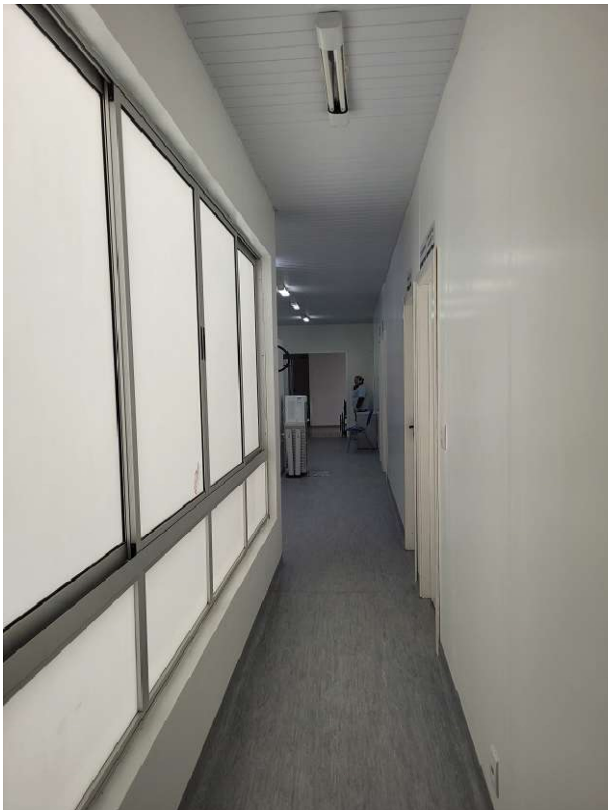
Foto 4: Circulação (manta vinílica).
