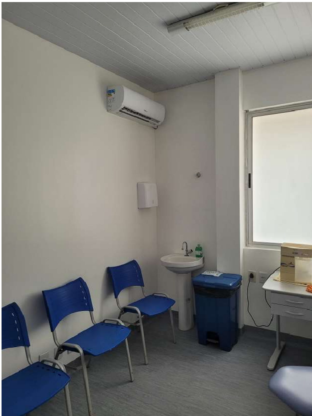
Foto 8: Sala de Sutura / consultório / Ponto de ar condicionado e Pontos de energia e lógica.
