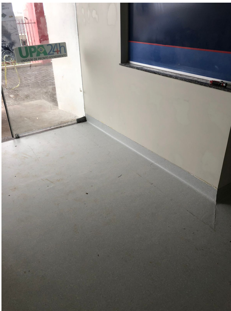
Foto 1: Manta vinílica instalada
