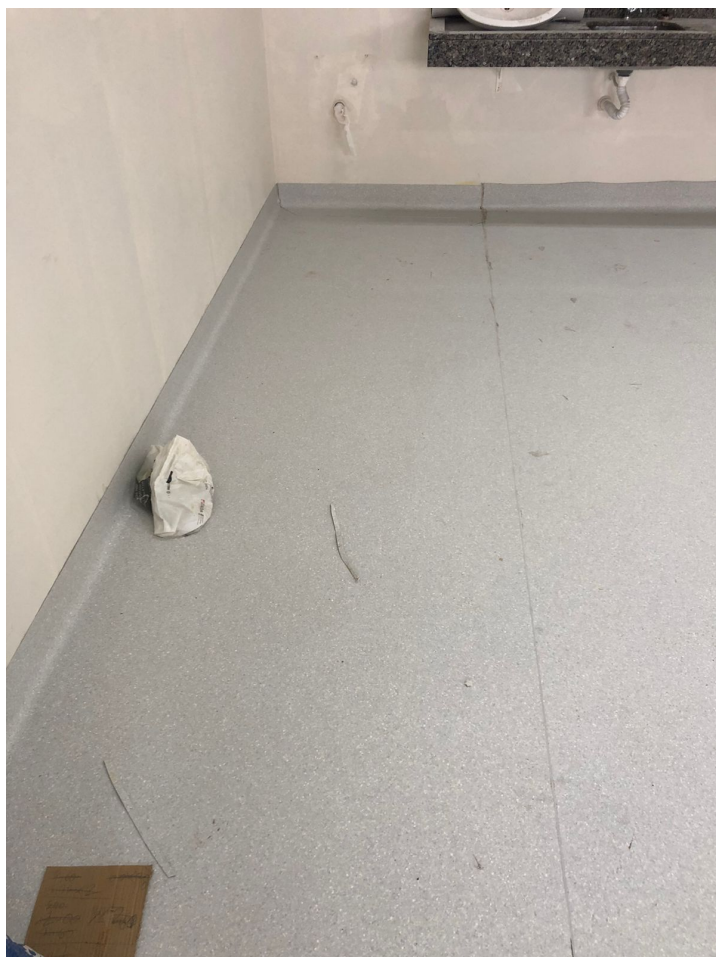
Foto 2: Manta vinílica instalada
