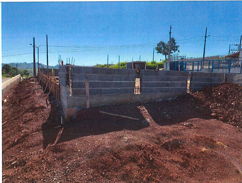
Execução de viga baldrame no entorno do campo
