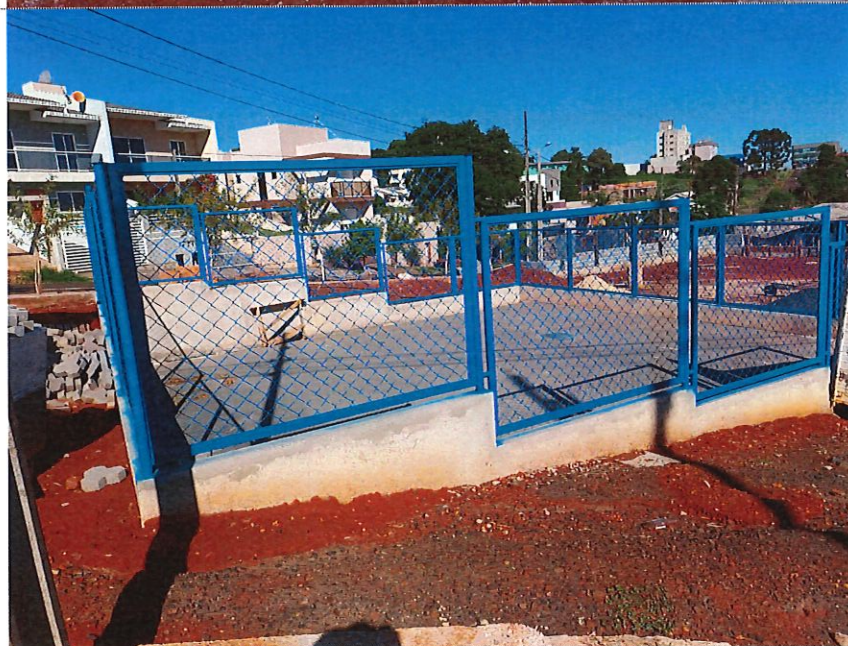
Emboço aplicado na mureta do playground
