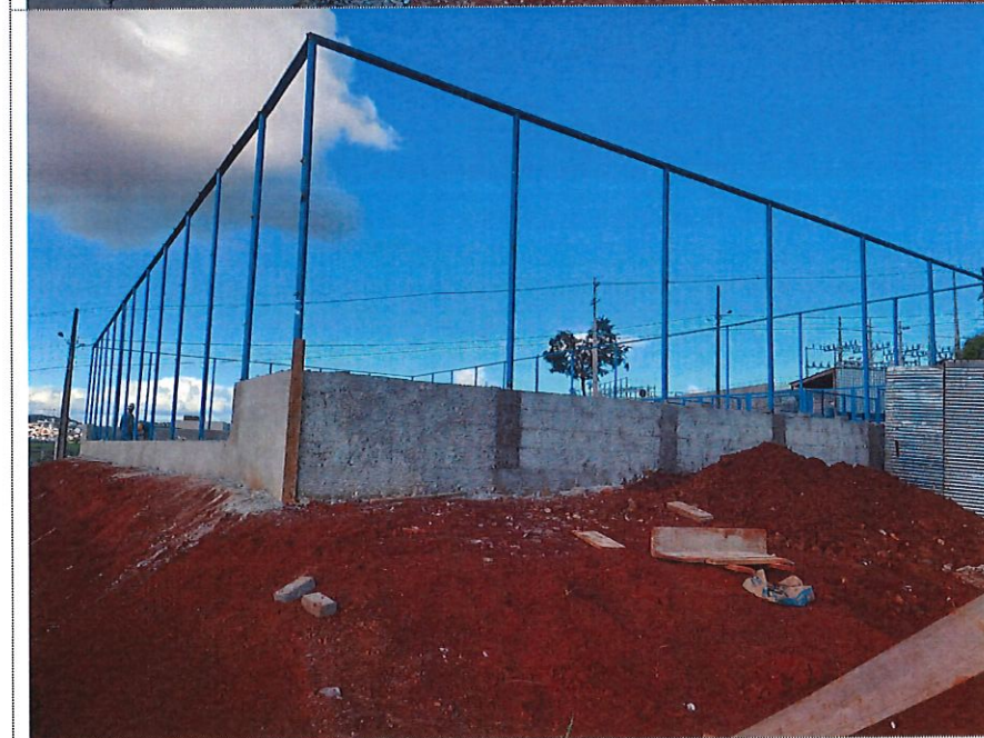
Chapisco aplicado na mureta do campo
