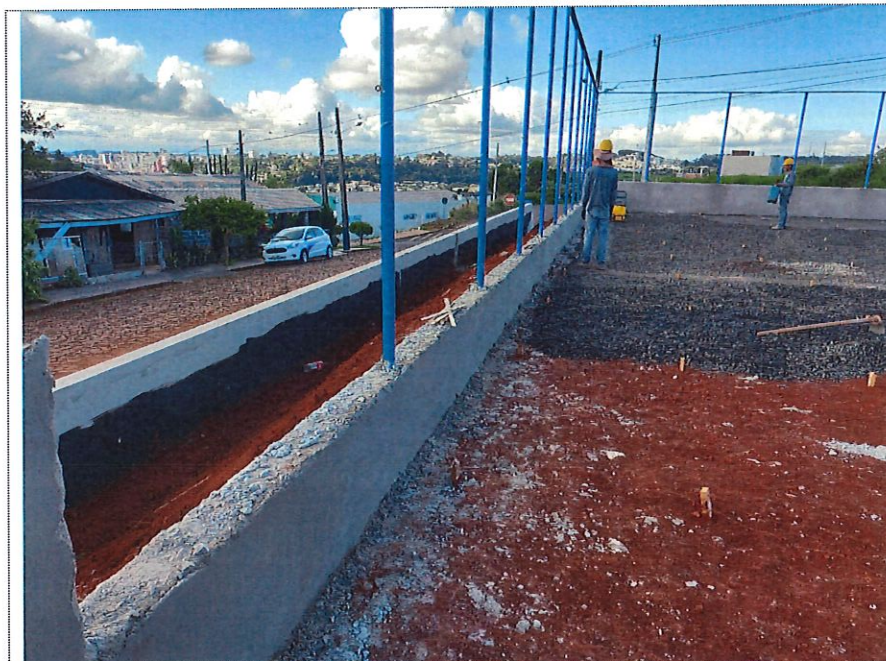
Impermeabilização de vigas baldrame no entorno do campo
