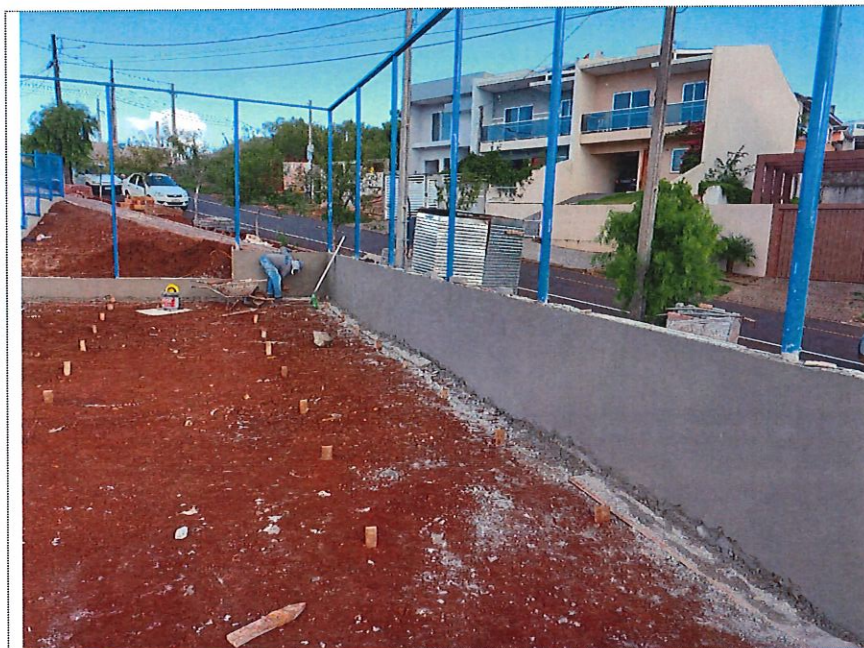
Emboço aplicado na mureta do campo
