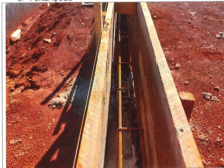
Estaca broca e camada drenante campo
