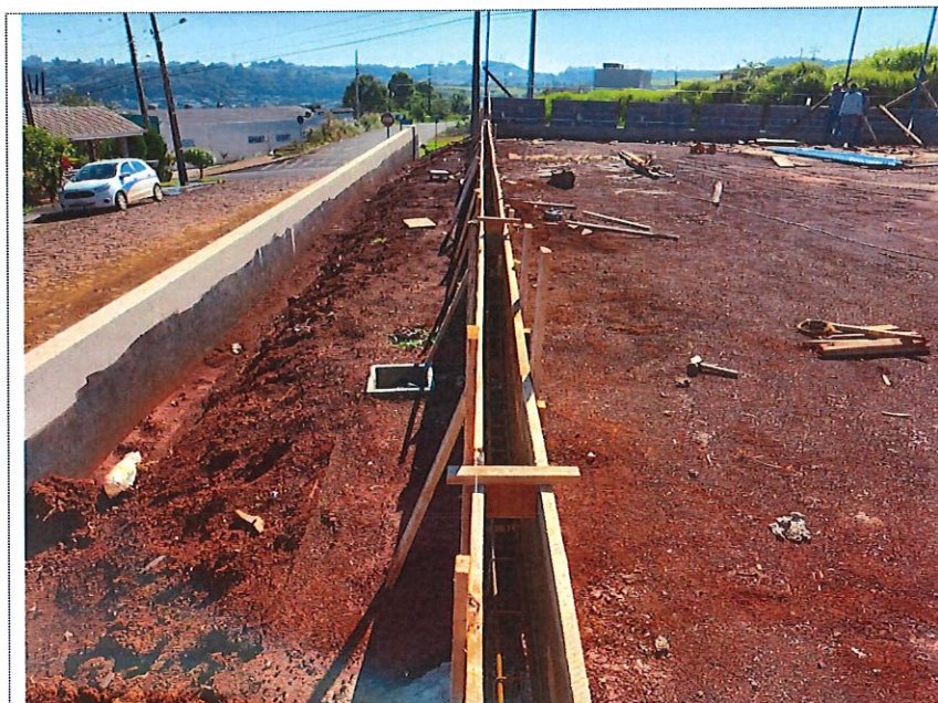
Fôrma e armadura da viga baldrame - campo
