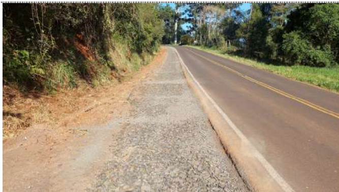
Fotografia 05.1: Sub-base em rachão (macadame).
