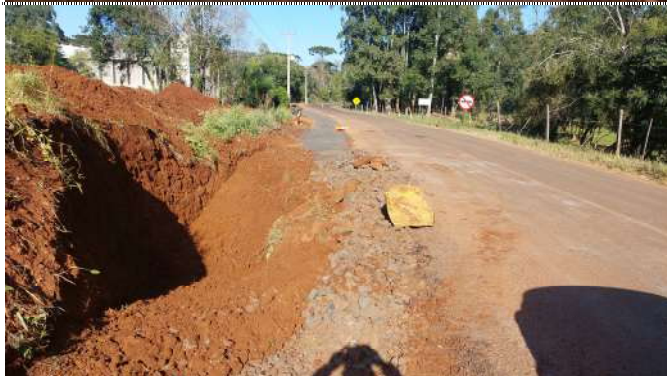
Fotografia 06.2: Escavação e Regularização.
