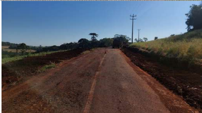
Fotografia 06.1: Escavação e Regularização.
