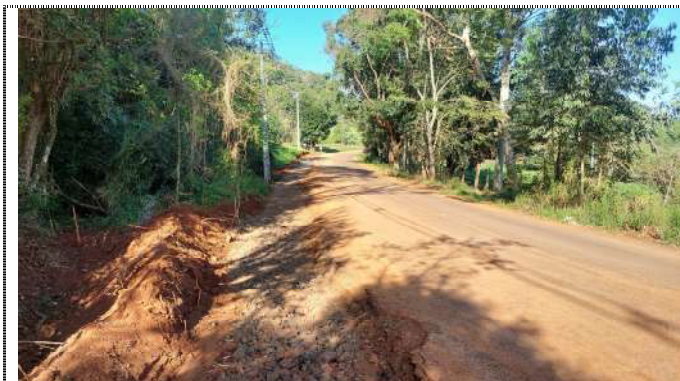
Fotografia 07: Sub-base em rachão (macadame).
