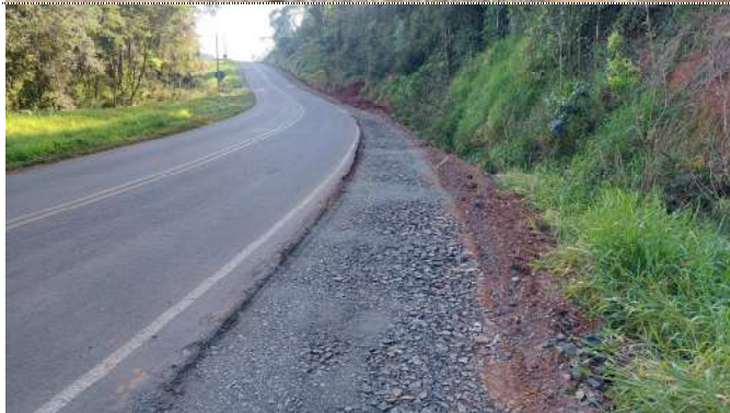
Fotografia 05.2: Sub-base em rachão (macadame).
