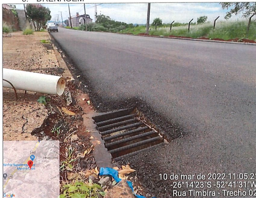
Imagem 18: Boca de lobo
