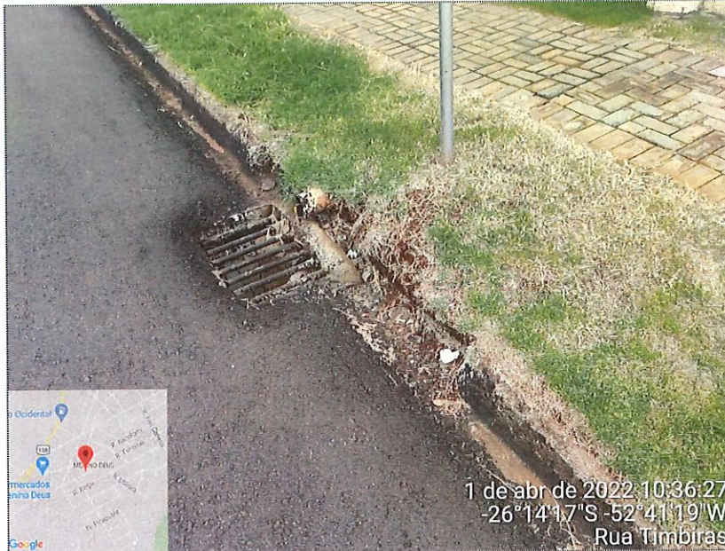
Imagem 19: Boca de lobo
